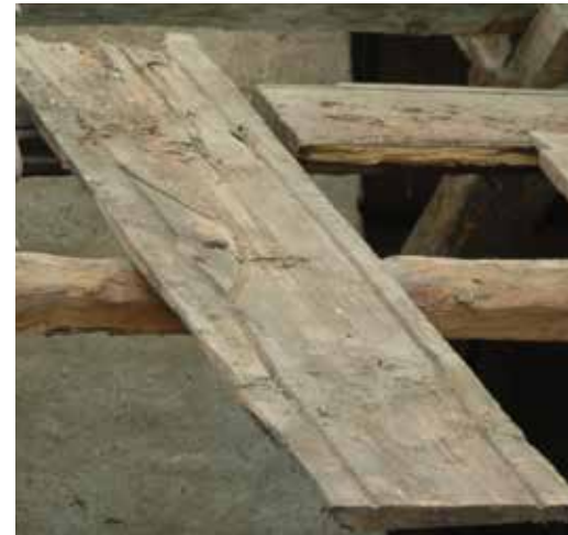
Erilaisia vapaalla kädellä tehtyjä vesiuria. Kuvassa yllä vesiura kiertää oksakohdan. Kuvassa alla vasemmalla laudan keskellä on lisäuria.
