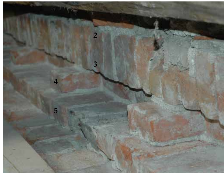
Etulapteen purettua muuria, jossa näkyy uloimpana olevan muurauksen limitys ja sidetiilien rytmi etulapteen seinällä. Varvit 2-3 ovat kantillaan oleva tiili, 4. varvi muodostuu juoksutiilien ja sidetiilien
