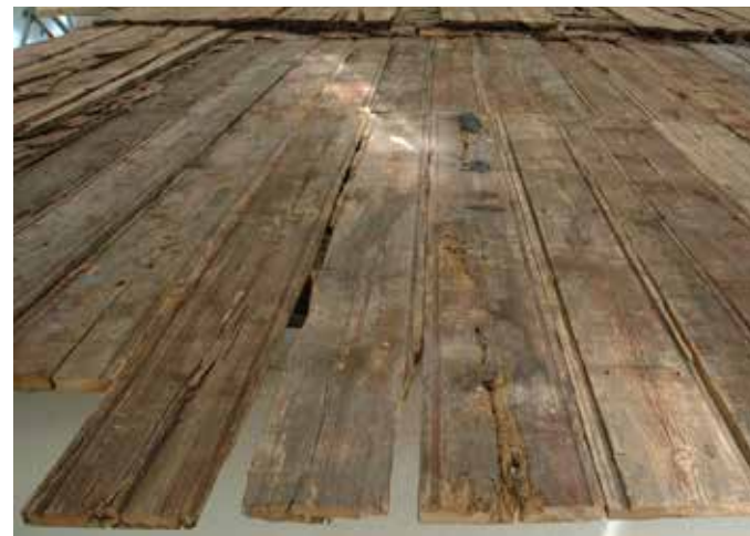
Palautetut laudat etulappeella. Kaikki laudat ovat etulappeelta, mutta niitä on siirretty. Osasta laudoista poistettiin lahonneet osat, ja katkaistut laudat liitettiin yhteen paikkaan. Joistakin laudoista poistettiin lahonneita osia, mutta myös katkaistut laudat käytettiin. Jatkoskohtaan lisättiin uusi naulauspuu. Katkaistut laudat asennettiin yhteen kohtaan, ettei uusia naulauspuita olisi tarvittu tarpeettoman paljon.
