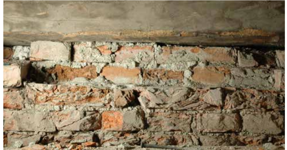
Rapautunutta tiilen pintaa rakennuksen ullakolla.
