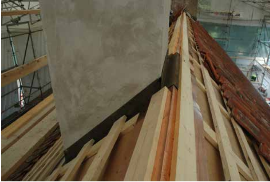
Merenpuoleinen piippu tiivistettiin kuten leivinuunin piipun juuri. Piipun reuna ulottui harjan tuntumaan. Harjatiilet jouduttiin piipun kohdalla leikkaamaan. Vesitiiviiksi harjan kohta tehtiin tiilen alla olevalla lyijypellillä.
