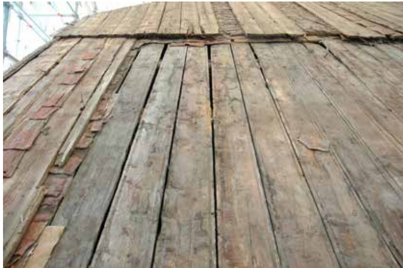
Vanha lautakate ennen korjaustöiden alkamista. Lappeelta on purettu ruoteet ja 1920-luvun vesiurattomat sahalaudat
