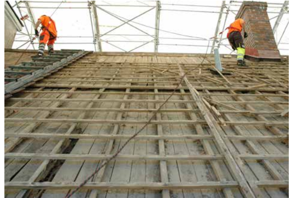
Alus-, ruoderimat (kuva yllä) ja laudoitus (kuva alla) ovat peräisin 1920-luvun korjauksesta. Tiiliruoteet ja alusrimat olivat pienikokoisia ja suurelta osin rikkoutuneita.
