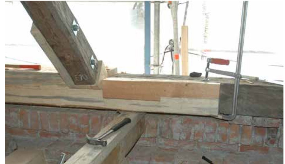
Vanhan ja uuden jalasparrun suora hammaslapiitos etulapella.
