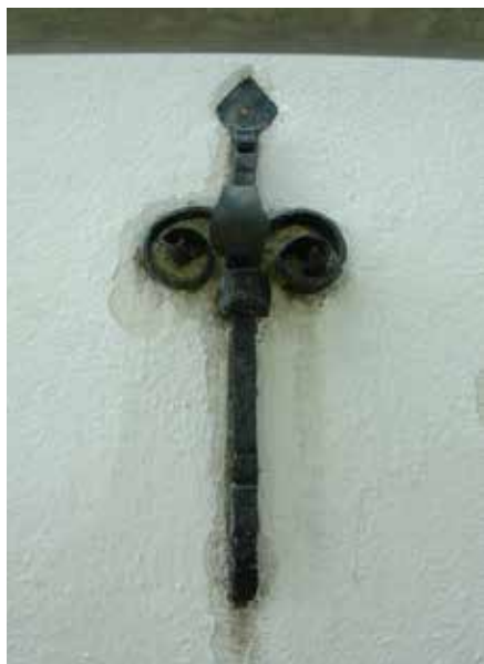
Ankkuriraudat kuvattuna ennen korjaustöiden alkamista kesällä 2016.
