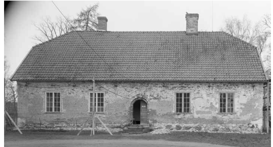
Kuvassa alhaalla vesemmällä luoteinen sivurakennus 1900-luvun alkupuolella kuvattuna. Katteena on yksikouruiset kankitiilet. Kuva kk 7627-34. Museoviraston arkisto. Kuvassa oikealla rakennus kuvattu korjaustöiden aikana 1964. HK1000-6569. Museoviraston arkisto.
