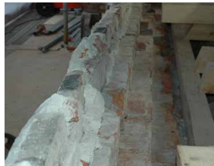
Kuvassa oikealla on purettua muuria takalappeella. Julkisivu rappauksineen säilyi rikkoutumatta. Rintamuurin sisäosa purettiin, puhdistettiin ja muurattiin uudelleen.
