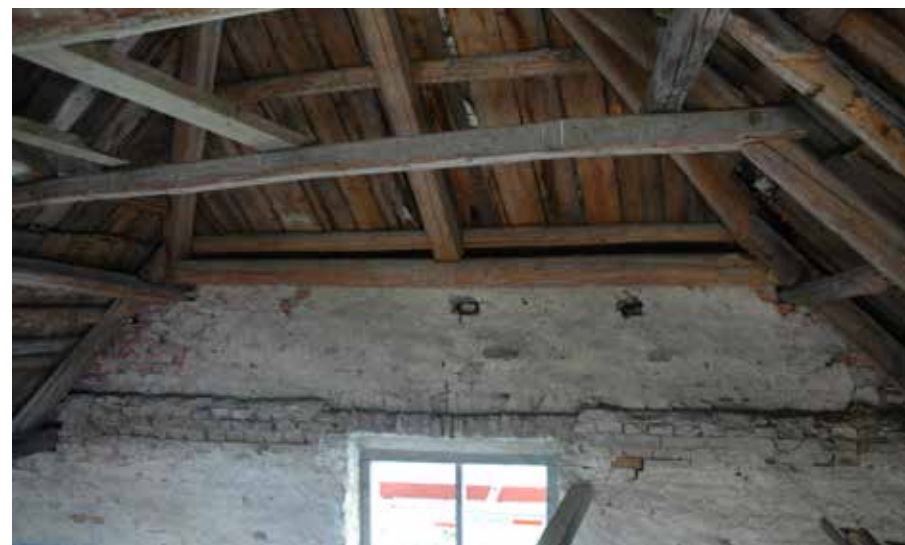
Kuvissa 1790-luvun alussa muutettua suoraa päätyä aumaksi. Tasakerran hirret ja tukipuu on ajoitettu kaadetuksi 1780-luvulla dendrokronologisessa iänmäärittäyksessä vuonna 1998.
