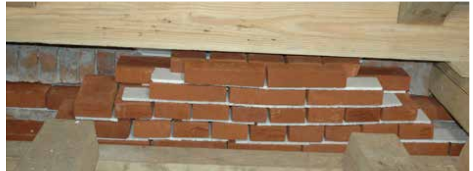
Sisäpinta muurattiin uudelleen. Viidennen kerroksen muurattiin juoksutiilirivi ja neljänteen sidetiilirivi. Kolmanteen kerroksen muurattiin juoksutiilirivit kahteen riviin. Toiseen kerroksen muurattiin juoksutiilirivi, jonka taakse muurattiin sidetiilirivi. Ylimpään eli ensimmäiseen kerrokseen muurattiin sidetiilet.
