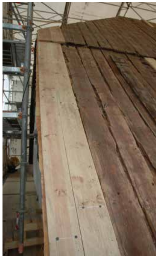
Uusien korokerimojen pohjaan kiinnitettiin uudet pohjalautojen kiinnitysrimat. Niihin taas kiinnitettiin uudet pohjalaudat sekä uudet räystäslaudat. Näin uusia räystäsrakenteita ei tarvinnut kannattaa vanhoista lautarakenteista.
