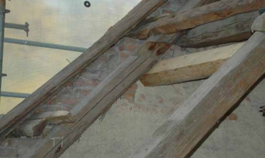
Yläkuviissa naulauspuiden jatkoksia, jotka toimivat räystäänkannattimina. Kuvassa oikealla keskellä on alin naulauspuu etulapteen puolella ja kuvassa alla alimman naulauspuun jatkos päädyn yli.
