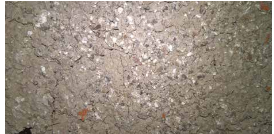
Laastina on käytetty kalkkilaastia, jossa on mukana siellä täällä murskattua tiiltä, eli chamottia. Laasti on väriltään vaalean harmaata, helposti murskautuvaa, mutta kuitenkin kovaa. Joukossa on kalkkipaakkuja, jotka näkyvät valkoisina pilkkuina.
