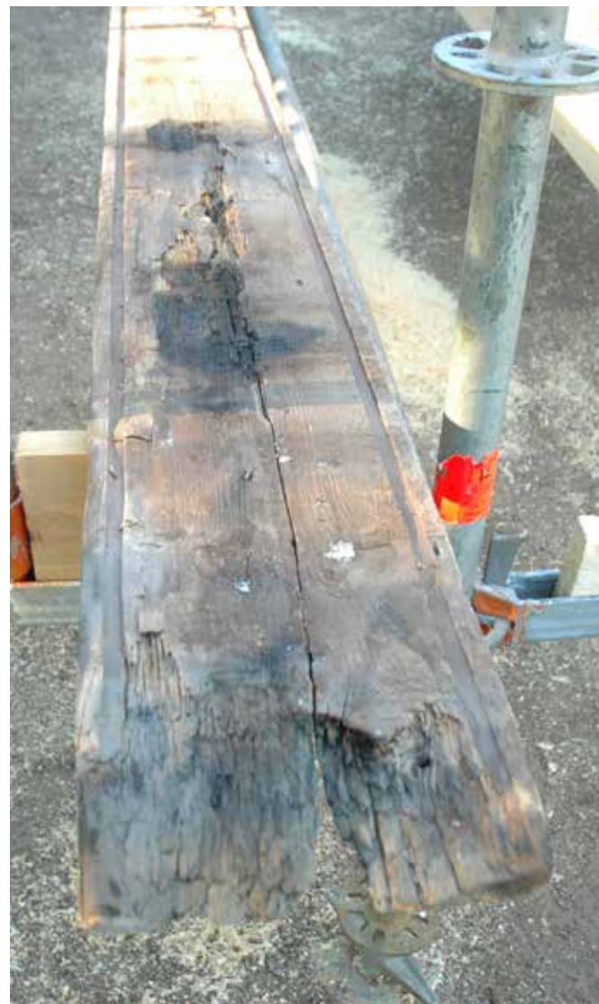
Luoteiseen sivurakennukseen tehtiin lautakate 1710-luvulla, tältä ajalta ovat myös sen vanhimmat ajoitetut osat. Etulappeella ollut kattolauta on tehty vuonna 1708 kaadetusta puusta. Suurin osa lautakatteesta on kuitenkin tehty myöhemmin 1700-luvulla.
