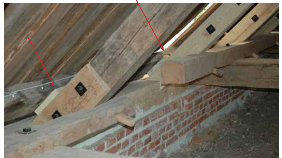
Alinta naulauspuuta jouduttiin korjaustöiden takia nostamaan paikoin useita senttimetrejä. Tämän takia selkämpuiden ja naulauspuun väliin jouduttiin toisaalla taas laittamaan korokkeita. Korokkeita asennettiin molemmille lappeille, useisiin selkäpuihin.
