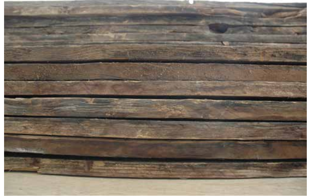
Kattolaudat ovat sahattuja ja reunat veistettyjä. Vuoden 1796 korjauskertomuksessa mainitaan käytettäneen ”helrena brädor”, joka viittaa tiettyyn laatuluokitukseen: ”fyrågade, fullkantiga, av bra o moget trä, utan stora, eller skadliga eller manga kvist samt utan vridna fibrer och blå yta.” Mielenkiintoiseksi määrittelyn tekee sahaustapa, fyrågade, jossa lauta on särmätty eli tukki sahataan kaikilta neljältä sivulta. Louhisaassa kaikkien lautojen sivut ovat veistettyjä, joka viittaa tuppeen sahauskeeseen.
