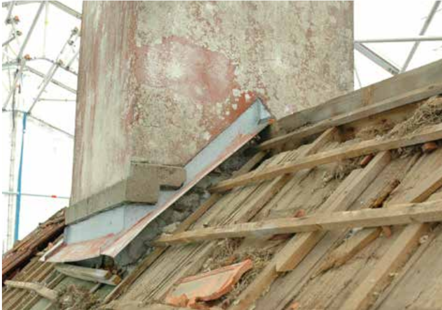
Vasemmalla yllä: Leivinuunin piippu ennen sen kunnostamista. Oikealla yllä: Piipun alin tiivistyskerros piippua vasten tehtiin bitumikermillä, joka liimattiin Icopal bitumiliimalla/kitillä piippuun ja aluskatteeseen.
