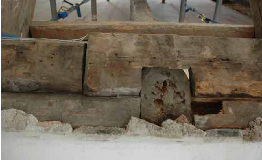
Sidehirren D pää ennen korjaustöitä
