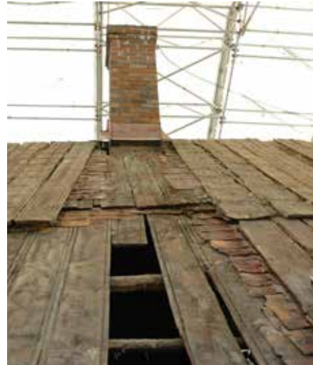
Kuvissa merenpuoleisen piipun alapuolisten lautojen korjaus
