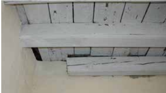
Kuvissa vasemmalla on paikka ennen korjauksia. Kuvissa oikealla palkki veksellillä tuettuna, paikka koirjattuna ja mineraalivillat vaihdettuna pellavariveeseen.
