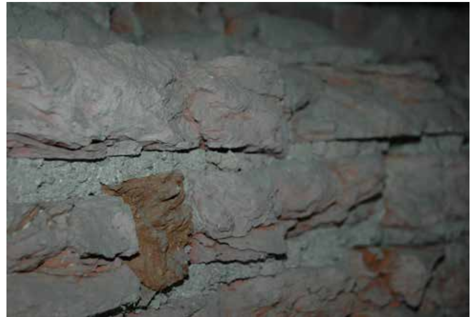
Rapautunutta tiilen pintaa rakennuksen ullakolla.
