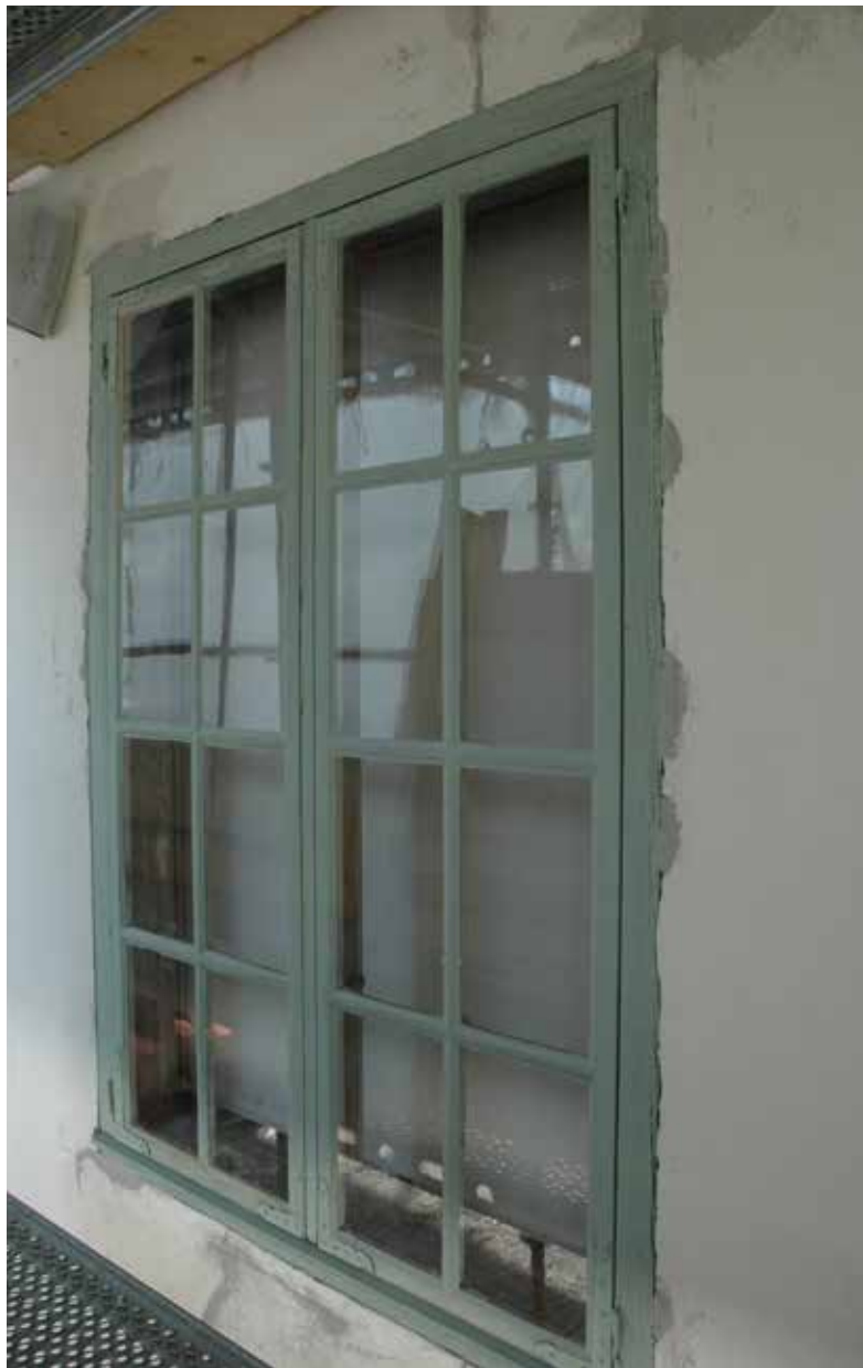
Ikkuna kesällä 2016, värisävy vuoden 2012 korjauksesta NCS S S3010-G
