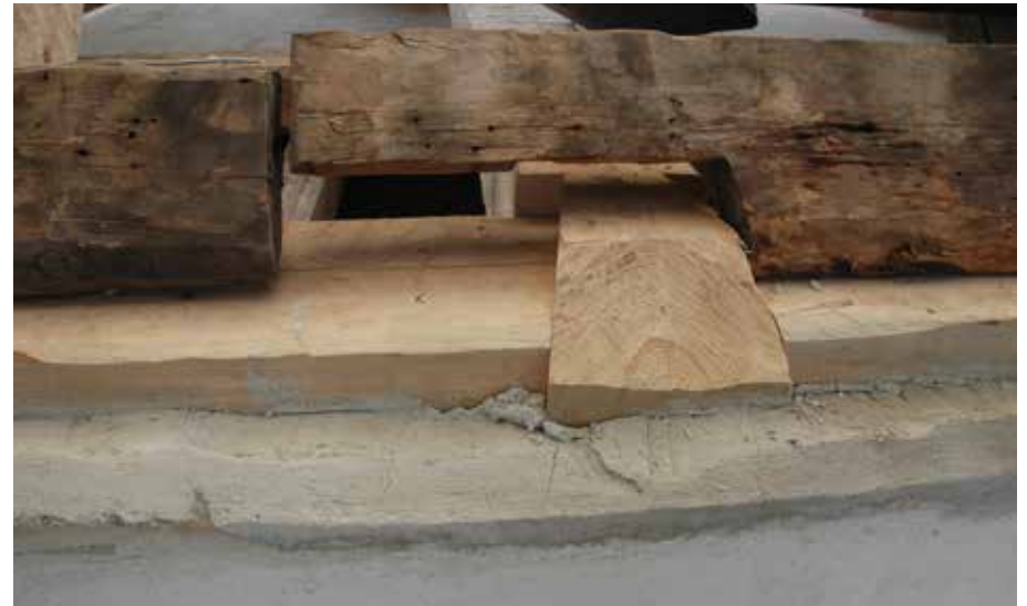
Sidehirren D pää valmiina korjaustöiden jälkeen.
