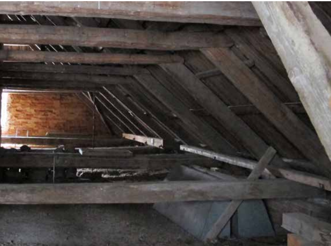
Kuvassa yllä vekselipalkki takalappeella TV 3/3. Alla takalappeen vekselipalkkeja.
