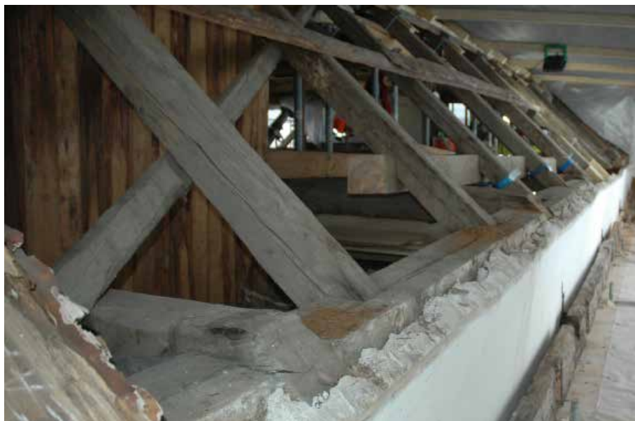
Etulapetta ennen korjaustöiden alkamista. Naulauspuu on irrotettu.
