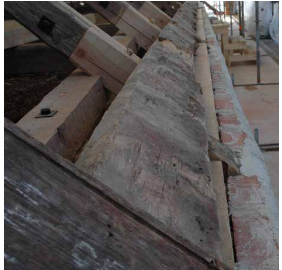
Kuva vasemmalla; takalapetta ennen korjaustöiden alkua. Kuva oikealla; Vanha, kookas naulauspuu on kiinnitetty takaisin korjaustyön jälkeen
