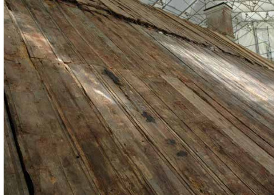
Palautetut laudat etulappeella. Kaikki laudat ovat etulappeelta, mutta niitä on siirretty. Osasta laudoista poistettiin lahonneet osat, ja katkaistut laudat liitettiin yhteen paikkaan. Joistakin laudoista poistettiin lahonneita osia, mutta myös katkaistut laudat käytettiin. Jatkoskohtaan lisättiin uusi naulauspuu. Katkaistut laudat asennettiin yhteen kohtaan, ettei uusia naulauspuita olisi tarvittu tarpeettoman paljon.
