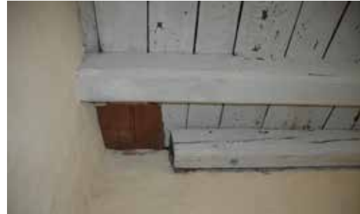
Kuvissa vasemmalla on paikka ennen korjauksia. Kuvissa oikealla palkki veksellillä tuettuna, paikka koirjattuna ja mineraalivillat vaihdettuna pellavariveeseen.
