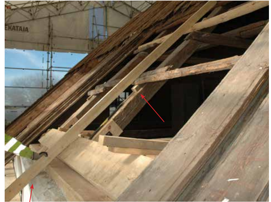
Etulapella naulauspuiden korkeusero tasoitettiin vaihtamalla nuolen osoittamasta paikasta naulauspuu yhteen yhtenäiseen ja korkeampaan naulauspuuhun. Se asennettiin kattotuolien E5-E9 väliin ja liitettiin vanhaan naulauspuihin vinolla lapaliitoksella ja naulalla. Muurin ulkoreuna oli muuraustyössä noussut liian korkealle. Muurin ulkoreunaa hiottiin matalammaksi.
