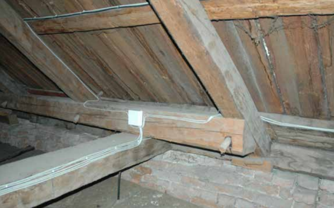
Kuvassa yllä vekselipalkki takalappeella TV 3/3. Alla takalappeen vekselipalkkeja.
