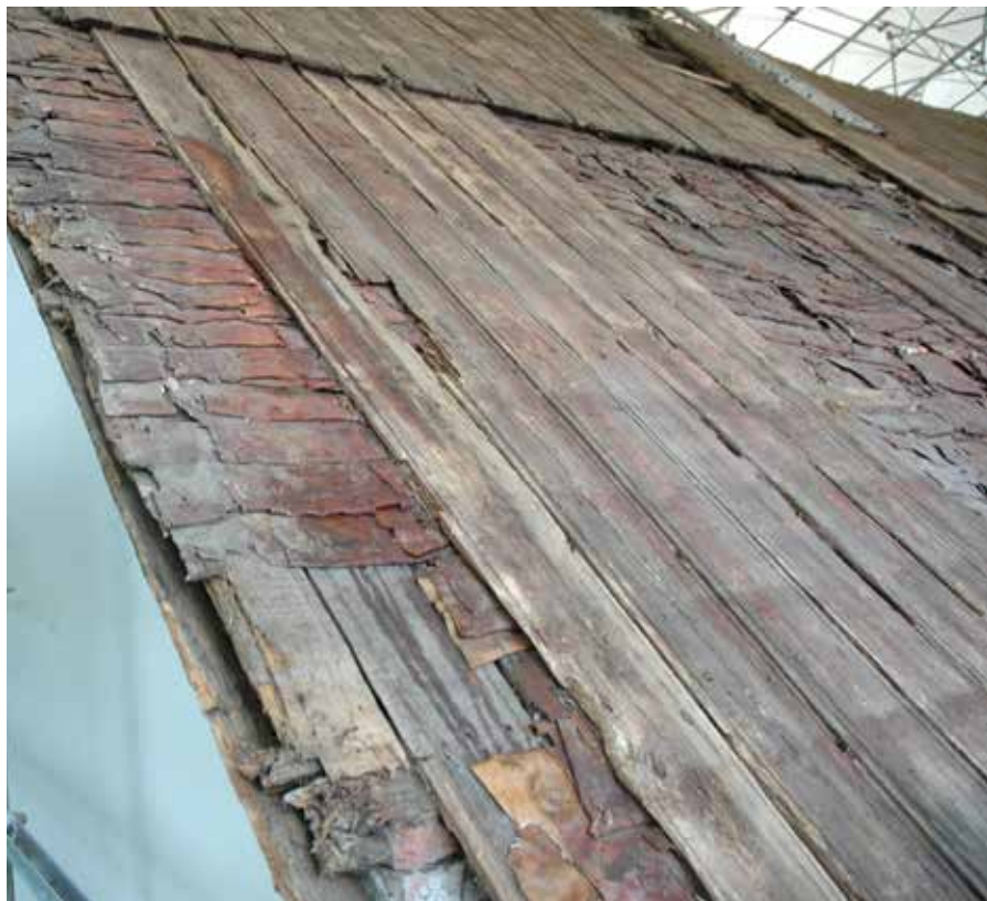
Takalape ennen kattolautojen purkamista.
