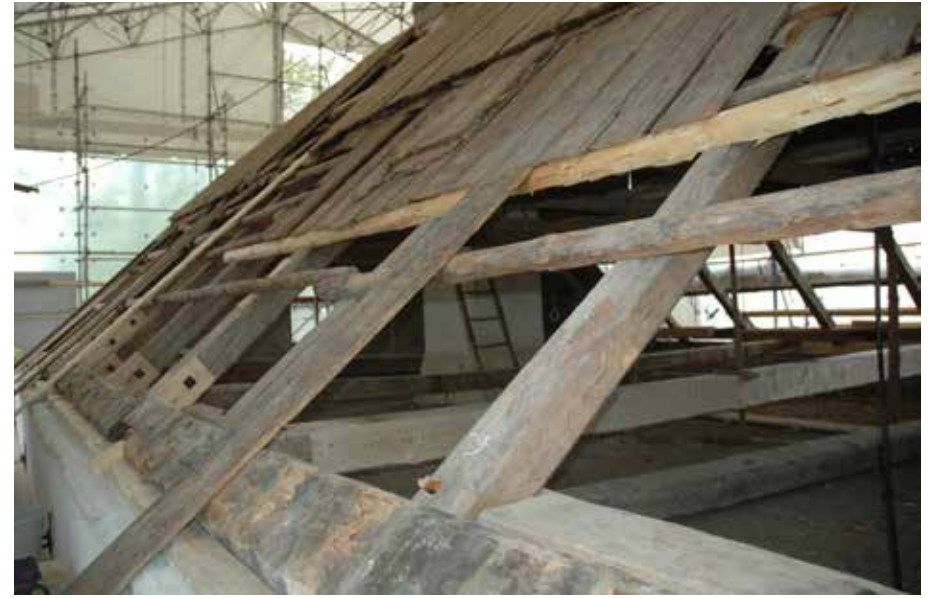
Takalapelle asennettiin ylimääräinen yhtenäinen naulauspuu kattolaudoituksen jatkokohtaan kattotuolien T6- T10 väliin. Etulapelle tehtiin uusi naulauspuu kattotuolien E11-E14 väliin. Se jää piiloon ullakolla komeron taakse. Lisäksi muutama vaurioitunut naulauspuu vaihdettiin ehjään.
