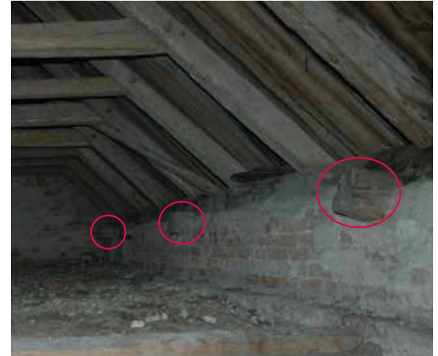
Kaakkoisessa sivurakennuksessa räystästä kannattavat poikkipuut ovat edelleen tallessa. Niitä on kummallakin pitkillä seinällä seitsemän kappaletta.
