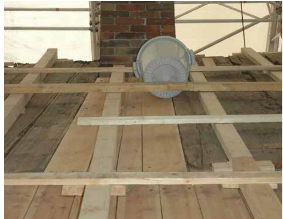
Kuvissa merenpuoleisen piipun alapuolisten lautojen korjaus
