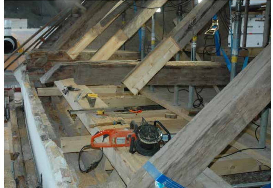
Selkäpuun jatkokset tehtiin lapaliitos läpipulttauksella. Tiilimuuri purettiin sisäpuolelta viiden tiilivarvin alueelta. Jalaparru ja kattotuolien selkäpuut korjattiin tarvittavilta osin, jonka jälkeen muurin sisäpuoli muurattiin uudelleen.
