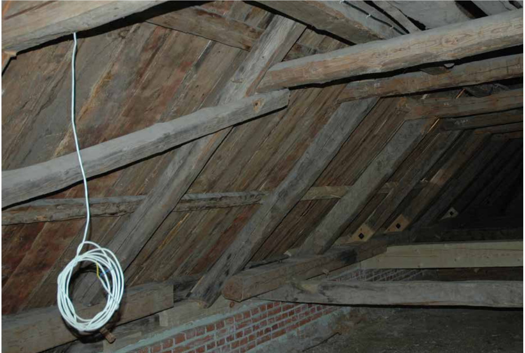
Palautettu lautakatto korjausten jälkeen ullakolta nähtynä. Etulapteen puoli.
