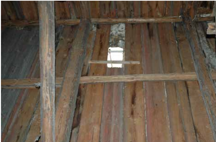
Lautakatteesta puuttui muutamia yksittäisiä lautoja, jotka korvattiin vanhoilla kattolaudoilla.
