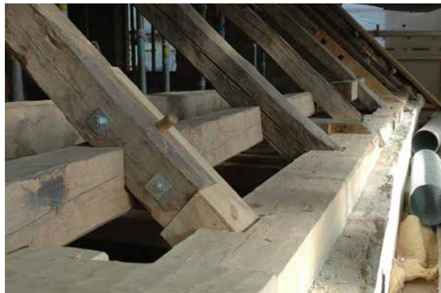
Etulapteen keskiosa korjattuna, naulauspuu kiinnittämättä.
