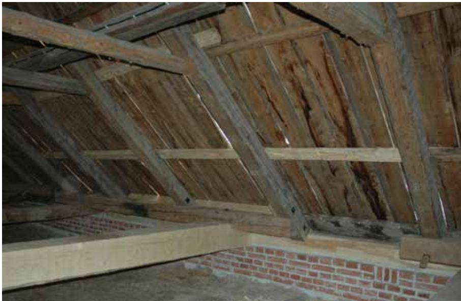
Naulauspuita on rakennuksen päädyistä päätyyn kuudessa rivissä. Naulauspuita on ajan saatossa lisätty tukemaan lautakattoa. Etulappeella on säilynyt yhtenäinen naulauspuiden rivi, joka haluttiin säilyttää, vaikkakin yksi naulauspuu jouduttiin korvaamaan uudella halkaistulla hieman tukevammalla puulla.
