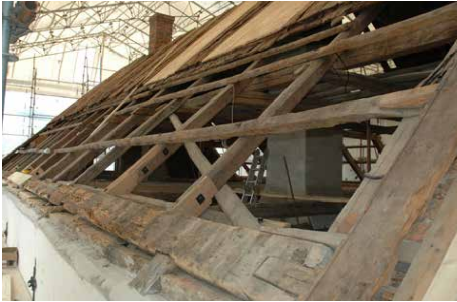
Naulauspuita on rakennuksen päädyistä päätyyn kuudessa rivissä. Naulauspuita on ajan saatossa lisätty tukemaan lautakattoa. Etulappeella on säilynyt yhtenäinen naulauspuiden rivi, joka haluttiin säilyttää, vaikkakin yksi naulauspuu jouduttiin korvaamaan uudella halkaistulla hieman tukevammalla puulla.
