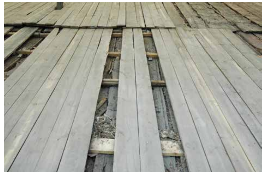
Alus-, ruoderimat (kuva yllä) ja laudoitus (kuva alla) ovat peräisin 1920-luvun korjauksesta. Tiiliruoteet ja alusrimat olivat pienikokoisia ja suurelta osin rikkoutuneita.
