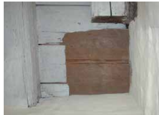
Kuvissa vasemmalla on paikka ennen korjauksia. Kuvissa oikealla palkki veksellillä tuettuna, paikka koirjattuna ja mineraalivillat vaihdettuna pellavariveeseen.
