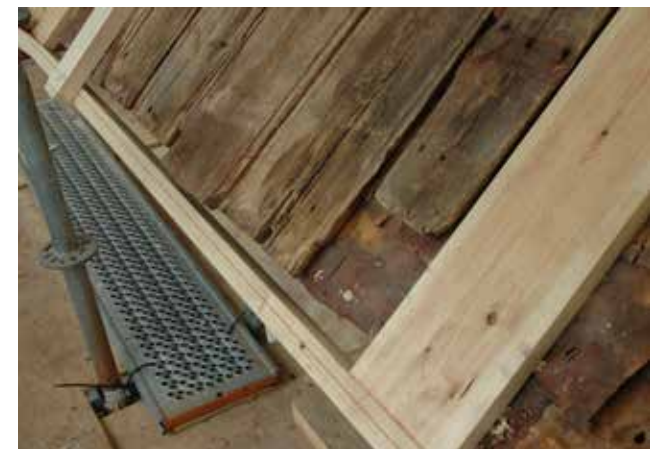
Uusien korokerimojen pohjaan kiinnitettiin uudet pohjalautojen kiinnitysrimat. Niihin taas kiinnitettiin uudet pohjalaudat sekä uudet räystäslaudat. Näin uusia räystäsrakenteita ei tarvinnut kannattaa vanhoista lautarakenteista.
