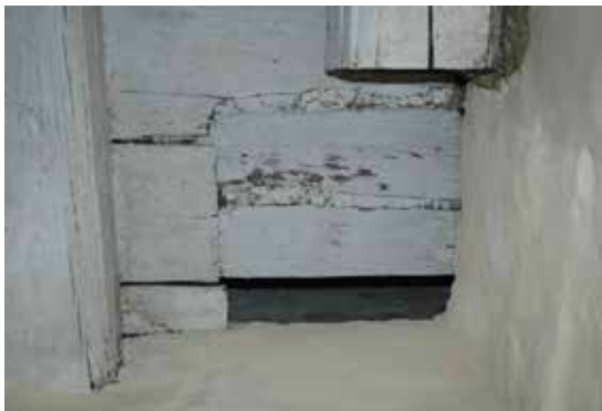
Kuvissa vasemmalla on paikka ennen korjauksia. Kuvissa oikealla palkki veksellillä tuettuna, paikka koirjattuna ja mineraalivillat vaihdettuna pellavariveeseen.
