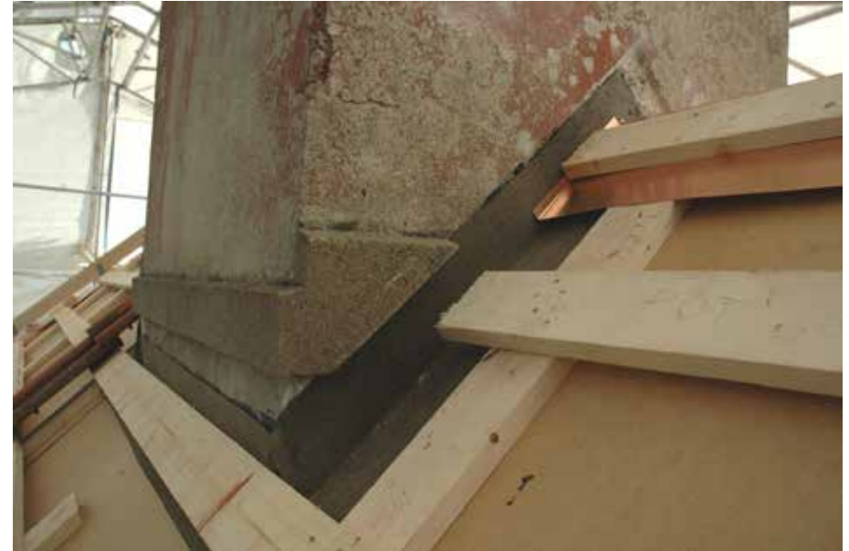
Kuvat alla: Tiilijako ei osunut kapealle suojapellille sopivasti vaan sen koko olisi kasvanut suhteettoman suureksi. Tästä syystä tiivistys tehtiin erillisellä lyijypellillä tiilien alla. Tällä tavoin saatiin säilytettyä vanhan mallin mukainen kapea suojapelti, joka on yhtenäinen muiden rakennusten kanssa. Lyijylevyt piipun sivuilla asennettiin tiilien alle siten, että lyijypellin helma tulee esiin piipun alapuolella olevien tiilien välistä, josta se ohjaa valumavedet alemman tiilen uraan. Piipun alareunassa lyijypelti asennettiin tiilien päälle ja muotoiltiin tiilen aaltojen mukaan. Nurkissa lyijypelit saumattiin. Muodonmuutoksille alttiit lyijypellit kiinnitettiin piippujen kylkiin rst-listoilla.
