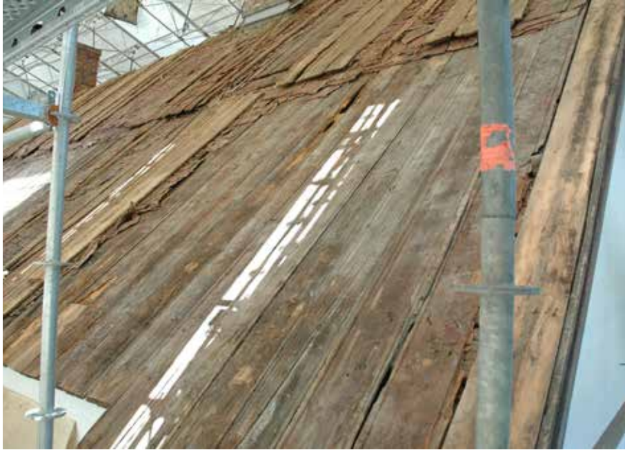
Vanha lautakate ennen korjaustöiden alkamista. Lappeelta on purettu ruoteet ja 1920-luvun vesiurattomat sahalaudat
