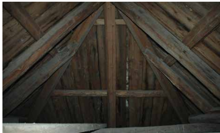
Kuvissa 1790-luvun alussa muutettua suoraa päätyä aumaksi. Tasakerran hirret ja tukipuu on ajoitettu kaadetuksi 1780-luvulla dendrokronologisessa iänmäärittäyksessä vuonna 1998.
