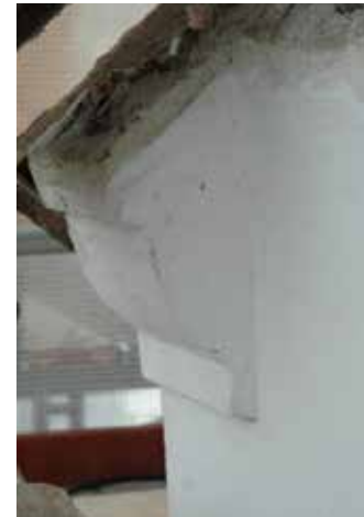
Koillismurkan räystäslistan jäännös.
