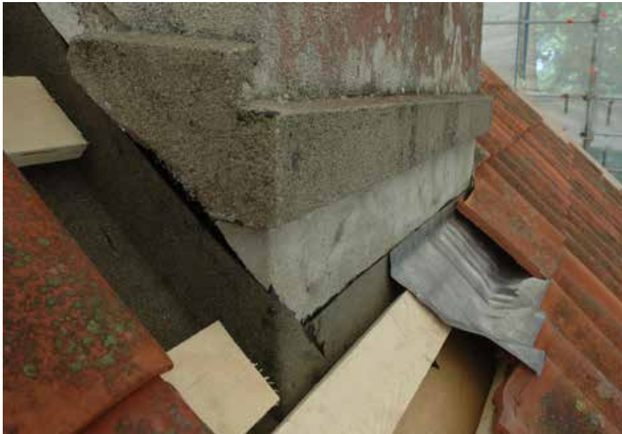
Vasemmalla yllä: Leivinuunin piippu ennen sen kunnostamista. Oikealla yllä: Piipun alin tiivistyskerros piippua vasten tehtiin bitumikermillä, joka liimattiin Icopal bitumiliimalla/kitillä piippuun ja aluskatteeseen.
