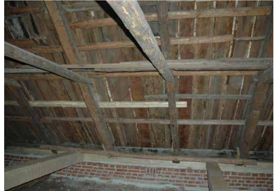
Lautakatetta samalla kohdalla ullakolla korjaustöiden jälkeen syksyllä 2017.
