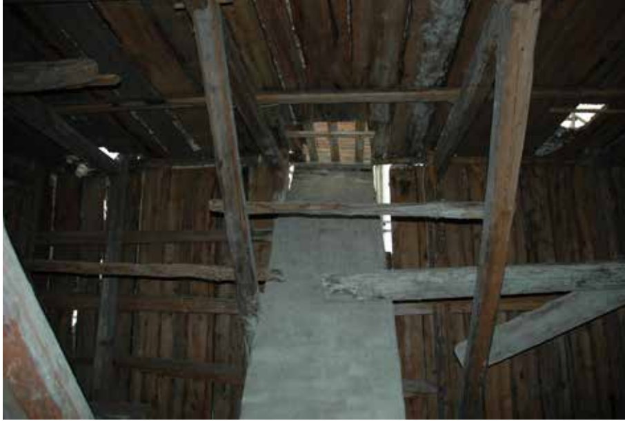
Lautakatteesta puuttui muutamia yksittäisiä lautoja, jotka korvattiin vanhoilla kattolaudoilla.
