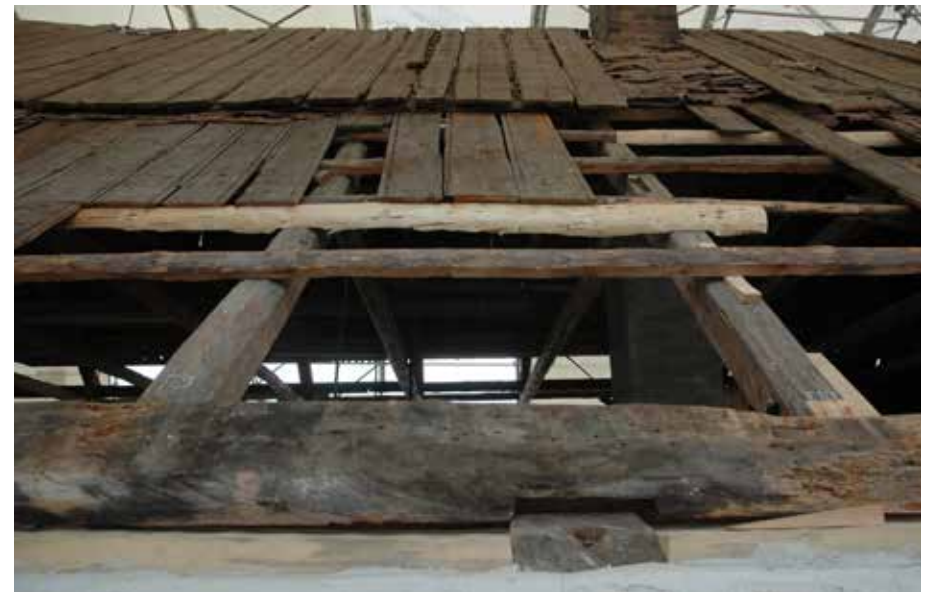
Takalapelle asennettiin ylimääräinen yhtenäinen naulauspuu kattolaudoituksen jatkokohtaan kattotuolien T6- T10 väliin. Etulapelle tehtiin uusi naulauspuu kattotuolien E11-E14 väliin. Se jää piiloon ullakolla komeron taakse. Lisäksi muutama vaurioitunut naulauspuu vaihdettiin ehjään.
