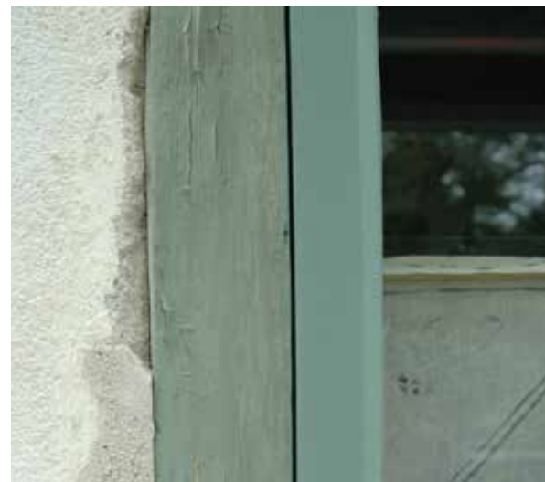
Päärakennuksen väriselvitys tehtiin luoteisen julkisivun toisen kerroksen karmien yläpinnasta. Kuvassa näkyy karmi vasemmalla jossa maalipinta vastaa sävyä NCS 5010-G50Y ja puite oikealla vastaa sävyä NCS S 4010-G10Y. Puitteet on maalattu vuonna 2011, karmit mahdollisesti 1970-luvulla. .
