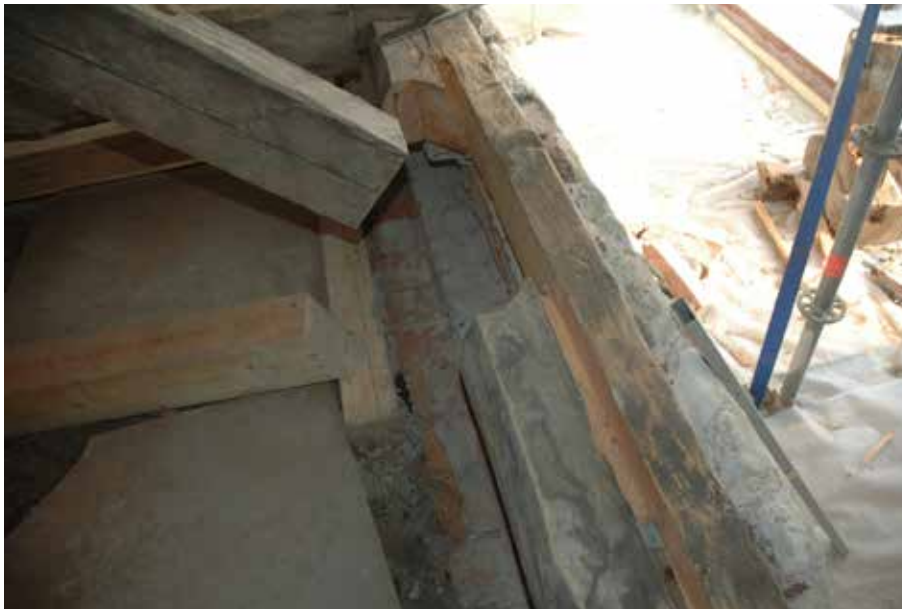
Selkäpuun (E12) lahon pään ja jalasparrun lahon liitoksen korjaus. Jalasparruun liitos tehtiin puupaikkaamalla katkaisematta parrua.
