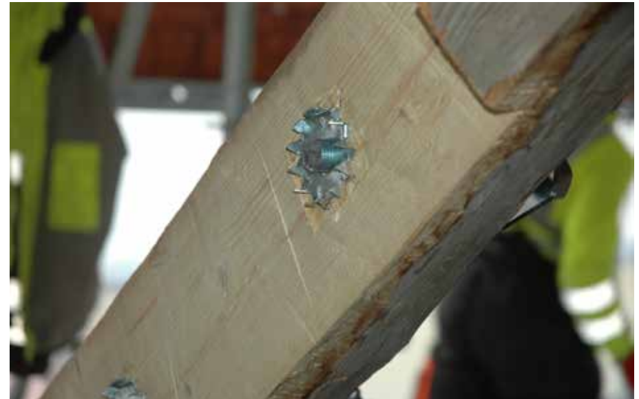
Selkäpuun jatkokset tehtiin lapaliitos läpipulttauksella. Tiilimuuri purettiin sisäpuolelta viiden tiilivarvin alueelta. Jalaparru ja kattotuolien selkäpuut korjattiin tarvittavilta osin, jonka jälkeen muurin sisäpuoli muurattiin uudelleen.
