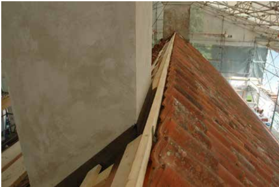
Merenpuoleinen piippu tiivistettiin kuten leivinuunin piipun juuri. Piipun reuna ulottui harjan tuntumaan. Harjatiilet jouduttiin piipun kohdalla leikkaamaan. Vesitiiviiksi harjan kohta tehtiin tiilen alla olevalla lyijypellillä.
