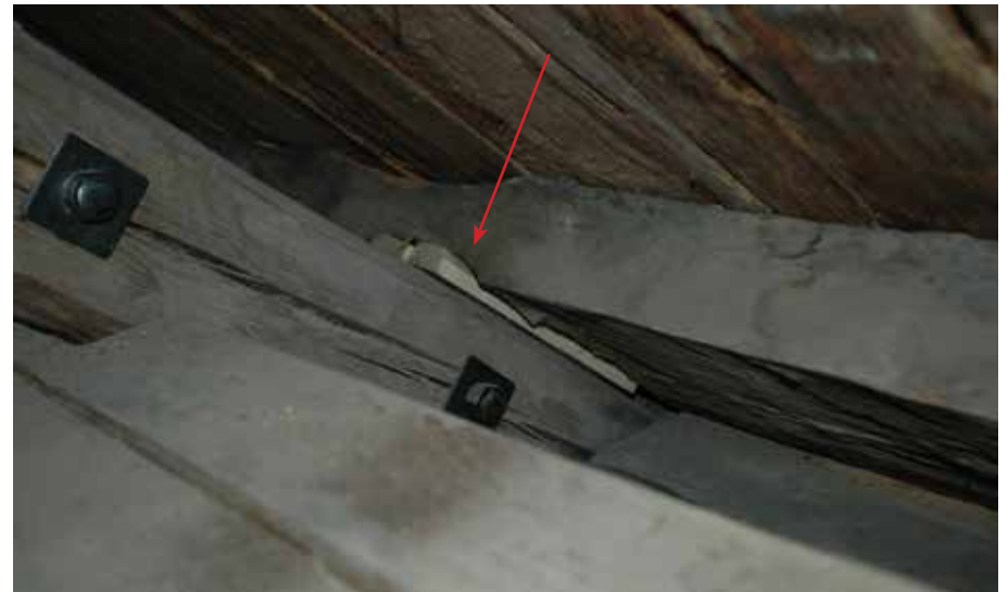
Alinta naulauspuuta jouduttiin korjaustöiden takia nostamaan paikoin useita senttimetrejä. Tämän takia selkämpuiden ja naulauspuun väliin jouduttiin toisaalla taas laittamaan korokkeita. Korokkeita asennettiin molemmille lappeille, useisiin selkäpuihin.
