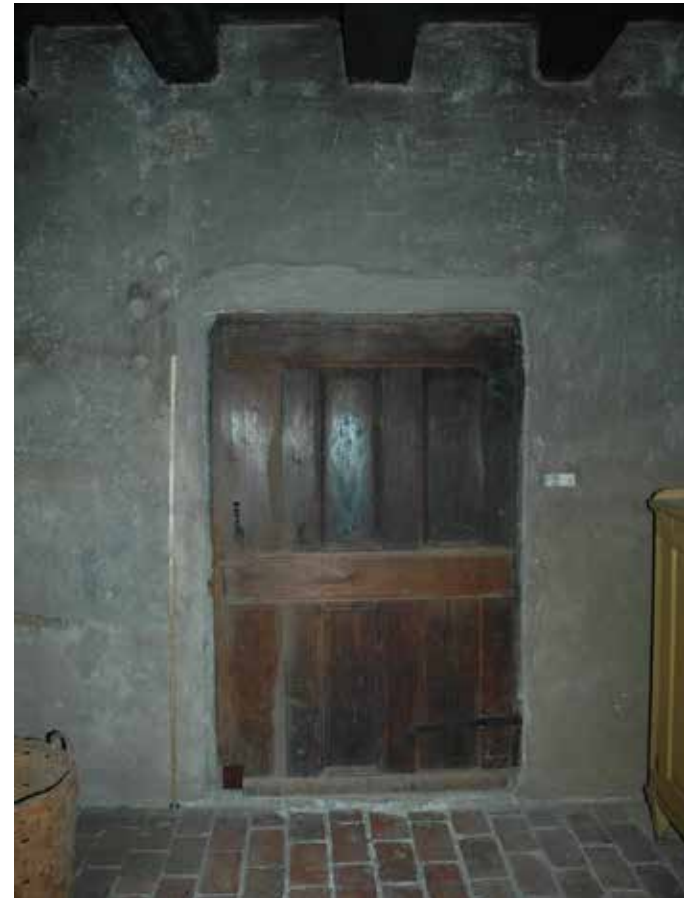
Museotilojen seinät valokuvattiin ja seinissä olevat halkeamat mitattiin ennen korjaustöiden alkua ja korjaustöiden päätyttyä. Lisähalkeamia ei havaittu korjaustöiden päätyttyä.
