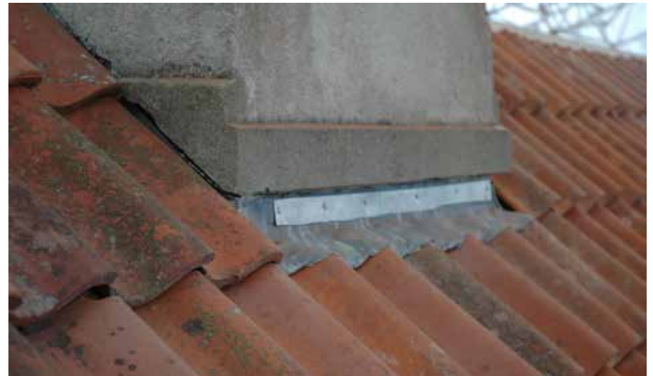
Kuvat alla: Tiilijako ei osunut kapealle suojapellille sopivasti vaan sen koko olisi kasvanut suhteettoman suureksi. Tästä syystä tiivistys tehtiin erillisellä lyijypellillä tiilien alla. Tällä tavoin saatiin säilytettyä vanhan mallin mukainen kapea suojapelti, joka on yhtenäinen muiden rakennusten kanssa. Lyijylevyt piipun sivuilla asennettiin tiilien alle siten, että lyijypellin helma tulee esiin piipun alapuolella olevien tiilien välistä, josta se ohjaa valumavedet alemman tiilen uraan. Piipun alareunassa lyijypelti asennettiin tiilien päälle ja muotoiltiin tiilen aaltojen mukaan. Nurkissa lyijypelit saumattiin. Muodonmuutoksille alttiit lyijypellit kiinnitettiin piippujen kylkiin rst-listoilla.
