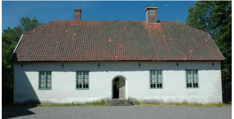
Kuvassa ylhäällä luoteinen sivurakennus kuvattuna kesällä 2016. Rakennuksessa on yksikouruinen valssitili- eli urareunatiili, sama tiilikate kuin kuvassa vuodelta 1964 (kuva alhaalla oikealla).
