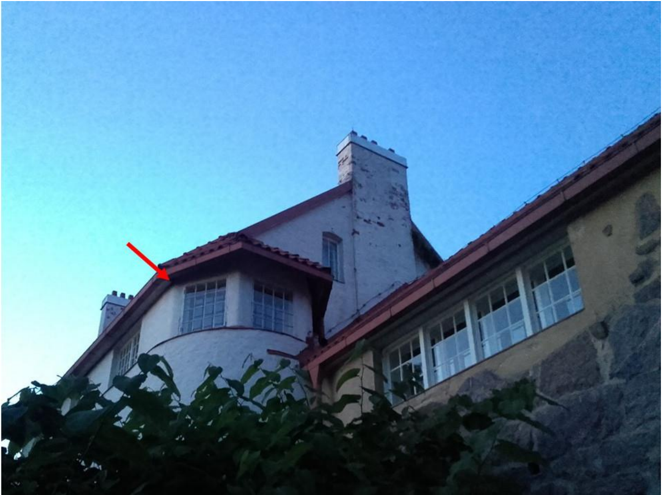
Kuva 6. Pohjanlepakoiden lisääntymispaikka sijaitsi päärakennuksen vintillä. Lepakoiden pääasiallinen kulkukohta on merkitty kuvaan nuolella.
