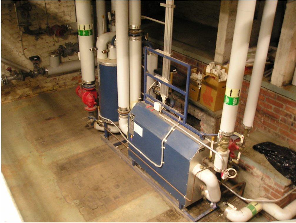
Kuva 1. Lämmönjakokeskuksen ja varusteiden kunto on tyydyttävä, mutta niiden uusiminen ajoittuu tälle tarkastelujaksolle teknisen käyttöiän päättyessä.
