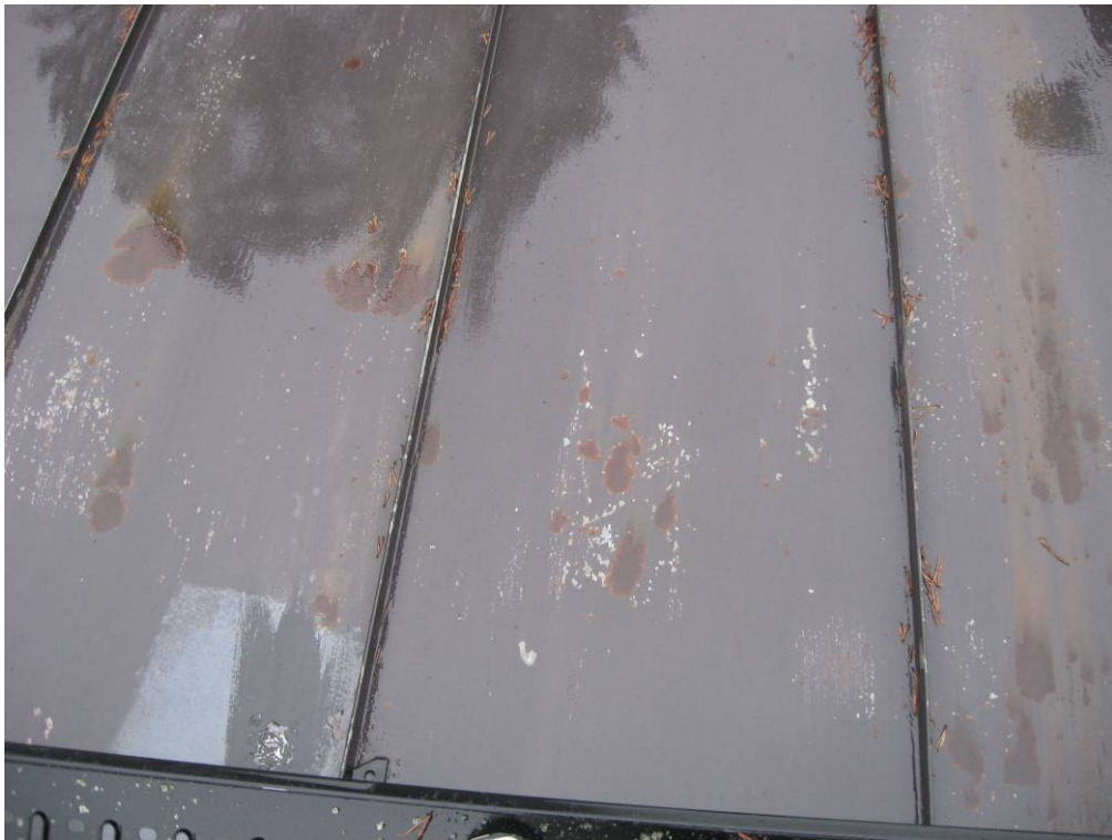
Kuva 8. Vesikatteen maalaus on ajankohtainen tarkastelujakson alkupuolella.
