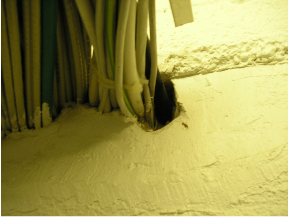
Kuva 1. Palokatkoissa havaittiin joitain puutteita. Suosittelemme palokatkokartoituksen teettämistä ja puutteellisten kohtien korjausta koko kiinteistöön.
