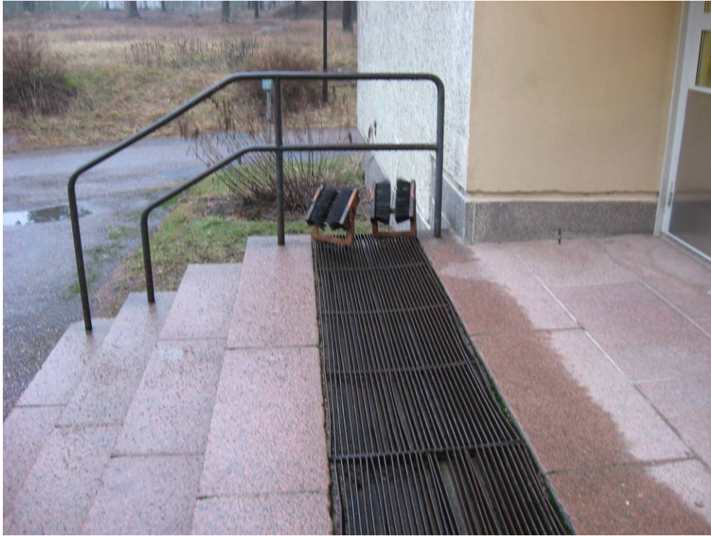
Kuva 5. Graniittilaatoituksen saumat ovat vajaat ja rappurallit ovat uusimisen tarpeessa.
