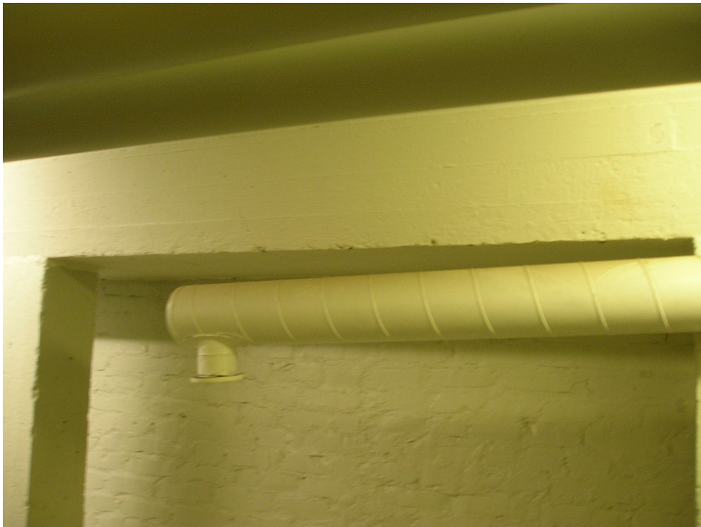
Kuva 10. Eteläpäädyn kellarin hallitilan poistokanavan kannatus on puutteellinen. Kanava roikkuu liittimensä varassa ja se tulisi korjata huoltotyönä.
