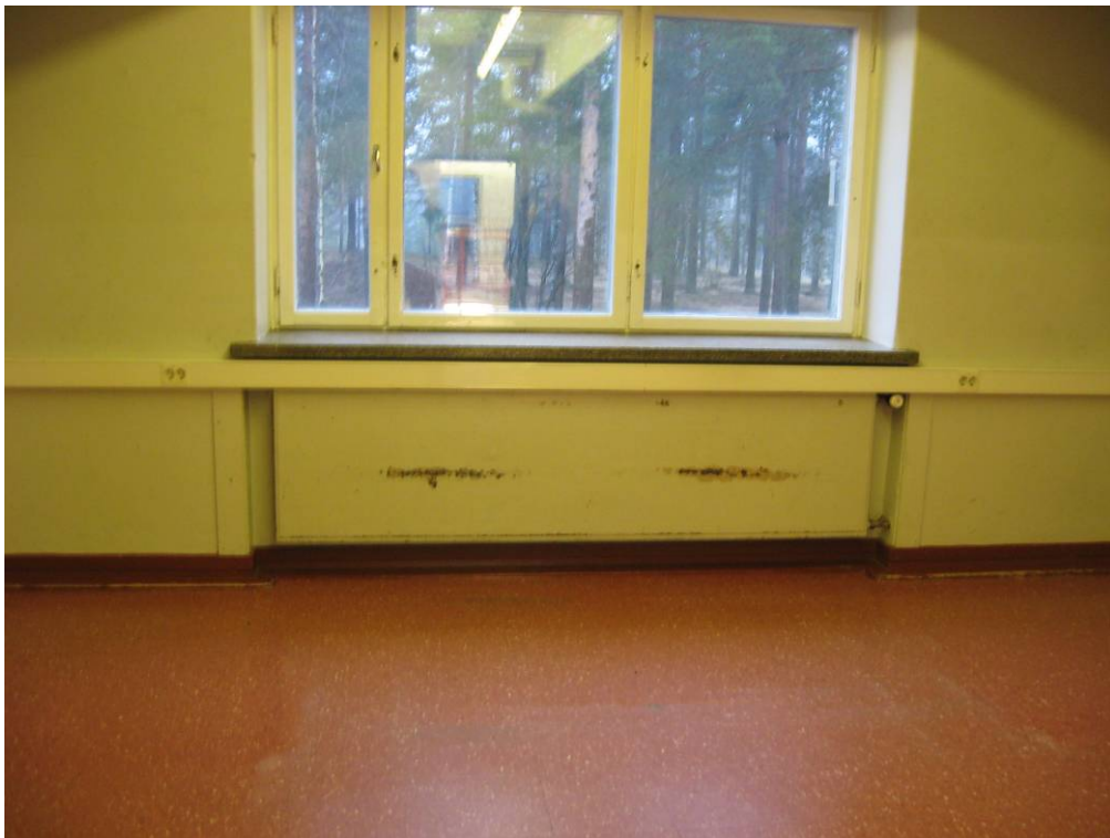
Kuva 22. Rakennuksen huoneissa pintojen huoltomaalaustarvetta on eri puolilla tarkastelujakson aikana.
