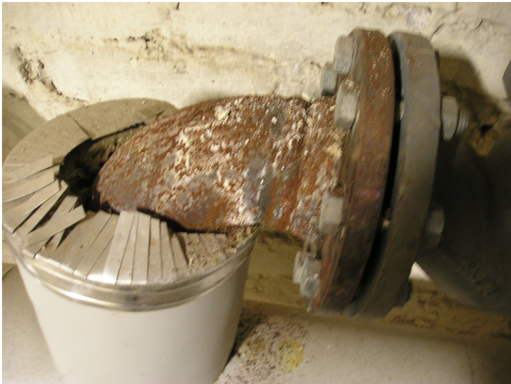
Kuva 4. Lämmönjakuhuoneen putkissa havaittiin myös paikoin korroosioaurioita. Vanhempien putkiosuuksien tarkempi jäljellä oleva käyttöikä voidaan tarvittaessa selvittää erillisellä putkiston kuntotutkimuksella.
