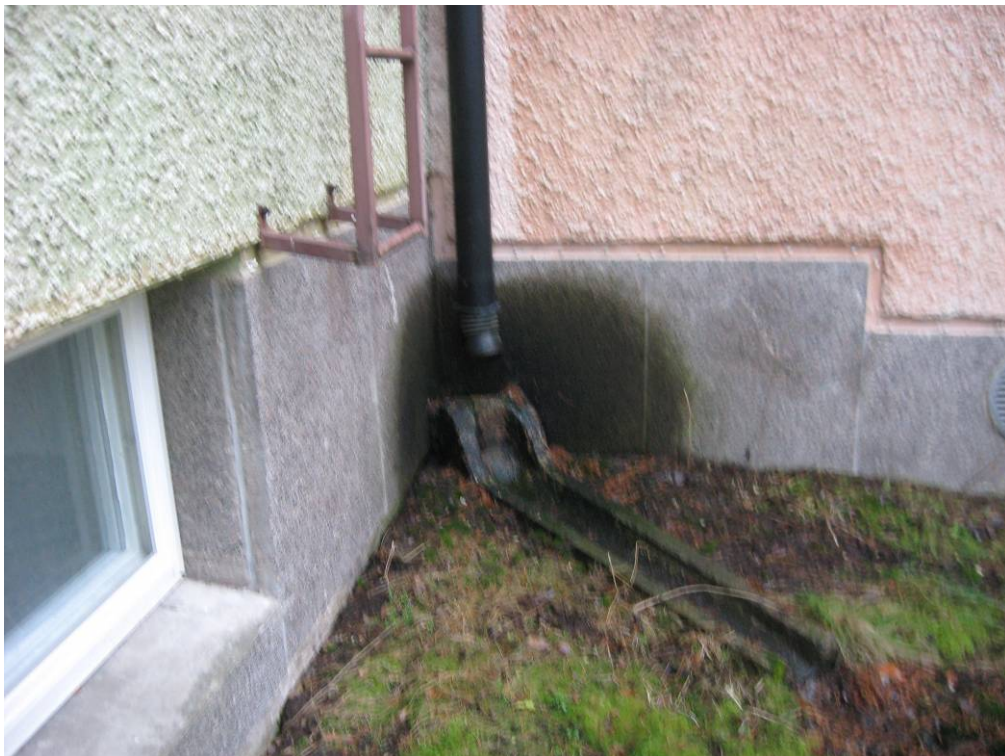
Kuva 4. Sadevesien ohjaus avokouruin vanhalla osalla. Kouru kaataa rakennukseen päin ja syöksyputki liian korkealla.
