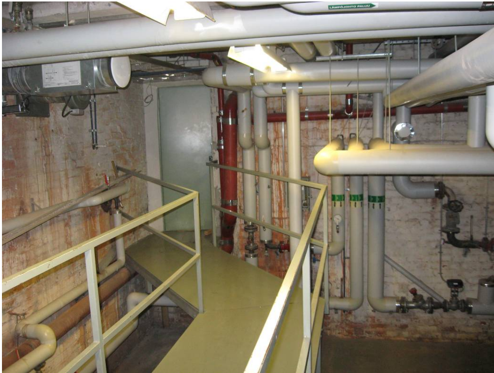
Kuva 25. Teknisen tilan pinnat ovat huoltomaalauksen ja kunnostuksen tarpeessa tarkastelu- jaksolla.
