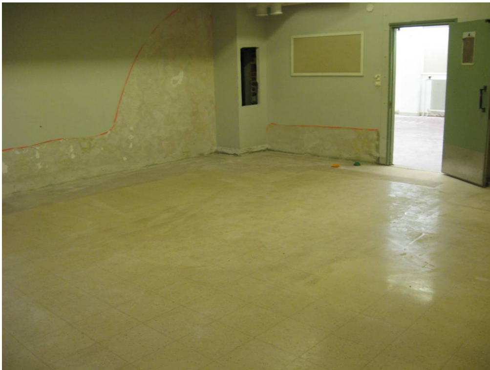
Kuva 20. Ensimmäisen kerroksen huoneessa on vesivahinko kunnostukset kesken, pinnat ovat kuivumassa.
