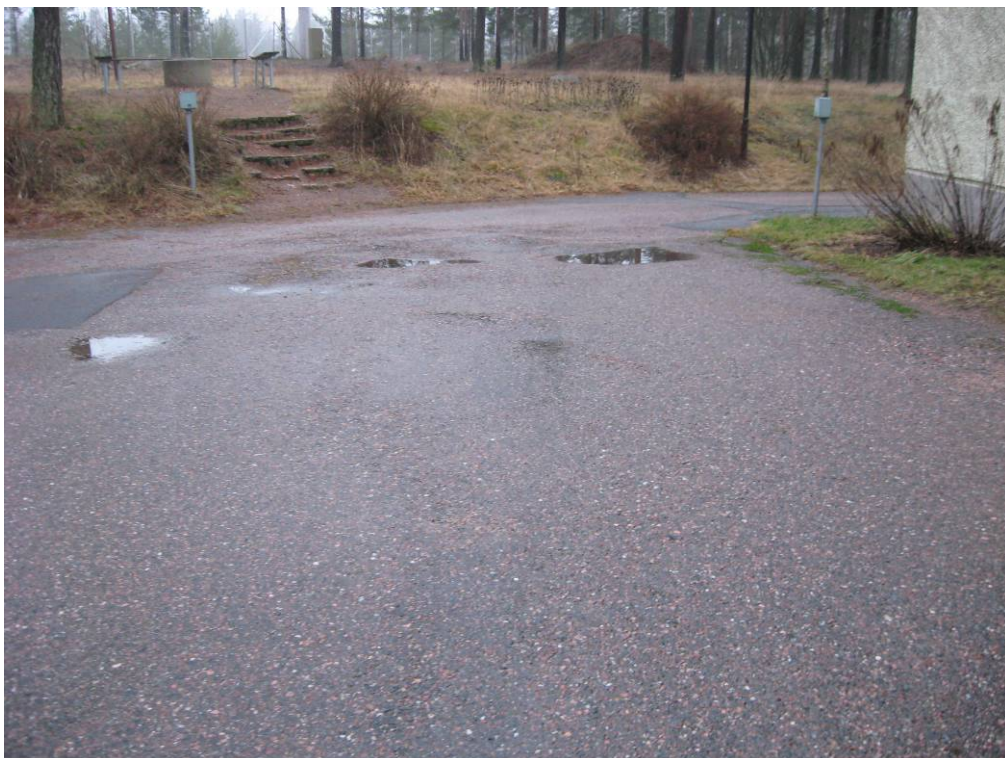
Kuva 2. Painumia asfaltoinnissa ja grillauspaikan portaissa on korjaustarvetta.
