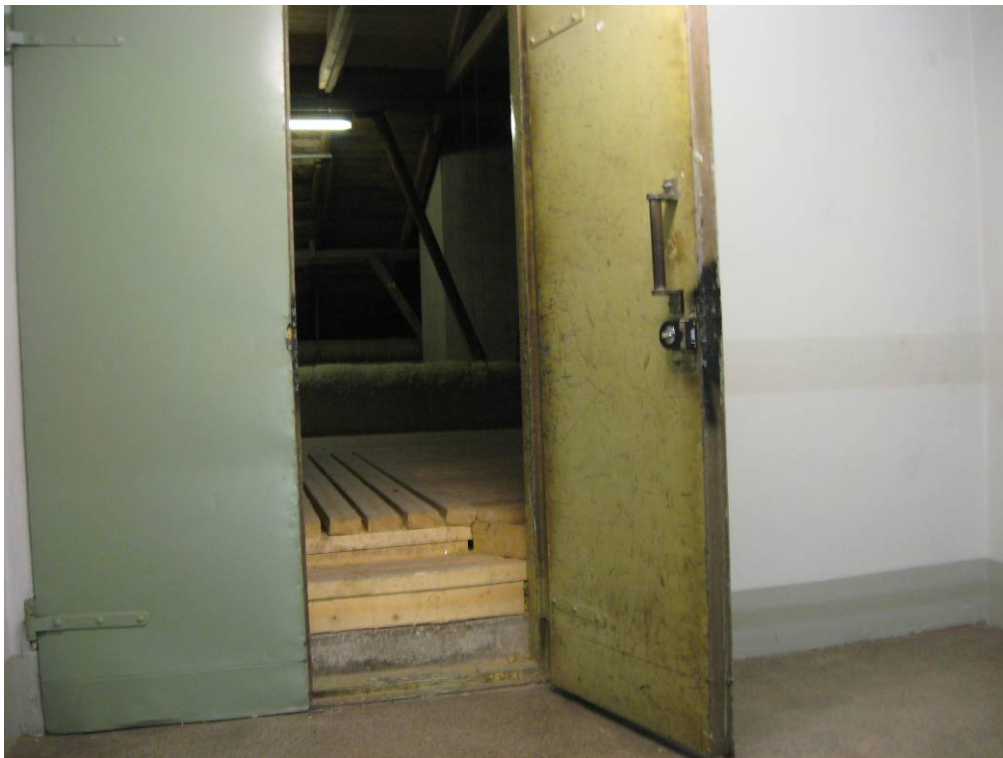
Kuva 14. Ullakon metalliovet niin kuin muutkin alkuperäiset metalliovet ovat huoltomaalauksen tarpeessa tarkastelujaksolla.
