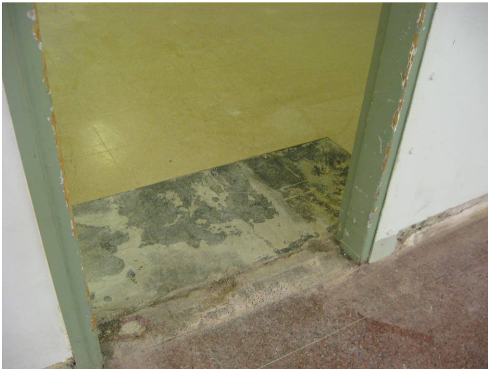
Kuva 26. Vinyylilaatat ja niiden kiinnitysaineet voivat sisältää asbestia. Ennen korjauksiin ryh- tymistä asbestikartoitus on tarpeen tehdä.
