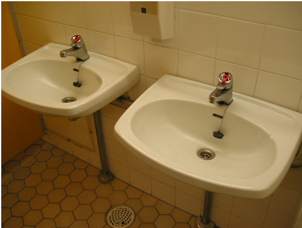
Kuva 7. Vesikalusteet 1990 -luvun vaihteesta ja kellarin lämmönjakohuoneen alkuperäiset vesikalusteet tulevat uusittavaksi tällä tarkastelujaksolla teknisen käyttöiän päättyessä.
