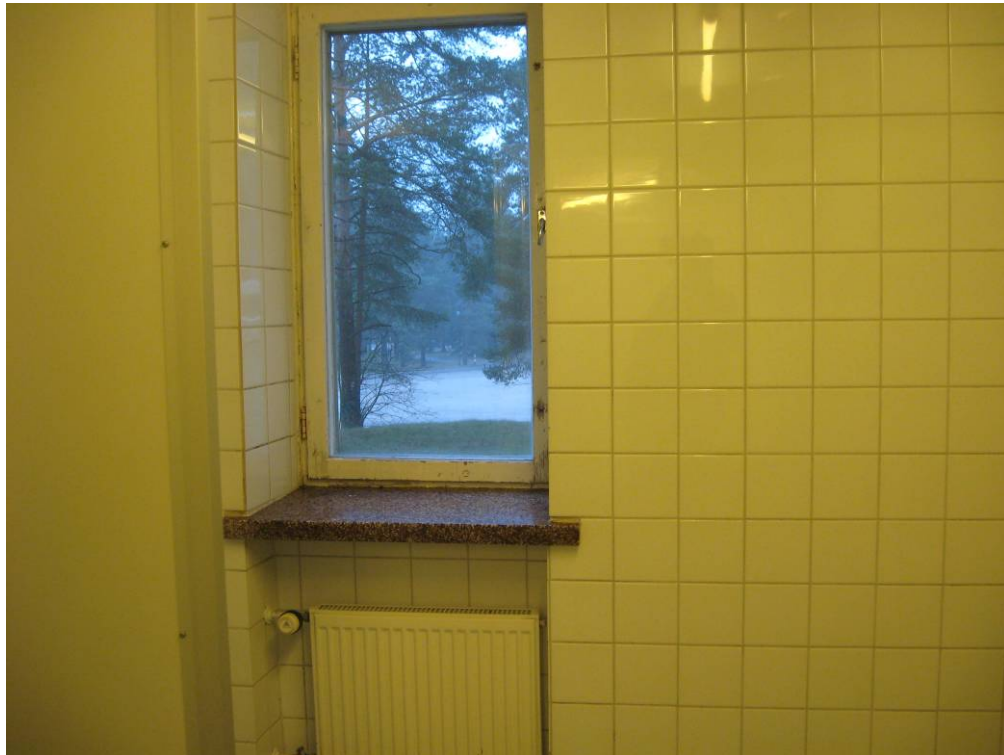
Kuva 23. Ikkunoissa on paikoitellen huoltomaalaustarvetta tarkastelujaksolla.
