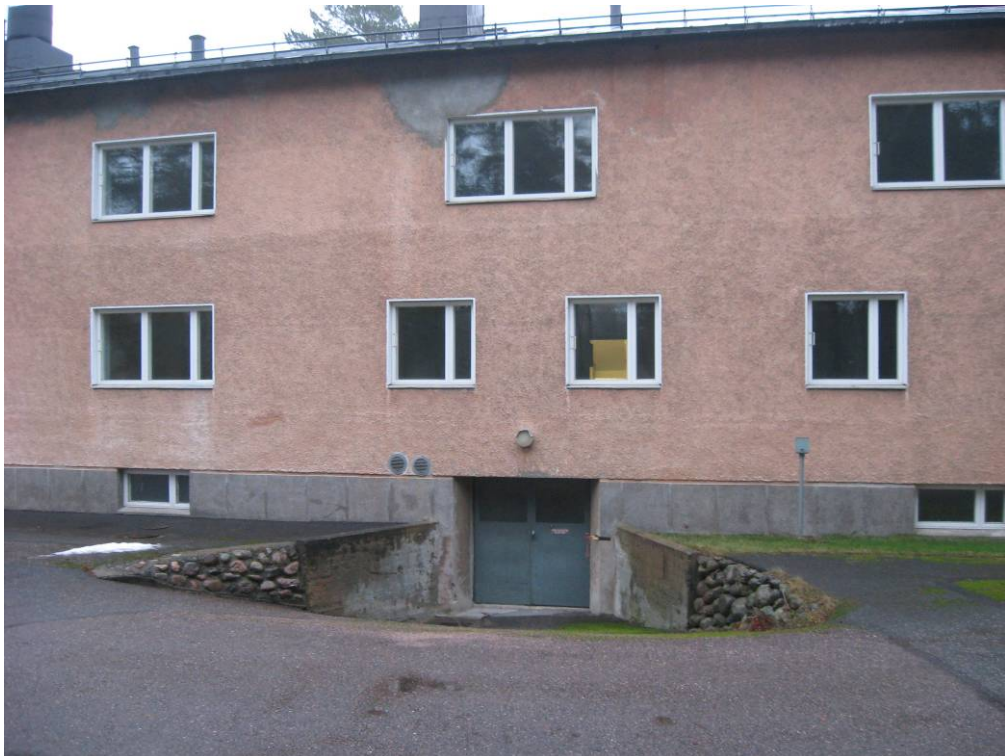
Kuva 6. Julkisivupinnoituksissa on paikkauksia eripuolilla rakennusta ja julkisivujen maalaus-kunnostus on ajankohtainen tarkastelujaksolla.
