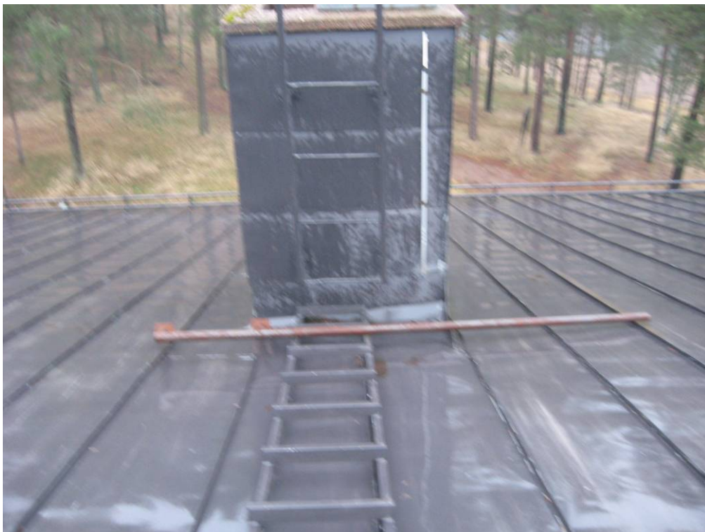
Kuva 10. Katolla oli irtonaisia metallitankoja, jotka tulisi poistaa tapaturmariskin takia.
