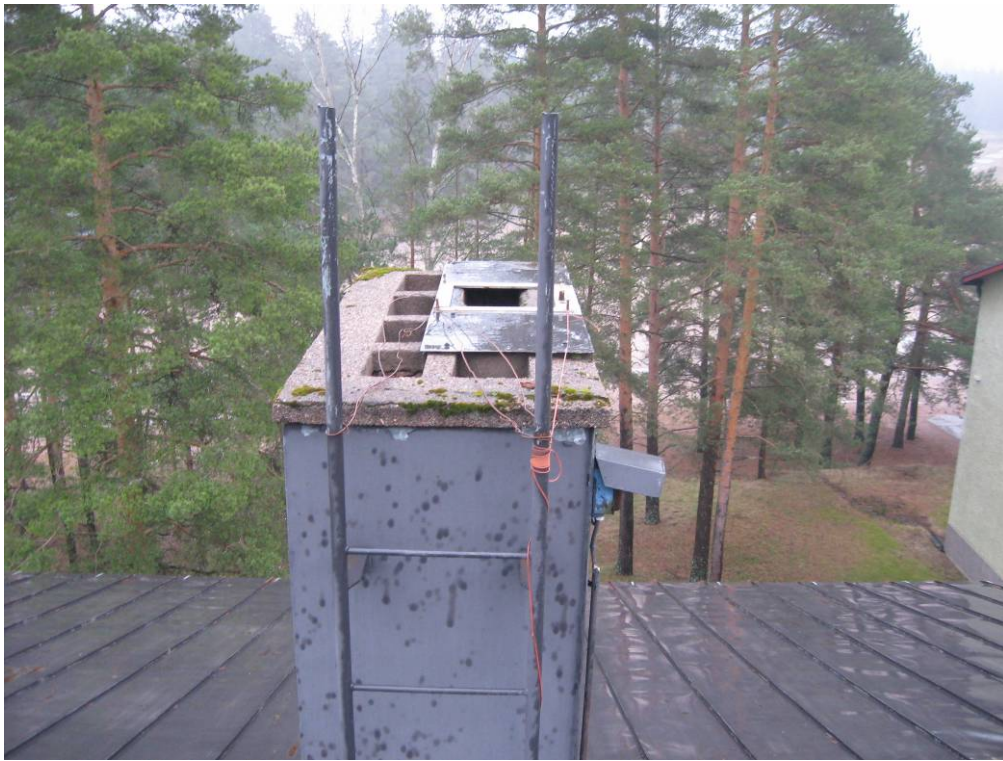
Kuva 9. Piippujen betonireunukset ovat rapautuneet, suositellaan piippuhattujen asennusta. Piippujen tikkaiden kiinnitys on paikoin löystynyt.
