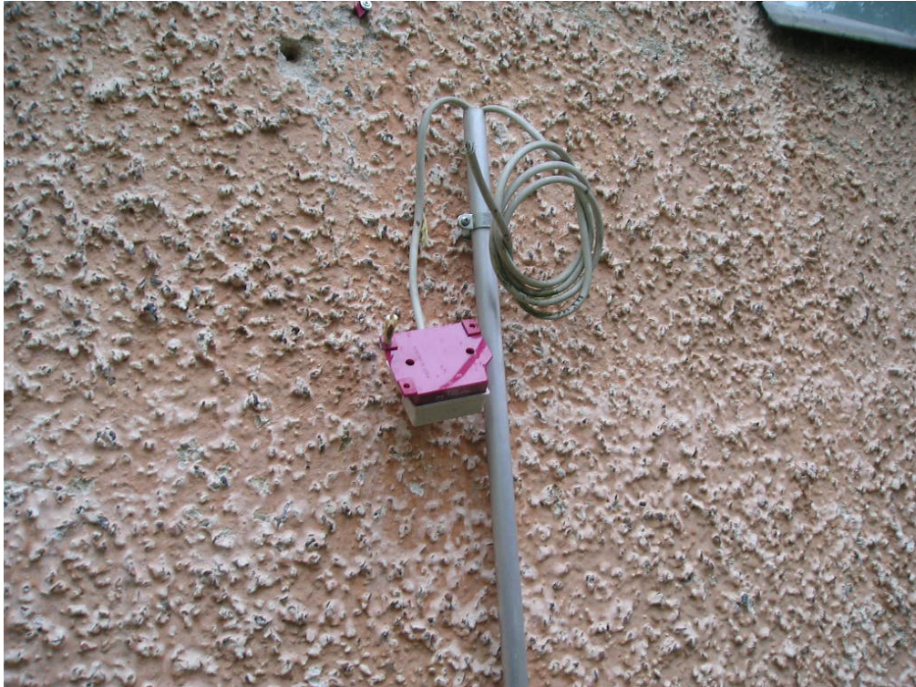
Kuva 7. Yhden ulkoanturin havaittiin olevan irti ja se tulisi korjata pikaisesti.
