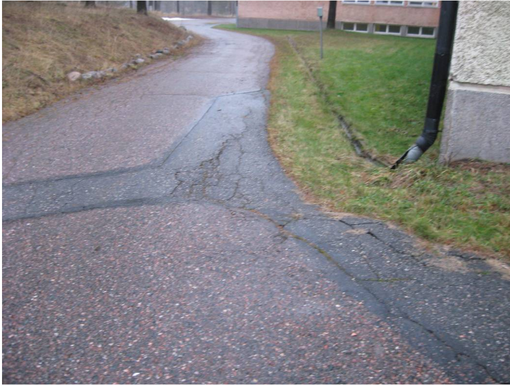
Kuva 3. Sadevesien johtamiseksi olevat avokourut ovat paikoin takakaatoiset ja kasvillisuutta oli kouruissa, asfaltin kunnostus tarvetta tarkastelujaksolla.
