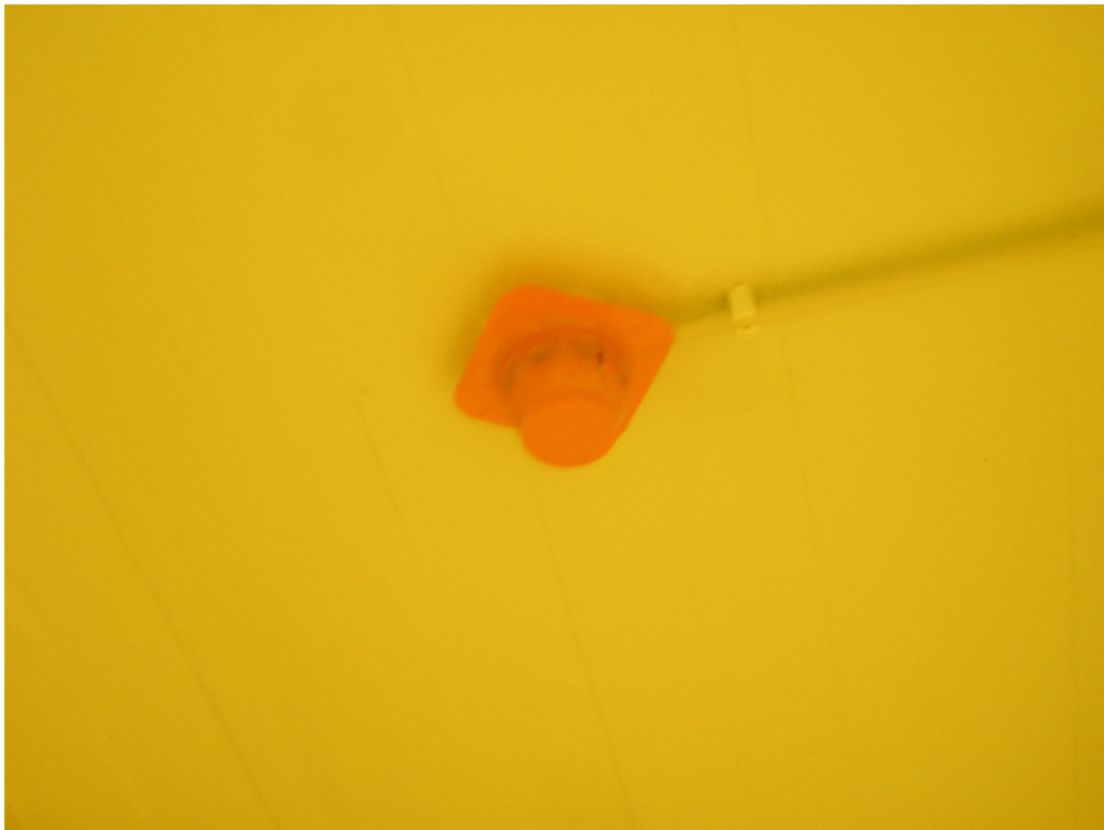
Kuva 4. Osa paloilmoinantureista oli huputettu korjaustöiden ajaksi, ne tulisi ottaa takaisin käyttöön heti korjaustöiden loputtua.
