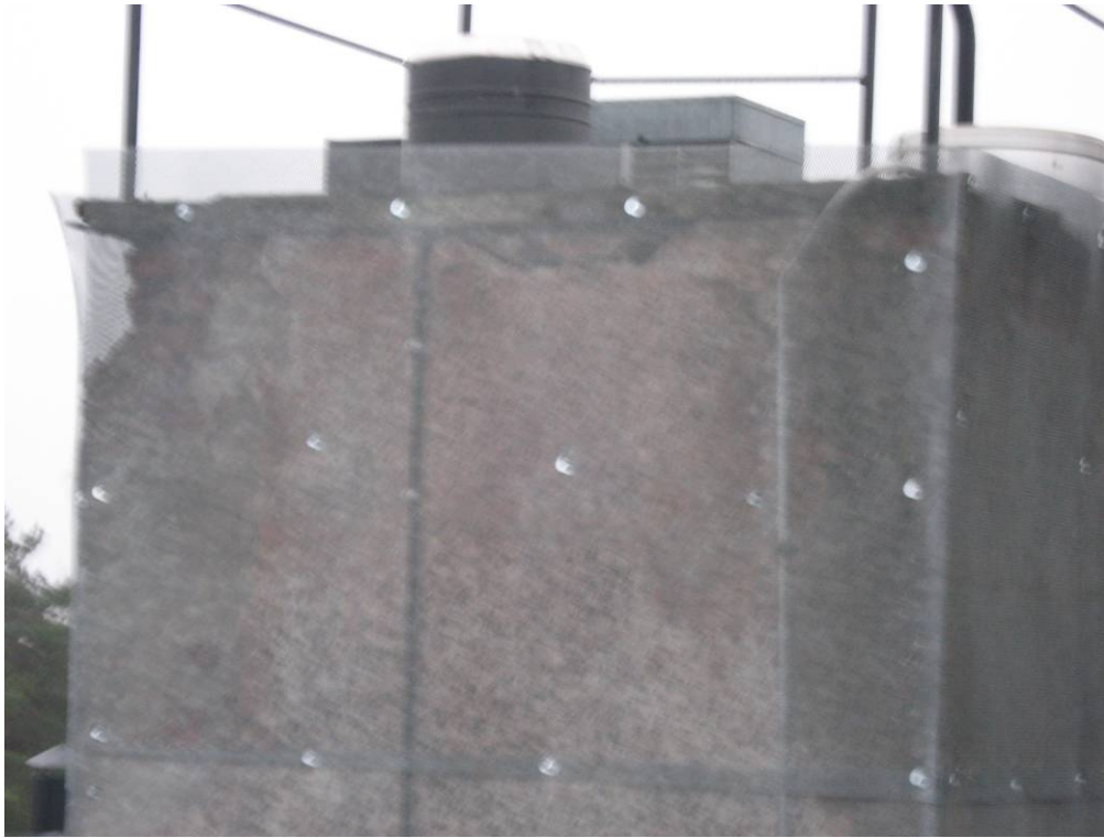
Kuva 11. Savupiipun suojaverkosta huolimatta rapautuneesta piipusta oli rappausta päässyt putoamaan katteen päälle, piipun kunto tulisi tutkia ja kunnostaa jotta vaurioituminen loppuisi.
