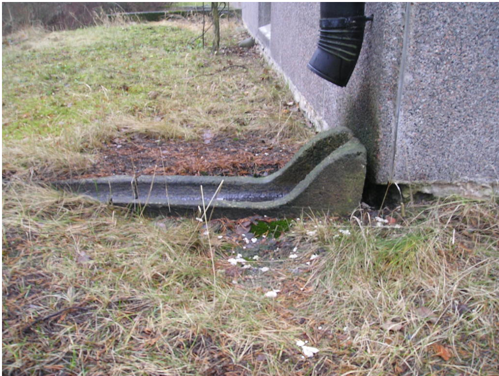
Kuva 6. Syöksytorvien alle maahan asennetut betoniset vesikourut ovat paikoin halki ja osassa virtaus-suunta (kaato) on jopa väärään suuntaan. Piha-alueen vesikourut tulisi korjata ja vesien johtamista poispäin rakennuksesta tulisi tehostaa.
