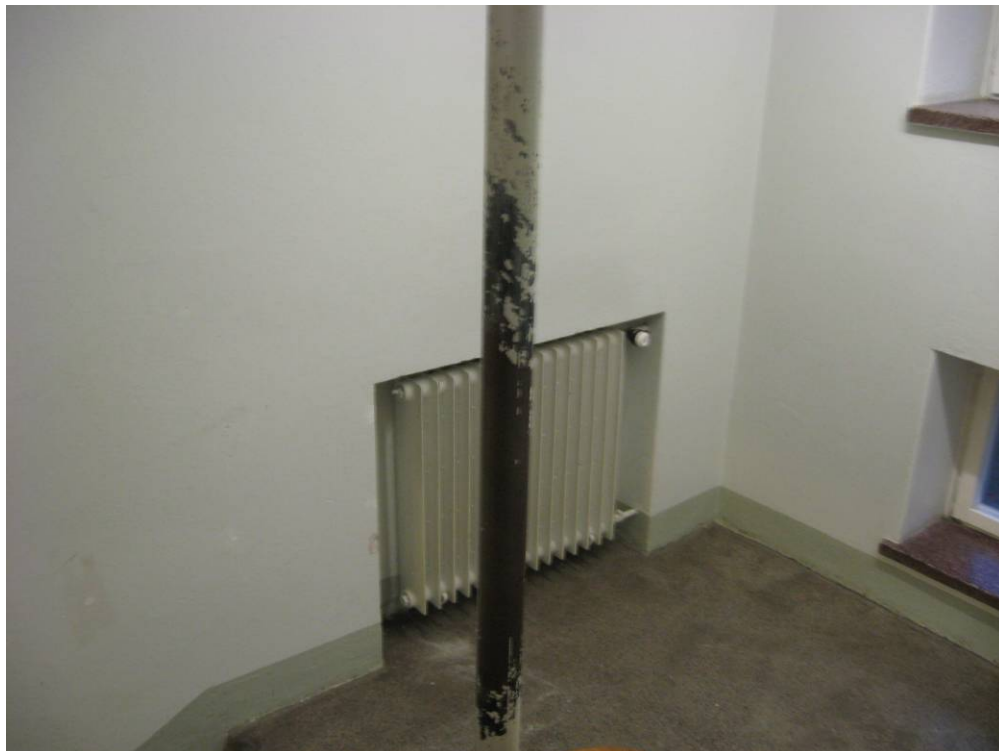
Kuva 24. Portaiden kaiteet ovat huoltomaalauksen tarpeessa tarkastelujakson alkupuolella.
