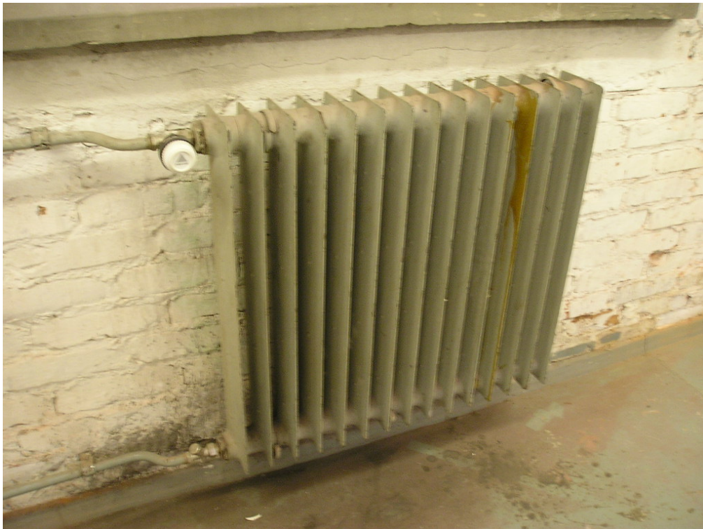
Kuva 2. Lämmityspattereissa havaittiin paikoin korroosiota ja kulumista. Niiden uusiminen ajoittuu tälle tarkastelujaksolle teknisen käyttöiän päättyessä. Suosittelemme samalla uusia maan termostaattiventtiilit.
