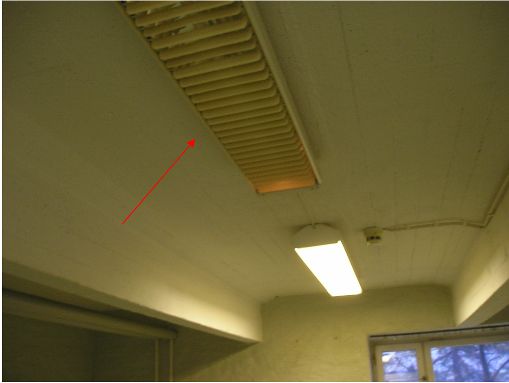
Kuva 3. Osa valaisimista oli katselmushetkellä pimeänä / rikki tai niistä puuttui suojakupu, vialliset valaisimet tulisi korjata valaisinhuoltojen yhteydessä.
