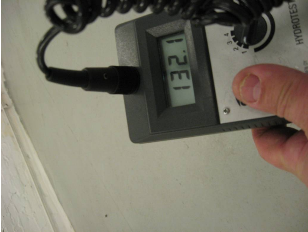
Kuva 17. Kellarissa pohjoisosan päädyssä/itäpuoleisessa huoneessa mitattiin kohonneita kosteuskukemia maanvaraisesta betonilaatasta (kosteus raja betonille on asteikossa 70).
