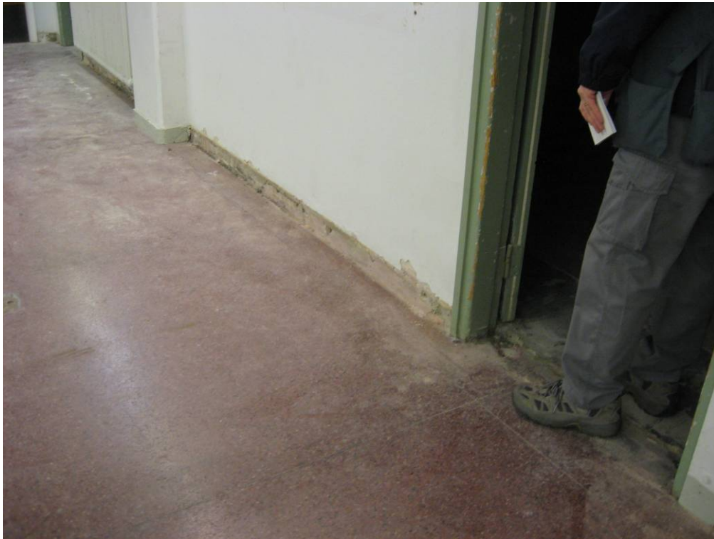
Kuva 19. Tapahtuneen vesivahingon jäljiltä on kunnostustarpeita pohjoisosan käytävässä.
