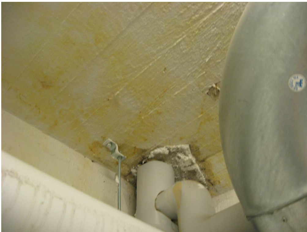
Kuva 16. Aiemmin tapahtuneen vesivahingon jäljet olivat näkyvissä kellaritiloissa.
