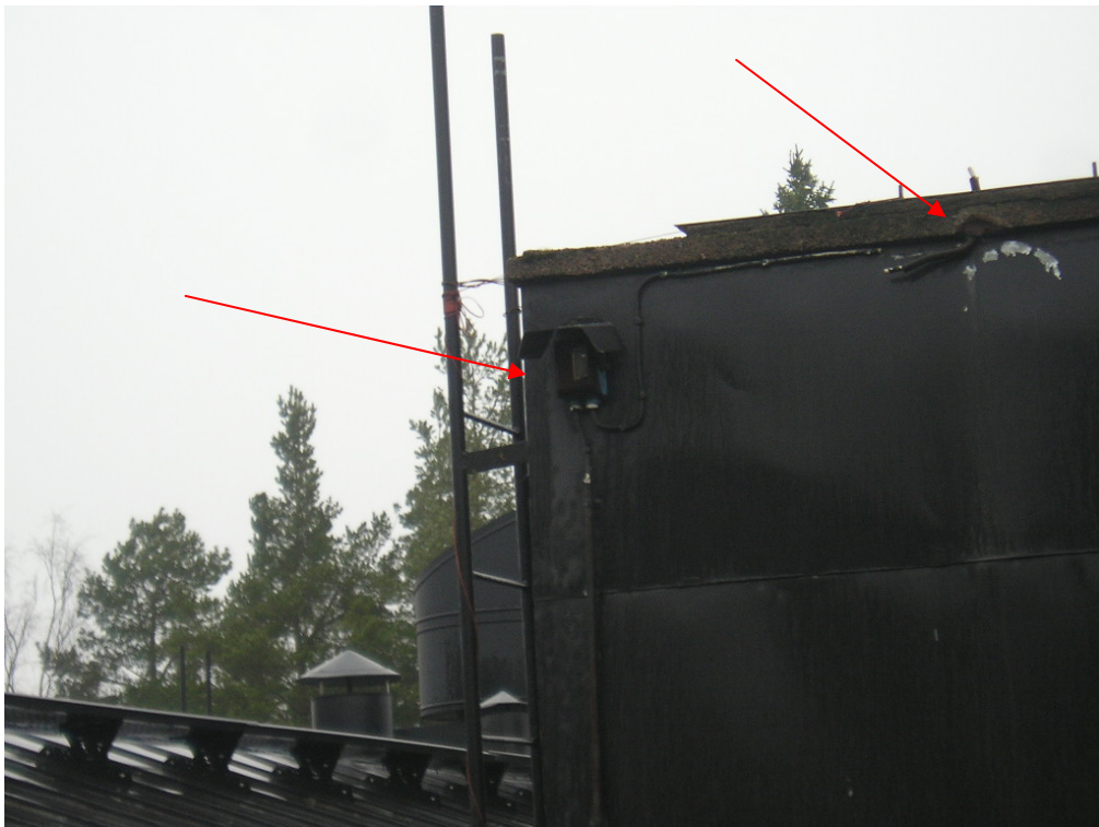
Kuva 2. Vesikatolta käytöstä poistettujen huippuimureiden tarpeettomat turvakytkimet ja johdotukset suositellaan purettaviksi.
