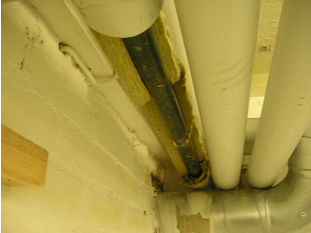
Kuva 5. Putkieristeissä havaittiin jotain vikoja ja puutteita, jotka tulisi korjata huoltotyönä.
