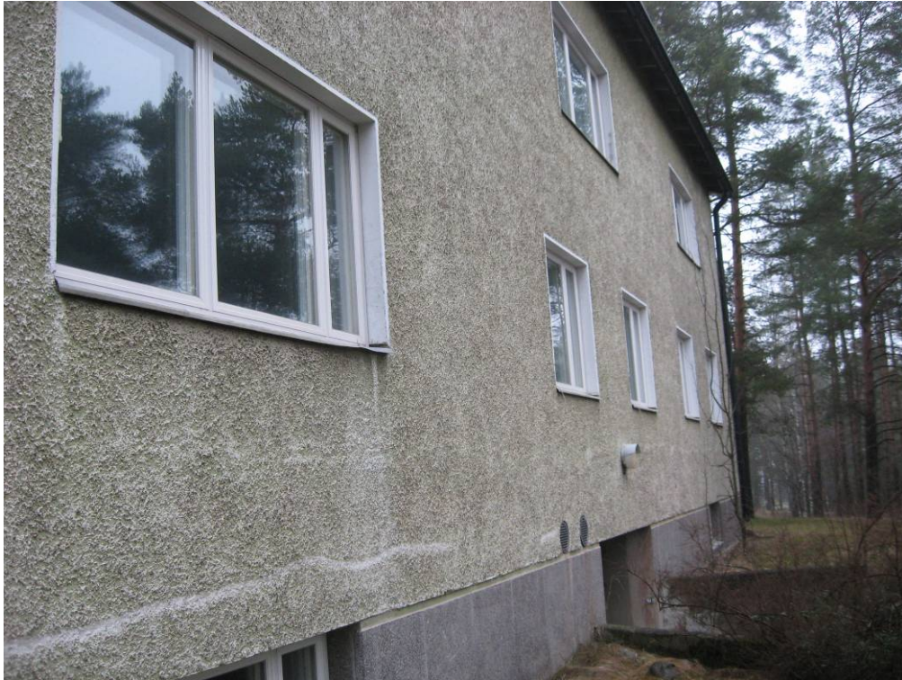
Kuva 7. Ikkunoiden tippapellit paikoin vääntyneet, kunnostus julkisivumaalauksien yhteydessä.
