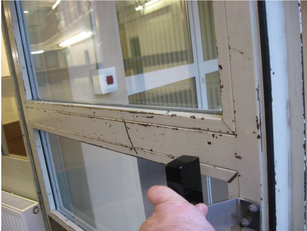
Kuva 13. Ulko-ovien huoltomaalaus on ajankohtainen tarkastelujaksolla.
