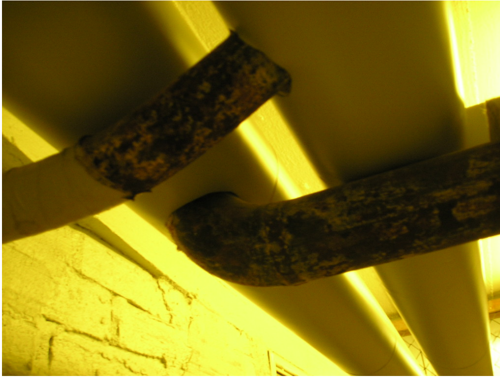
Kuva 3. Lämmitysputkien haaralinjojen uusimista tulisi harkita lämmityspattereiden uusinnan yhteydessä. Niissä havaittiin paikoin korroosiota ja kulumista.
