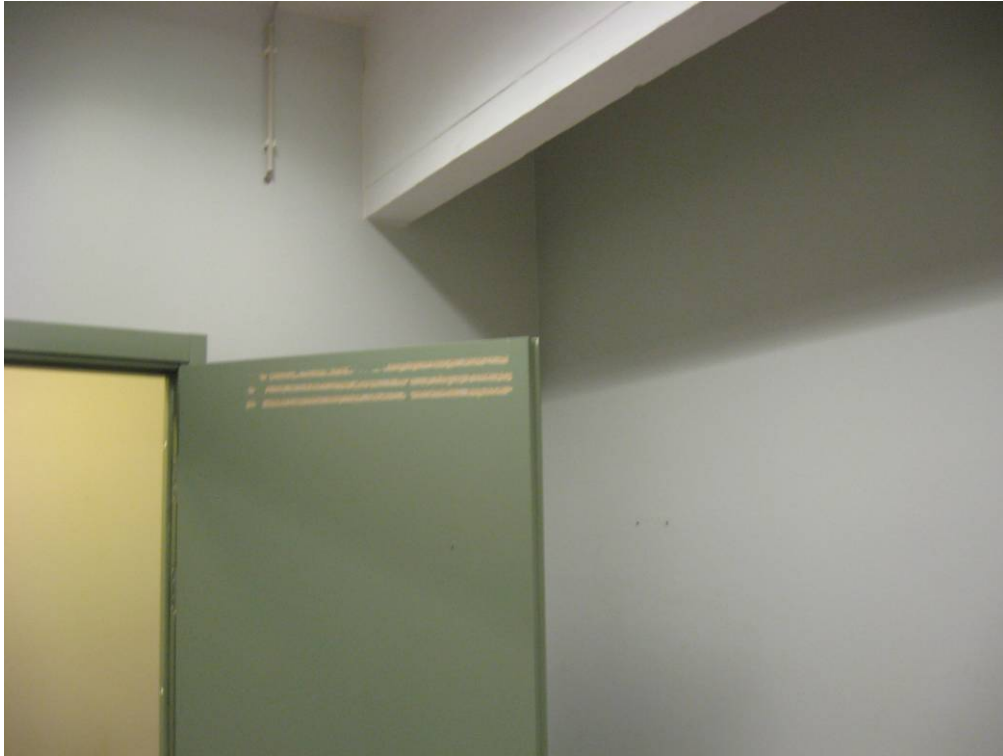
Kuva 15. Puulaakaovissa oli sekä uudemmissa että alkuperäisissä huoltomaalauksen tarvetta tarkastelujaksolla.
