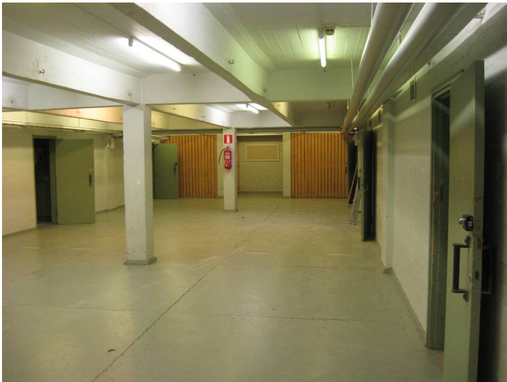
Kuva 18. Kellarin pinnoitukset on määriteltävä tulevan käyttötarkoituksen mukaisesti, nykyisellään maalaus-kunnostusta vaativat lähinnä lattiapinnat tarkastelujaksolla.
