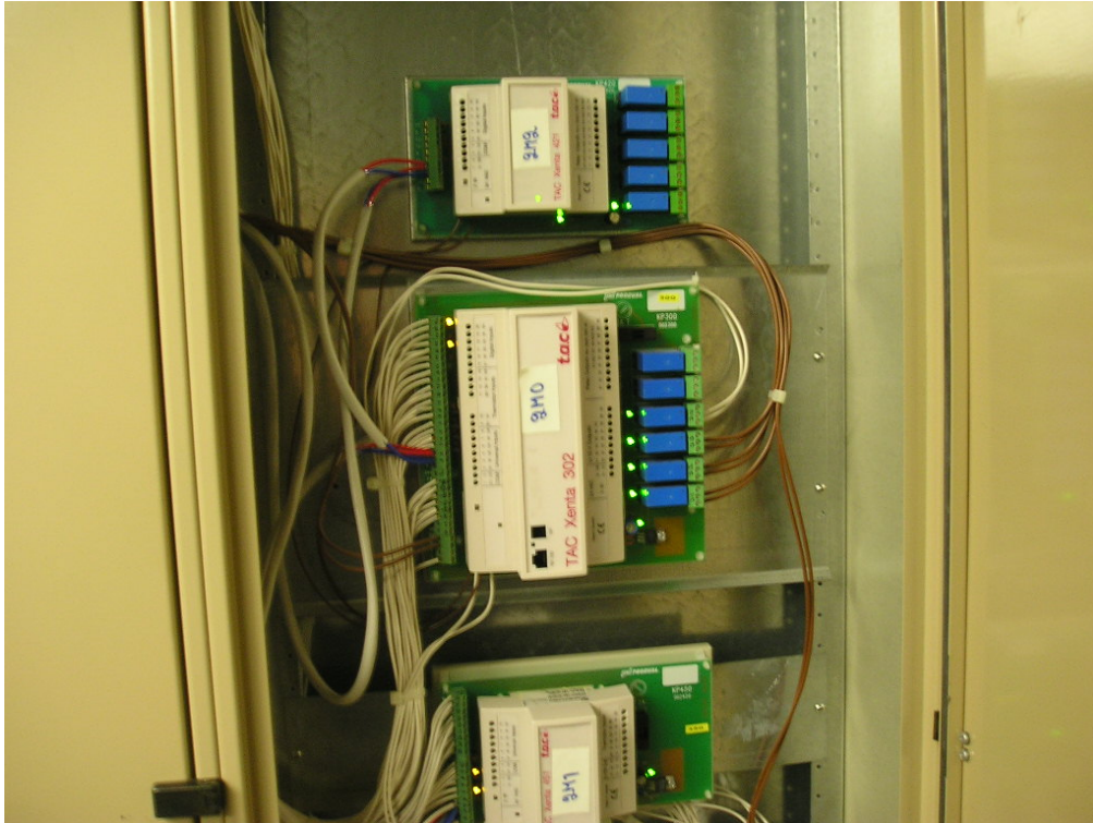
Kuva 5. Automaatiolaitteet (LVI) ovat pääosin saneerausvuodelta 1997, niiden uusimiseen tulee varautua tämän tarkastelujakson aikana teknisen käyttöiän päättyessä.
