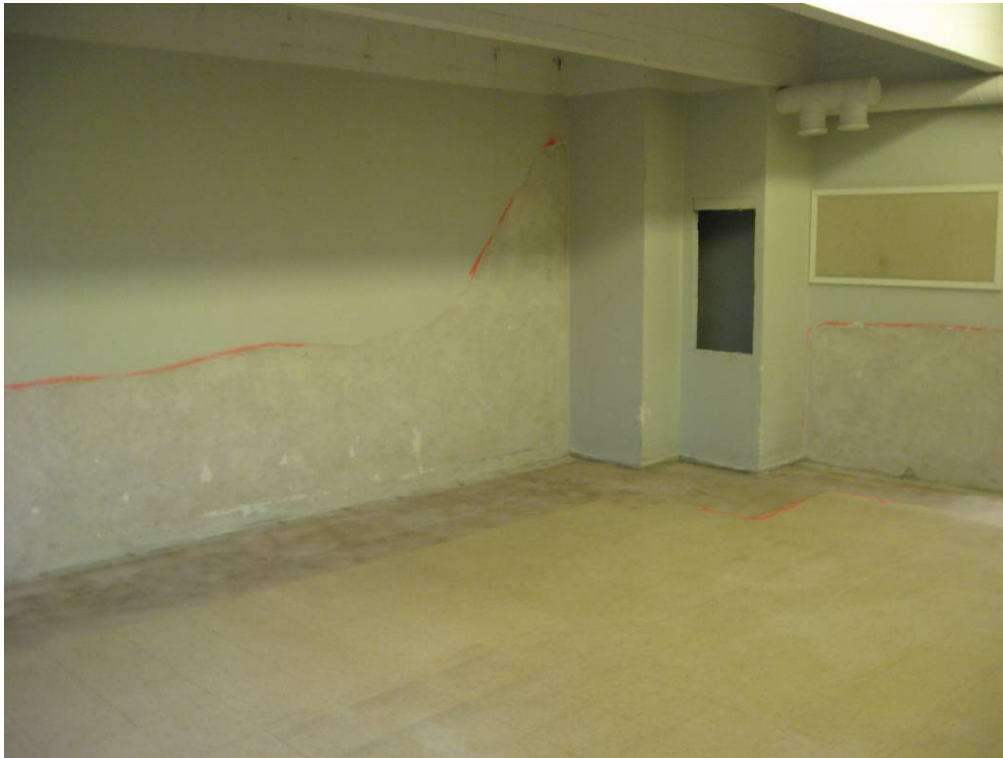
Kuva 21. Toisen kerroksen huoneessa oli myös vesivahingon kunnostustoimet kesken.
