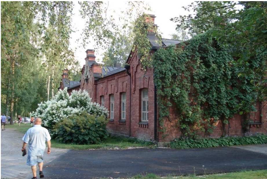
Entinen komentajan asuinrakennus (rakennus 8).
