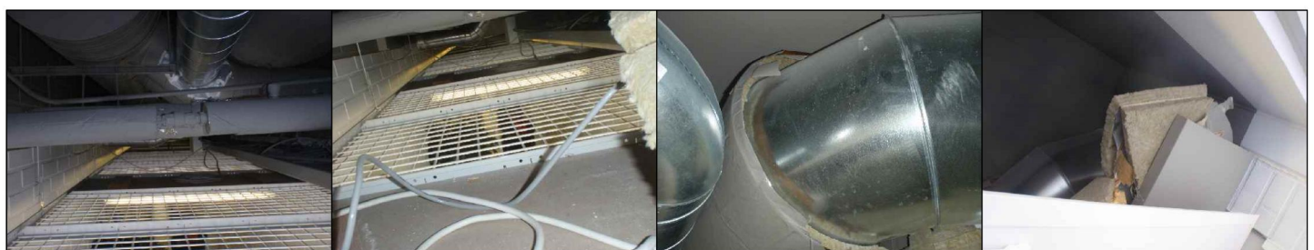
KUVA 3: Kuvia alaslasketun käytävän katon päältä
