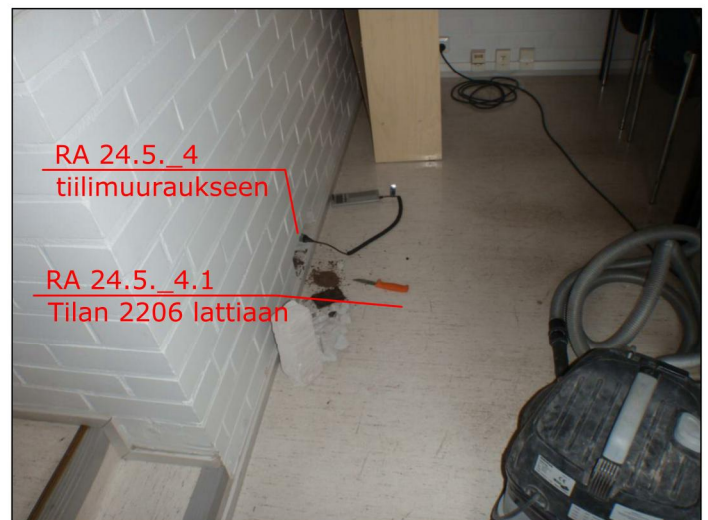
KUVA 2: Rakenneavaus lähempää
