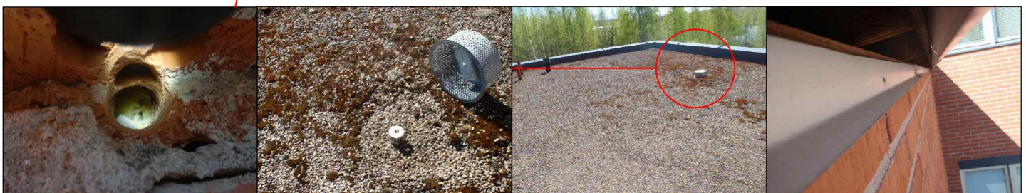
KUVA 3: Rakenneavauksen jatkaminen poraamalla ja kuvia vesikatoilta
