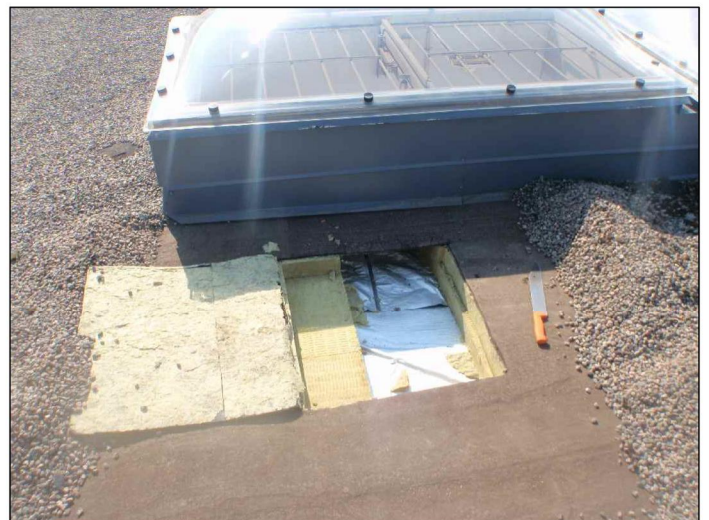
KUVA 2: Rakennusosa RA 5.6._2 (alkuperäinen osa)
