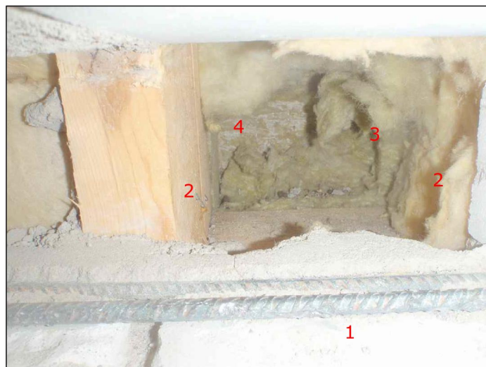
KUVA 2: Rakennekerrokset
