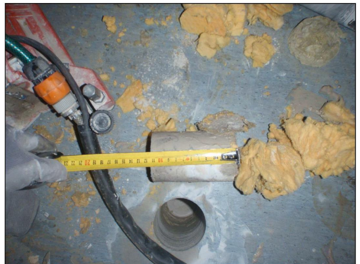
KUVA 2: Rakennearaus RA 5.6._4 (laajennusosa)
