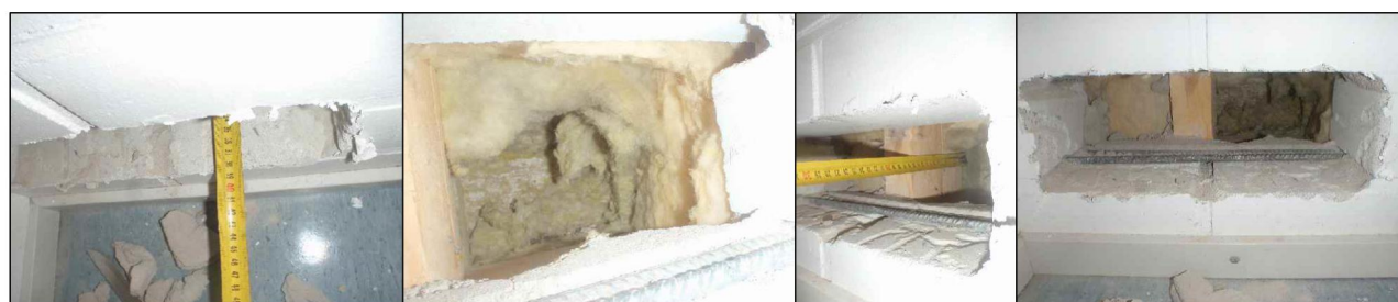
KUVA 3: Kuvia rakenneavauksesta
