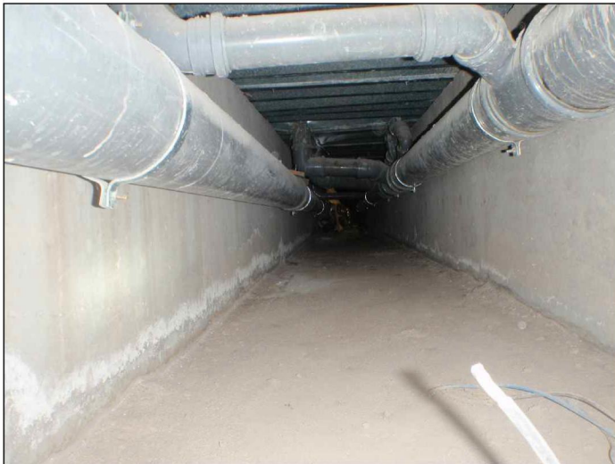
KUVA 1: Kanaali IV-katosten kohdalla (toimisto-/laboratorio-osa)
