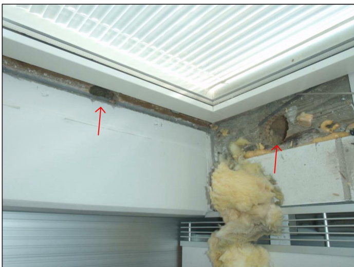
KUVA 1: Rakenneavauskohdat
