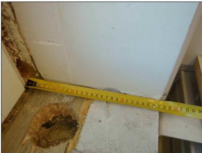
KUVA 1: Rakenneavaus ja ikkunan sijoittuminen
