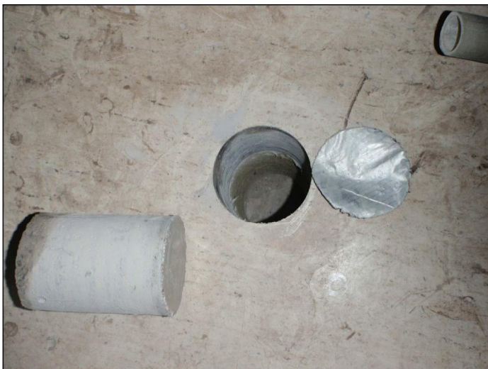
KUVA 1: Rakennearaus RA 5.6._3 (alkuperäinen osa)
