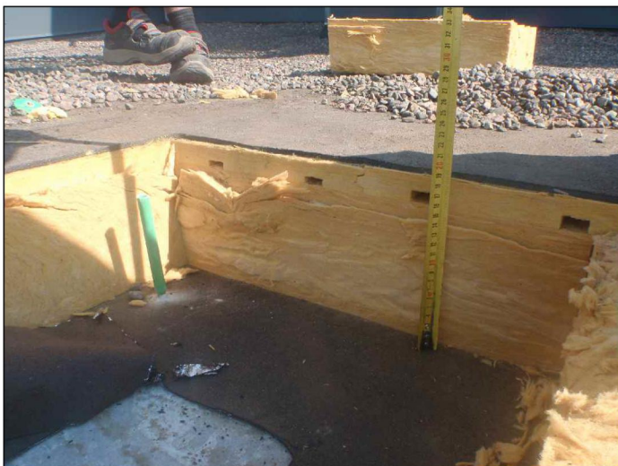
KUVA 1: Rakennusosa RA 5.6._1 (laajennusosa)
