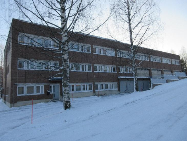
A-rakennus koillisesta päin kuvattuna
