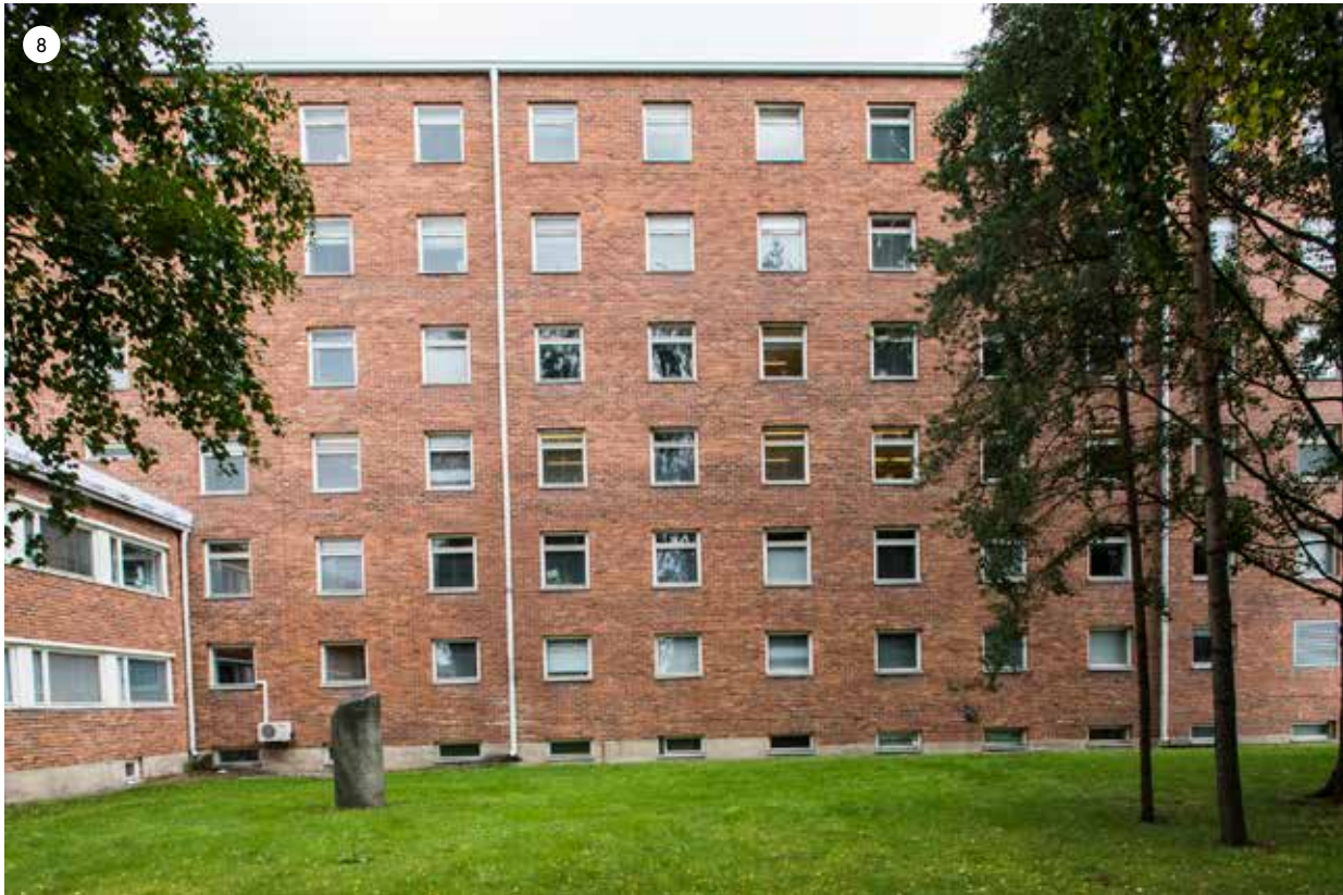
Rakennuksen ikkunat on sommiteltu tasaiseksi ruudukoksi. Siipien edustalla sijaitsi 2000-luvun alkuun saakka näyttekivipiha, joka näkyy varhaisemmissa valokuuvissa.
