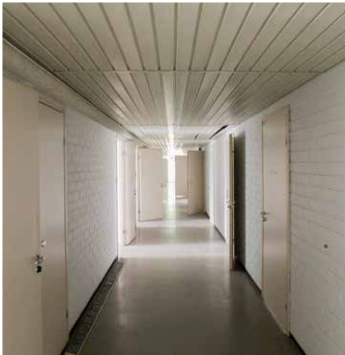
Keskikäytävän seinämateriaalina on valkoiseksi maalattu kahi-tiili. Alakaton metallisäleiköt ovat pääasiassa alkuperäisiä.
