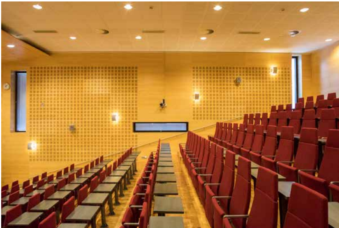
Auditorion kolme pitkänomaista ikkunaa sijaitsevat sen pohjoisjulkisivulla. Auditorion seinät ovat viilupäällysteistä MDF-levyä.
