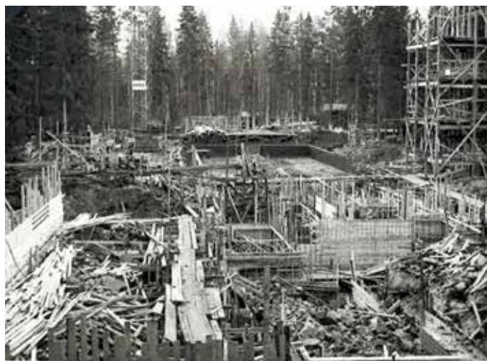
Näkymä työmaan pohjoispäästä katsoen lokakuussa 1954. GTKA.
