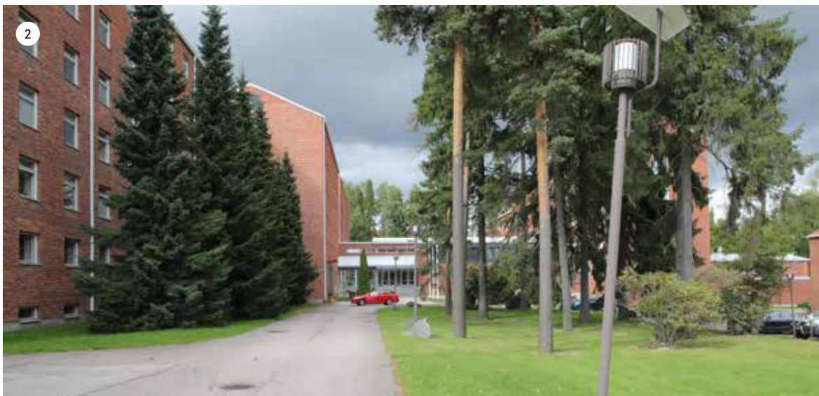
Näkymä Miestentieltä nykyiselle pääsisäänkäynnille. Vanhimman rakennusosan seinustalla kasvaa ryhmä vanhoja kuusia.
