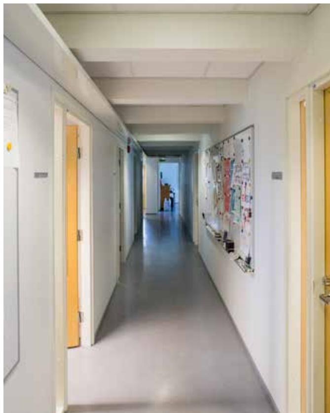
Pihasiiven ensimmäinen kerros on otettu toimistokäyttöön jakamalla avoin tila kevyin väliseinillä toimistohuoneiksi.
