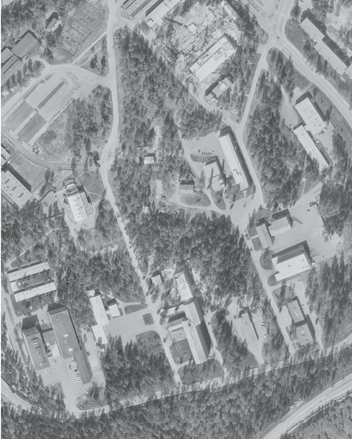
Ilmakuva Kivimiehen alueesta vuonna 1969. Geologisen tutkimuslaitoksen laajennussiipi on rakennustyömaana. Sen länsipuolella näkyy 1950-luvun alussa rakennettu, tontilla 1980-luvulle asti sijainnut puurakennus. HRI.
