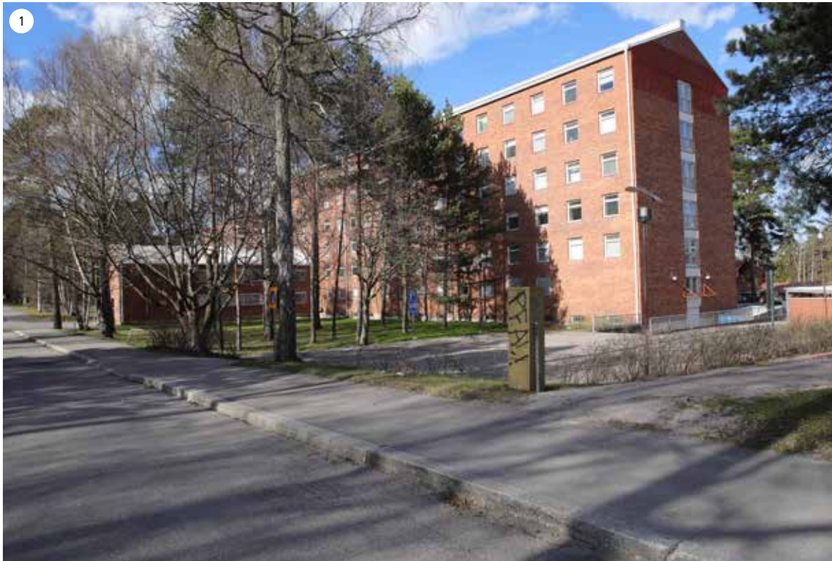
Ensimmäinen rakennusvaihe, näkymä Miestentien ja Kivimiehentien risteykseen.
