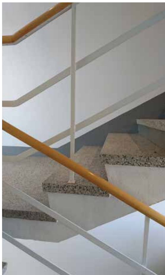
B-portaan teräskaiteet ovat yksinkertaisen linjakaat ja koostuvat valkoisiksi maalatuista pystypinnoista ja vaakasuuntaisista lattarautoista.
