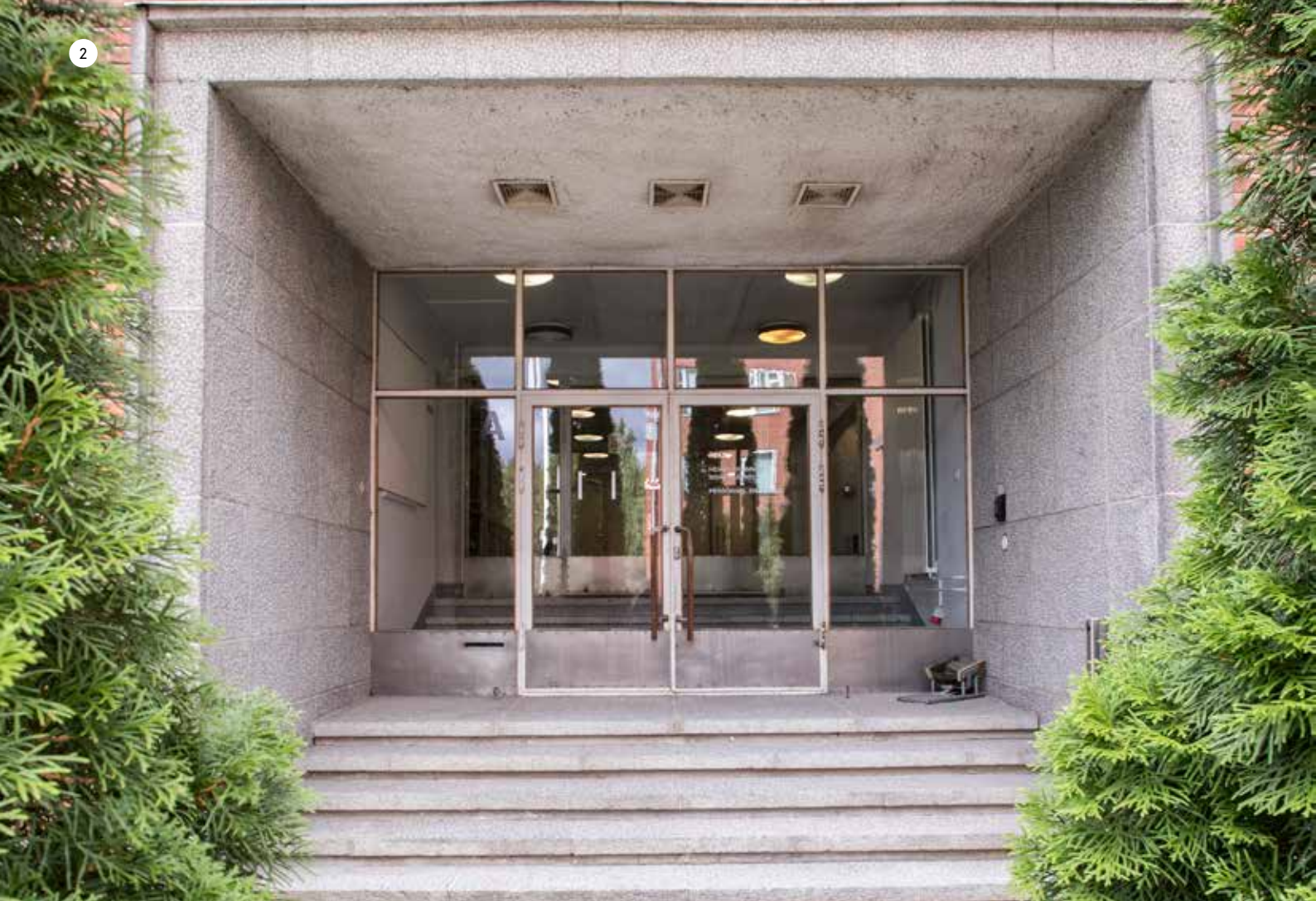
Alkuperäinen pääsisäänkäynti on päällystetty ristiinhakatulla harmaalla graniitilla.
