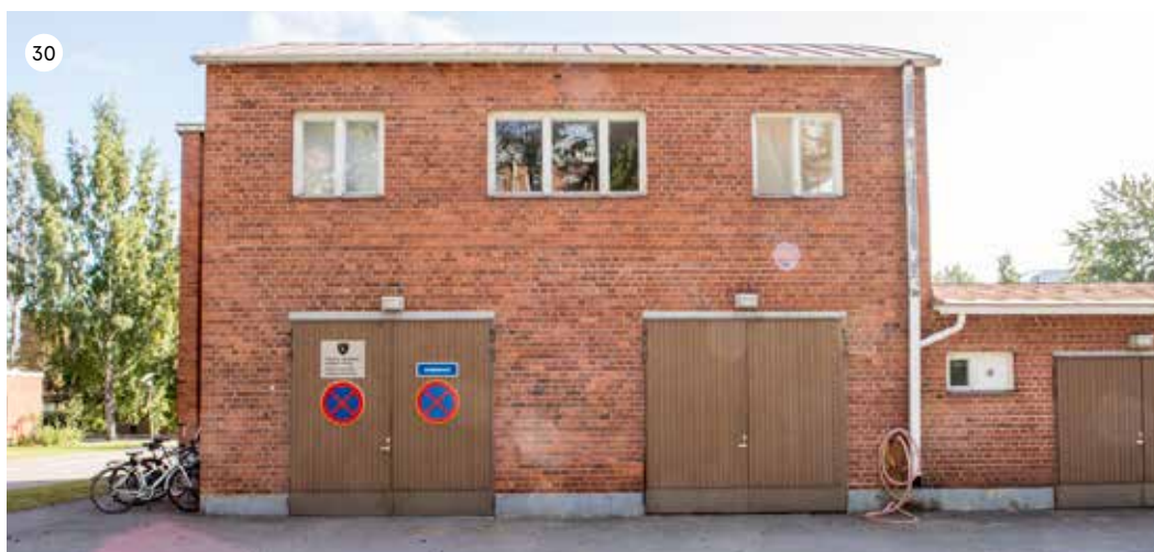
Noppamainen kaksikerroksinen osa on vuokrattu pelastuslaitokselle. Yläkerrassa sijaitsee alun perin työnjohtajan asunto ja alakerta oli varattu huolto- ja varastotiloille.
