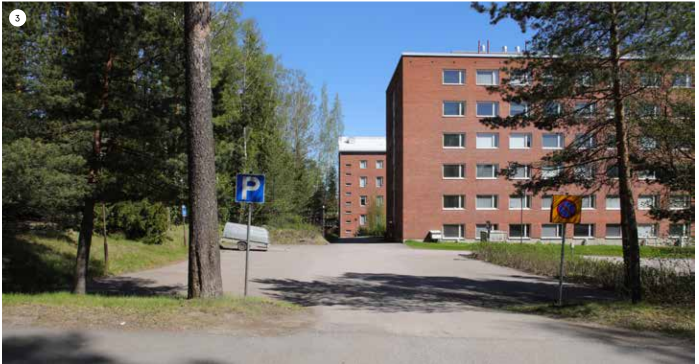
Näkymä Kivimiehentieltä tontin pohjoisosaan. Rakennussiivet rajoittuvat tontin pohjoisosan metsikköön. Kuvan etualalla näkyvässä tontin pohjoiskulmassa sijaitsi kaksi 1950-luvun alussa rakennettua varasto- ja asuinrakennusta, joista viimeinen purettiin 1980-luvulla pysäköintialueen tieltä.
