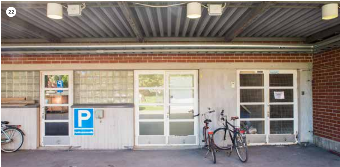
Lastauslaiturin ovi- ja materiaalamailmaa yhdistettynä lasitiilikenttään.
