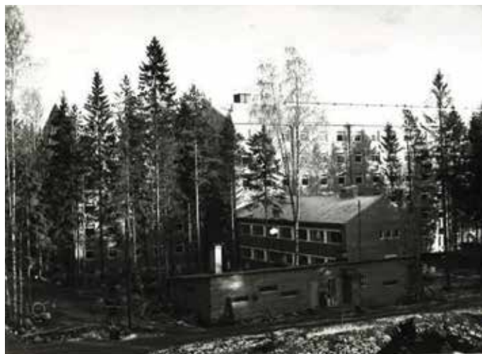
Näkymä työmaalle lännestä lokakuussa 1955. Etualalla Kivimies-hentien varteen rakennettu työmaaparakki. GTKA.
