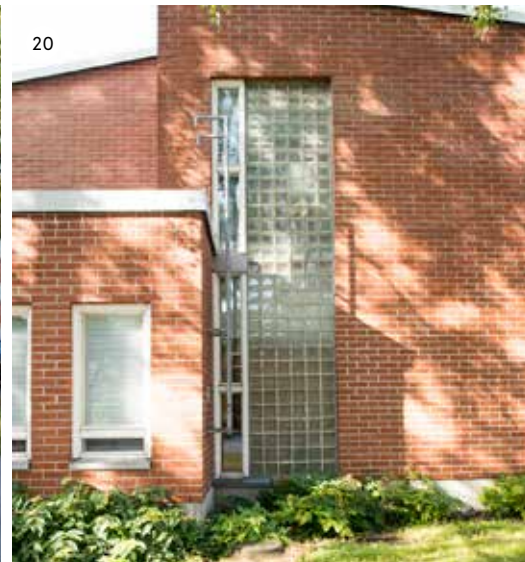
Siiven päässä on käytetty ikkunoiden ohella lasitiilikenttiä.
