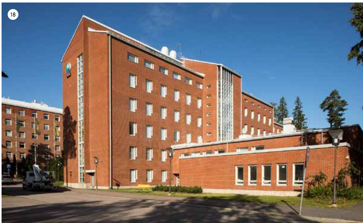
Laajennusosan hahmo on ottanut vaikutteita ensimmäisestä, satulakattoisesta rakennusvaiheesta. Arkkitehtuuri on kuitenkin ajalle tyypillistä laitosrakentamista, jossa suurta rakennusmassaa on rikottu porrastuksin ja sisäänvedoin.
