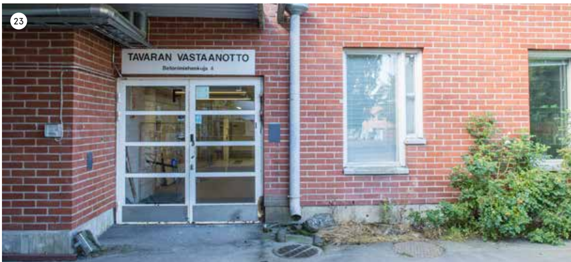
Kolmannen rakennusvaiheen ulko-ovityyppi on teräs-lasirakenteinen ovi, jota on käytetty yhden ovilehden ovissa ja pariovissa. Oikealla laajennusosan tyyppi-ikkuna.
