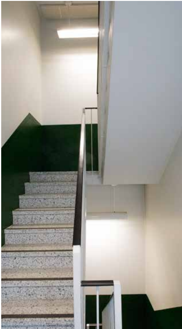
1980-luvun laajennuksen sekundääriset porrashuoneet ovat kapeita. Kaksivartiset portaat on rakennettu porraselementeistä.
