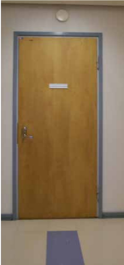
Alkuperäinen puuviilulaakaovi, joka on varustettu sinertävillä ovilistoilla.
