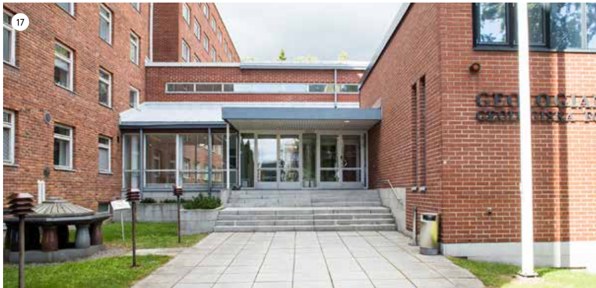
Kolmannen laajennusosan sisäänkäyntiä laajennettiin vuonna 1998 ja myöhemmin sisäänkäyntiä avartamalla siitä tehtiin rakennuksen pääsisäänkäynti.
