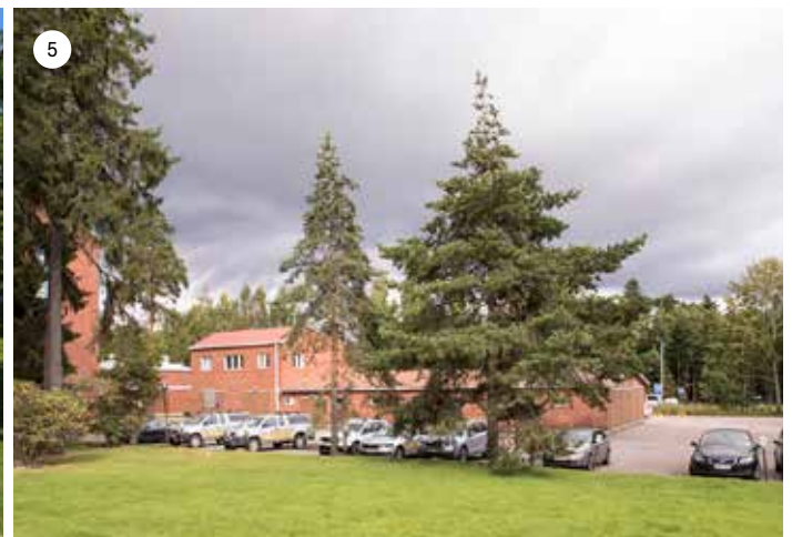
Autotallirakennus ja pysäköintialue kuvattuna lounaasta. Pysäköintialueen erottaa ensimmäisestä rakennusvaiheesta laaja nurmialue.
