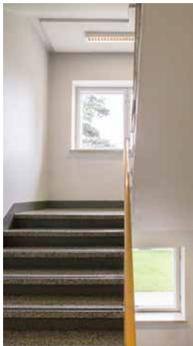
B-portaan ikkunat ovat kaksiosaisia, kaksipuitteisia puuikkunoita ja selvästi arkisempia kuin pääportaan ikkunat.
