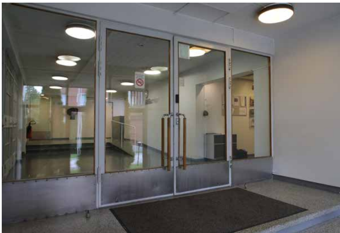
Alkuperäiset pääsisäänkäyntiovet ovat säilyneet alkuperäisinä vetimineen. Tuulikaappitilassa on neljä porraskelmaa ja sen lattiamateriaali on mosaiikkibetonia.
