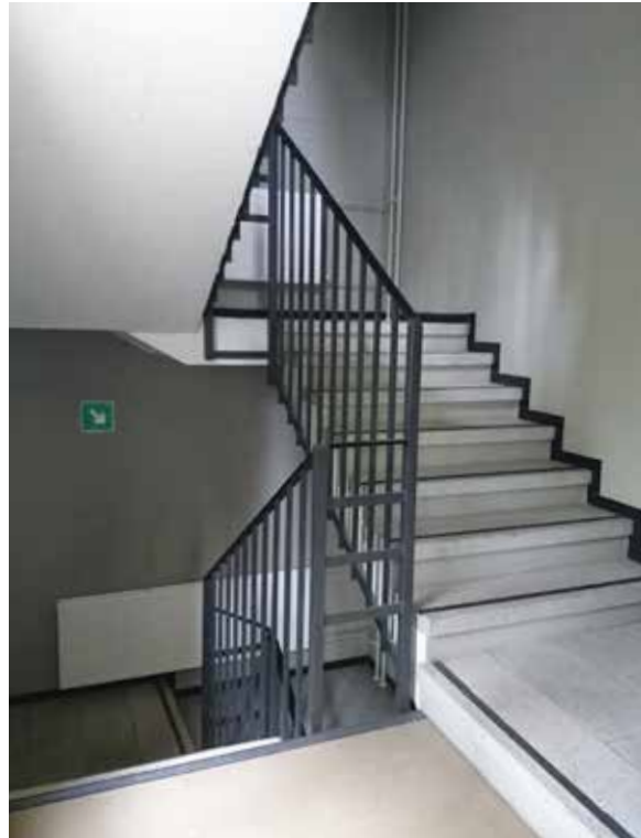
Pienemmän B-porrashuoneen kaksivartinen porras noudattaa pääportaan materiaali- ja kaideratkaisuja.
