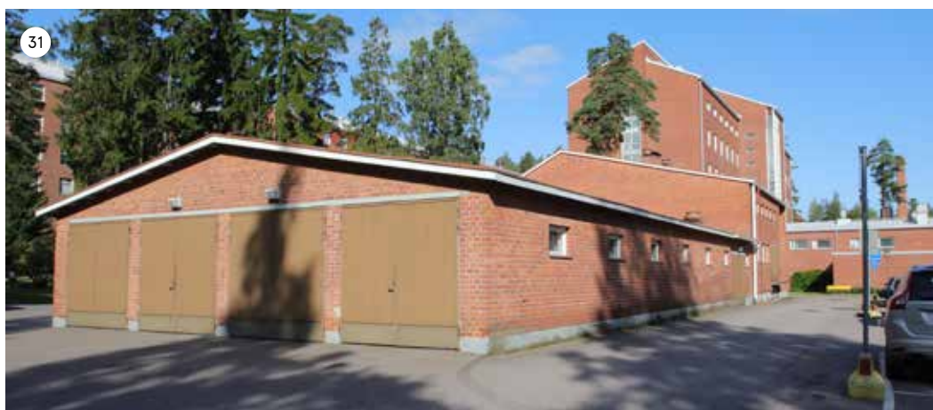
Autotallirakennus on ulkohaamoltaan horisontaali ja sen loiva satulakatto noudattelee tutkimuslaitosrakennuksen vanhimman osan kattoratkaisua.
