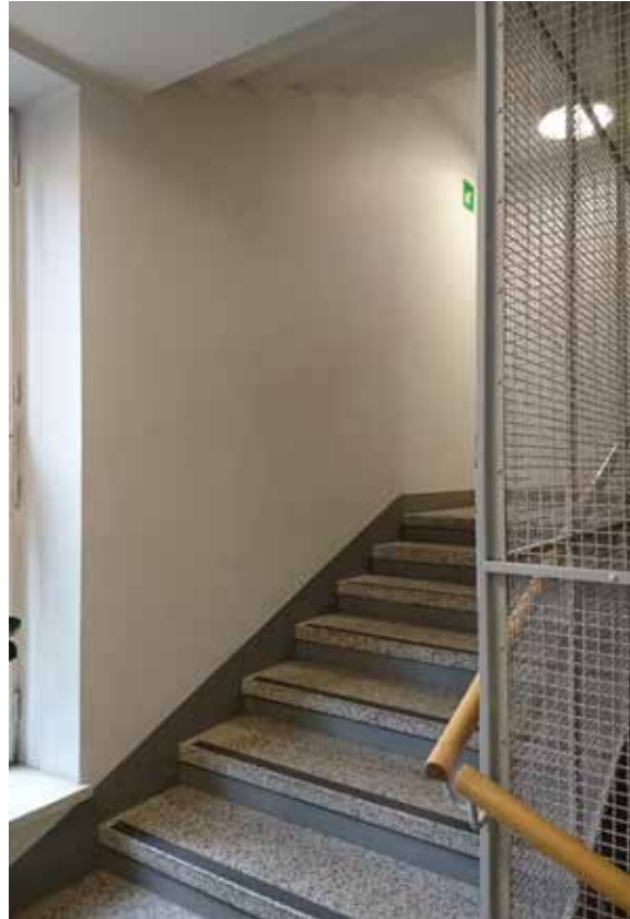
Pääporras on päällystetty mosaiikkibetonilla.
