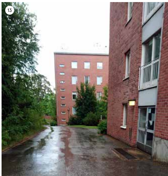
Rakennuksen pohjoispuolella on kulkureitti, joka rajautuu rakennussiipiin ja tontin pohjoisosan metsikköön.
