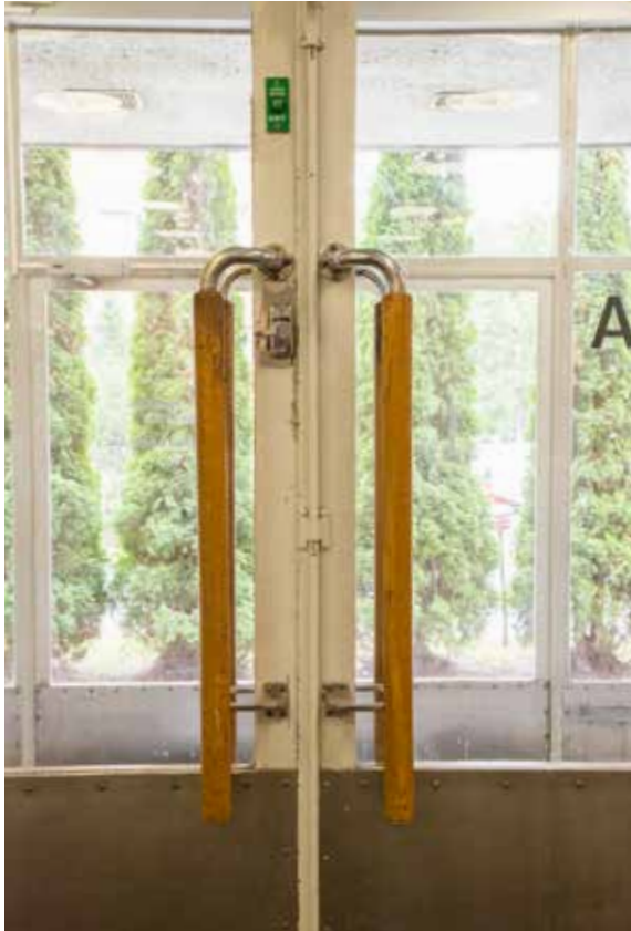
Pääsisäänkäynnin teräs-lasiovien vetimet ovat säilyneet alkuperäisinä.
