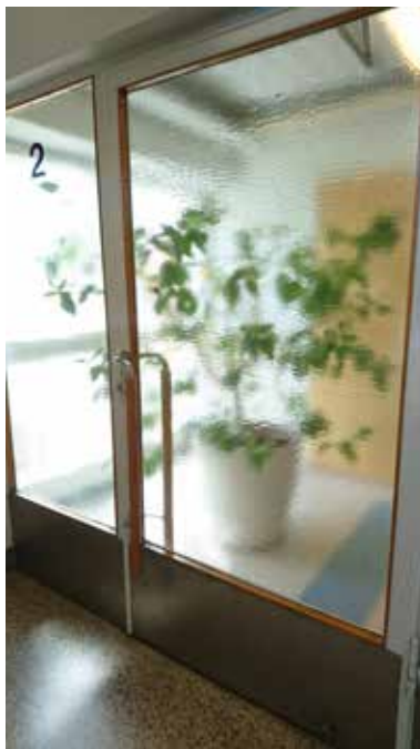
Porrashuoneen lankalasiovet ovat alkuperäiset.
