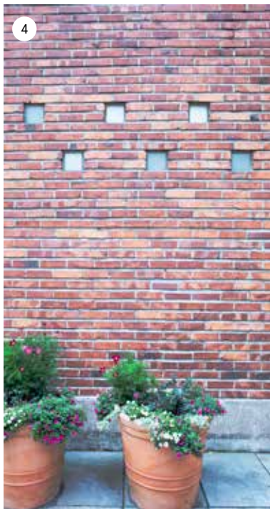
Lasitiiliyksityiskohta vanhan pääsisäänkäynnin vieressä.
