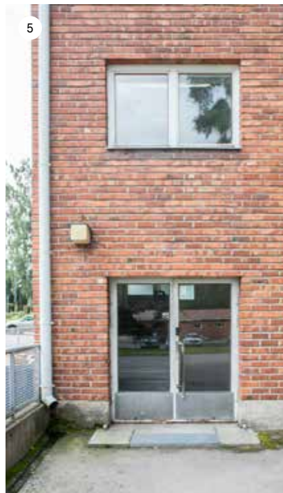
B-portaan sisäänkäynti on arkinen teräslasipariovi.
