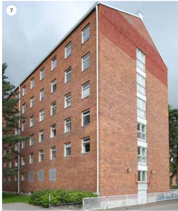
Rakennuksen eteläpääty. Arkistotilojen umpeen rakennetut ikkunat näkyvät julkisivussa alinna.
