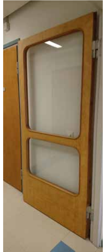
Alkuperäinen puu-lasipariovi toisen kerroksen käytävällä.
