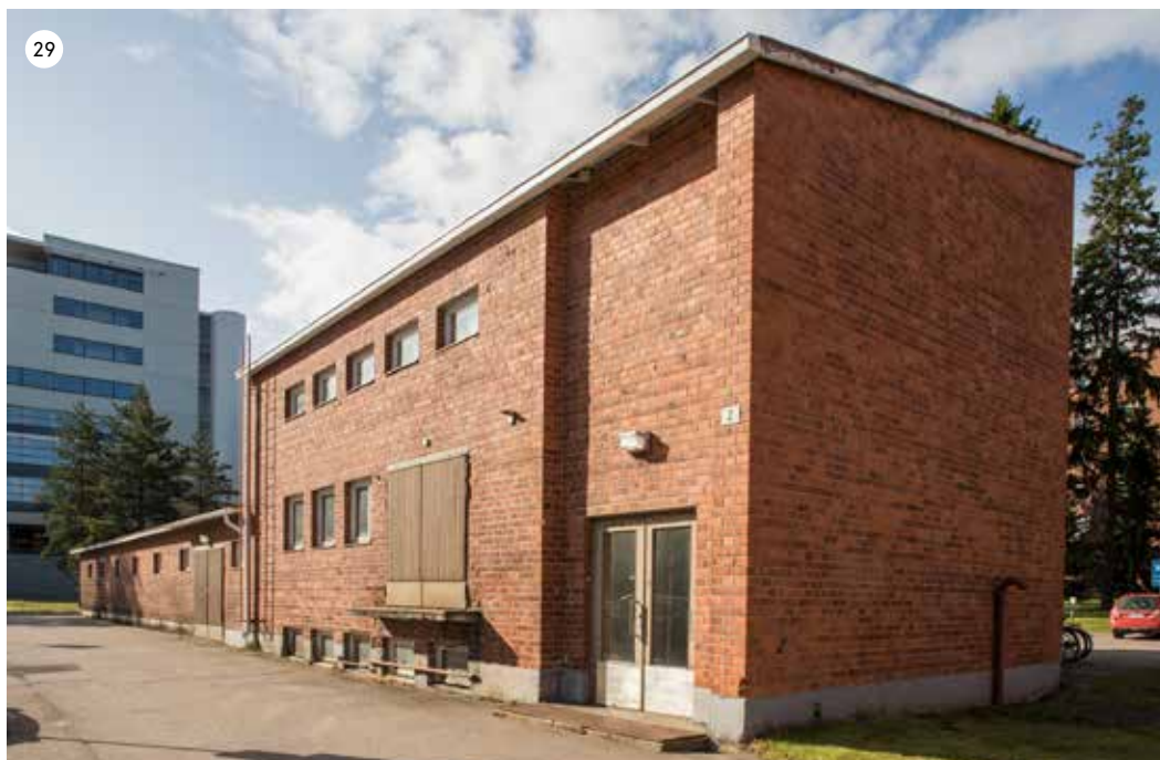
Autotallirakennuksen itäjulkisivulla on pieni lastauslaituri, josta on käynti alkuperäisiin huoltotiloihin. Kuvassa etualalla näkyy sisäänkäynti porrashuoneeseen, josta on käynti kellariin ja toisen kerroksen varasto- ja asuintiloihin. Asuintilojen nykykäytöstä ei ole tietoa, tiloihin ei ollut inventoinnin yhteydessä pääsyä.
