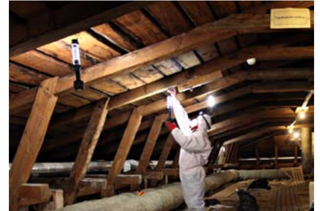
Länsisiiven pohjoispään kattorakenteita.
