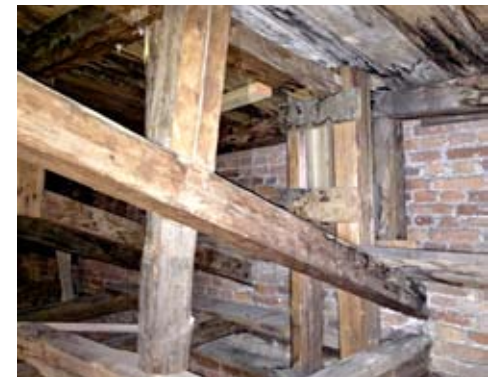
Kattorakenteen korotusta pohjoissiiven keskirisaliitin kohdalla. Rakenne lienee alkuperäinen.
