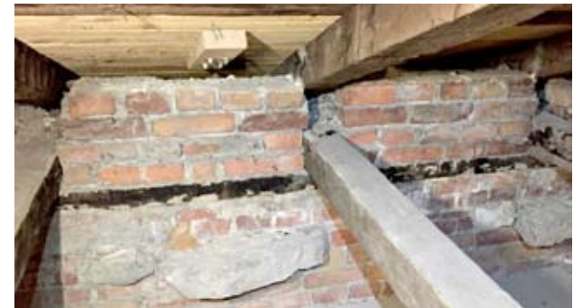
Yllä ja alla eteläisen kulmapaviljongin konttirakenteita. Ulkomuurin korotus lienee muurattu räystäään ulotuksen tasapainottamiseksi.
