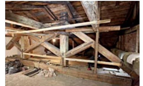
Eteläesplanadin puoleisen siiven itäpäässä yläpohjaa on korotettu 1860-luvulla. Yläpohjaa kannattelee massiivinen ansas, jonka alapäärre on vahvistettu kiilapalkkirakenteella.
