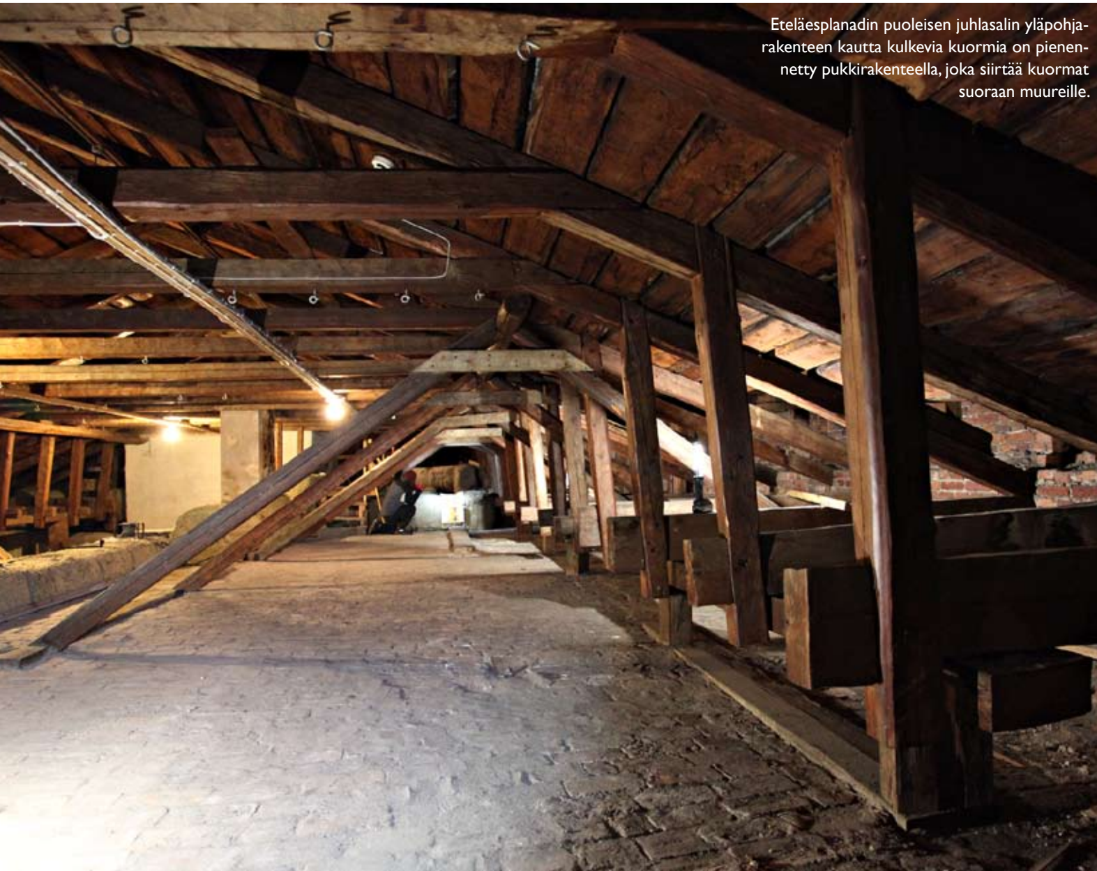
Ulkonurkan auman jiiri länsisiiven eteläpäässä. Koroke tukeutuu levikkeen kautta useampaan yläpohjapalkkiin. Seinän vieressä kulkee haltijapalkki.
