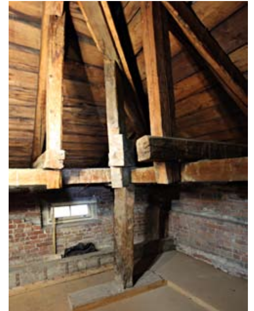
Ulkonurkan auman jiiri länsisiiven eteläpäässä. Koroke tukeutuu levikkeen kautta useampaan yläpohjapalkkiin. Seinän vieressä kulkee haltijapalkki.
