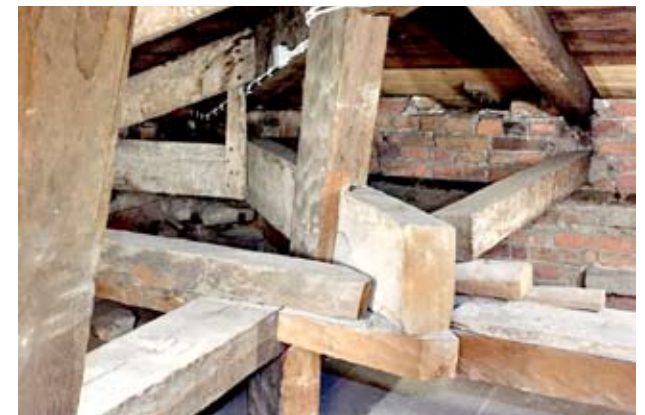
Alla: Ulkonurkan auman kattorakenteita Valtioneuvoston linnan eteläisessä kulmapaviljongissa.
