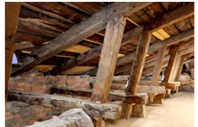
Yllä ja alla eteläisen kulmapaviljongin konttirakenteita. Ulkomuurin korotus lienee muurattu räystäään ulotuksen tasapainottamiseksi.
