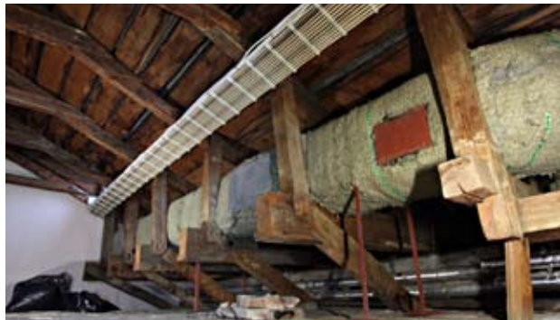
Vasemmassa (A-kirjain viereisessä kuvassa): 1860-luvulla korotetun yläpohjan kohdalla jalasparrua ei ole lainkaan ja kypälät on tuettu pönkillä muuriin. Uusien konttien osat on tehty kierrätysmateriaalista.
