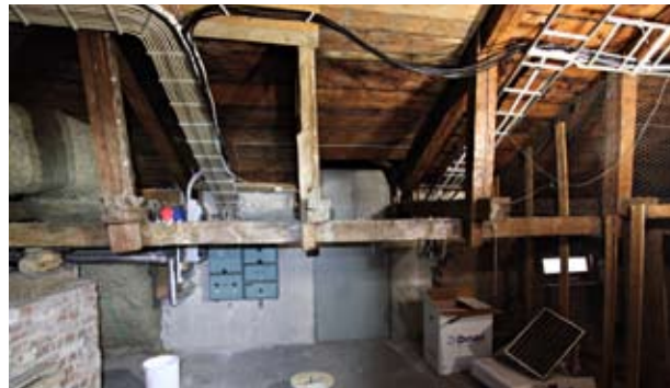
Vasemmassa (A-kirjain viereisessä kuvassa): 1860-luvulla korotetun yläpohjan kohdalla jalasparrua ei ole lainkaan ja kypälät on tuettu pönkillä muuriin. Uusien konttien osat on tehty kierrätysmateriaalista.
