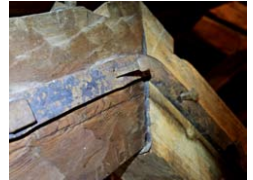
Vasemmalla olevassa valokuvassa näkyvien ansaiden yläpään liitos. Puskupinnat on vahvistettu teräspellillä.
