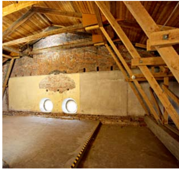
Läntisen upseerikasarmen vesikattorakenteita joulukuussa 2016.
