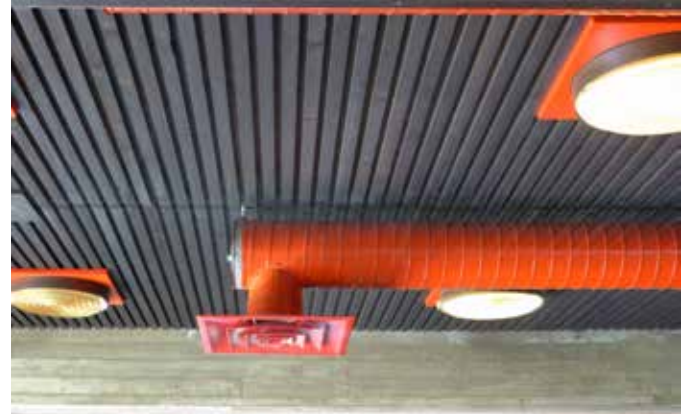
Oik. Miehistösalin eteläosan ja kabinetin IV-asennuksia. Pekka Lehtinen / MV
