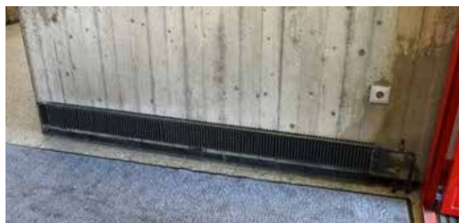
Mustaksi maalattu lämpöpatteri 1. kerroksen porrasaulassa.
