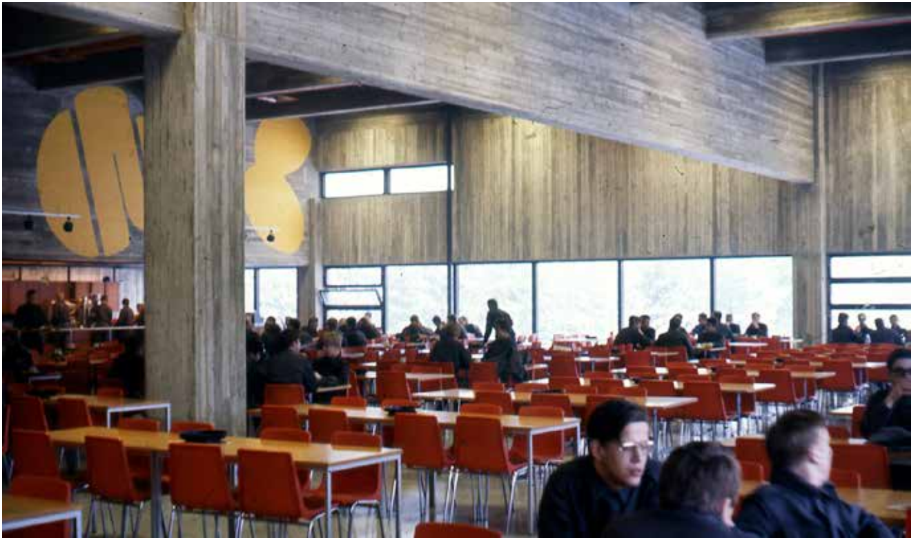
Miehistösali rakennuksen valmistuttua 1970-luvulla. Ilmanvaihtokonehuoneen betoniseinässä on taiteilija Howard Smithin seinämaalaukset "Keltainen paraati". Osmo Lappo / SK
