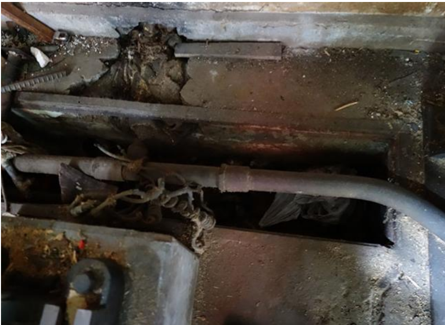
Rak5, pumppuhuonetilan lattiasta tulevia putkia.
