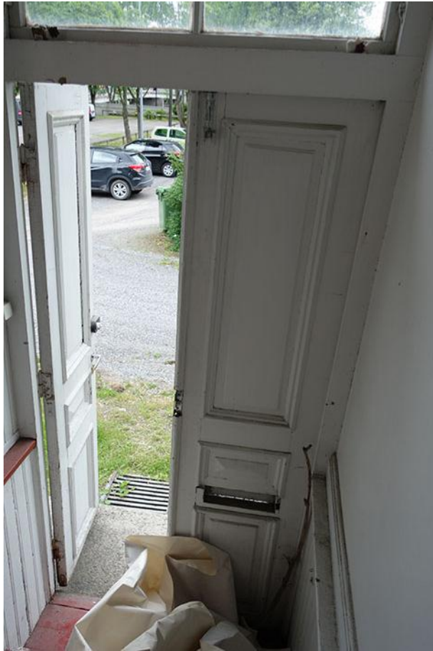
Rak3, kuva eteisestä H108 tuulikaappiin
