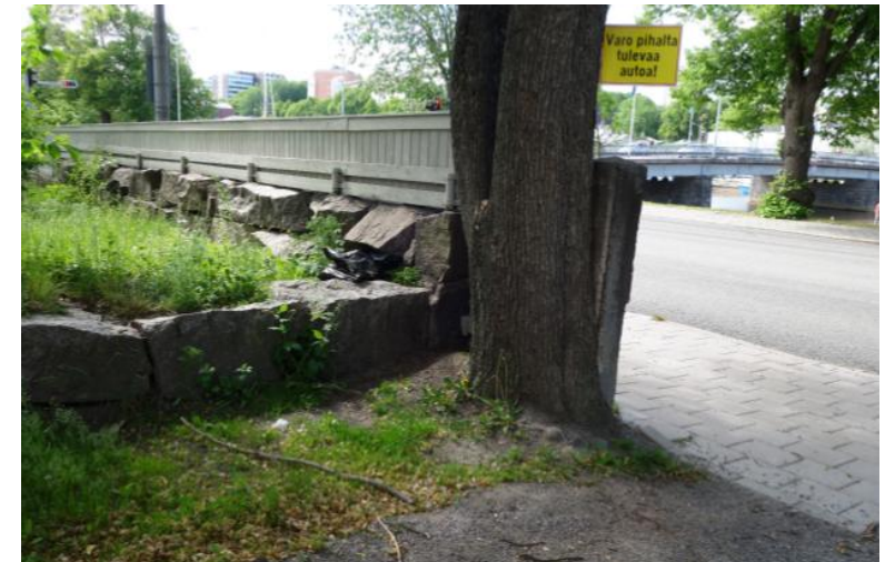
Lauta-aita, joka on tehty vanhojen perustuskivien päälle.
