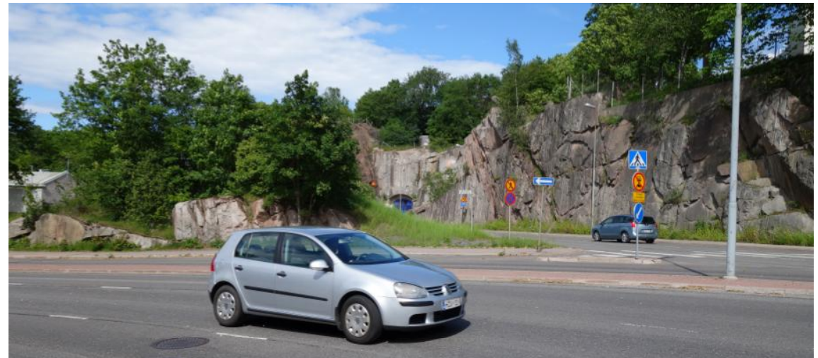
Martinkatu ja Myllytunneli.
