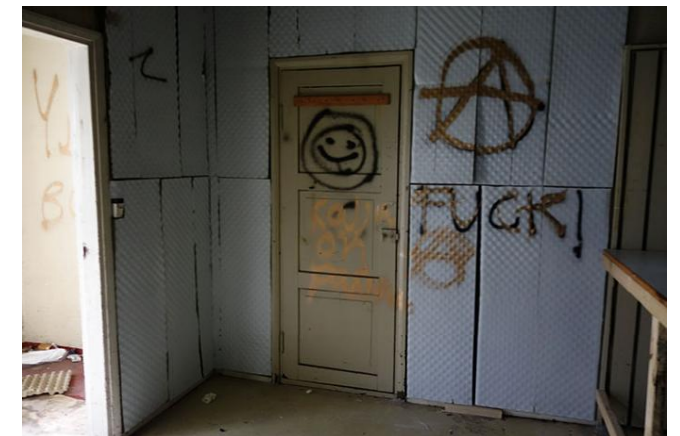
Rak4, huonetila eteläpää
