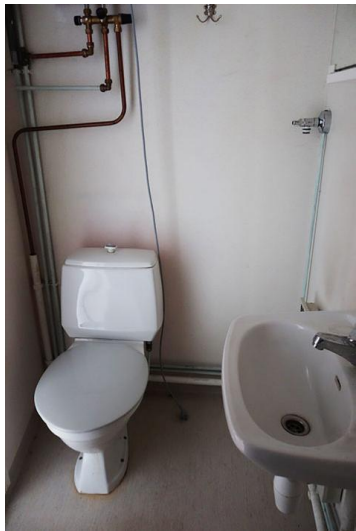
Rak3, WC Etuhuoneesta H110
