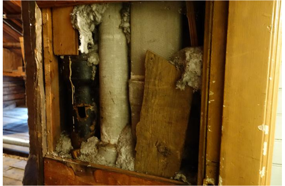
Rak1, ullakolla tehty rakenneavaus
