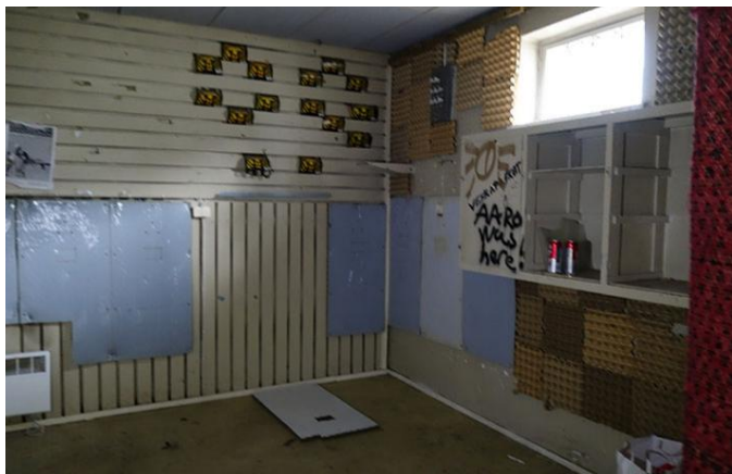
Rak4, huonetila eteläpää
