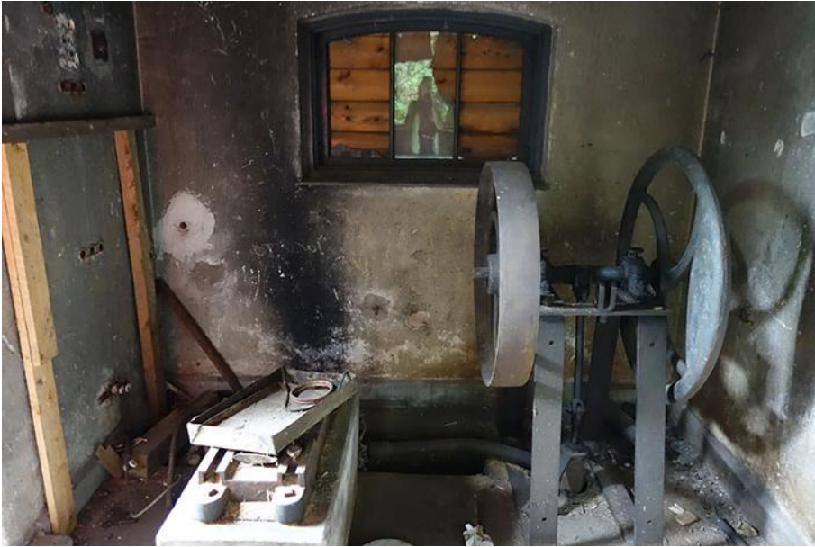
Rak5, pumppuhuonetilassa on jäljellä alkuperäisiä (höyryvoima?)koneen osia.
