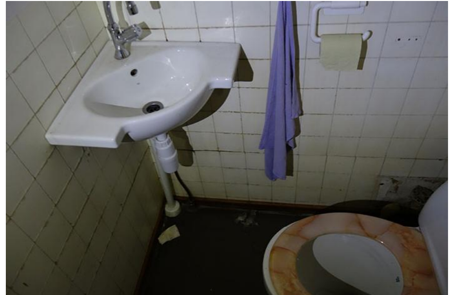
Rak1, WC H7 eteisestä, sijainti portaan alapuolella
