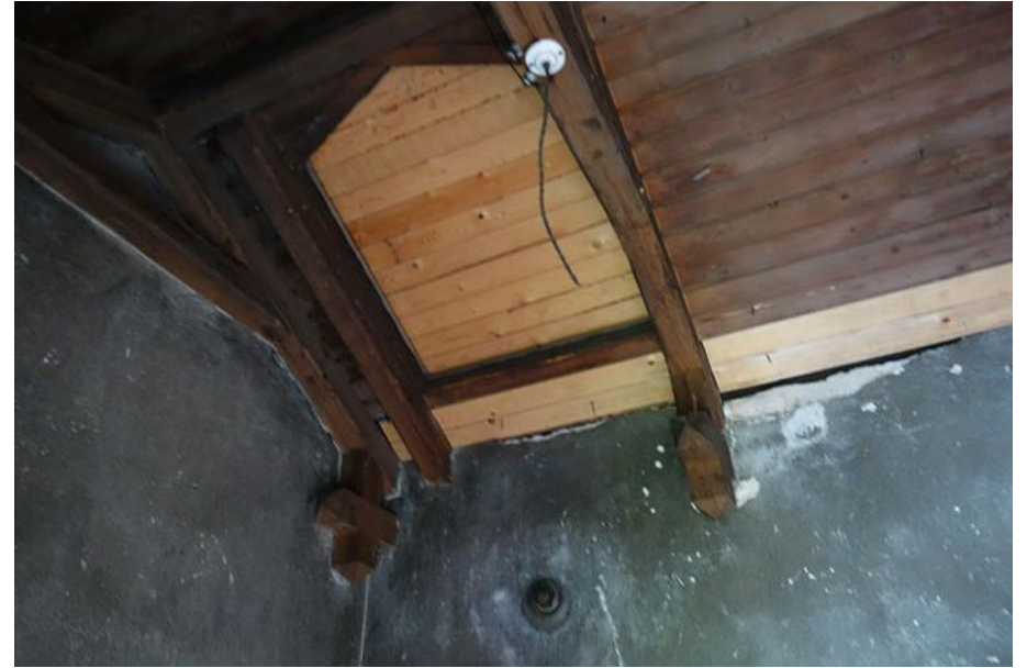
Rak5, pumppuhuonetilan kattoon on tehty korjaus.
