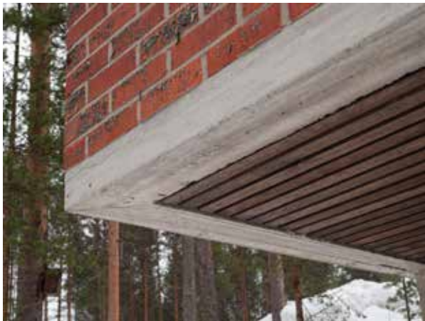
Julkisivujen tiilimuurausta kannattavat betonisokkeliin tehdyt ulokkeet. Pohjakerroksen sisäänvetojen kohdalla tiiliverhouksia kannattavat runkorakenteeseen liittyvät leukapalkit.
