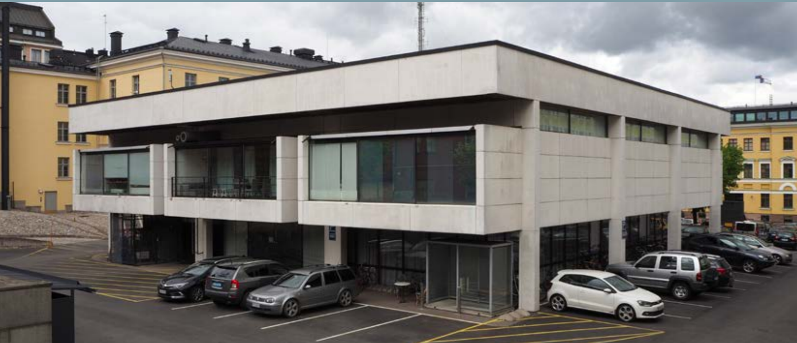
↑ Rakenteet ovat ilmaisuvoimainen osa paviljongin ulkoarkkitehtuuria. amoy 2017
