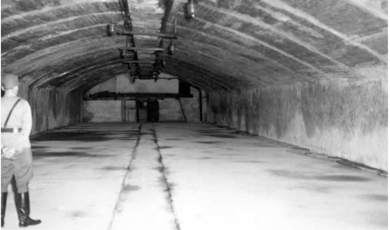
Kalliorakentamista Obbnäsin alueella vuonna 1956: yllä sotasataman laidalla oleva varastotunneli ja alla koneista riisuttu varavoima-asematunneli. SA-kuva
