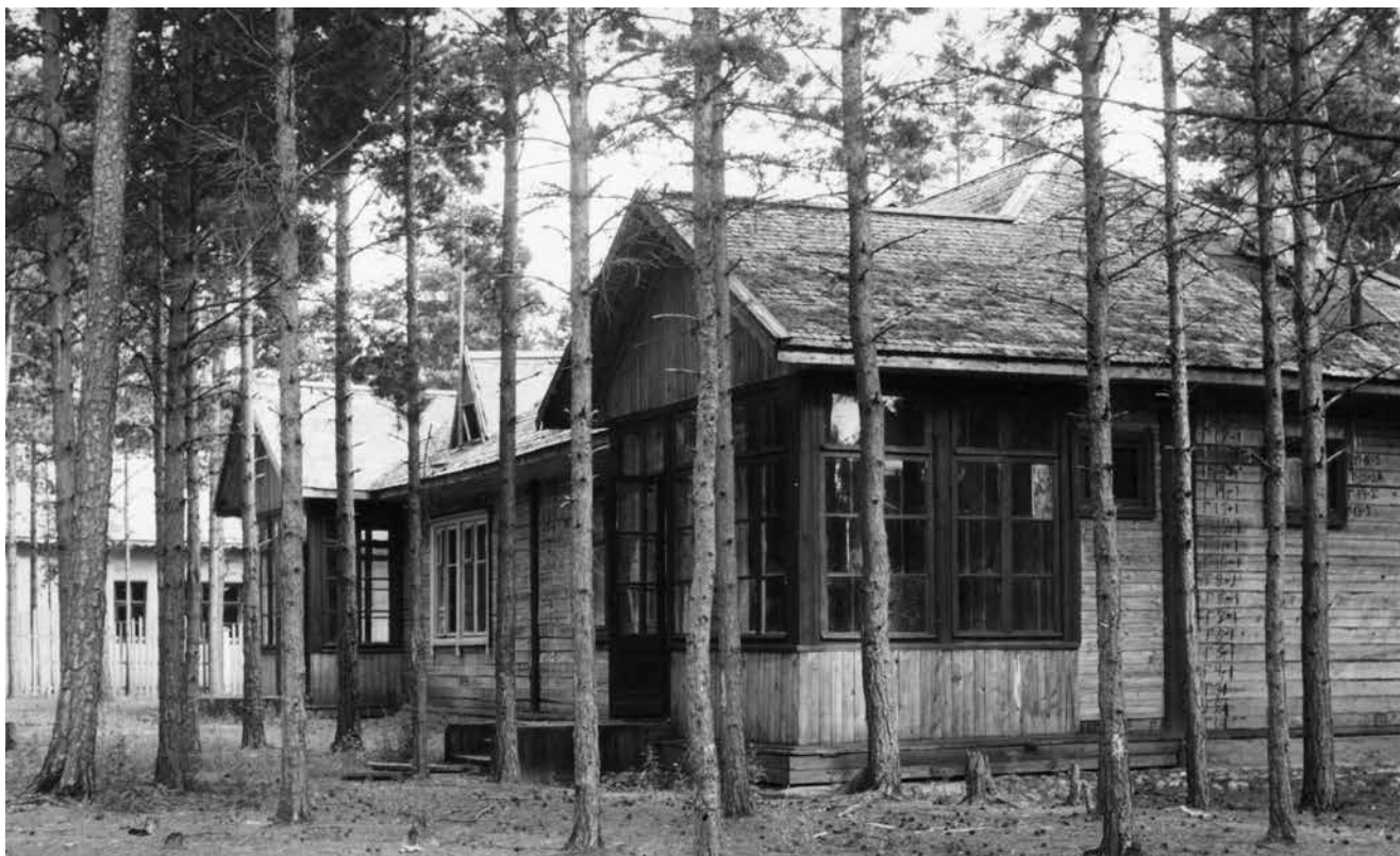
Yllä vas. ja yllä: Rapattu lastentarha, eli nykyinen sosiaalikeskus, ja hirsinen henkilökunnanrakennus sen länsipuolella kesällä 1956. Molemmissa rakennuksissa oli pohjoisen puolella lasiverannat. SA-kuva
