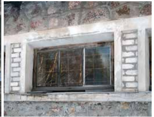
Rakennus on säilyttänyt julkisivuissaan monia alkuperäispiirteitään, mm. koristeelliset räystäskonsolit.
