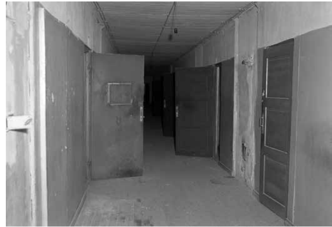
Alla: Ulko- ja sisäkuva suuresta esikuntaparakista, joka oli rakennettu Obbnäsin päärakennuksen länsipuolel-le tien varteen. SA-kuva
