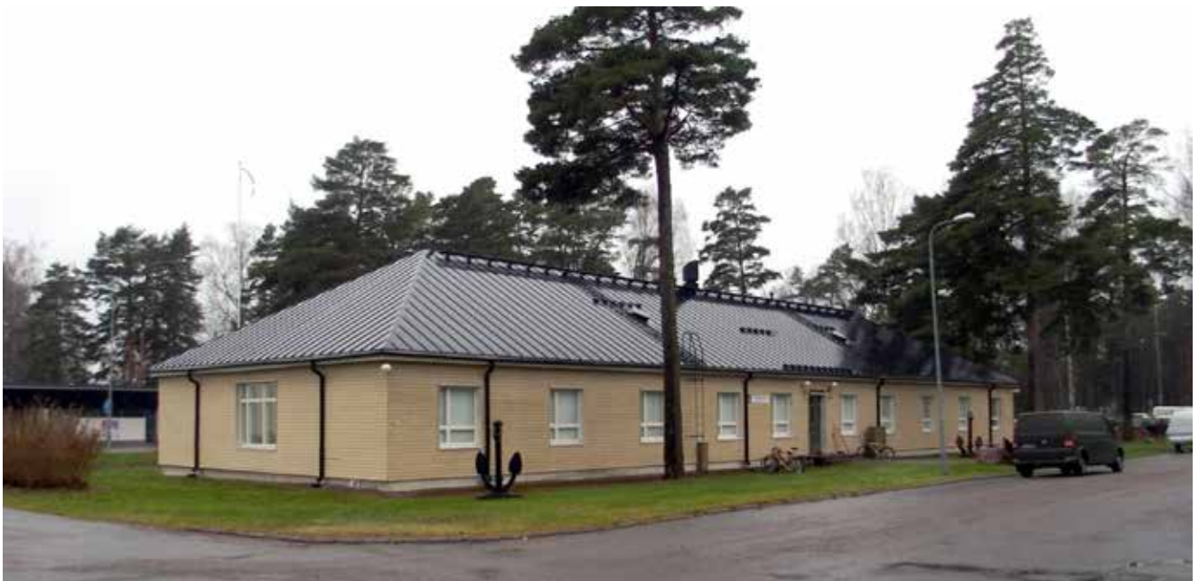
Kasarmi 2009 nykyään. 1950-luvun lopun muutostöissä rakennus sai huomattavasti alkuperäistä modernimman ilmeen mm. ulkoverhoilun, kattomuodon muutoksen ja ikkunoiden uusimisen ansiosta.
