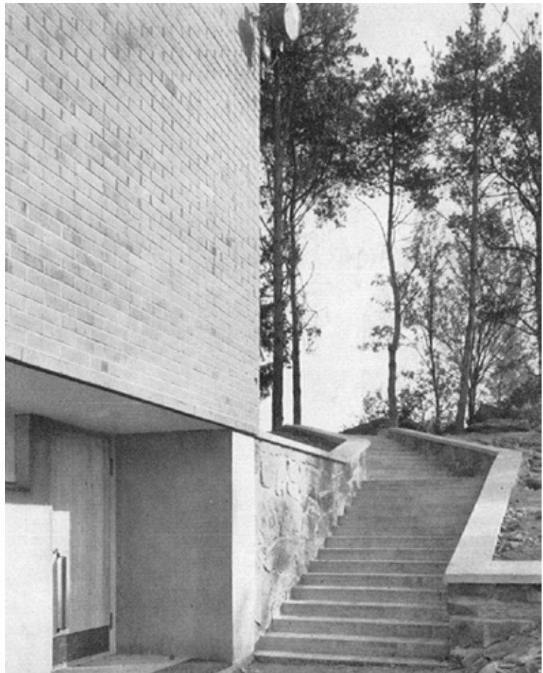
Närpiön koulukeskuksen kokonaisuuteen kuului myös pihapiirin portaita ja muurirakenteita. Arkkittehti 12/1958, 193.
