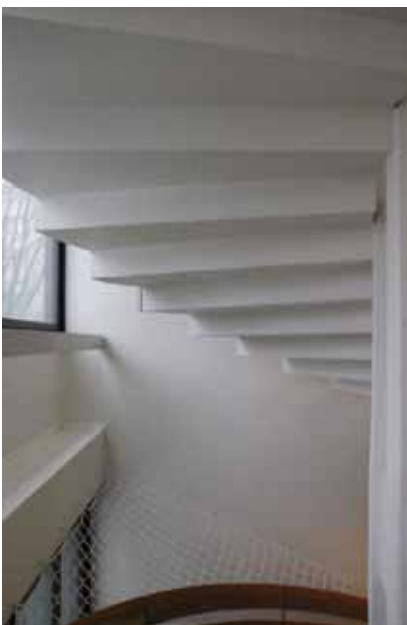
Pääportaikon porrasaskelmien tukirakenne on viuhkamainen ja portaalla onsiro betonirakenne.
