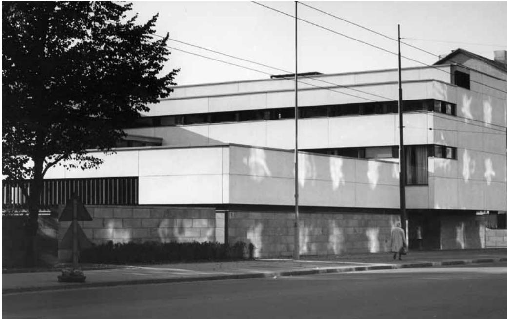
Rakennuksen umpinainen koillisfasadi ja kaakkoisfasadin ikkunavyöhykkeet. Valokuvaaja: Eero Aarnio, 1960-luku. MFA.
