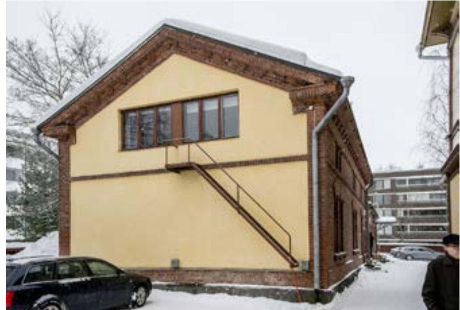
Pääty länteen Rakennus 5A.
