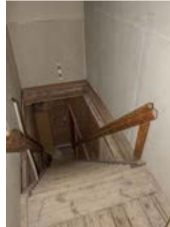
Porras Alkuperäinen porras. Palo-osastonin takia portaalle on ullakko-tilaan tehty levyllä verhottu tila ja palo-ovi ullakkoa vastaan.
