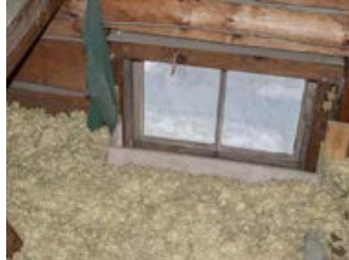
300 b Ullakon ikkunat ovat alkuperäiset.
