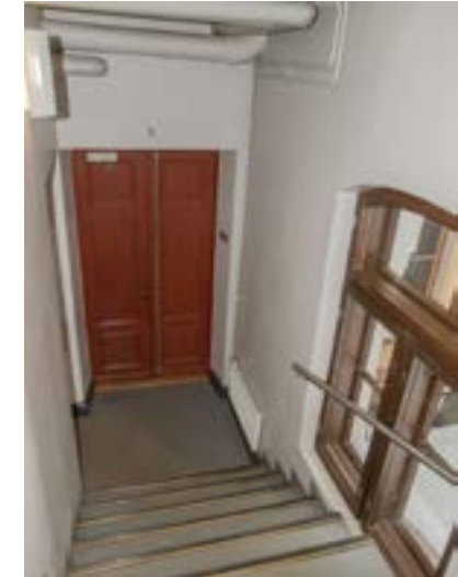
Portaaseen tultiin alunperin rakennuksen keskellä olevasta käytävästä kuvassa näkyvän oven kautta. Nykyisin käytävän paikalla on ruokailutila 108.
