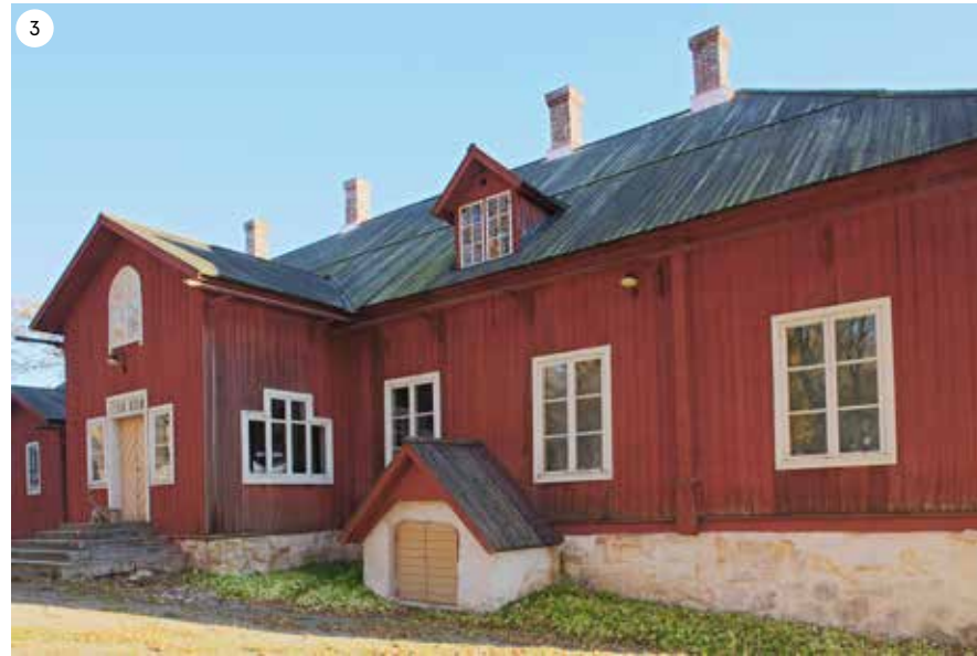
Pääkuisti ja kellarin eteiskäytävä 2016.
