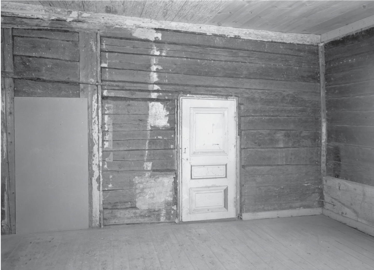
Seinä länteen, garderobin suljettu oviaukko on peitetty levyllä ja paljastunut puolipaneli oikealla 1988. Kuvaaja P. O. Welin MVRHO.
