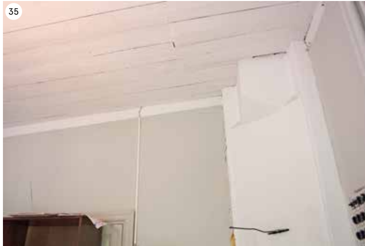
Puretusta tiilitakasta on jäljellä hormit. ark-byroo, AV.
