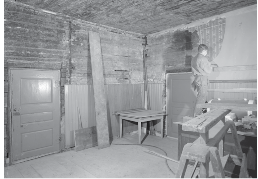
Keittiön levytykset ja pinkopahvit on purettu 1988. Kuvaaja P. O. Welin MVRHO.
