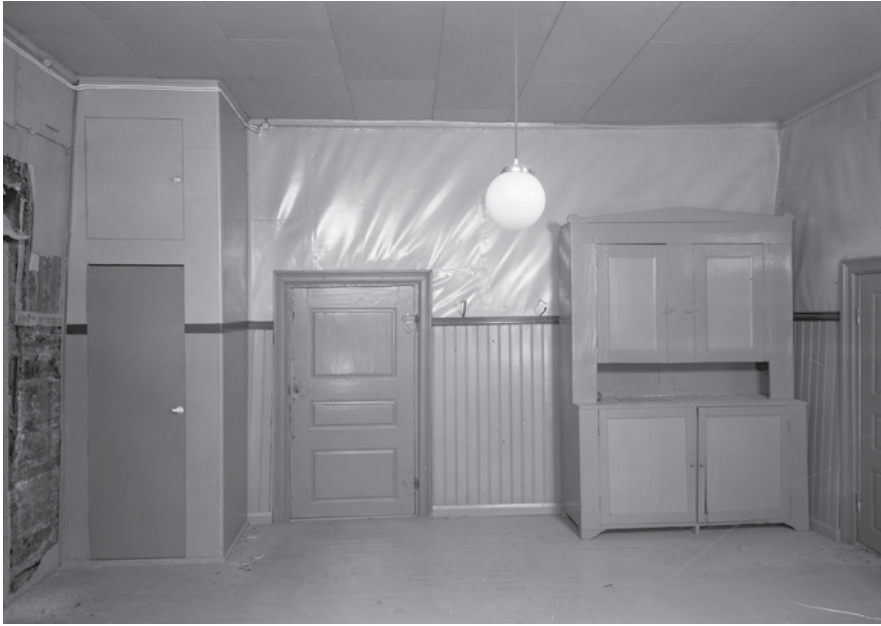
Keittiö ennen pintojen avaamista ja komeroiden purkua 1978. Kuvaaja P. O. Welin MVHK.
