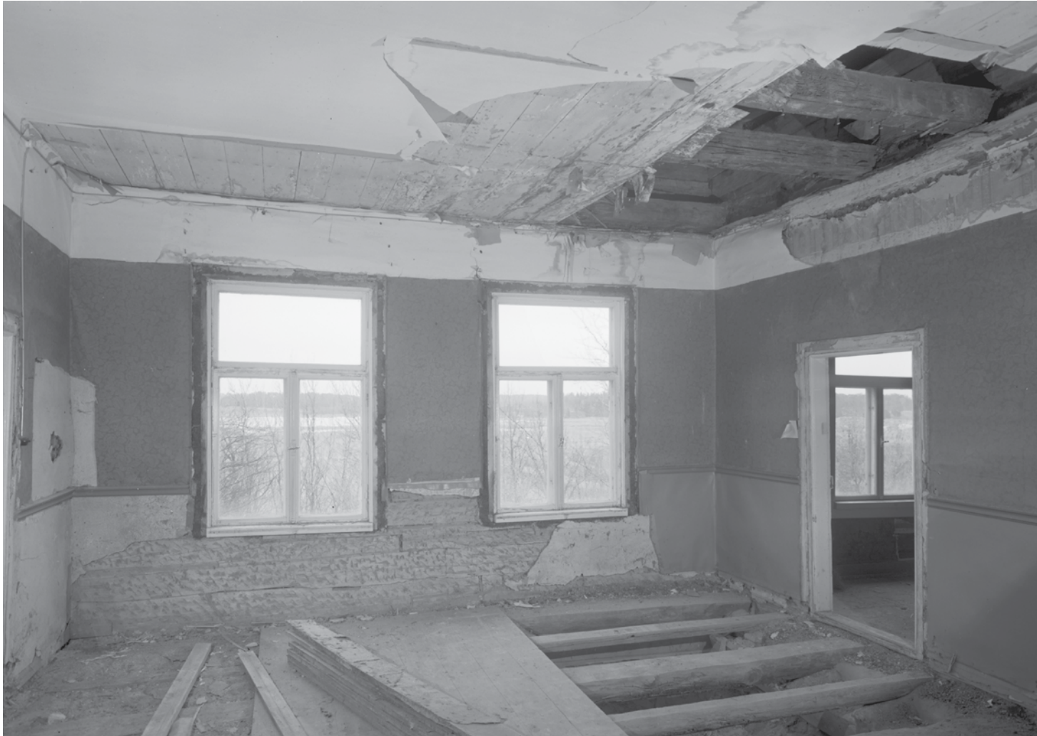
Ruokasalin katto ja lattia on avattu. Ulkoseinällä on näkyvissä vanhat rappauskyntteet 1978. Kuvaaja P. O. Welin MVHK.
