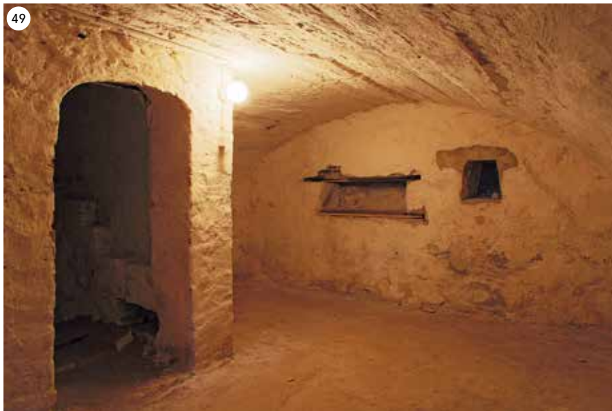
Kellariin johti aluksi kulku sisätiloista. Perällä hylly. Pienempi aukko on vino tuuletushormi suoraan ulkotilaan. Kellari vaikuttaa pakopaikalta.
