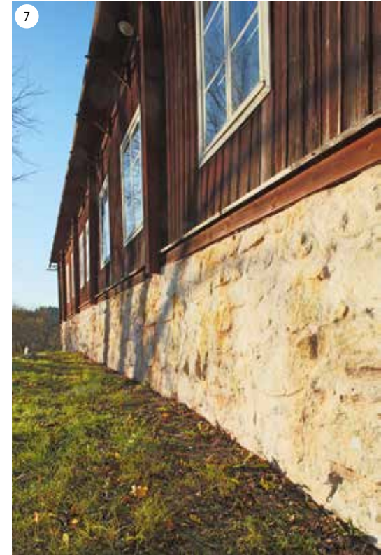
Kaakkoissivun sokkeli on korjattu 2016.
