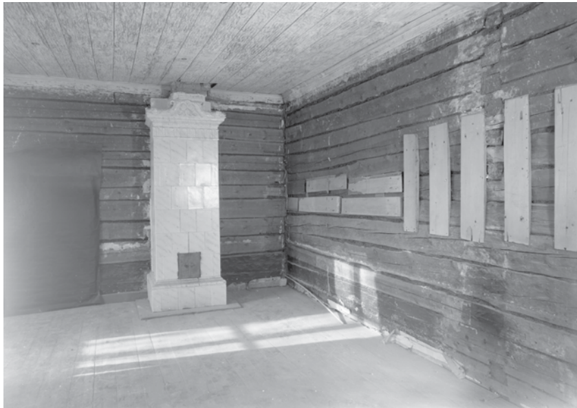
Pohjois- ja länsiseinä, lisätty oikaisupalat 1988. Kuvaaja P. O. Welin MVRHO.
