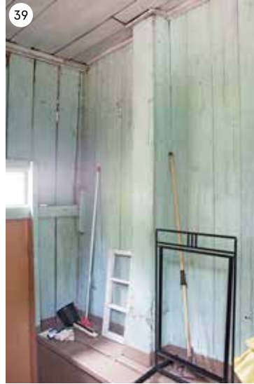
Entinen ulkoseinä 2016. ark-byroo, AV.
