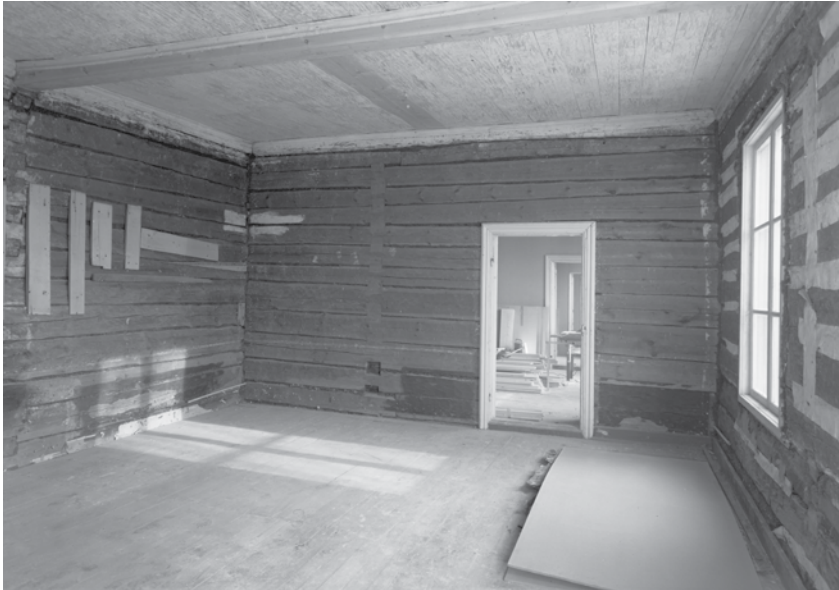
Näkymä kohti huonetta 8 ennen levytystä; oikaisut ja maalaamattomat vanhat pinnat ovat näkyvissä. 1988. Kuvaaja P. O. Welin MVRHO.
