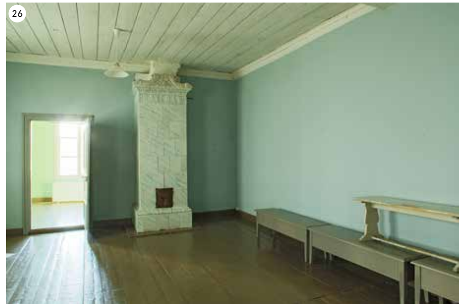
Pohjois- ja länsiseinä, tilanne 2016.
