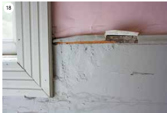
Alkuperäinen puolipaneli ja uusi maalipinta 2016. ark-byroo, AV.
