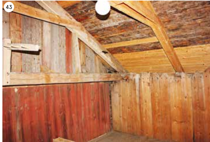
Vanha ulkoseinä ja korjatut kattorakenteet 2016. ark-byroo, AV.
