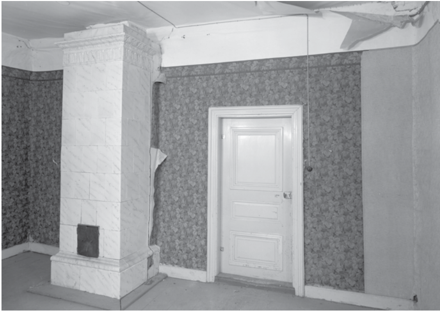
Huone ennen paperointien poistoa 1978. Kuvaaja P. O. Welin MVHK.
