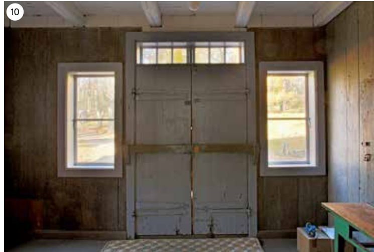
Pääovi, o1, ikkunoineen sisältä 2016.
