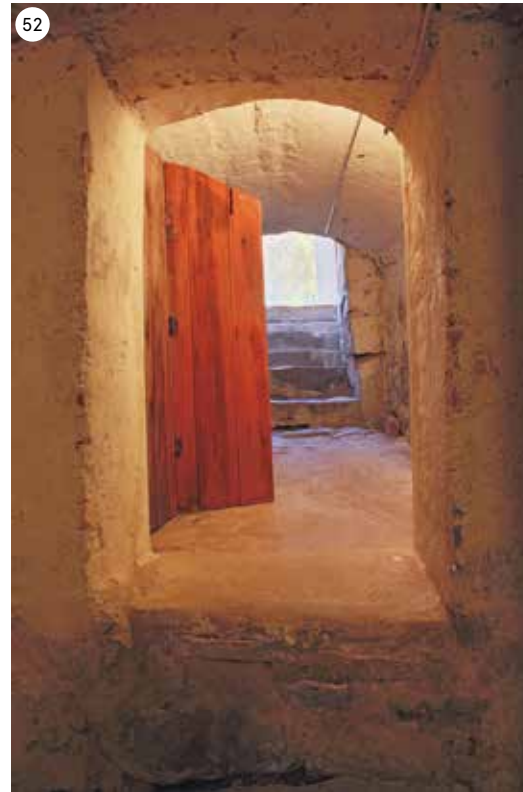
Näkymä kellarihuoneesta eteiskäytävän lävitse kohti ulkoporrasta. Kellarin väliovi taittuu keskeltä.
