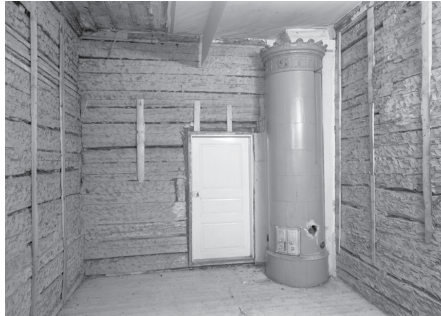
Huone 10 pintapurkujen jälkeen: tila on ollut rapattu. Uunin pinnan kiiltoaste ja osien värityserot näkyvät selvästi 1978. Kuvaaja P. O. Welin MVHK.
