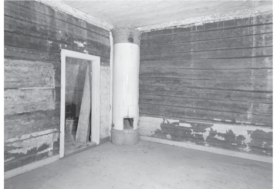
Pintoja on avattu ja vanhoja kerrostumia avattu 1988. Kuvaaja P. O. Welin MVRHO.
