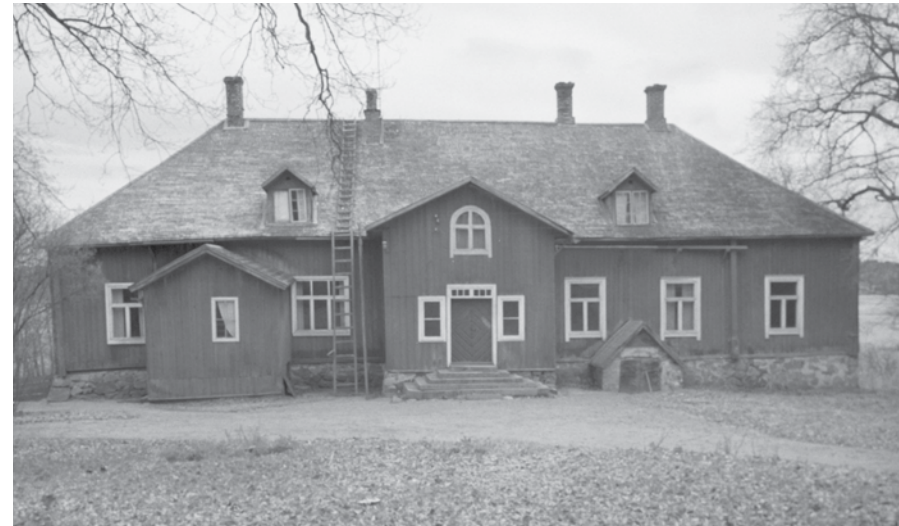
Pääjulkisivu, vuosi 1974. L. Laaksonen MVRHO.
