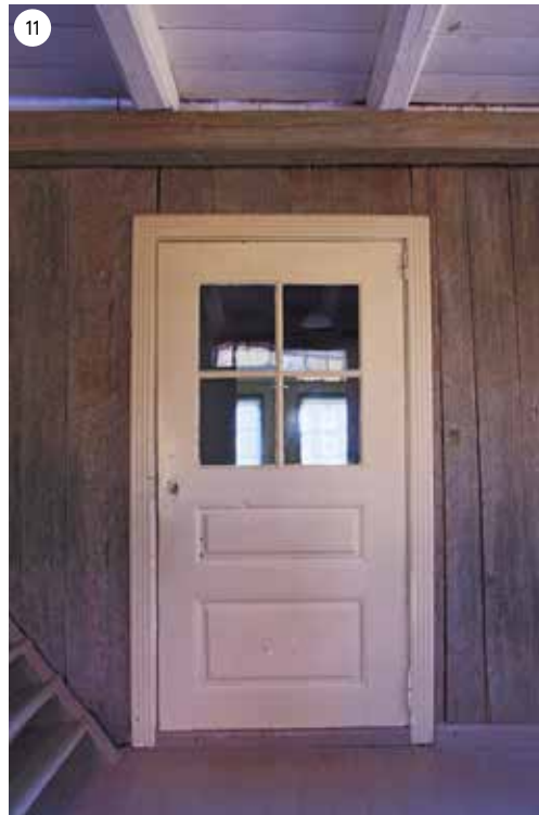
Huonetila on säilynyt 1980-luvun konservoidussa asussa. Sisäovi o2 ja konservoitu roiskemaalaus, vasemmassa reunassa portaat ullakolle.
