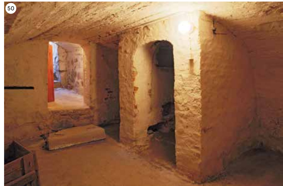
Tynnyriholvattu kellarihuone. Vasemmalla uusi sisäänkäynti suoraan ulos. Oikealla alkuperäinen sisäänkäynti, minkä portaat olivat lankkua.
