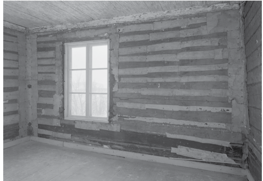
Seinä lähteen, uusi ikkuna asennettu 1988. Kuvaaja P. O. Welin MVRHO.
