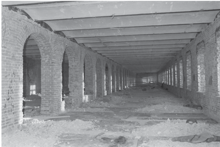
Teräspalkkien välissä kulki valetut holvirakenteet, jotka uusittiin elementtirakenteina. Myös keskimuurin alkuperäinen kaarisarja palautettiin alkuperäiseen asuunsa. Kuvattu vuonna 1987. Veijo Laine, MV.
