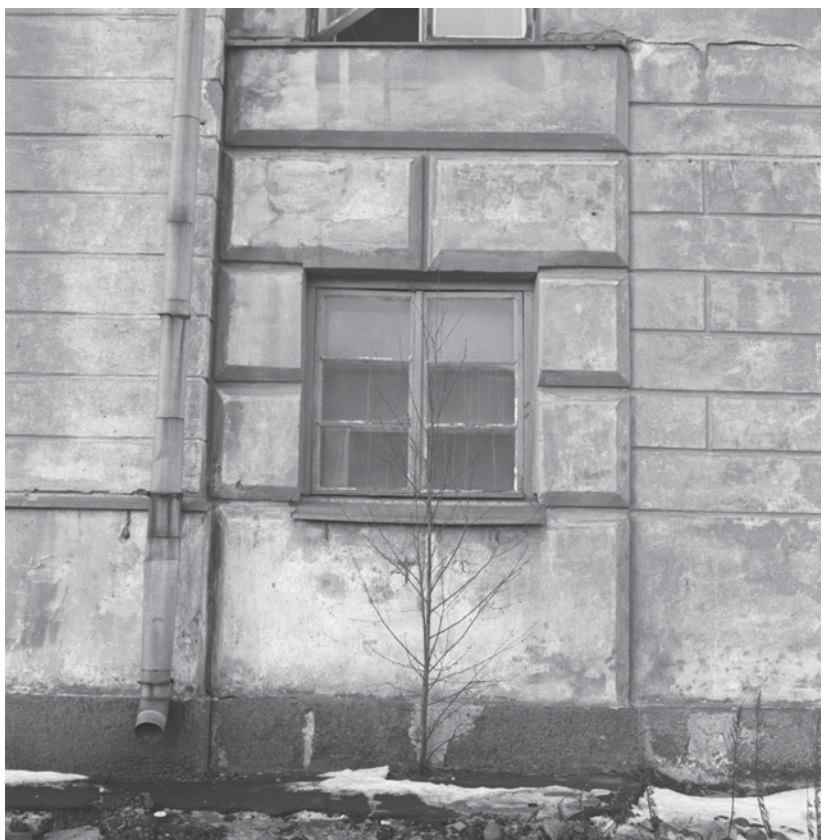
Matruusirakennuksen ja sen itäisen keittiösiiven rajaa korostavaan vertikaaliseen harkkoimitaatiopintaan oli myöhemmin puhkaistu ikkuna keittiösiiven muutostöiden yhteydessä. Kuvattu 1973. Veijo Laine, MV.
