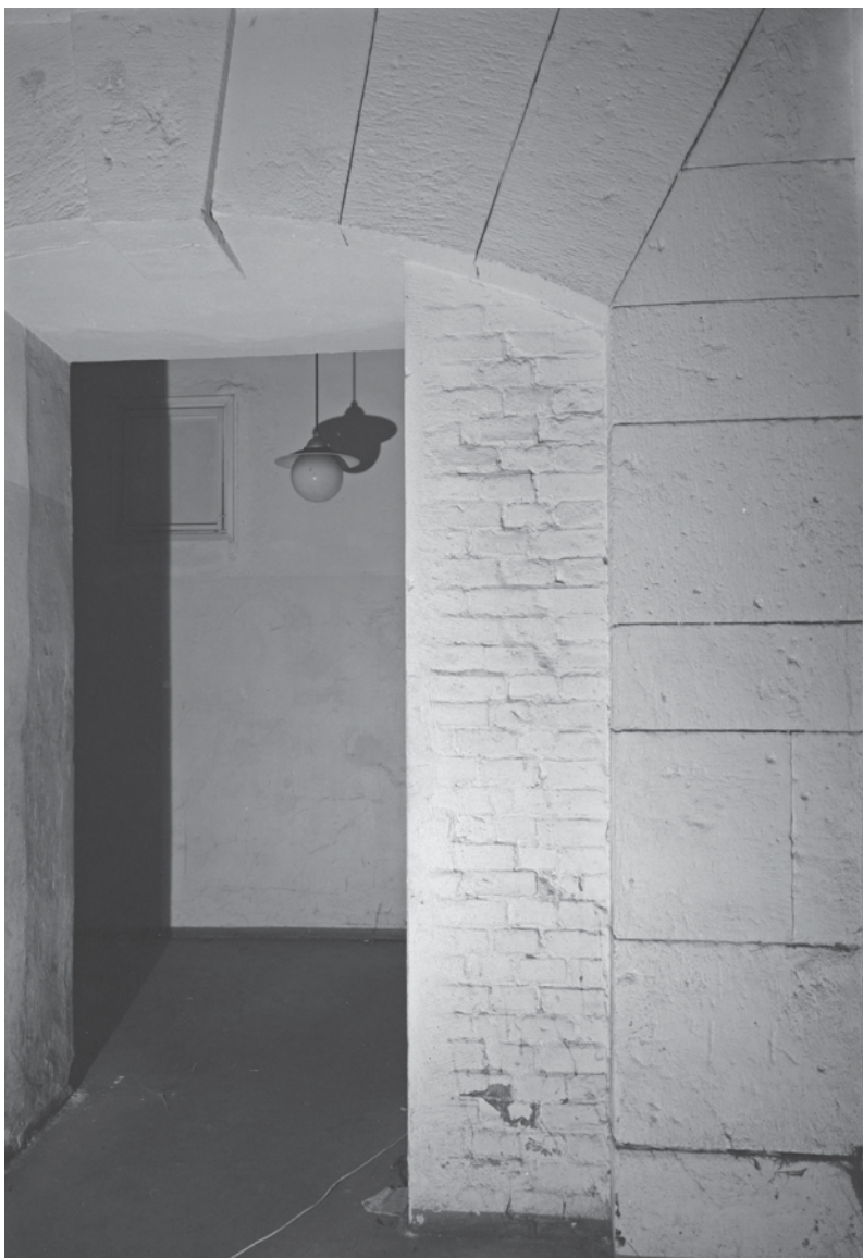
Läntisen makasiinirakennuksen 1700-luvulta peräisin oleva portti oli säilynyt osana myöhemmän rakennuksen keskimuuria kavennetussa muodossa. Kuvattu vuonna 1977. Veijo Laine, MV.
