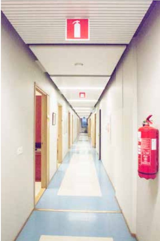
Rakennuksissa B, C, G ja H käytävien alaslasketut osat ovat leijuvia rakenteita, joiden yläpuolinen seinäpinta on maalattu mustaksi. Lattia on rakennuksissa B, C, D ja G vinyylilievartsilaattaa, rakennuksessa F se on sittemmin vaihdettu. Kuvassa rakennuksen G ensimmäisen kerroksen käytävä
