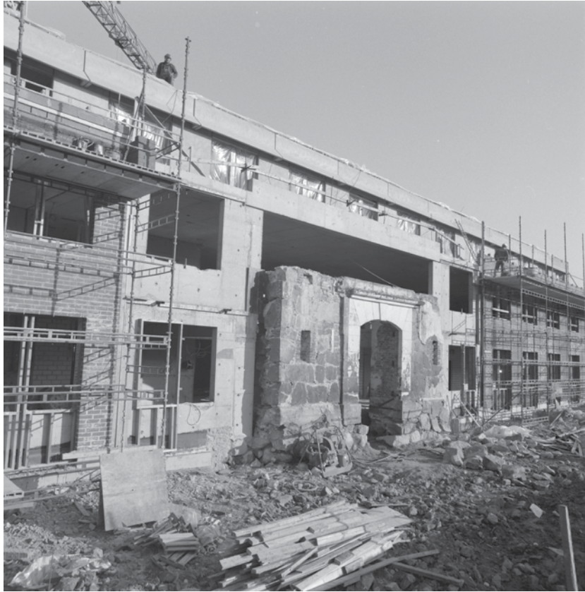
Muuri ja ympäröivä harmaakiviseinä sijoitettiin betonielementti- ja tiilimuurattuun ulko-kuoreen. Kuvattu vuonna 1985. Veijo Laine, MV.
