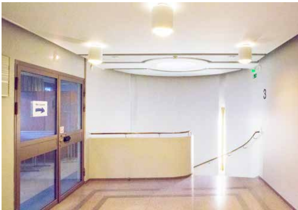
Rakennuksissa B, C ja G käytetty porrashuoneiden valaisinmalli.
