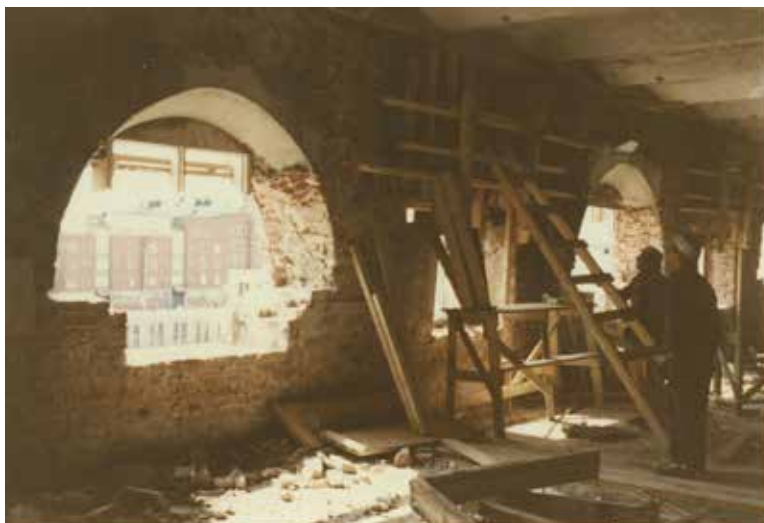
Tilannekuva sisältä purkutyön aikana. Kråkströmin aineisto, UM.
