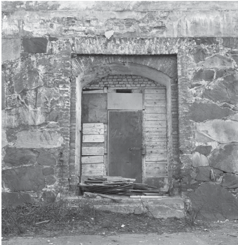
Rakennuksen A pohjoisjulkisivun sokkelin alkuperäisiin tiilikehyksiin aukkoihin oli sijoitettu sekundäärisiä ovia. Kuva vuodelta 1977. Erkki Härö, MV.
