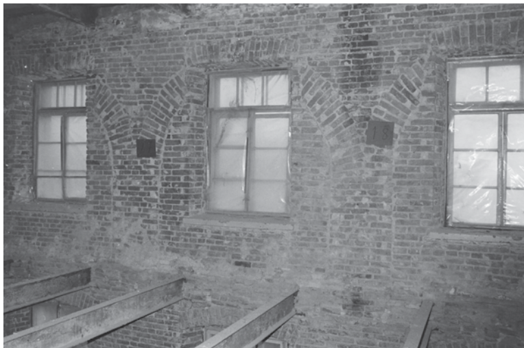
Kolmannen kerroksen ikkunamuoto palautettiin suorakulmaisesta kaarevaan. Kuva purkutyön alusta vuodelta 1987. Veijo Laine, MV.
