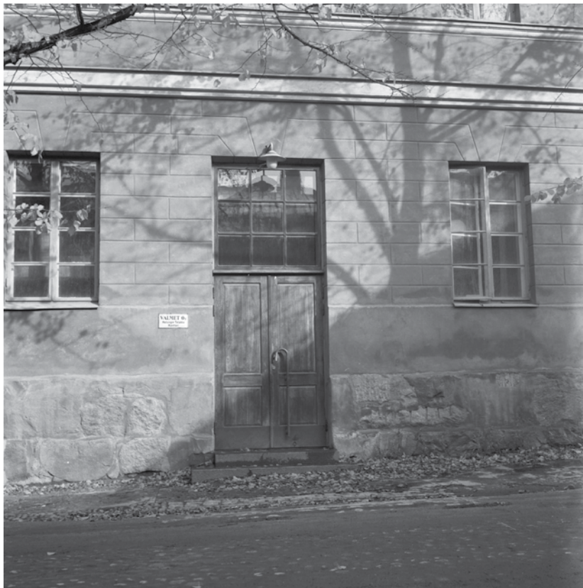
Rakennuksen H länsijulkisivuun oli puhkaistu oviaukko. Kuvattu vuonna 1973. Jarkko Sinisalo, MV.
