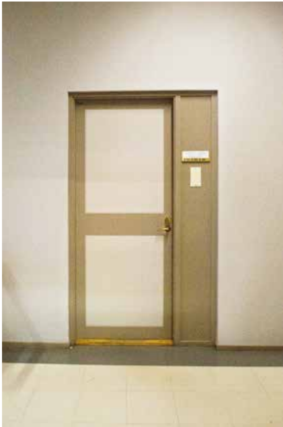
Toimistohuoneen ovi rakennuksessa B. Ovet ovat kaikki uusia.
