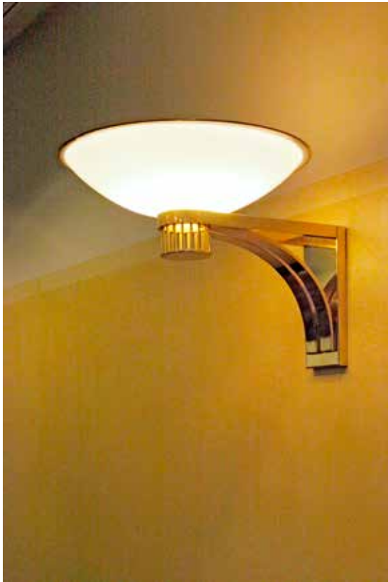
Rakennuksissa A ja H käytetty käytävävalaisinmalli. Valaisimen runko on messinkiä rakennuksen A ensimmäisen kerroksen käytävillä.
