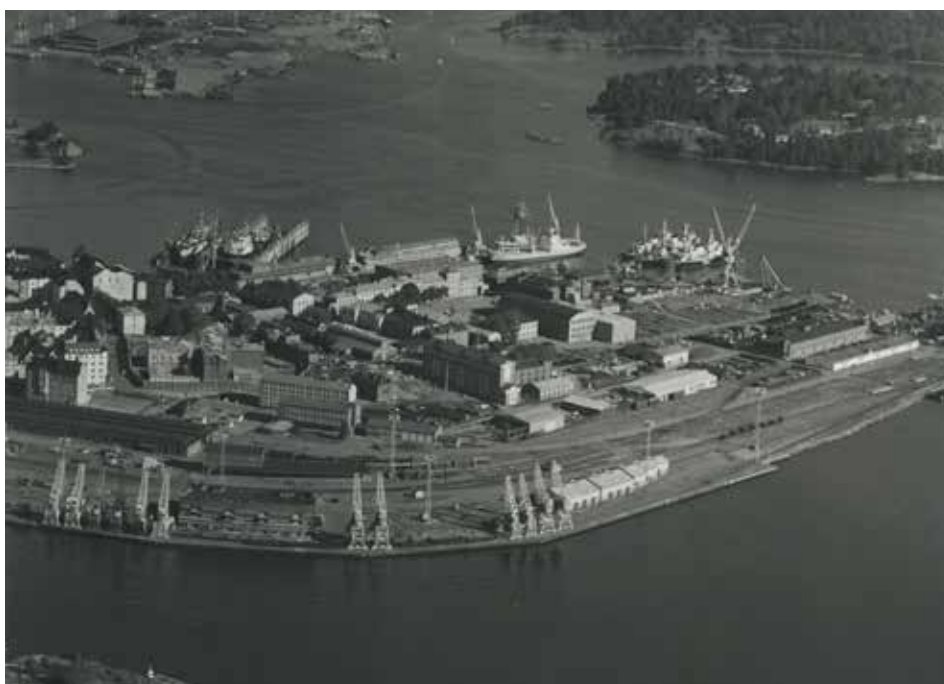
Merikarmin oli osa merkittävää, koko Katajanokan itäosan kattavaa telakka-aluetta aina 1970-luvun puoliväliin. Kuva vuodelta 1974. Simo Rista, UM.
