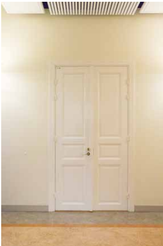
Toimistohuoneen ovi rakennuksessa H. Osa ovista on vanhoja, osa uusia.
