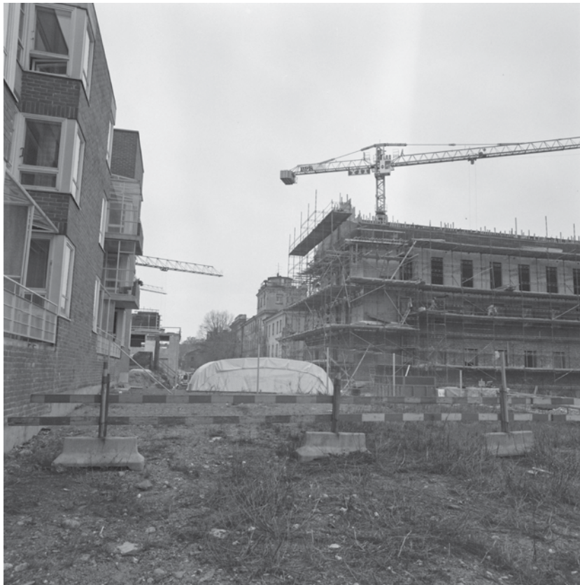
Kuvassa oikealla oleva uudisrakennus B rakennettiin tiilistä muuraamalla ja pitkälti käsityönä aikana, jolloin elementtirakentaminen oli ollut vallitseva tapa jo useamman vuosikymmenen ajan. Kuvattu vuonna 1985. Veijo Laine, MV.
