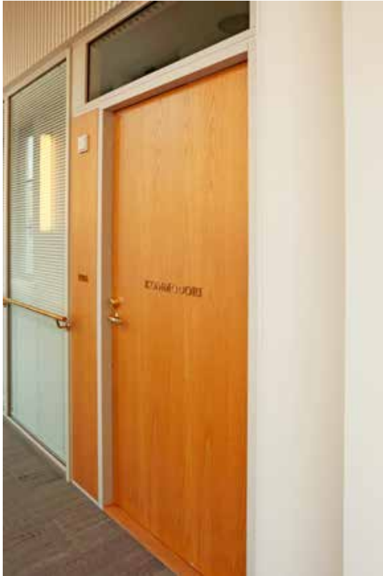
Neuvotteluhuoneen ovi rakennuksessa F. Ovet on uusittu vuonna 2010.
