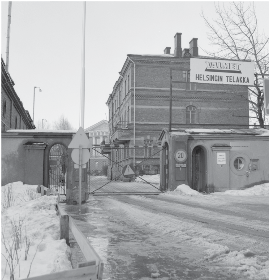
Valmetin telakan portti vuonna 1973 Merikasarmin alueen luoteiskulmalla. Portti rakennettiin alun perin venäläisen sotasataman portiksi 1800–1900-luvun vaihteessa. Taustalla häämöttävä läntinen upseerirakennus (H) oli telakan konttorina. Veijo Laine, MV.
