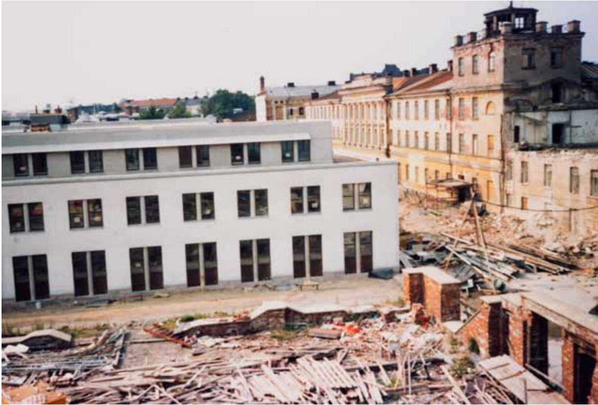
Uudisrakennukset valmistuivat ennen kuin hyvin huoonon kuntoon päässeeseen matruusikasarmin A korjaus- ja muutostyöt alkoivat. Etualla ulko-osiltaan valmis rakennus C, oikealla rakennus A, jonka itäisen keittiösiiven ylempien osien purkutyöt ovat käynnissä, mutta lennätintorni on vielä purkamatta. Kuva on vuodelta 1986. Aino Grundström, MV.
