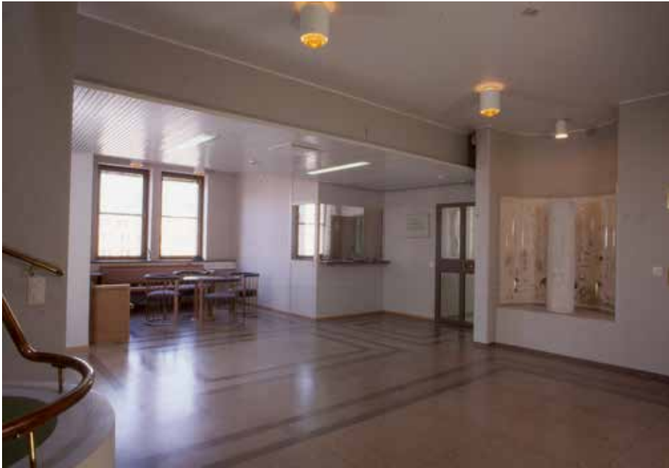
Rakennusten B, C, G ja H aula- ja porrashuonetiloissa on mosaikkibetonilattia, johon on upotettu kalkkikivikaistaleita muodostamaan erilaisia kenttiä. Kuvan aulatilassa rakennuksen C toisen kerroksen syvennyksessä on oikealla Outi Heiskasen sekatekniikkatyö. UM.
