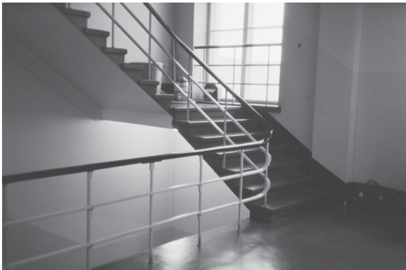
Rakennuksen E portaikko oli uusittu, joskin se sijaitsi alkuperäisellä paikallaan. Kuvattu vuonna 1973. Jarkko Sinisalo, MV.
