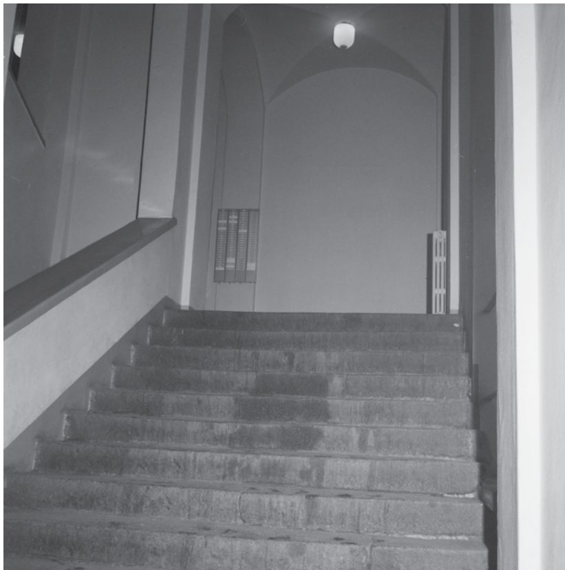
Rakennuksen A portaikot olivat säilyneet hyvin lähellä alkuperäistä asuaan. Itäinen portaikko kuvattuna 1973. Jarkko Sinisalo, MV.
