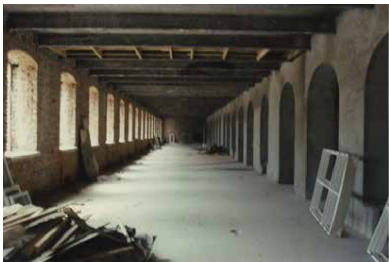
Tilannekuva korjaustöiden edetessä. Keskimuuri on korjattu, vahvistettu ja rapattu, välipohjien betoniosat on purettu. Kråkströmin aineisto, UM.
