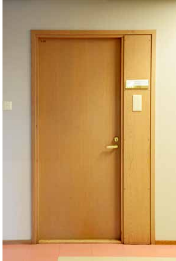
Siipirakennuksissa C ja G työhuoneiden ovet ovat tammivii- lupintaisia laakaovia.
