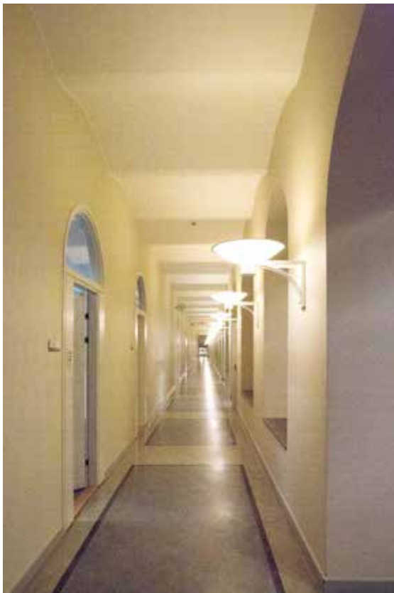
Rakennuksen A toisen ja kolmannen kerroksen käytävillä on näkyvissä kappaholvikatto. Lattia on linoleumia kuten muissakin 1800-luvun rakennuksissa E ja H.
