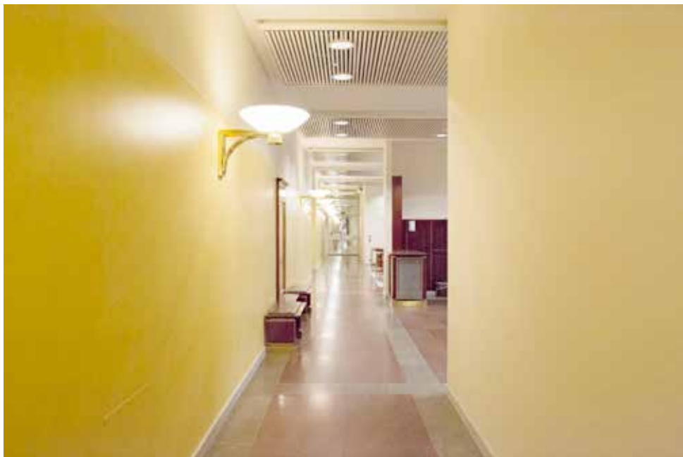
Rakennuskokonaisuuden eri rakennusten käytävissä toistuvat alumiinisäleistä koostuvat alasasketut pinnat, jotka vuorottelevat umpiosien kanssa. Rakennuksen A julkiset aulatilat on päällystetty Öolannin kalkkikivellä.
