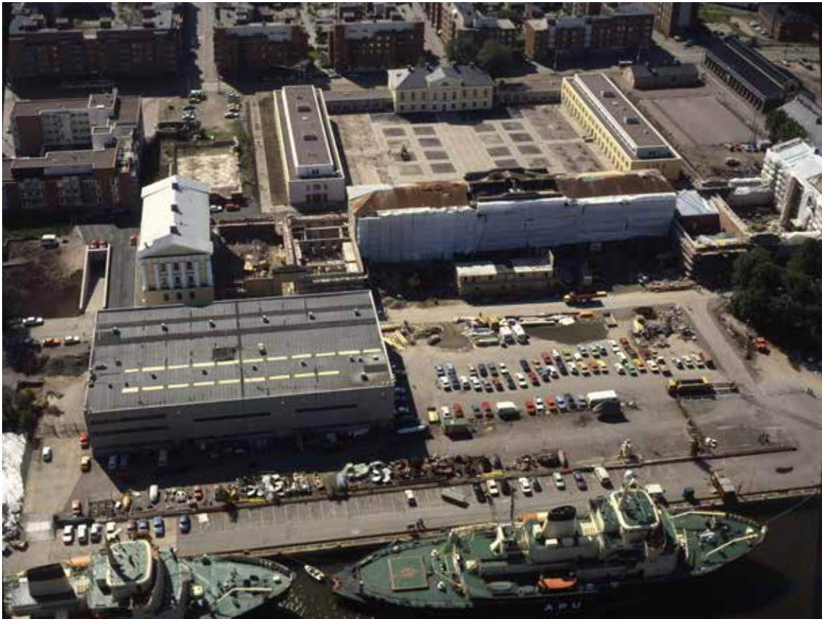
Vuoden 1987 tilanteessa uudisrakennukset B, C, D, F ja G sekä peruskorjattu rakennus E ovat valmistuneet, rakennuksen A purkutyöt suoritettu ja rakennusten A ja H peruskorjaus- ja muutostyöt käynnissä. Etualalla näkyy suurikoinen Valmetin halli, joka purettiin vasta 1990-luvun alussa. Helifoto, UM.
