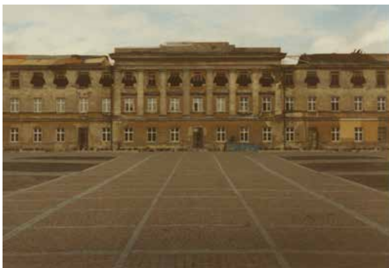
Tilannekuva ulkoa purkutyön aikana. Kråkströmin aineisto, UM.
