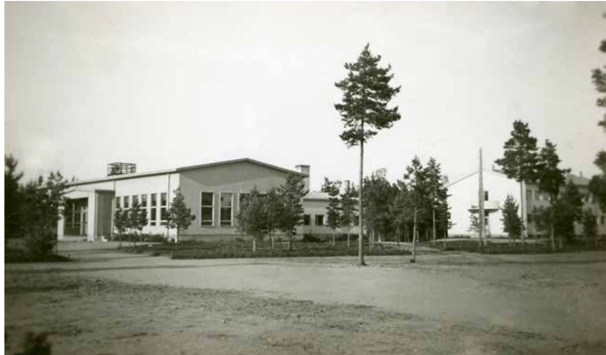
Todennäköisesti 1940-luvun alussa otettu kuva, jossa näkyy kahvilarakennus katollaan ilmatorjuntakonekiväärin lava. Oikealla lottien leipomo- ja asuinrakennus. Kankaanpään kaupunginmuseon kuva-arkisto.
