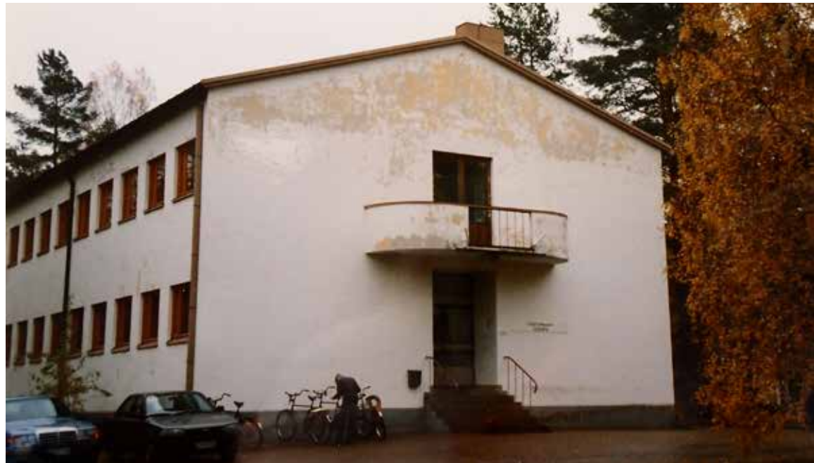
Rakennuksen julkisivurappaus on korjattu tarpeen vaatiessa. Nämä kuvat ovat luultavasti 1980-luvun lopulla tai 1990-luvun alkupuolella otettuja. PhRakL, Hamina
