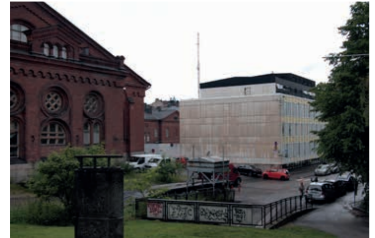
↓ Näkymä Virastosiiven (D-rakennus) päädyistä Kasarmikujaa ylös länteen. Virastosiiven betonisokkelin yläpuolisen pinnan koristuksena on kuorielementtiruudutus. Betonimuurin elementtijakoa ei voi kutsua koristukseksi. amoy.
