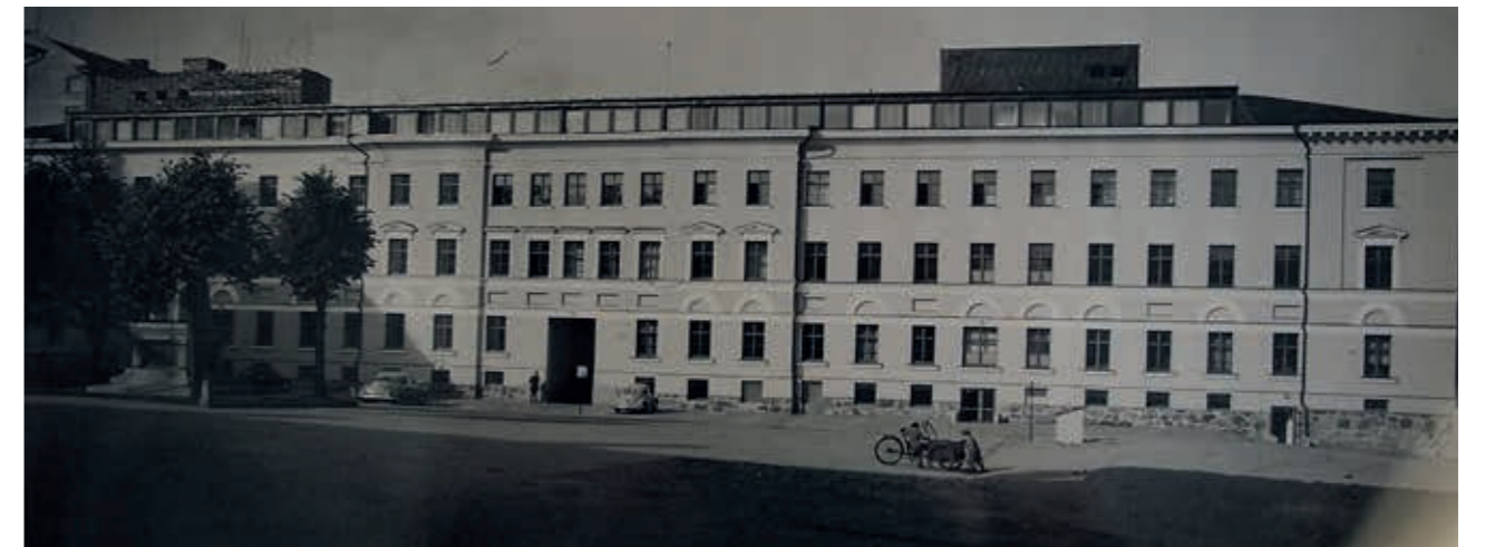
↑ Upseerikasarmi 1950-luvun muutosten jälkeen. Kuvassa näkyvät sisäpihan puoleinen uusi kattokerros ja uudet hissitornit. AMA
