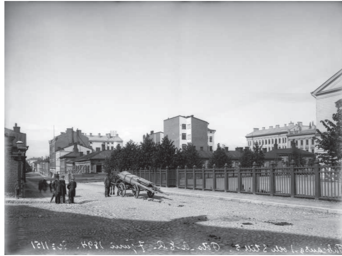
↑ A.E. Rosenbröjjerin valokuvassa vuodelta 1894 näkymä Fabianinkadulta kasarmi-korttelin kaakkoiskulmalta koilliseen. Vasemmalla kivirakenteinen muuria ja talousrakennuksia (purettu 1900-luvun alussa Varussivustan tieltä). Katutila on varsin jäsennelyä, kadut ovat mukulakivetyt, jalankululle on rakennusten vierillä korotetut, nupukivetyt ja kivipaasin katetut kaistat ja Kaartin korttelin kulmalla on katulyhty, todennäköisesti kaasukäyttöinen. HKM.
