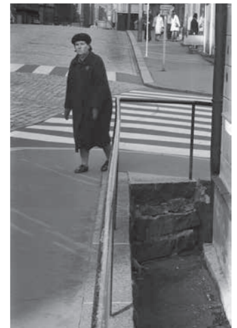
↓ Eteläisen Makasiinikadun profiili laskee voimakkaasti itään päin ja korkeuseroa Kaartin kasarmijulkisivun länsipäädystä itäpäättyyn on edelleen lähes kellarikerroksen verran. Rakennuksen on länsipääty on upoksissa ja vajaan metrin kuilu nykykadun tason alapuolella suojattu teräskaitteella. Tilanne on ollut samankaltainen ainakin vuodesta 1956, mutta kaide on uusittu. 1 Kulmalla on graniittisen seinämän suojaama kuilu, jossa vanhempaa, mukulakivetä pintaa. amoy 2016.
