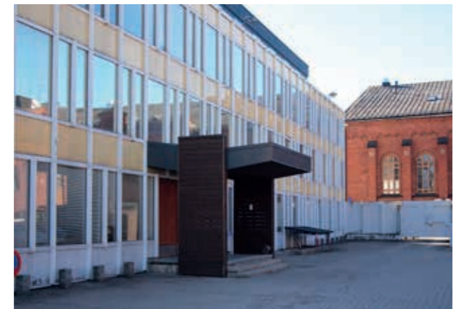
↑ Virastosiiven D-rakennuksen pääsisäänkäynnin uusi katos. amoy 2016 ↓ D-rakennus, päätyjulkisivu pohjoiseen. PHRAKL
