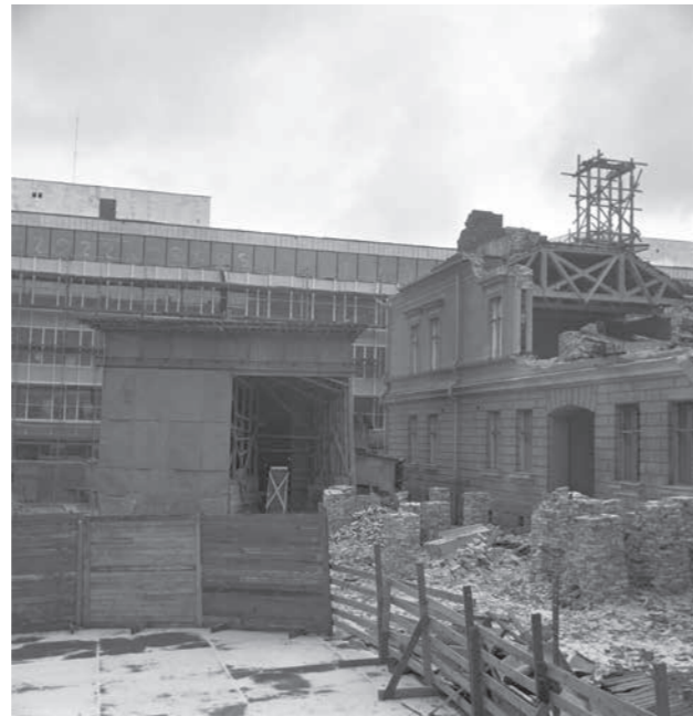
↑ Artellirakennusta puretaan vuonna 1961, taustalla vastavalmistunut C-rakennus. SM
