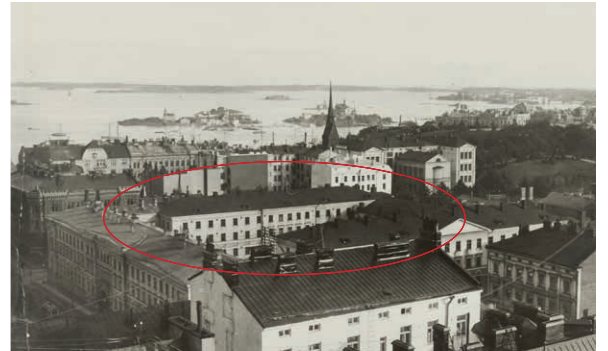
↑ Näkymä Erottajan paloaseman tornista vuonna 1905. Vasemmalla Upseerikasarmi, Itäisen miehistökasarmin sisäpihan julkisivua Upseerikasarmin oikealla puolella. MV
