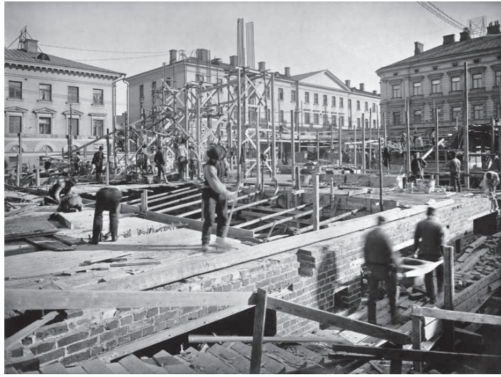
↑ Helsingin kaupungin sähkölaitoksen hallintorakennuksen rakennustyömaa Pikku-Roobertinkadun ja Kasarmikadun kulmassa vuonna 1908, taustalla Kaartin kasarmin läntinen miehistösiipi.
