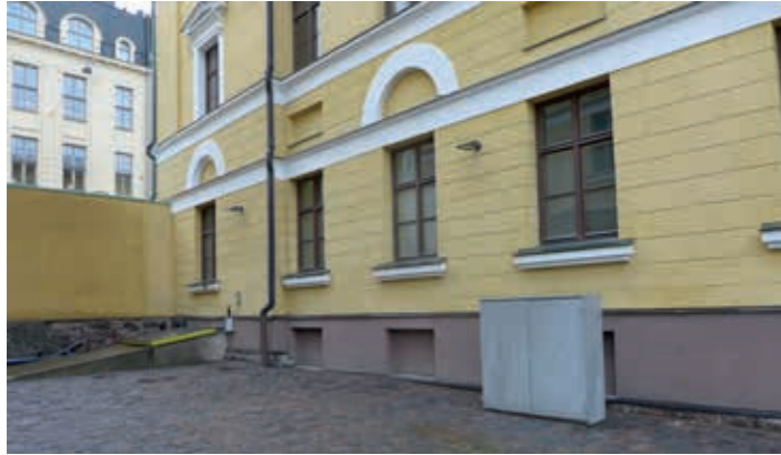
↑ Upseerikasarmien ja läntisen miehistökasarmien välissä on säilynyt kivisokkelille perustettu, rapattu tiilimuri. Kuva on pihan puolelta. Pihapinta on noin metrin muurin takaista katupintaa alempana. amoy 2016. ↓ Läntisen miehistökasarmien päädyssä oleva kvaaderoitu osa on miehistön pesu- ja käymälätilat sisältänyt laajennus 1880-luvulta. Laajennukseen kytketty 1970-luvun betonielementtimuuri ja teräsportti eivät elävöitä katu-kuvaa. amoy 2016.
