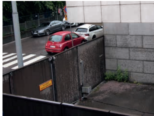
↑ Viereinen D-rakennuksen pääty on myös aidalla suljettu kadulta. amoy
