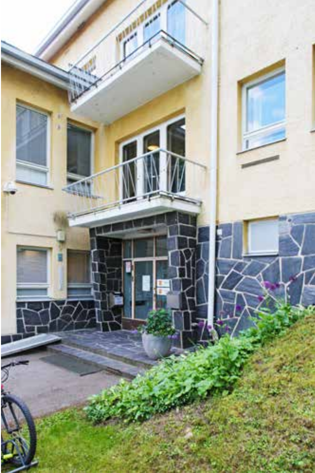
40) A-talon pääsisäänkäynti ja pääporrashuoneen parvekkeet ovat säilyneet alkuperäisinä. Sisäänkäynit, sokkelit ja parvekkeet ovat mukana tuomassa rakennukseen inhimillistä mittakaavaa ja materiaalin tuntua.
