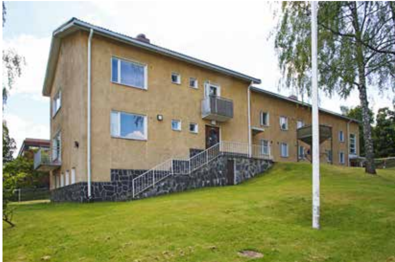
49) B-talon terassille johtavat portaat ovat säilyneet alkuperäisinä.
