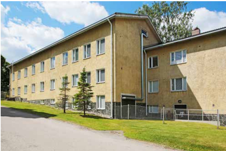
37) B-talon kaakkoisjulkisivuun on lisätty näkyvä ilmanvaihtohormi.
