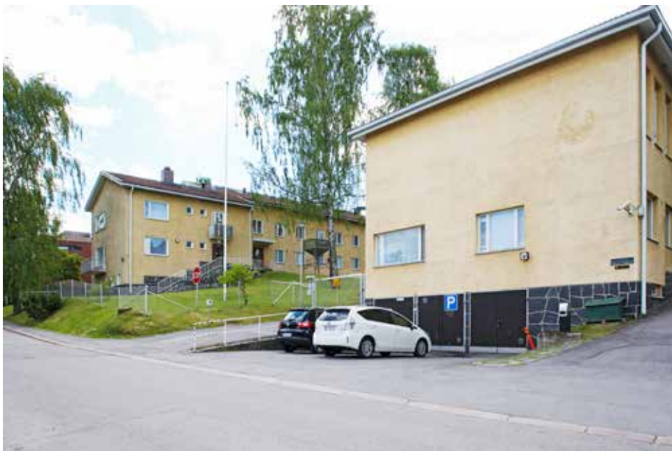
31) Taaempänä B-talo ja lähempänä A-talo vuonna 2016. Rakennusten yleishahmo, julkisivut ja katot ovat säilyneet todella hyvin.
