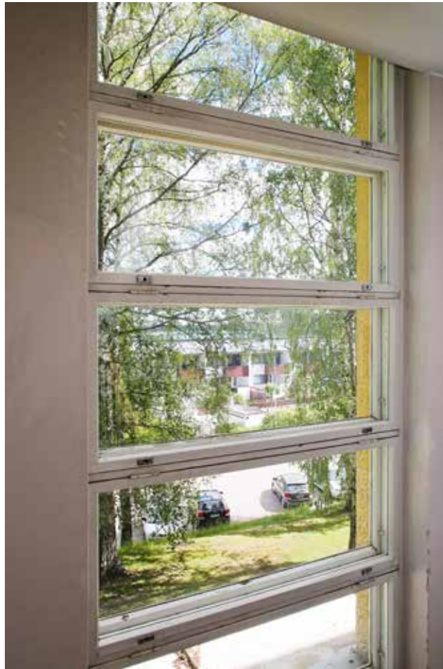
12) Rakennuksen ikkunat ovat alkuperäiset puuikkunat.
