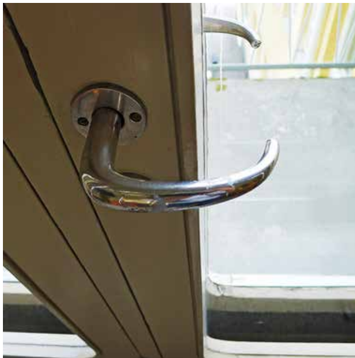
11) Porrashuoneen parvekeovessa on alkuperäinen pukinsarvivedin.
