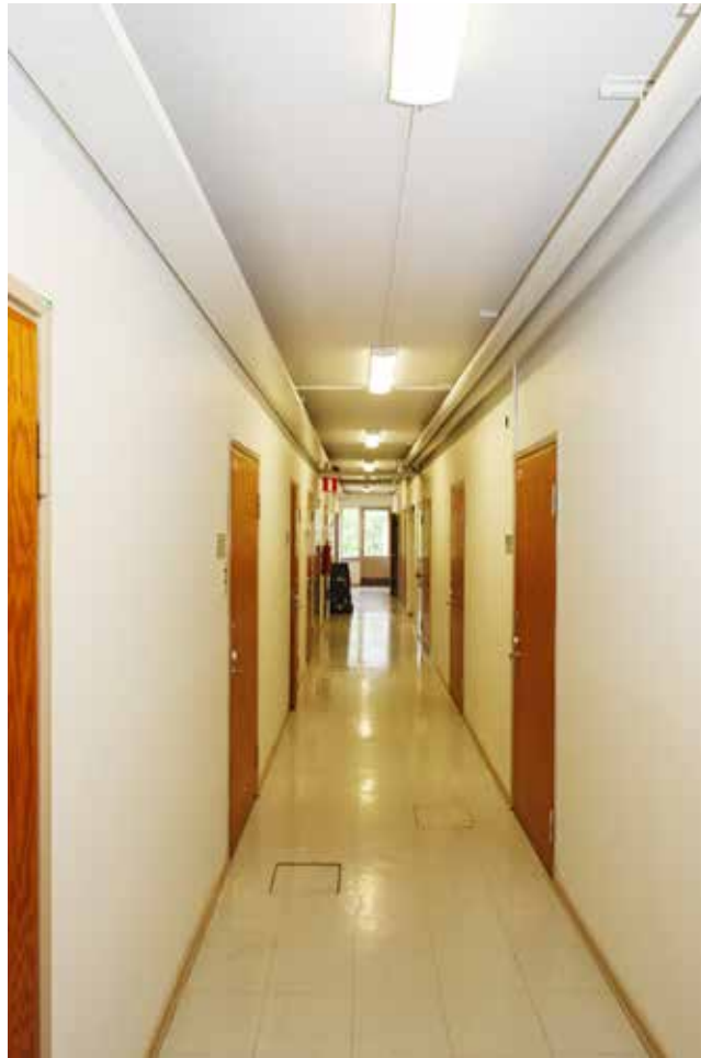
5) Toisen kerroksen käytävä alkuperäisine puuvineen on hyvin säilynyt. Käytävän luoteispäädystä on ikkuna ja lasitettu parvekeovi.
