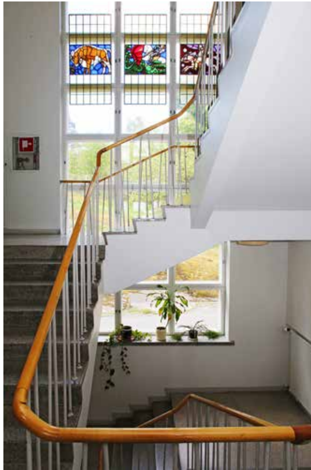
14) Pääportaan alkuperäinen pinnakaide. Käsijohteena on lakattu koivuprofiili.
