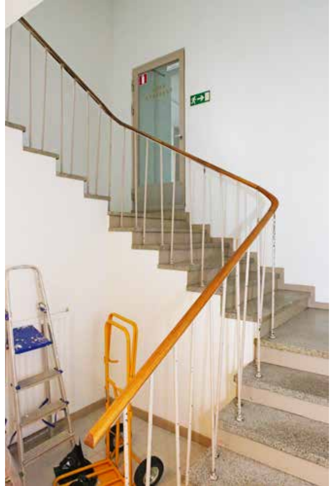
24) Pääportaassa on alkuperäiset betonimosaiikkiaskelmat ja alkuperäinen kaide.
