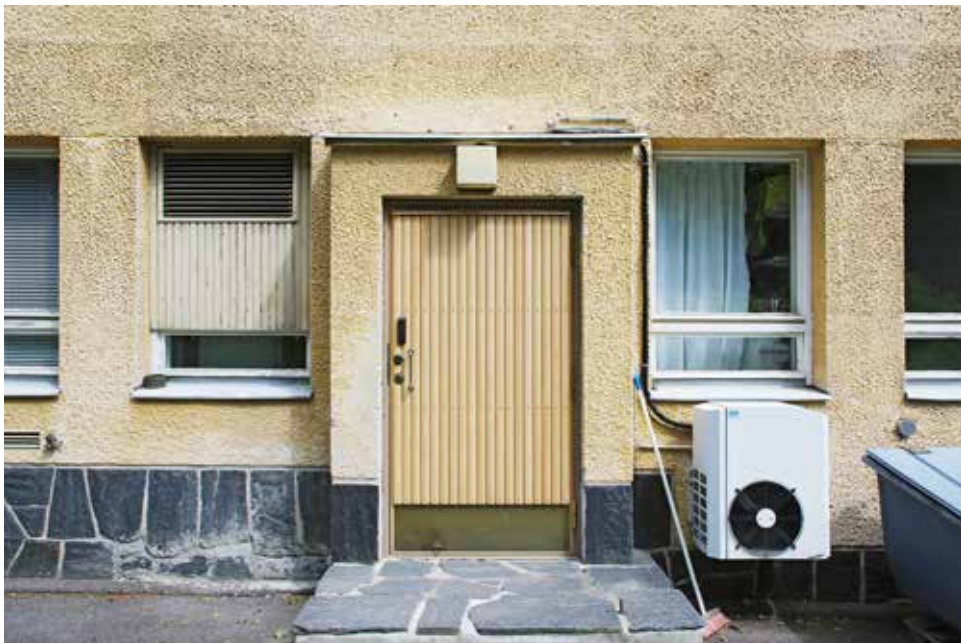
43) Alkuperäisen mallin mukaan uusittu puuovi johtaa A-talon keittiöön.
