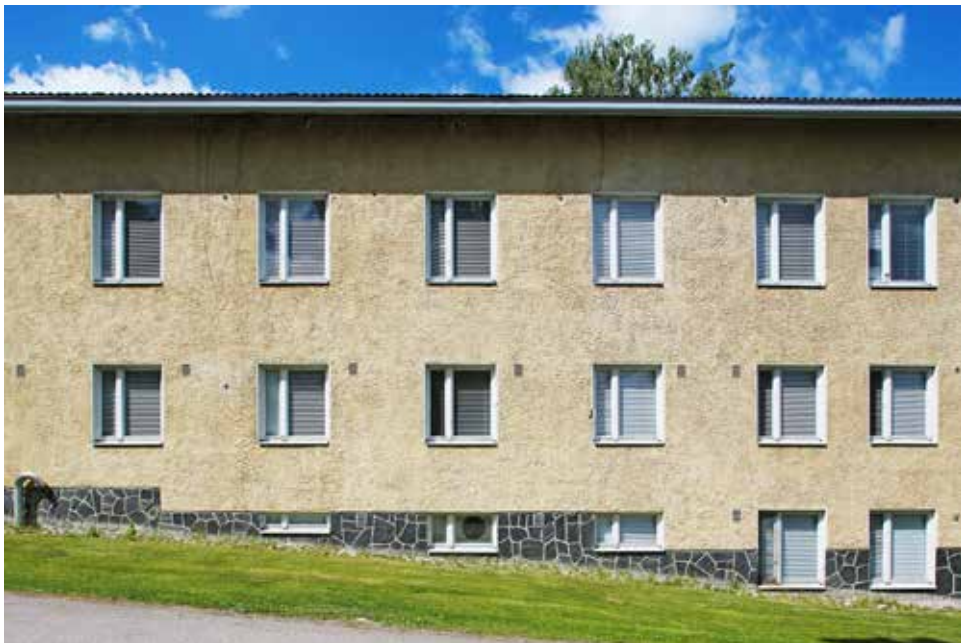
47) B-talon julkisivujen jäsentely on säännöllisempi kuin A-talossa.
