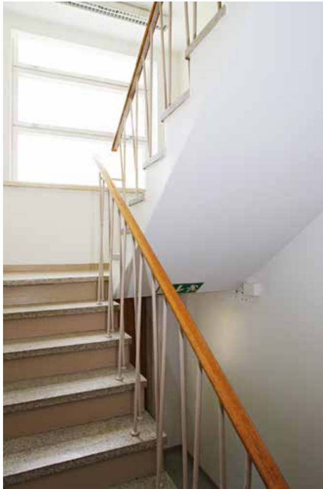
29) Rakennuksen ikkunat ovat alkuperäiset. Sivuporrashuoneen ikkuna on samaa tyyppiä kuin A-talossa.
