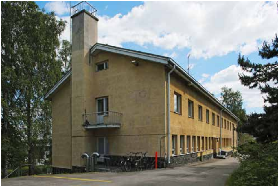
34) A-talon luoteispääty ja lounaispuoli. Luoteispäätyyn on lisätty näkyviä ilmanvaihtohormia. Molemmat julkisivut ovat kuitenkin pääasiassa säilyneet hyvin.
