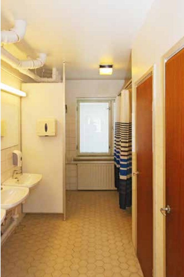
23) Ensimmäisen kerroksen pesuhuoneessa on 1950-luvun klinkkeri-laattalattia.
