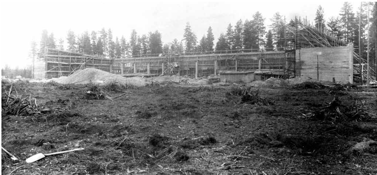
Lentohallin n:o 1 betonivalutyöt käynnissä heinäkuussa 1936. Etualalla näkyy vastikään raivattua lentokoneiden rullausaluetta. Ilmavoimien kuvakokoelma/Sotamuseo
