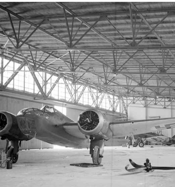
Luonetjärven lentohallit rakennettiin pitkälti samojen piirustusten mukaan kuin Immolan. Kuvassa talvisodan aikana Englannista hankittu "pitkänokkainen" Blenheim Mk.IV Luonetjärvellä maaliskuussa 1940. SA-kuva
