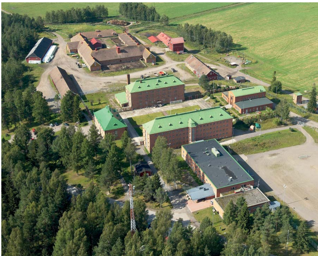
Vankilan aluetta vuonna 2008. (kuvaaja Suomen Ilmakuva Oy/ kuva vankilan omistuksessa).
