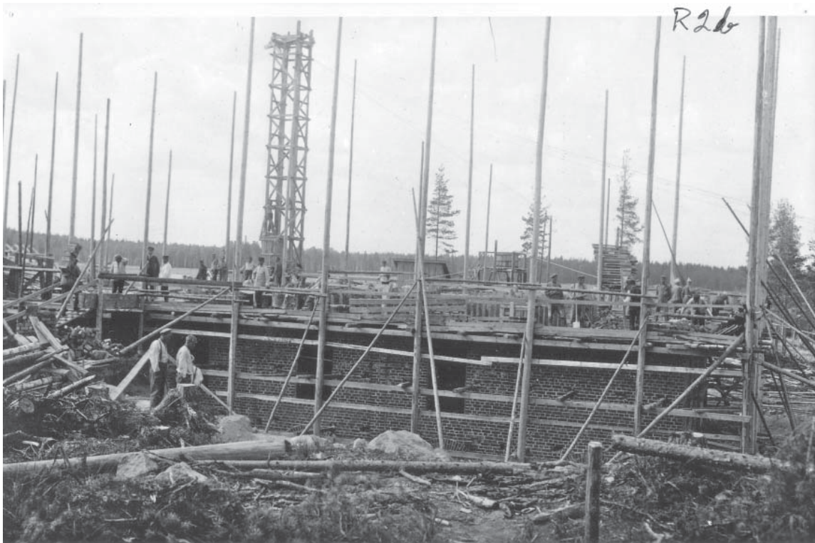
Talousrakennuksen työmaa kesällä 1926. Muuraus on meneillään ensimmäisen kerroksen tasolla. Rakennuksen ympäristö on vielä kaivamatta tasaiseksi.
