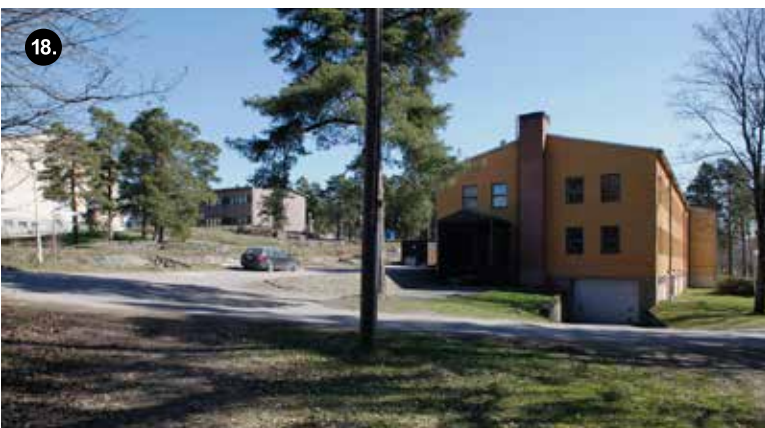
Työpajarakennuksen länsipäätty, las-tauslaituri ja muurattu tiilipiippu.
