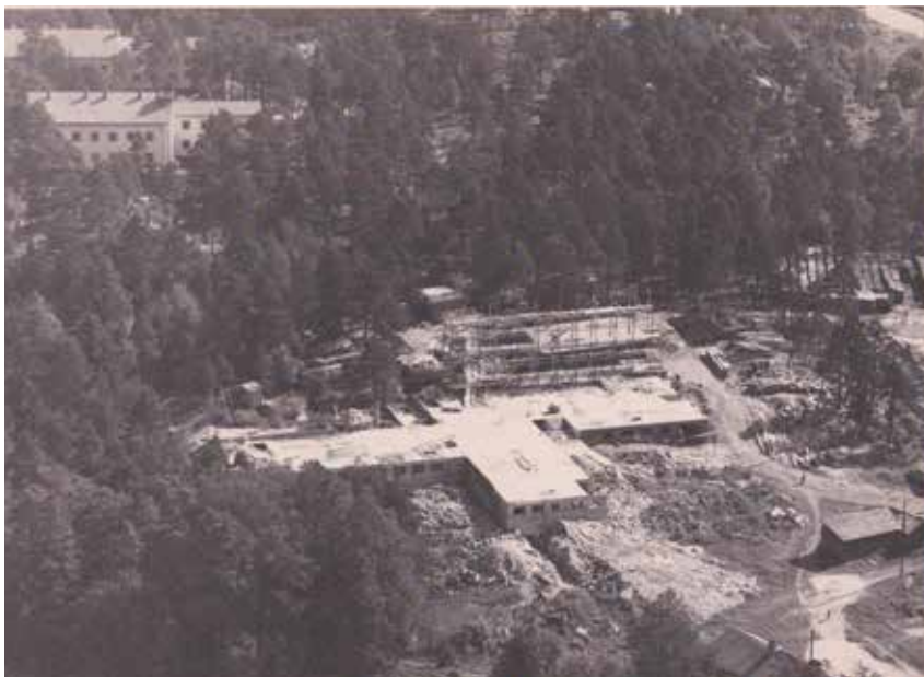
← VAK:in päärakennuksen työmaa 1950-luvun lopussa. Kuvaaja tuntematon, LS.
