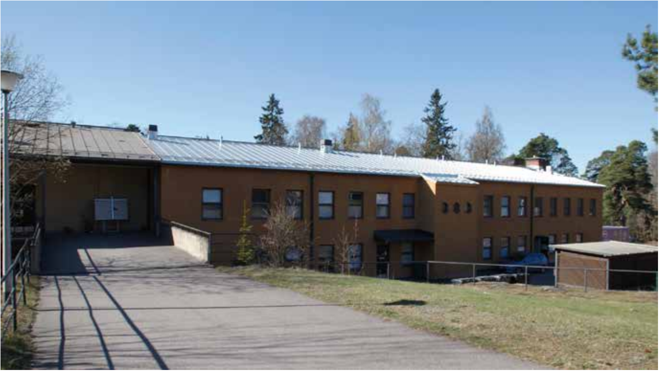
⬇ Työpajarakennuksen pohjoispuoli ja laajennusosan siltayhteys yläpihalle.
