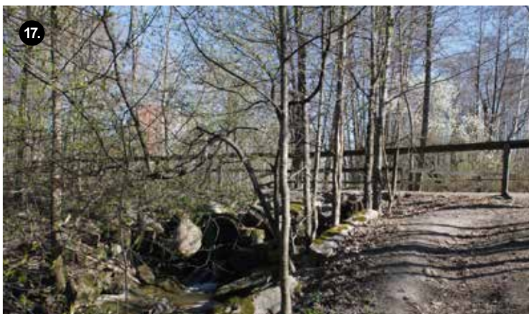
Puron ylitys ja vanhan lammen betonirakenteet.
