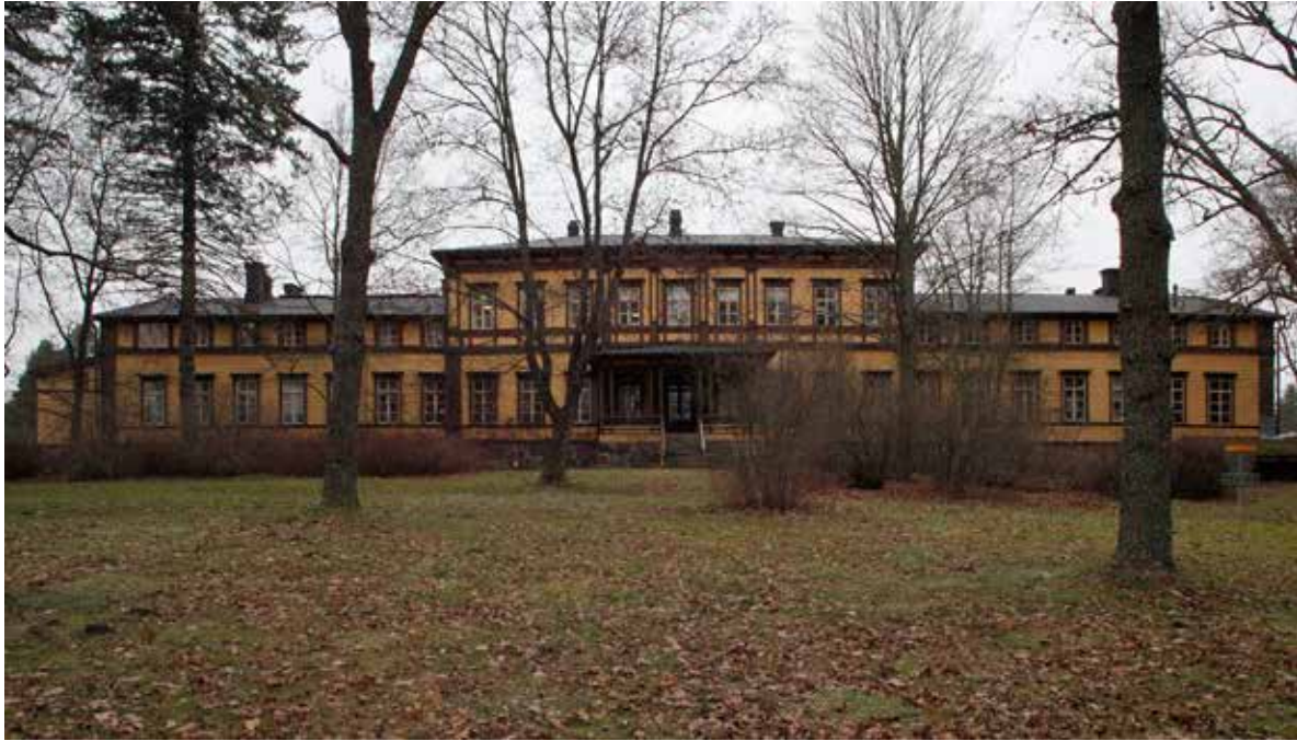
10. Päärakennuksen julkisivu etelään. Julkisivu muistuttaa vahvasti pohjoisen puoleista julkisivua.
