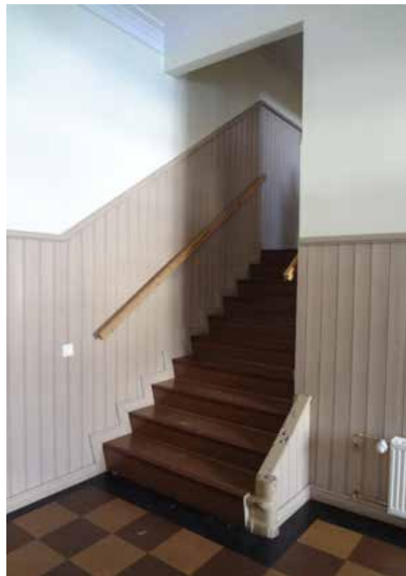
2. Porras johtaa ensimmäisen kerroksen aulasta toiseen kerrokseen. Porrasta on uusittu, mutta sen alkupäässä on vanha yksityiskohta 1800-luvulta.
