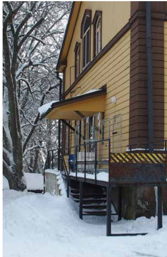
5. Itäpäädyn umpikuisti on purettu ja tilalle on rakennettu ulkoporras ja sisäänkäynnin katos.
