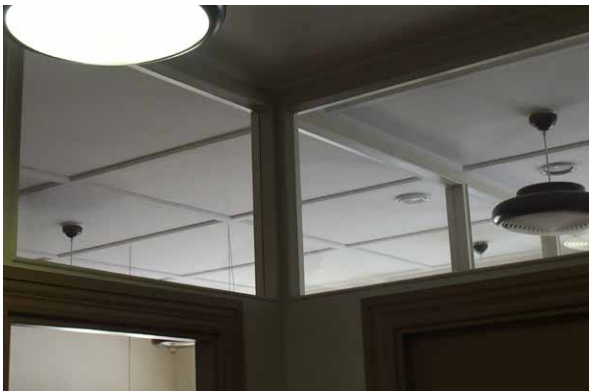
3. Toisen kerroksen toimistohuoneen kevyiden väliseinien yläosissa on ikkunoita.
