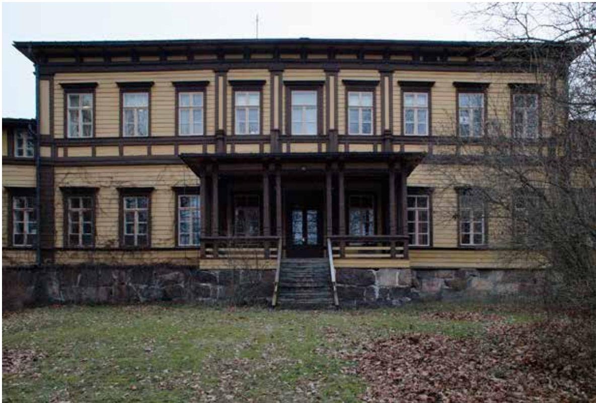
11. Etelän puoleisen avokuistilla on puiset pilariparit. Ovet ovat vanhat, mutta ne eivät ole käytössä. Kuistin takana on juhlasali, jota käytetään myös voimistelusalina. Rakennuksen toisesta kerroksesta on purettu parveke, joka sijaitsi kuistin katoksen päällä.
