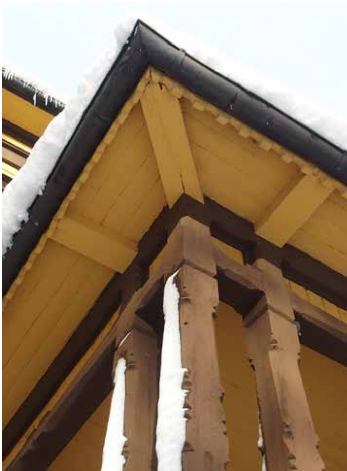
13. Yksityiskohta etelän puoleisen kuistin koristeleikatuista puupilareista ja räystään alapinnasta.
