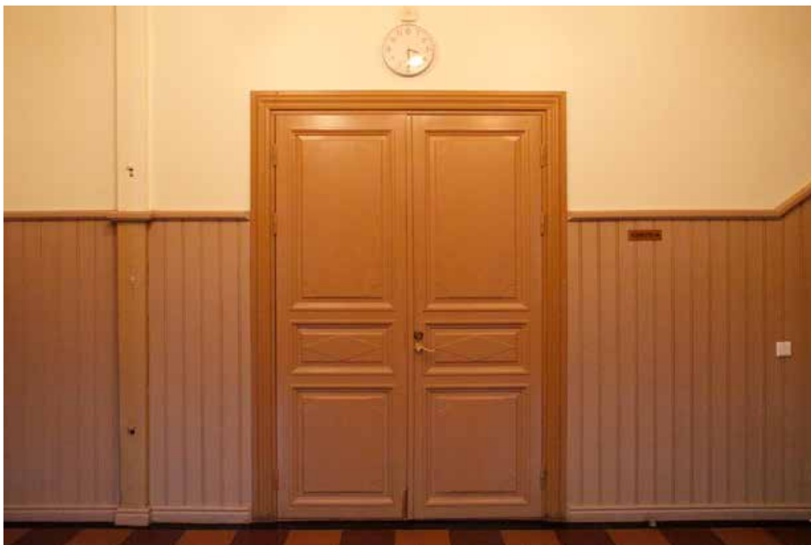
3. Pääsisäänkäynnin aulassa on vanhat puupeiliovet juhlasaliin. Lattialla on kahdenvärisiä vinyylilaattaruutuja. Seinien alaosat on paneloitu.
