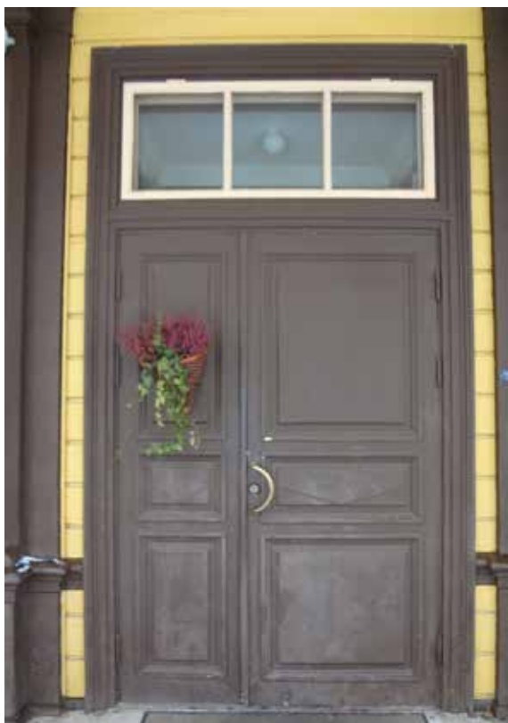
3. Pohjoisen puolen pääsisäänkäynnin ovi on vanha, muttei alkuperäinen. Ovet ovat olleet alun perin yhtä leveät, nyt sivuovi on pääovea kapeampi. Ovien kasettikuviointi noudattaa alkuperäistä kuviointia. Oven päällä on kolmiruutuinen ikkuna.
