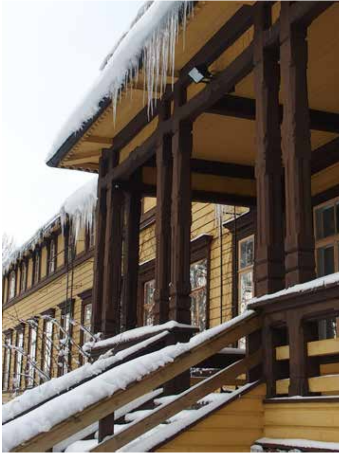
12. Etelän puoleisen kuistin kaiteet ovat olleet alun perin ristikaiteita, nykyisin ne ovat vaakalautakaiteita. Puuporras on uusittu.
