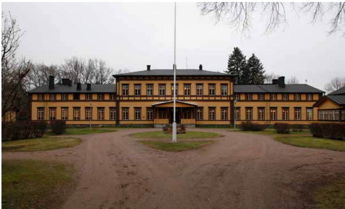
1. Sippolan koulukodin päärakennuksen julkisivu pohjoiseen. Rakennus on symmetrinen. Keskiosassa on sivusiipiä korkeampi. Julkisivujen uusrenessanssi-ilme on peräisin 1850-luvulta. Rakennuksen edessä olevaa pihaa rajaavat vasen ja oikea sivurakennus.
