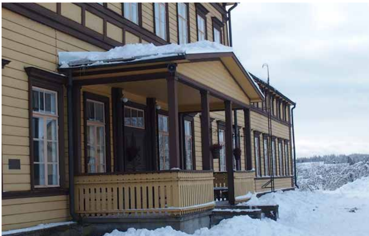
2. Päärakennuksen pohjoispuolen kuistin katos on uusittu ja sen ulkoasu on alkuperäiseen verrattuna yksinkertaistunut. Myös porras on uusittu. Muilta osin rakennuksen ulkoasu vastaa pitkälti 1800-luvun ulkoasua.
