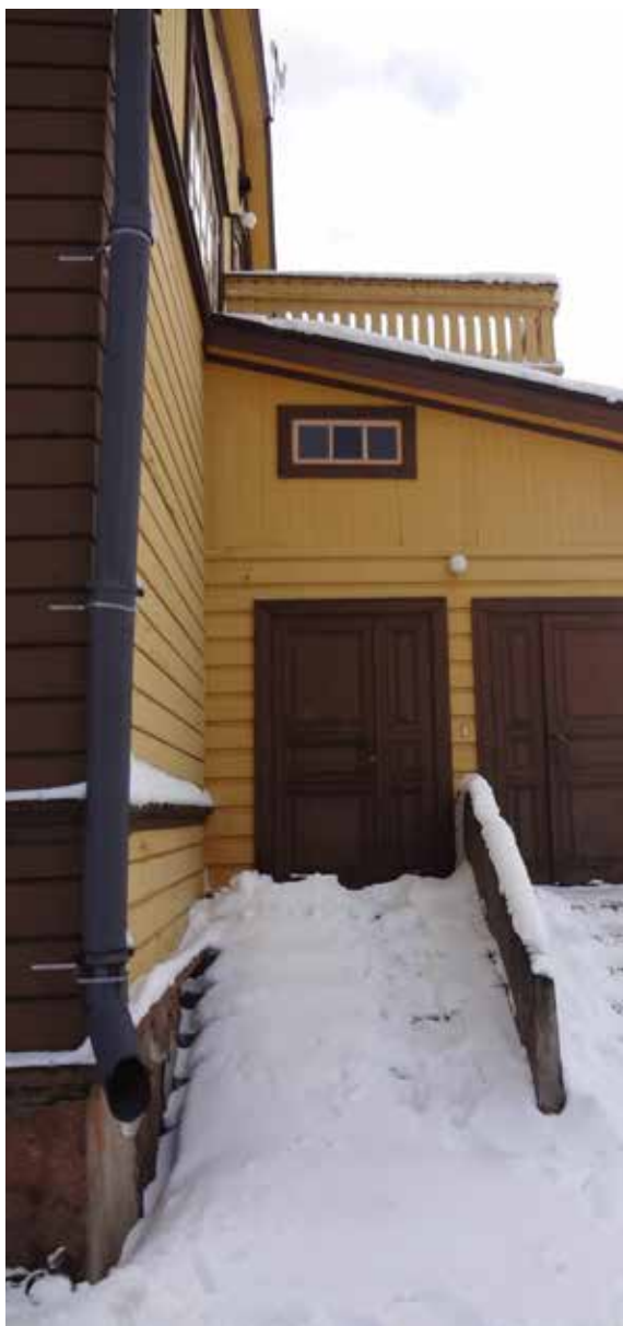
8. Rakennuksen länsipäädyn yläkertaan on lisätty parveke. Portaat on uusittu. Sisäänkäynti ei ole tällä hetkellä käytössä.
