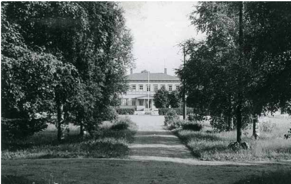
Näkymä kohti koulukodin päärakennusta. Kuva on ajoittamaton, mutta mahdollisesti 1950-luvulta. Sisäänkäyntitien molemmin puolin sijaitsi tällöin suuria koivuja. Kartanonpihaa rajaa leikattu pensasaita ja sen takaista puustoa on uudistettu. SiA.
