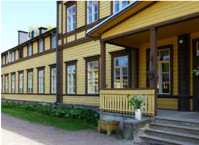
Päärakennuksen seinustalle on istutettu vuorenkilpiä leveänä kaistaleena. Kuisti on koristeltu pihasta poimituilla morsiusangervon kukilla koulun kevätjuhlaa varten.
