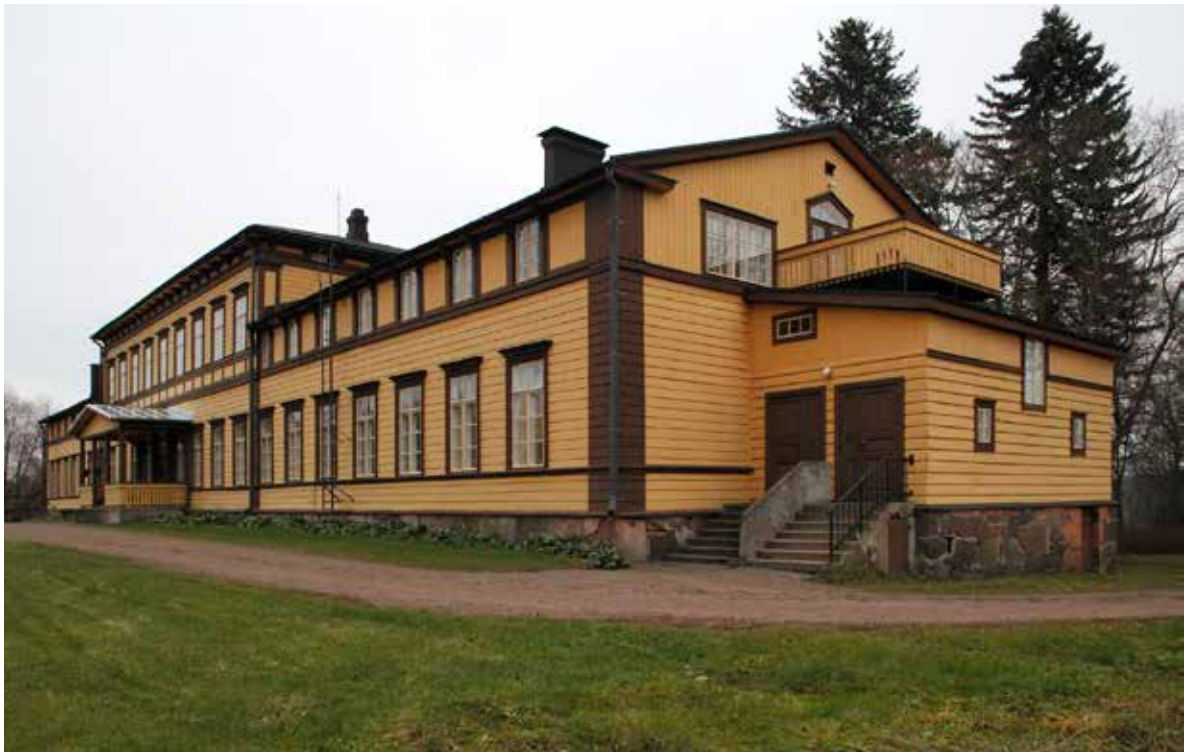
4. Näkymä kohti kaakkoa ja päärakennuksen luoteiskulmaa.
