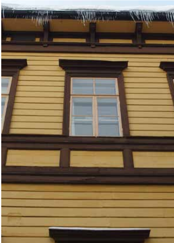
6. Räystäiden alapinnat ovat koristeellisia. Ikkunat ovat sisään-ulos avautuvia puisia ruutuikkunoita.
