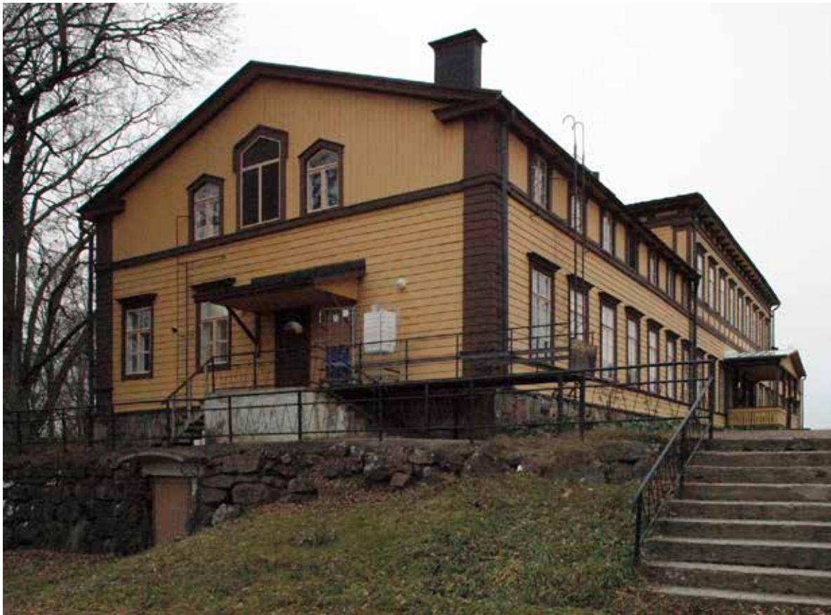
7. Näkymä kohti länttä. Rakennuksen itäpuolella on graniittimuurin keskellä ovi, joka johtaa kellaritiloihin.
