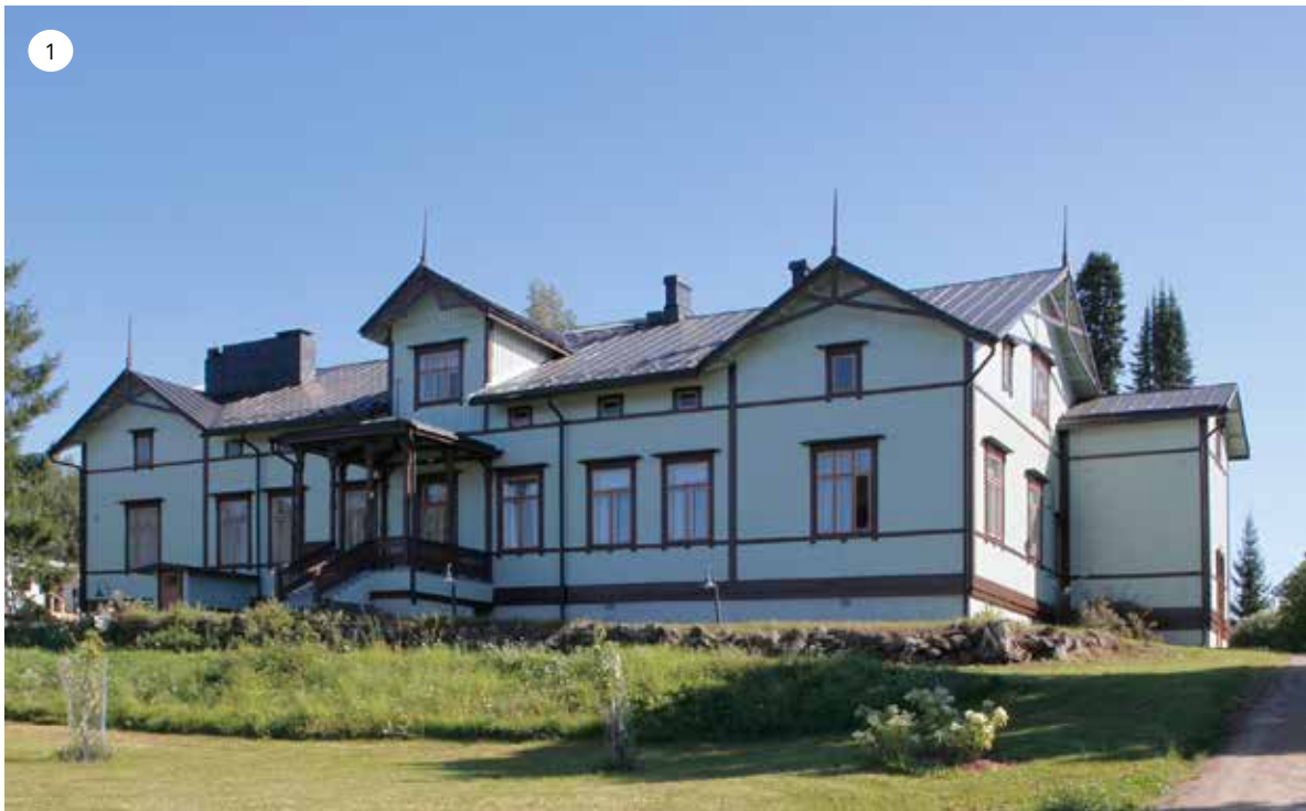
Päärakennuksen länsijulkisivu kesällä 2015. Rakennuksen hahmo on säilynyt hyvin. Kuistin porras on nykyisin keski-akselissa eikä sivulla, kuten ennen.
