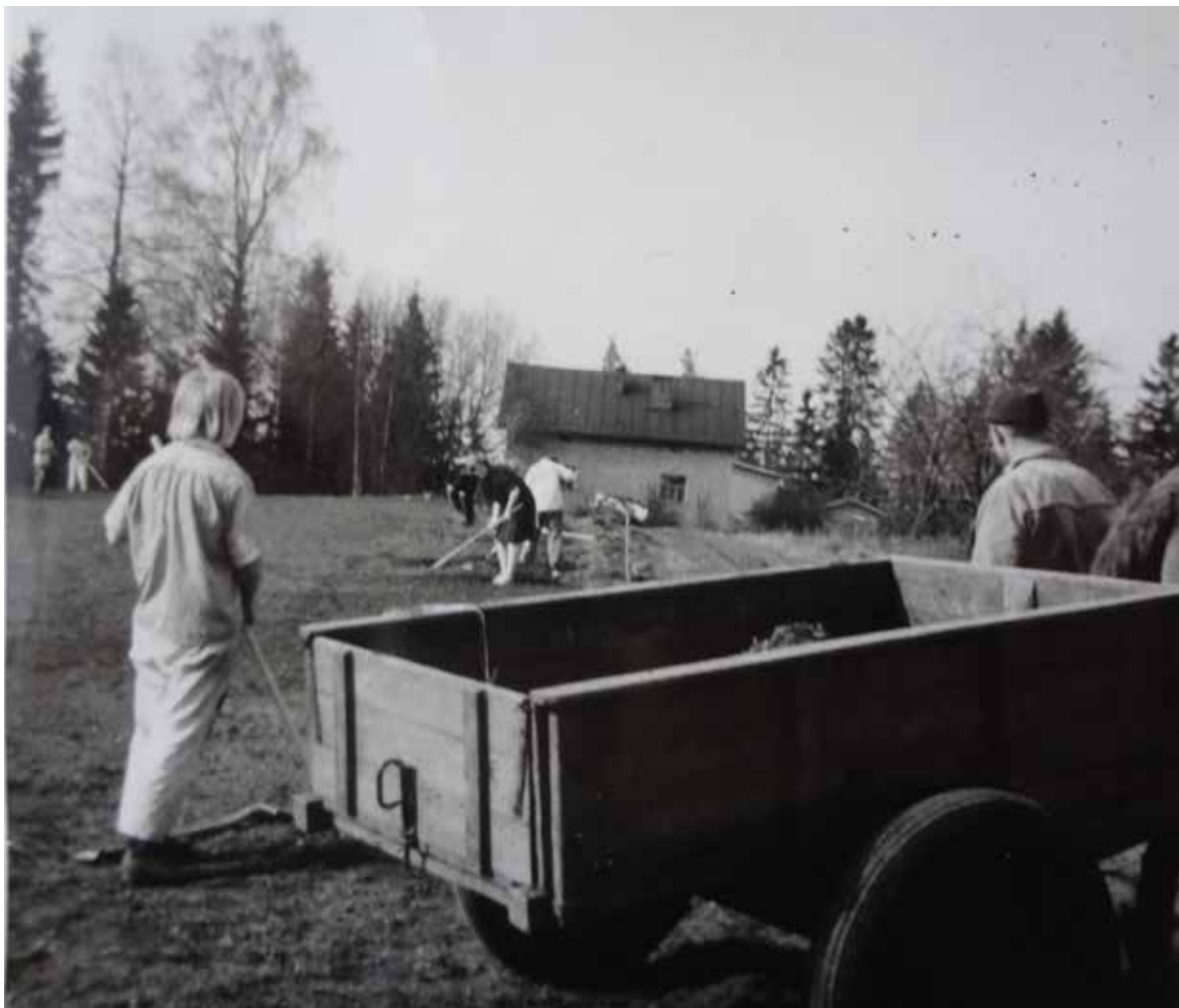
Koulukodin väkeä kunnostamassa kasvimaata kesällä 1964. Taustalla näkyy alueen pohjoisosassa sijainneet tilanhoidajan asunto, ulkorakennus ja talouskellari, jotka purettiin vuonna 1983 henkilökunnan asuinrakennusten alta. KA.
