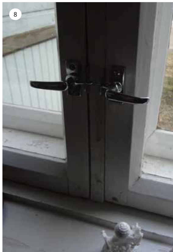
Rakennuksen ikkunat ovat kaksilasisia puuikkunoita. Puitteet ja karmit ovat vanhoja, mutta ikkunoita on kunnostettu ja tiivistetty sekä helat uusittu.
