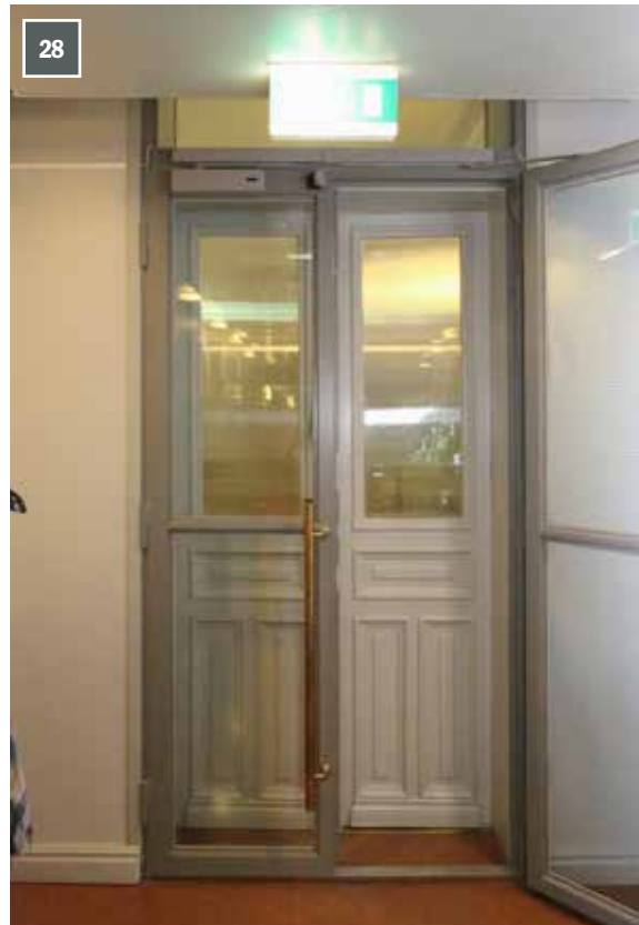
Käytävän puolelle on asennettu uudet teräslasipalo-ovet vuonna 1999.
