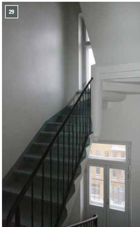
Pihasiiven eteläpäädyn keittiöporras on kapea betoniporras. Portaassa on pölytysparvekkeita.
