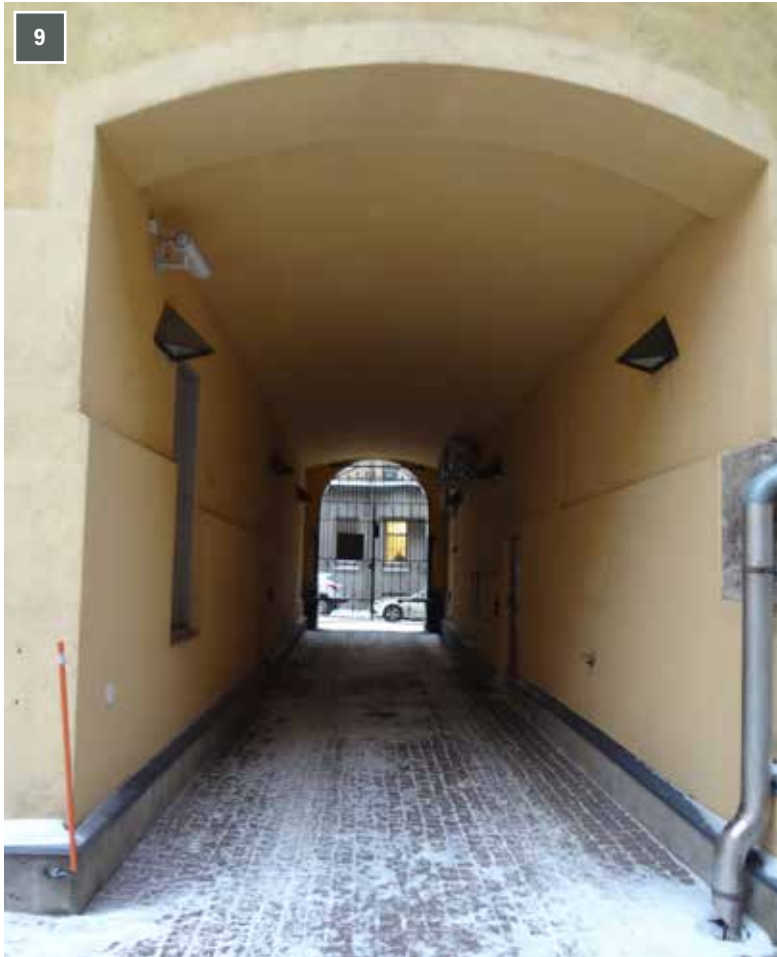
Porttikäytävän maanpintaa on laskettu 1999, kun pihakansi purettiin. Tällöin tehtiin uudet betonisokkelit ja sisäänkäynnit. Maahan asetettiin nupukivetys.
