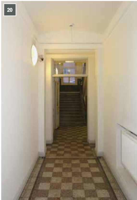
Sisäänkäyntihalli johtaa Rikhardinkadulta pääportaaseen. Vanhat puiset heiluriovet on poistettu.
