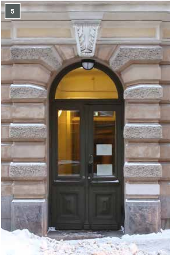
Pääsisäänkäynnin puupeilipariovi on vanha ja kunnostettu. Ikkunoissa on eristyslasit.
