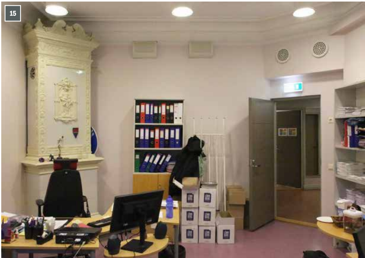
Pääsiiven kolmannen kerroksen länsipäädyn odotushuone vuonna 2016. Pariolet on muutettu yksilehtiseksi oveksi. Seinien yläosiin on puhkaistu ilmanvaihtokanavien aukkoja 1999. Myös linomatto ja valaisimet ovat vuodelta 1999.
