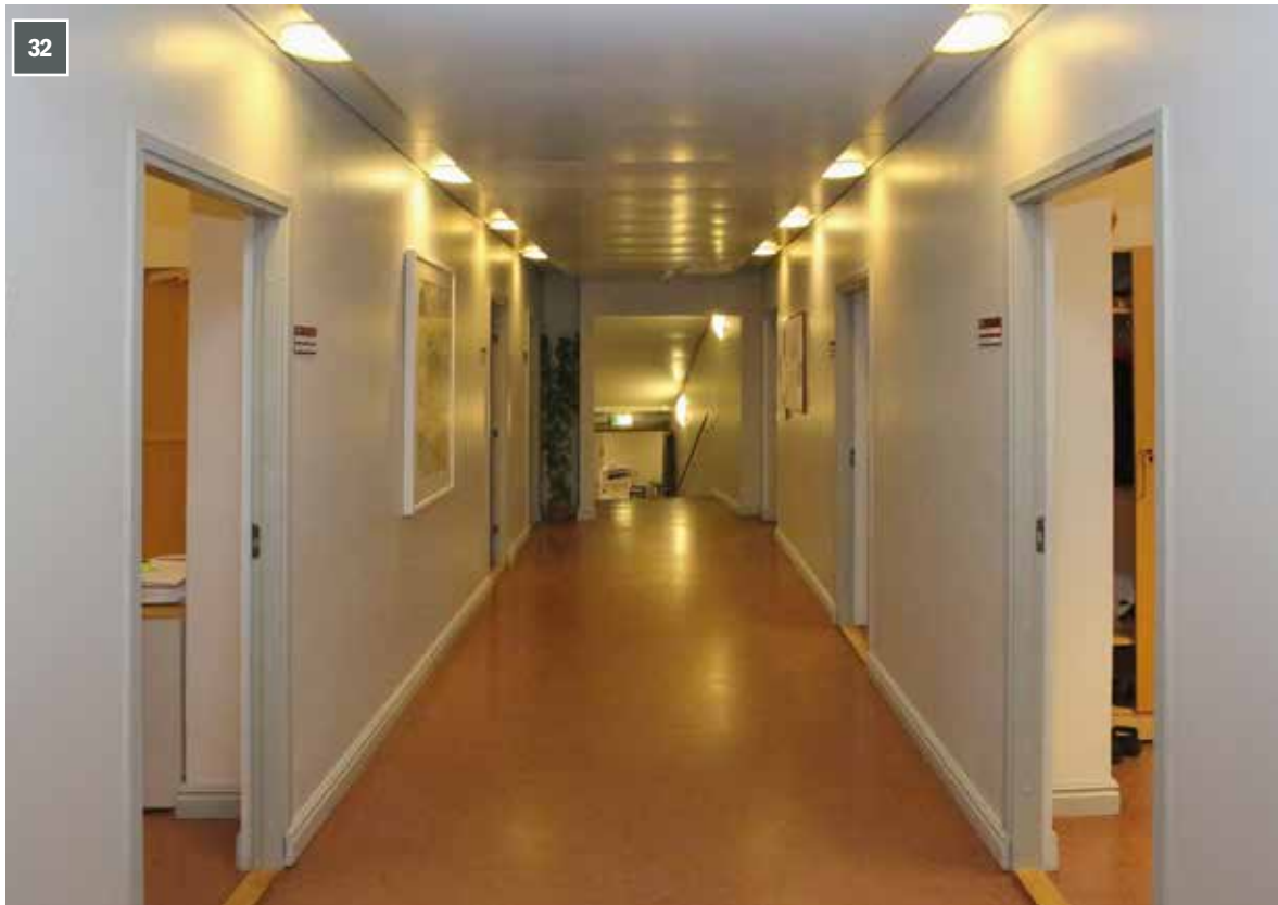
Pääsiiven neljännen kerroksen toimistokäytävänäkymä kohti palo-osastoitua rakennusten välistä yhdysporrasta. Lattiat ovat punaista linomattoa (1999), lattialistat ovat uusia, uusrenessanssityylisiä puulistoja. Käytävän katto on alas laskettu ja siihen on integroitu ilmanvaihtolaitteistoja.
