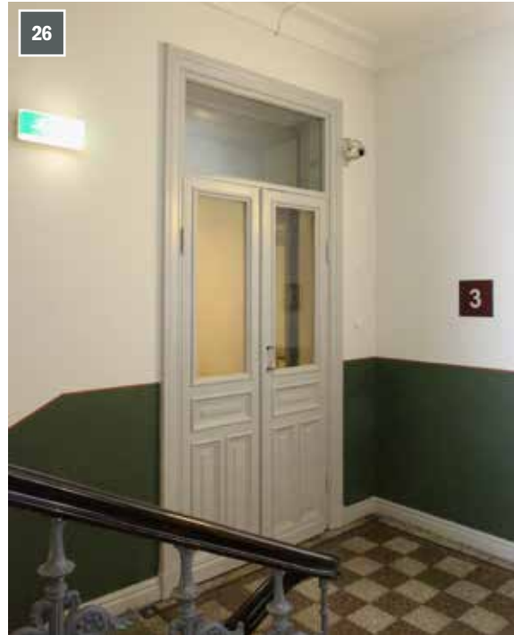
Pääportaan kolmannen kerroksen kerrostaso vuonna 2016. Ovet on kunnostettu ja lasit on uusittu 1999, kuvioiteja ei enää ole. Seinät on maalattu vöhykkeisiin.
