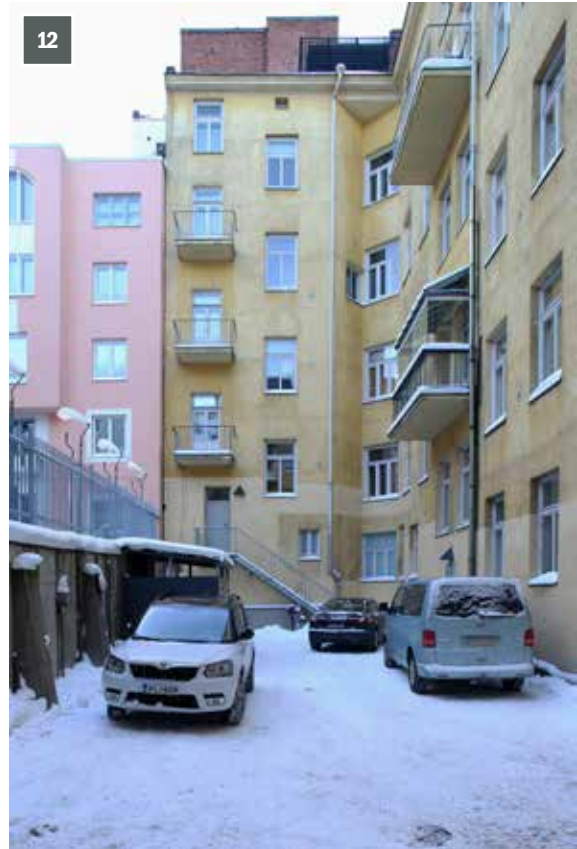
Pihänäkymä kohti pihasiiven itäjulkisivua. Vasemmalla on 1999 valettu tukimuuri, jonka päällä on teräsaitea. Tukimuuria vasten on 1999 rakennettu jätehuone. Talon sisäkulman katos on purettu 1999.
