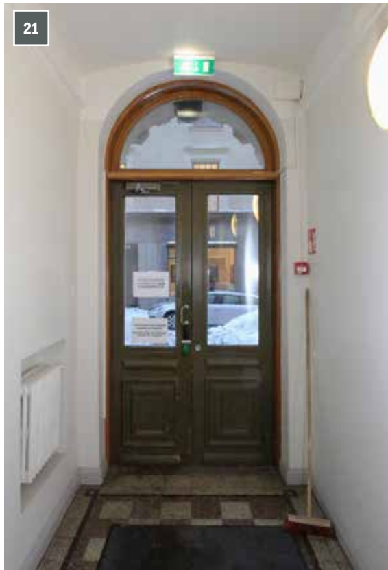
Sisäänkäyntihallin puupeiliövi on vanha, mutta kunnostettu. Oven yläpuolella on puolipyöreä ikkuna. Seinäsyvennyksessä on valurautainen pylväsradiaattori vuodelta 1933, jolloin rakennukseen asennettiin keskukslämmitys.
