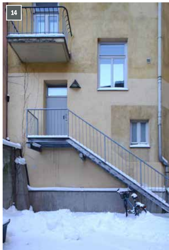
Pihasiiven itäjulkisivuun asennettiin 1999 uusi teräs-rakenteinen ulkoporras, joka johtaa pihasiiven keittiö-portaan ensimmäiseen kerrokseen. Seinässä näky rappauskorjauksia.
