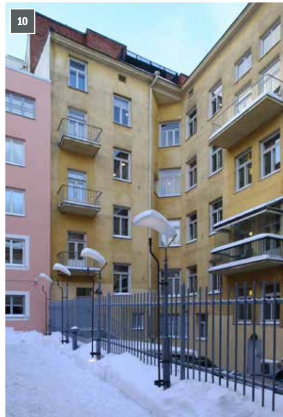
Sisäpihan alta purettiin kellari 1999, jolloin pihan korkeus laski ja rakennettiin uusi ulkoporras, joka johtaa keittiöportaaseen. Pääportaan alempi parveke lasitettiin 1999. Kuva on otettu etelänaapurin tontilta.
