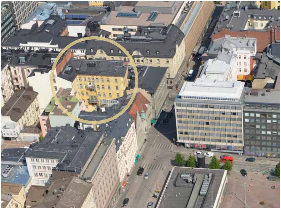
Viistoilmakuva vuodelta 2014. Rikhardinkatu 2:n sisäpihan puoleisille katon lappeille on lisätty 1999 ilmanvaihtolaitteisto. ©Kaupunkimittausosasto, Helsinki 2015-565.
