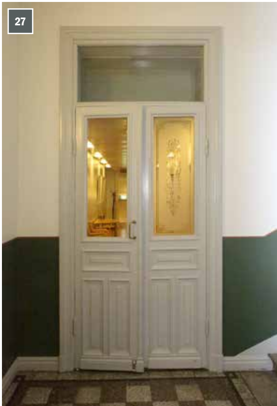
Kolmannen kerroksen porrastasanteen parioven toisessa ikkunalasissa on kuviointi.
