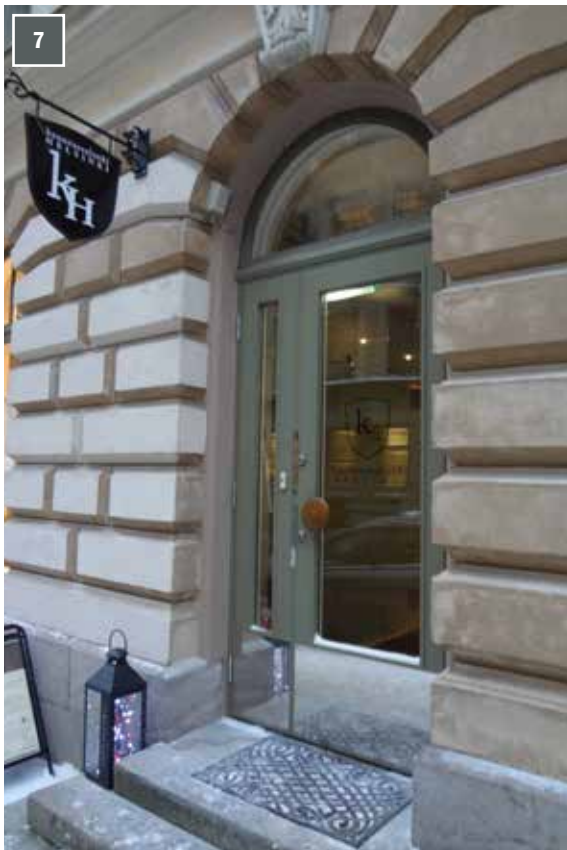
Kauneussalonki Helsinki Oy:n ovi on vaihdettu kesällä 2015 teräslasioveksi. Porraskelmat ovat vanhat.
