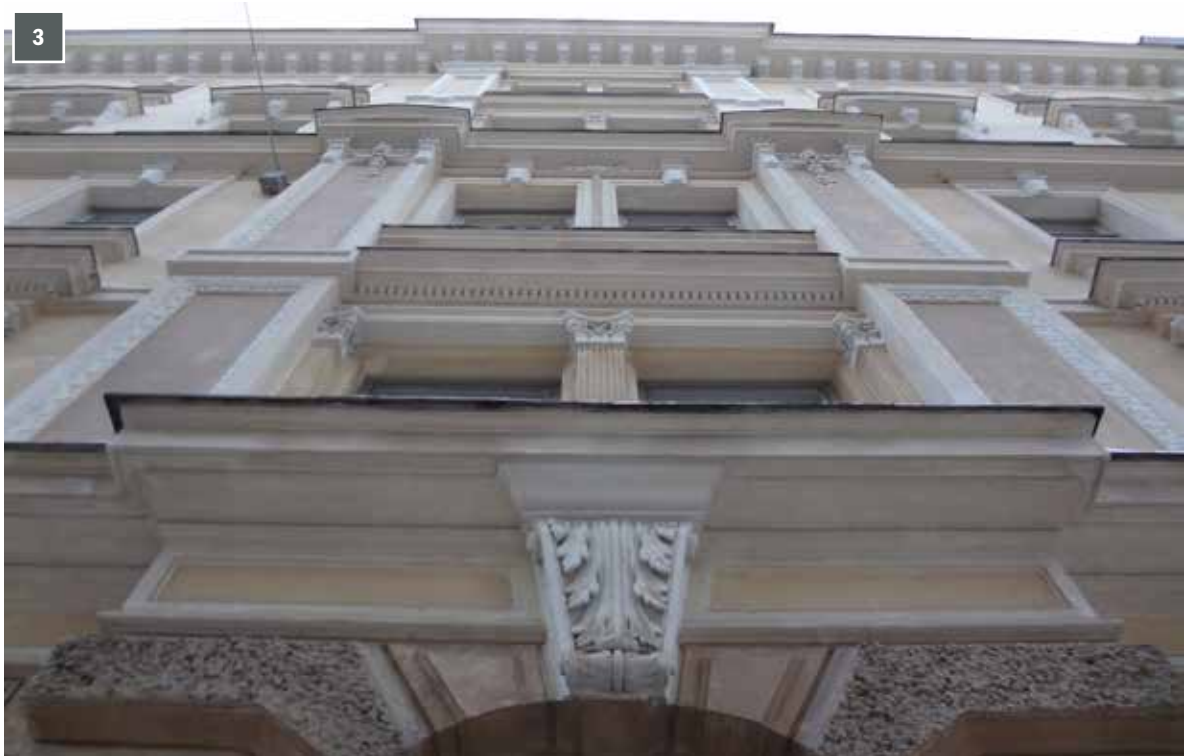
Katujulkisivu on uusrenessanssille tyypillisesti voimakkaasti koristeltu. Kerrosten välissä on profiloidut kerroslistat. Räystään alapinnassa on kipsikonsolit. Kuva on keskirisaliitin kohdalta.
