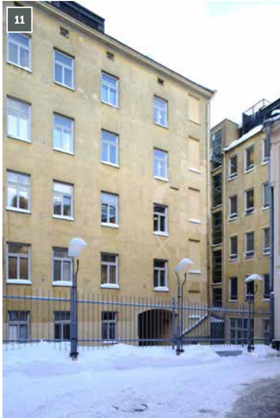
Näkymä naapuripihalta kohti eteläjulkisivua. Porttikäytävän viereinen keittiöporras purettiin 1999 ja portaan ikkunat ja parvekkeet purettiin ja aukot muurattiin umpeen.
