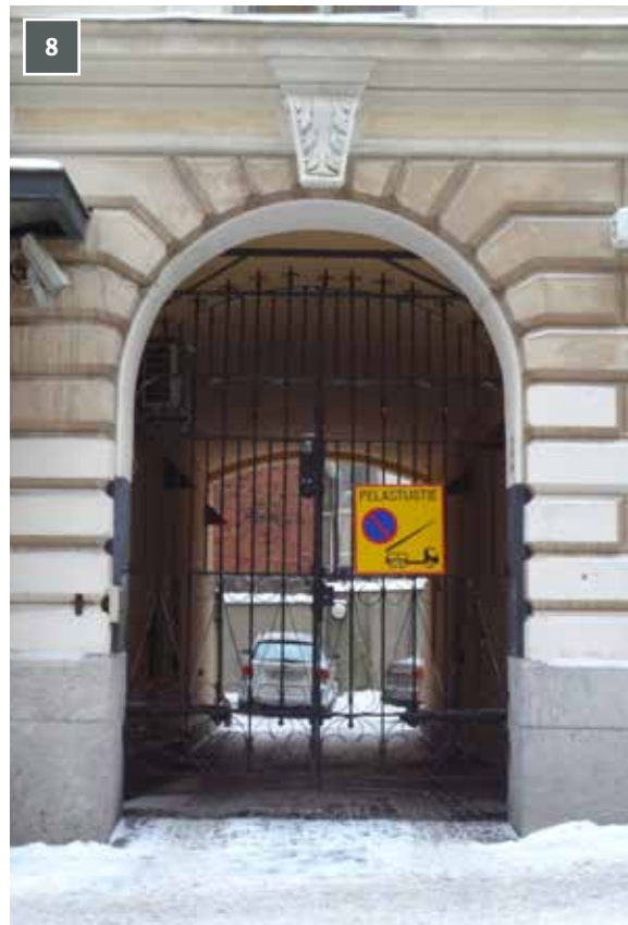
Porttikäytävän rautaporttia on kunnostettu 1999.
