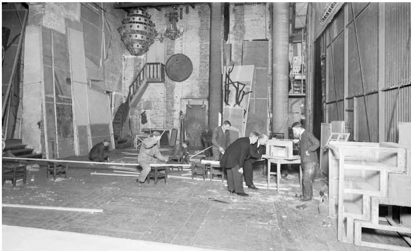
Näyttämö vuonna 1932. Oikealla palo-esirippu, taustalla takakulmasta toisen kerroksen pukuhuonekäytävälle 225 nousevat puuportaat ja vasemmalla takanäyttämölle nousevat portaat. Lavastemallin takana näkyy pyöröhorisontin laitteistoja ja vanha valaistusohjaimo. Pietinen/MV
