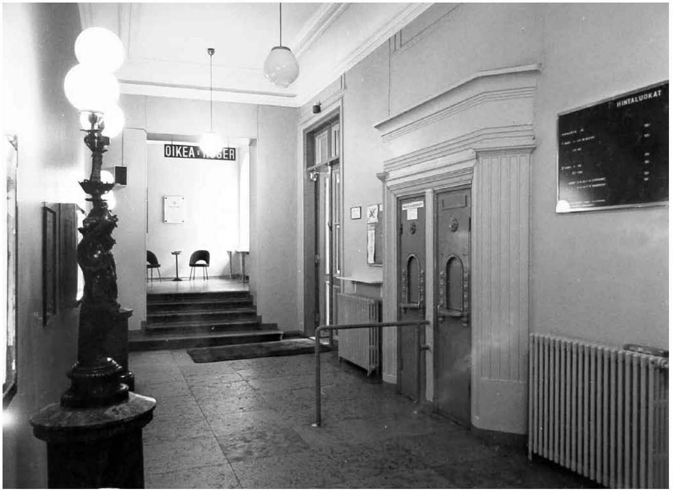
Sisäntulohalli vuonna 1978 ennen peruskorjauksen alkamista. Hakli/SKO
