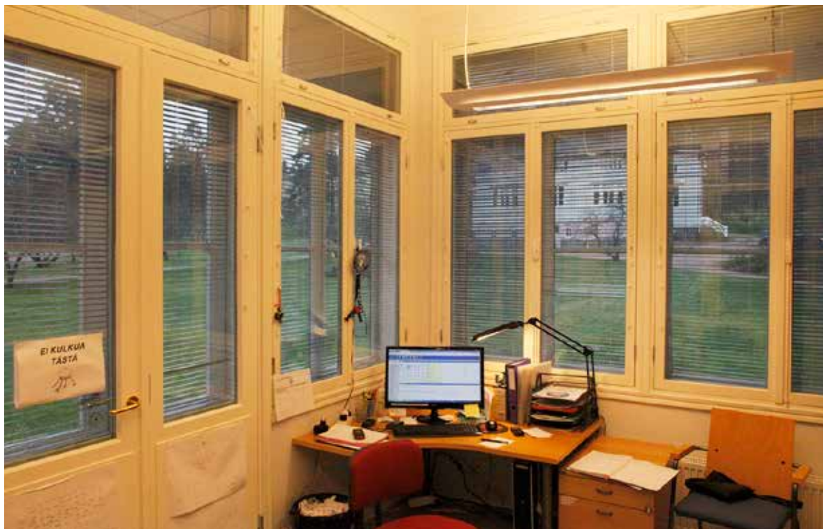
Kaakkoispään kylmä kuisti lämmöneristettiin ja muutettiin päivystyshuoneeksi vuonna 2013.
