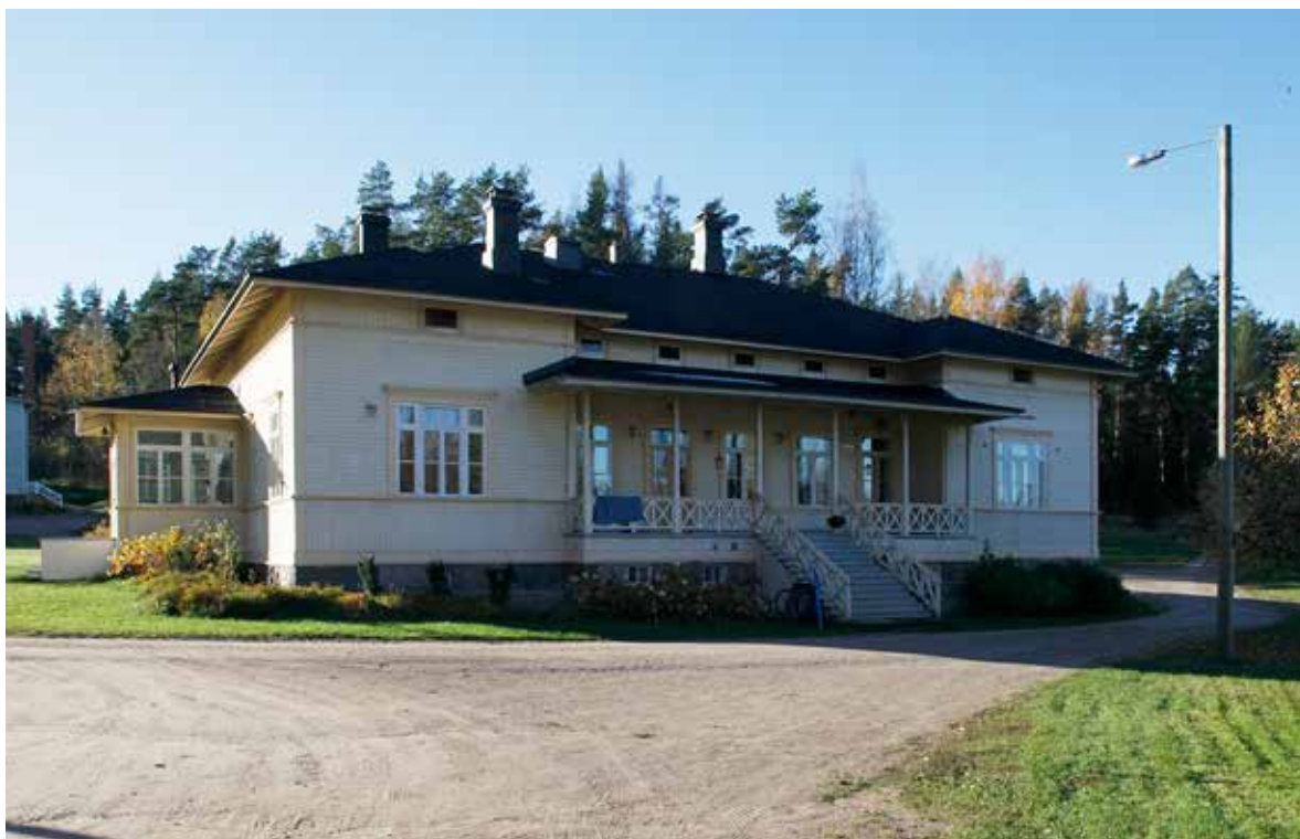
Vanhalan pääjulkisivu koilliseen on symmetrinen ja sen keskellä on avokuisti.
