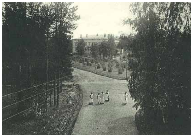
1900-luvun alun kuva kohti Opistolan itäjulkisivua. Vuosisadan alussa heinää nostettiin seipäille myös pihan nurmialueilta, kun kaikki mahdollinen viljelysmaa pyrittiin hyödyntämään. VKA.
