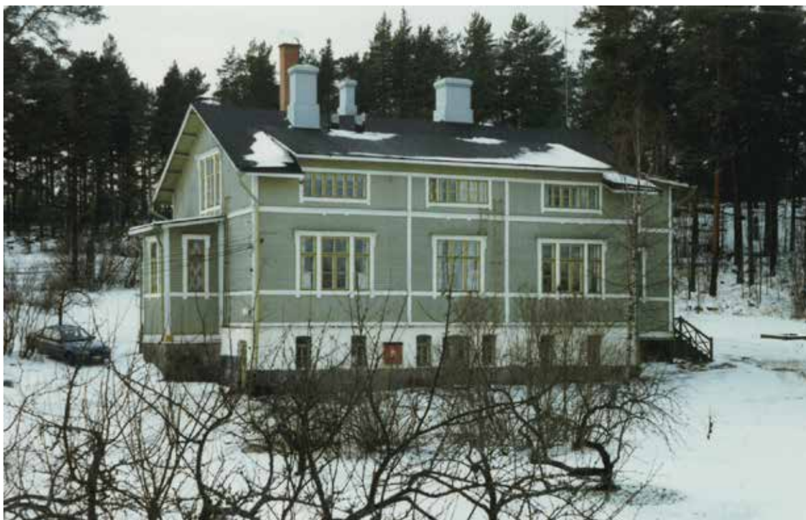
Miehelän rakennus 1980-luvulla. Seinät olivat tällöin vihreitä. Ullakkokerroksen ikkunat on uusittu ja kattolippa rakennettu vuoden 1963 muutostöissä.VKA.
