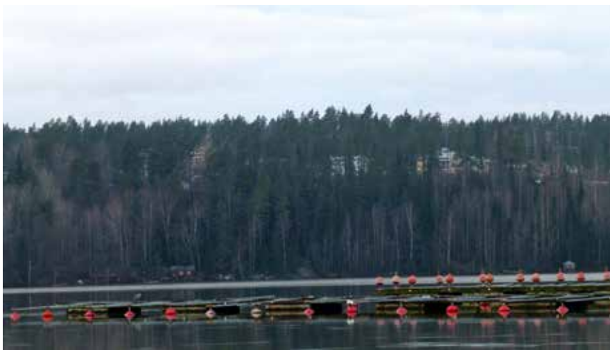
Vuorelan koulukoti sijaitsee jyrkän kallion päällä komealla paikalla. Rannassa vasemmalla on pumppuhuone, venevaja ja rantasauna. Uimahuone on kuvassa oikealla. Kuva on otettu Hiidenrannan venerannasta.
