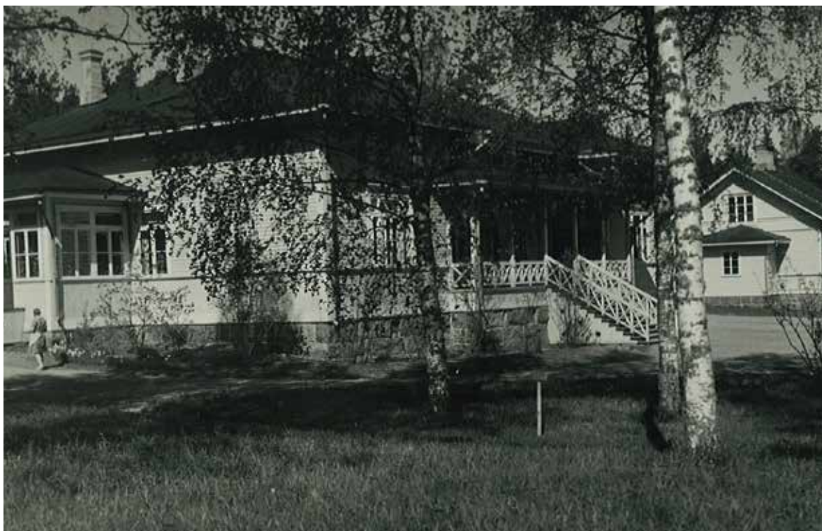
Vasemmalla Vanhala, taustalla Hissula, joka toimi leipomo- ja pesularakennuksena. Kuva on otettu viimeistään 1950-luvulla, jolloin taustalla näkyvä Hissula purettiin.VKA.
