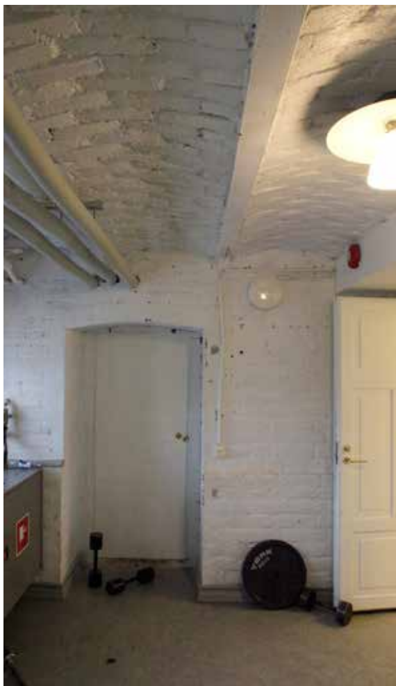
Miehelän kellarikerroksen katossa on tiiliholvit ja rautakiskot. Kellarissa sijaitsevat varasto- ja teknisten tilojen lisäksi saunatilat.
