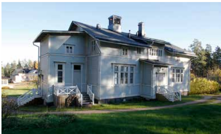
Miehellä julkisivu koilliseen.
