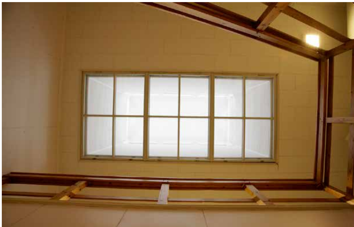
Näkymä porrashallista kohti kattolyhtyä, jota on muutettu vuonna 1959.
