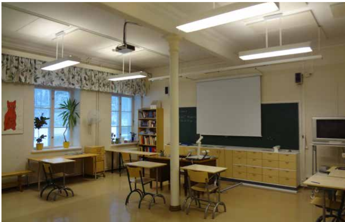
Ensimmäisen kerroksen luokkahuone on muodostettu jakamalla alun perin tyttöjen makuusalina toiminut huone väliseinällä kahtia. Huonetila on alun perin toiminut lasten makuusalina. Alkuperäiset rautapylväät ovat säilyneet.
