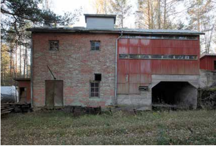
Julkisivu koilliseen. Rakennusta on laajennettu 1970-luvulla.
