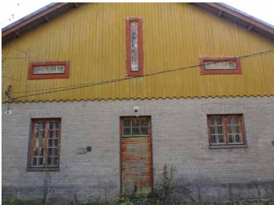
Navetan pääty koilliseen lokakuussa 2014. Koillispääty oli sommittelultaan melko symmetrinen. Ensimmäinen kerros oli tiilestä. Ikkunat olivat alkuperäisiä puisia ruutuikkunoita. Julkisivussa oli vanhoja ilmanvaihtoritilöitä. Ullakon seinässä oli pystylautaverhoilu, jonka alareuna oli hammastettu.
