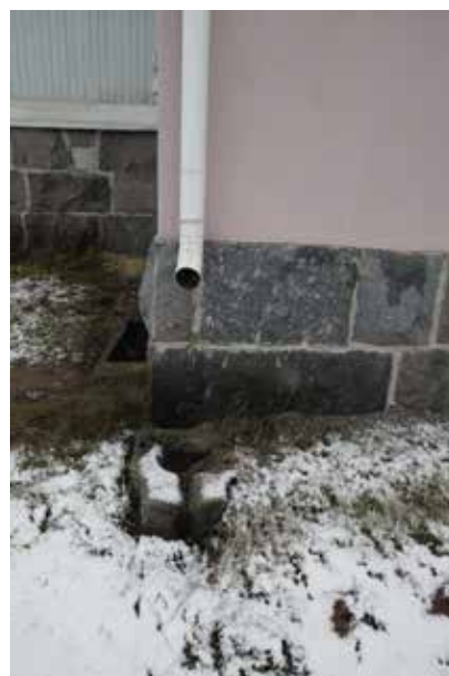
Miehellä sokkeli on ladottu graniittikivistä. Sokkelin yläpuolinen osuus kellarin seinästä on rapattu ja maalattu.
