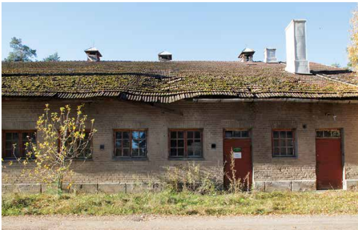
Lokakuussa 2014 otetusta kuvasta näkyy, että navetan tiilikatteinen harjakatto oli osittain romahtanut rakennuksen sisään. Piiput olivat eri-ikäisiä.
