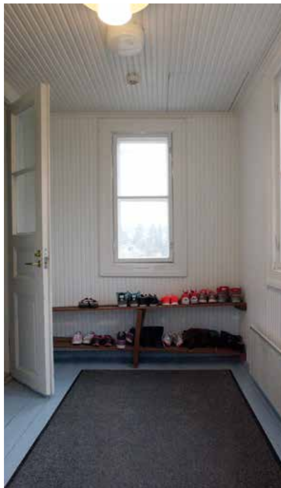
Eteisen (01) puupanelointi on alkuperäistä.
