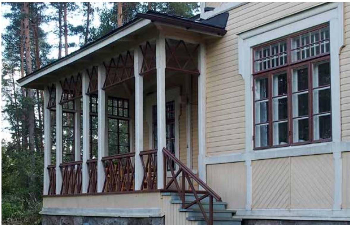
Johtolan kulmassa on järvelle päin avautuva avokuisti.
