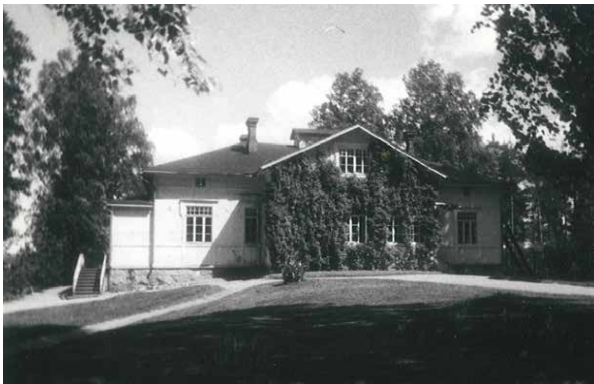
Johtolan sisäänkäynnin yhteydessä on kasvanut aiemmin runsaasti villiviinejä. Kuva on otettu ennen ullakon ja koillispuolelman muutostöitä, jotka tehtiin vuonna 1965.VKA.
