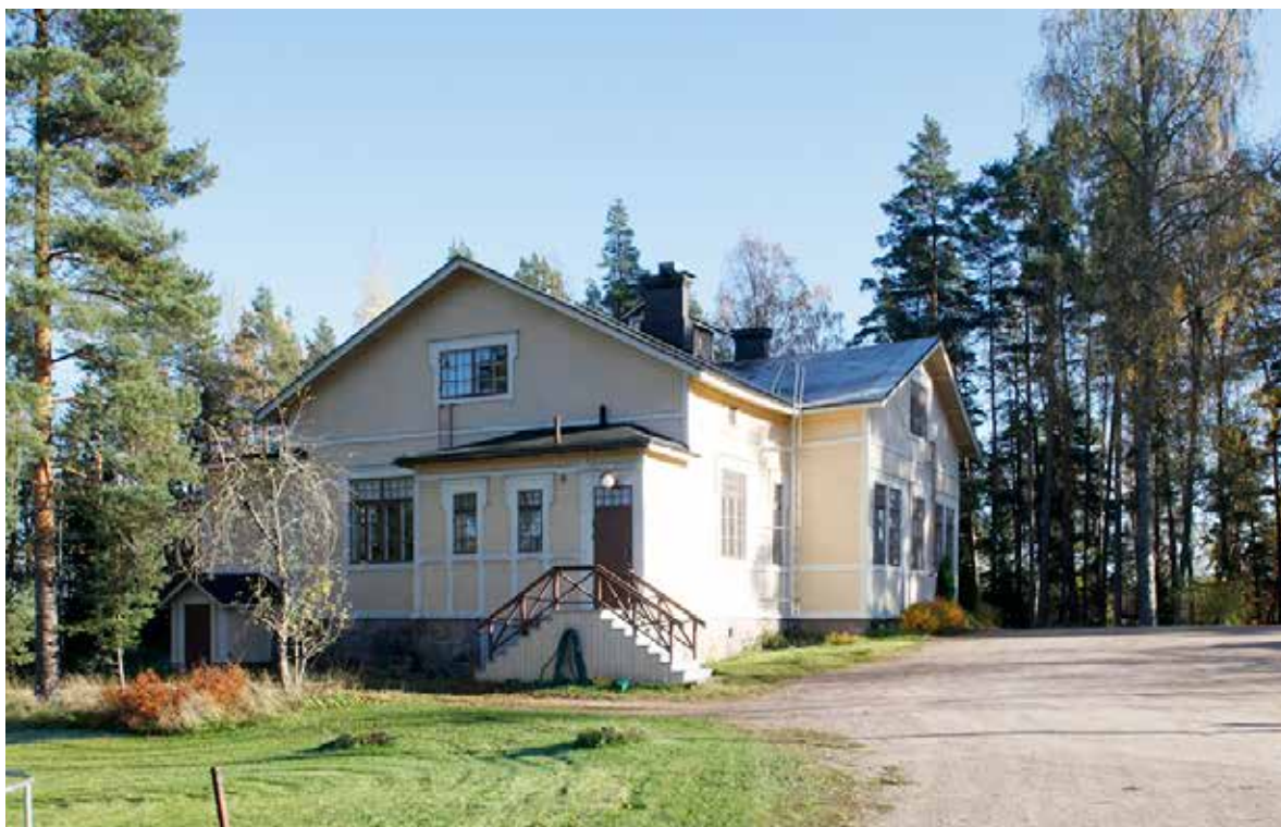
Johtolan päätyjulkisivu luoteeseen. Päädyn aumakatto on muutettu harjakatoksi ullakkomuutostöiden yhteydessä.
