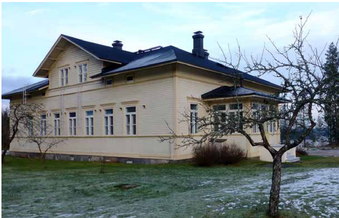
Vanhalan aumakaton peltikate vaihdettiin vuonna 1996 bitumikermikatteeksi. Lounaan puolella katolla on poikittainen harjakatto.
