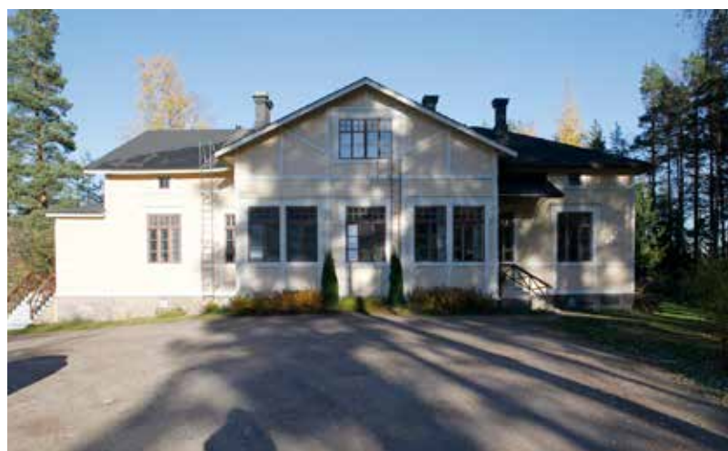
Johtolan pihan puoleinen julkisivu nykyasussaan.
