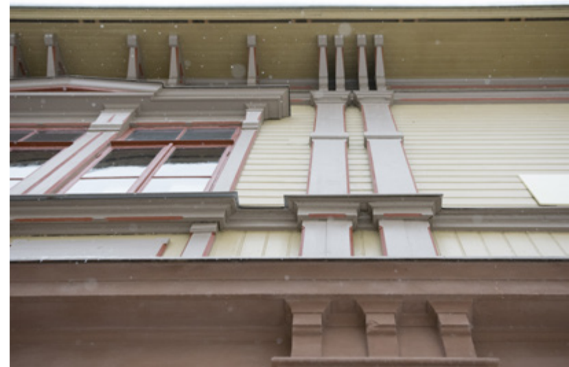
Toisen kerroksen puujulkisivujen voimakasta, uusrenessanssityylistä reliefiä.
