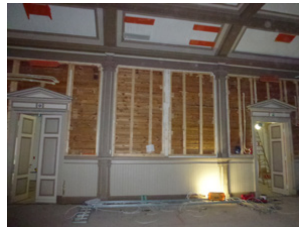
Toisen kerroksen salin sei-niä paljastettuina 2013, kun raken-nusta viimeksi perusteellisemmin korjattiin.
