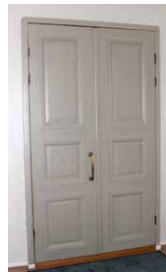
Tuulikaapin paripeiliovi (A-siipi 126) on mahdollisesti myöhempi lisäys. Ovi karmenteen työntyy ulos seinäpinnasta. Vetimet ovat messinkiä.
