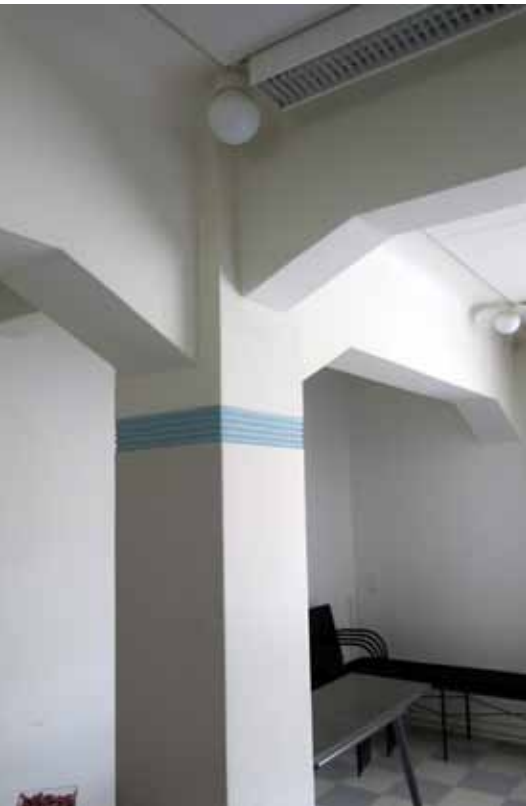
Ahrenbergin siiven alkuperäisiä betonipilari- ja palkki-rakenteita on parhaiten näkyvissä opetustilassa I14A.
