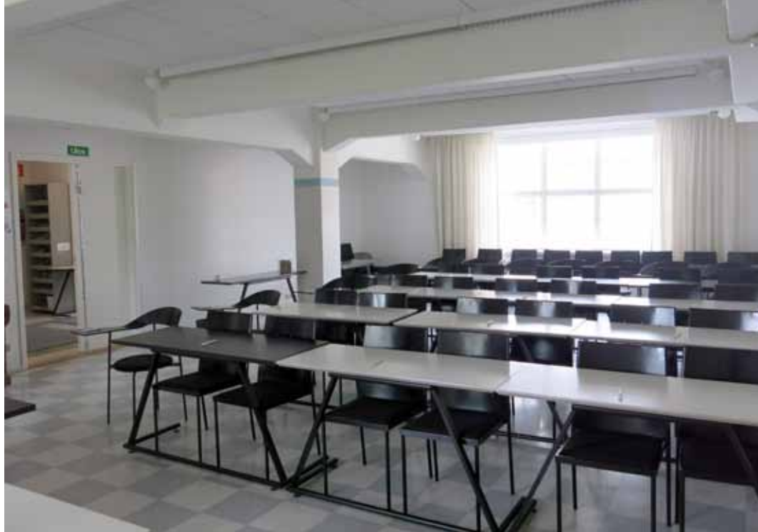
Opetustilassa 114 A on näkyvissä alkuperäiset betonipilarit palkistoinen.
