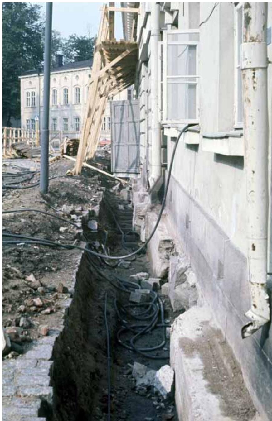
B-siiven perustustyöt käynnissä 1976. Koskinen/MV
