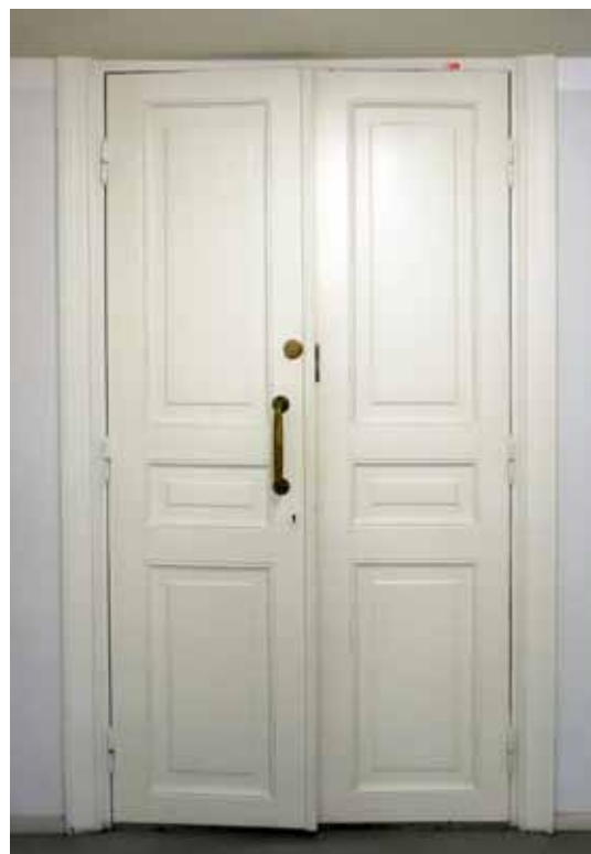
Peiliovet (A-siipi 200, 212) Tilan 200 todennäköisesti alkuperäinen ovi on siirretty nykyiseen paikkaansa 1990-luvulla. Ovia kehystävät profiloituneet ovilistat ja niissä on messinkivetimet. Tilan 212 taittava neliosainen pariovi on ilmeisesti peräisin 1920-luvulta.
