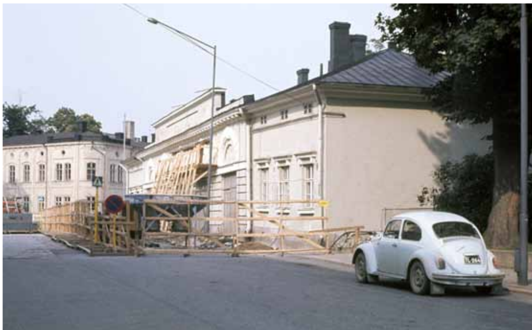
Peruskorjauksen aikaisia kuvia Maa-herran makasiinista vuodelta 1976. Yläkuvassa tehdään B-siiven perustustöitä ja alakuvassa pihajulkisivun muutos- ja uudelleenrappaustöitä. Koskinen/MV
