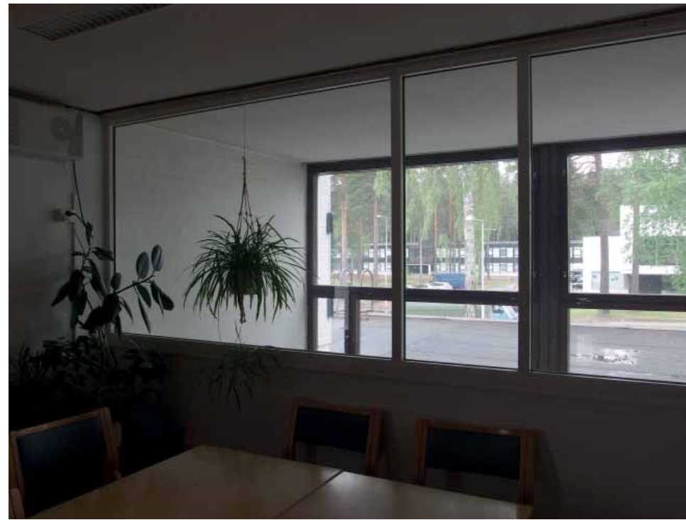
Rakennuksen eteläpäässä valokuilu on varustettu ikkunoilla.
