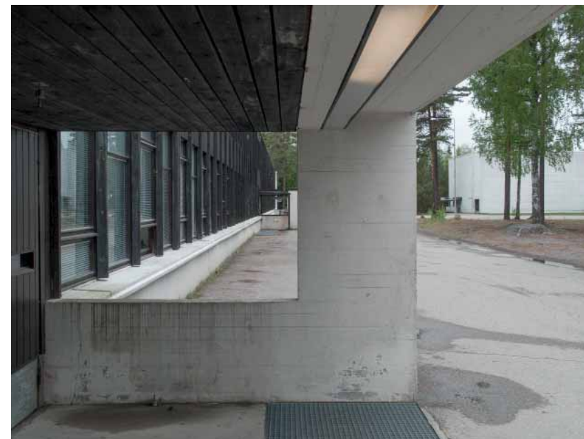
Kasarmin betoniset sisäänkäynnit ovat arkkitehtonisesti tärkeä aihe. Valaistus on hoidettu etuosassa olevan betonirakenteen alapinnassa olevalla loistevalaisinnauhalla.
