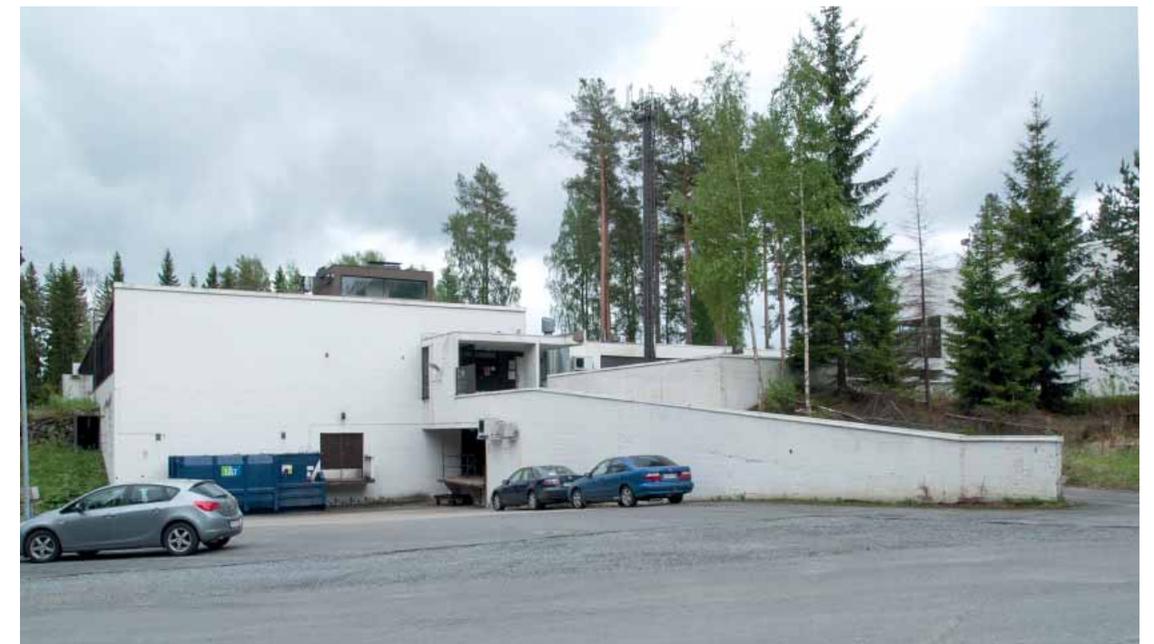
Ruokalarakennuksen länsipääty, josta tapahtuu keittiön huolto.
