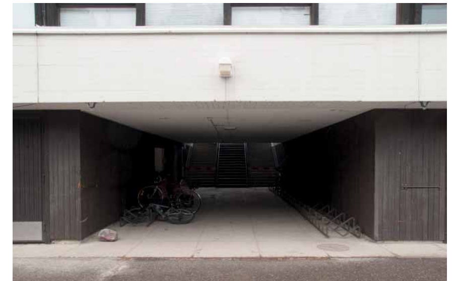
Toinen pohjakerroksen tasolta sisäpihalle johtavista käytävistä.
