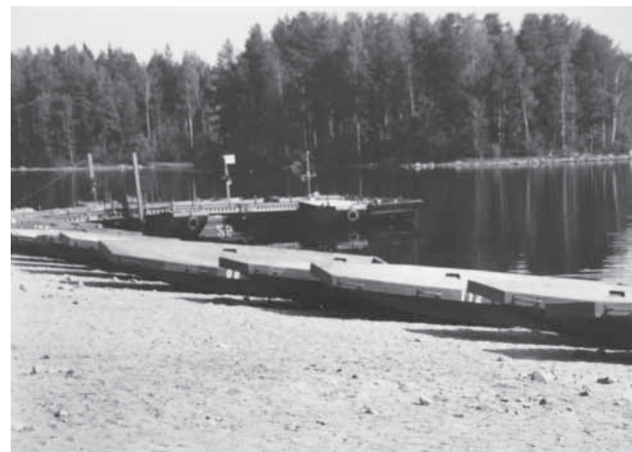
Pioneerirykmentin kalustoa vesistökalustovaraston edustalla. Yläkuvassa näkyy rakenteilla oleva Vesistökalustovarasto. Kuvat: Puolustusvoimat
