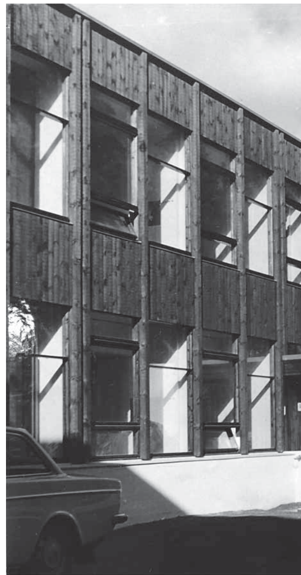
Kasarmien julkisivujen ikkunajakoa ja ruodesysteemiä. Oikeanpuoleisessa kuvassa julkisivua vasta valmistuneena vuonna 1967. Julkisivujen kaikki puuosat ovat painekyllästettyjä. Kuvaushetkellä puuosia ei ehkä vielä ollut käsitelty tummanruskeiksi. (Pioneerirykmentin kokoelmat; osa kuvasta)
