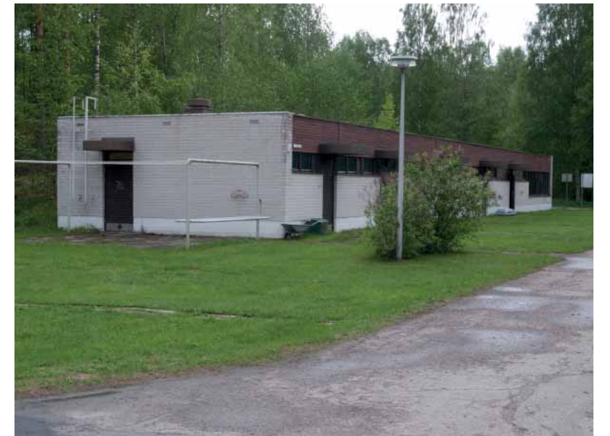
Huoltorakennuksen kahitiilipäädyt ja muuntamon betoniseinät antavat rakennukselle kubistista hahmoa.
