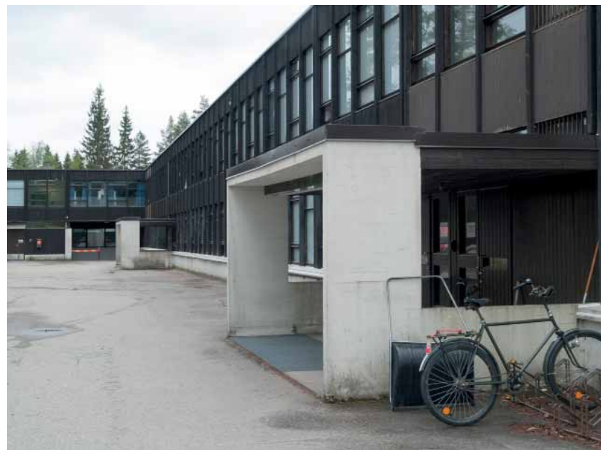
Kasarmin betoniset sisäänkäynnit ovat arkkitehtonisesti tärkeä aihe. Valaistus on hoidettu etuosassa olevan betonirakenteen alapinnassa olevalla loistevalaisinnauhalla.
