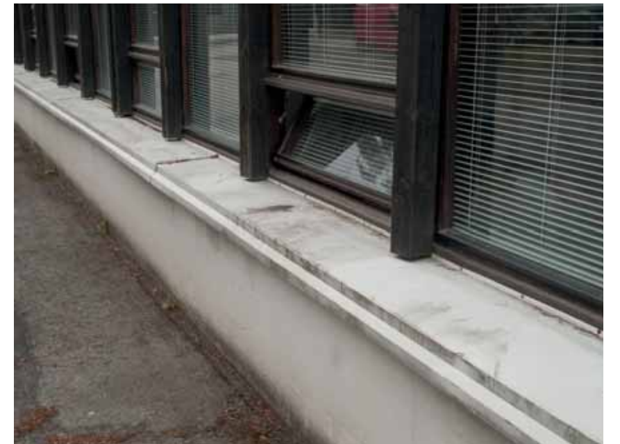
Betonisokkelit on vedetty ulos julkisivulinjasta huomiotaherättävän paljon. Varsinainen kantava runko on kuitenkin sisäpuolella, jossa ikkunoiden alapuolinen betoniseinämä yhdistyy pilarirunkoon.
