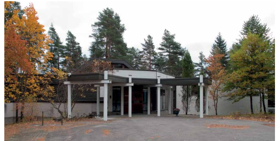
Viikinhovin pääsisäänkäynti syyskuun lopussa 2014, jolloin rakennus oli siirtynyt jo hotelliyrittäjän omistukseen. Alun perin sisääntulokatoksen puurakenteet oli käsitelty samalla tavalla tummiksi kuin muutkin puurakenteet.
