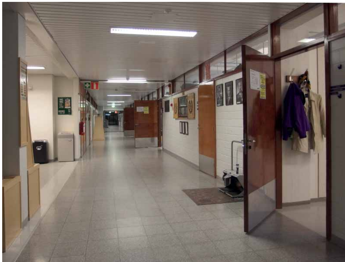
Rakennusten sisätiloissa hallitsevia ovat vaaleat sävyt: kasarmien käytävien lattioissa on mosaiikkibetoni, seinät ja lautakatot on maalattu valkoisiksi, tuvissa on vaaleat, vihertävänharmaat Finnflex-lattiat. Ovien ja ikkunoiden petsilakatut puuosat tuovat kontrastia värimaailmaan.
