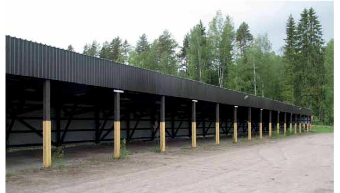
Katokset 303 ja 304 ovat alueen varhaisimpia autosuojia. Kantavat rakenteet ovat puuta. Alunperin katteena ja verhouksena oli sinkitty aaltopelti.
