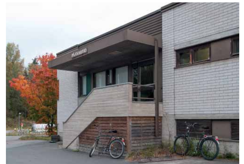
Päävartion porras katoksineen rakennuksen länsisivulla.
