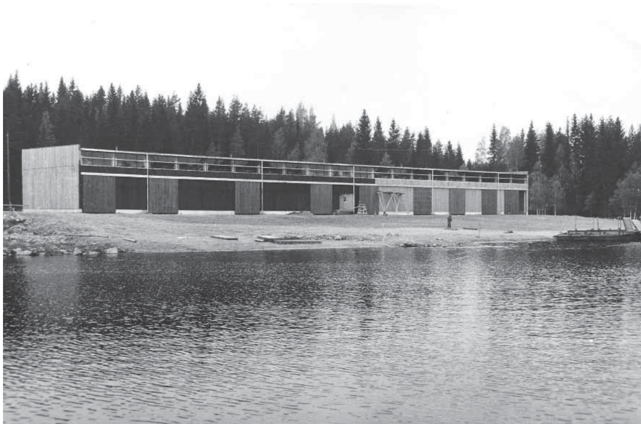
Vesistökalustovarasto valmistui vuonna 1970. Kuva: Puolustusvoimat.
