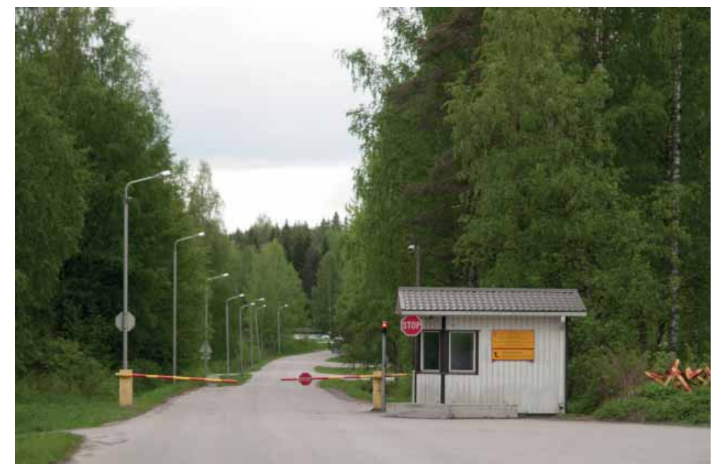
Pioneerirykmentin nykyinen pääportti ja vahtikoppi.
