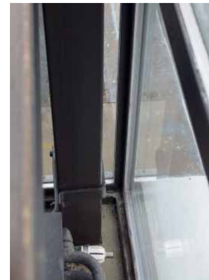
Suurten lasipintojen karmirakenteet ovat muista rakennuksista poiketen terästä. Pyrkimyksenä on ollut rakenteiden visuaalinen keveys.
