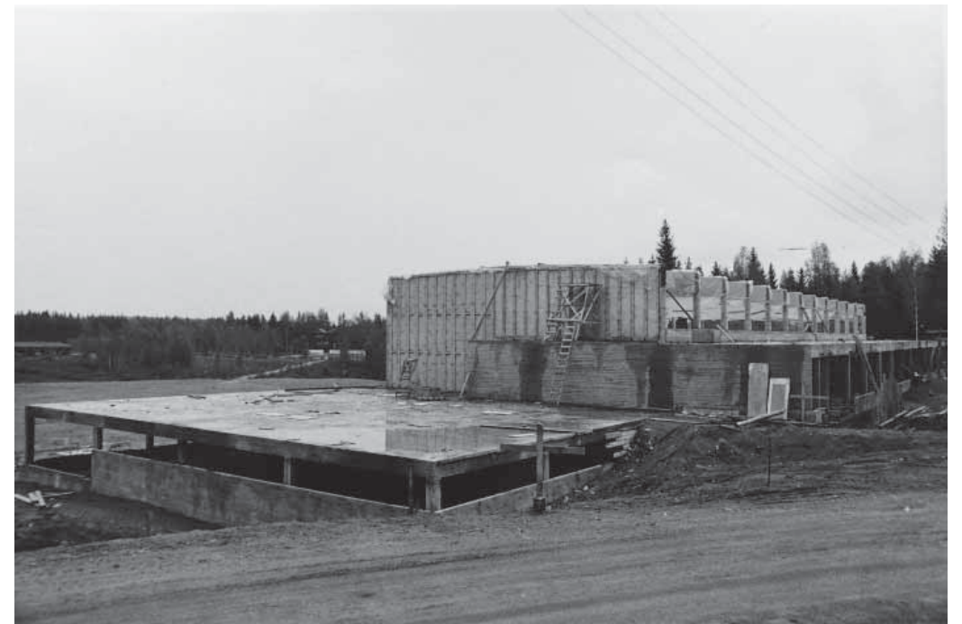
Kuntotalo rakennusvaiheessa vuonna 1971. Kuva: Puolustusvoimat.
