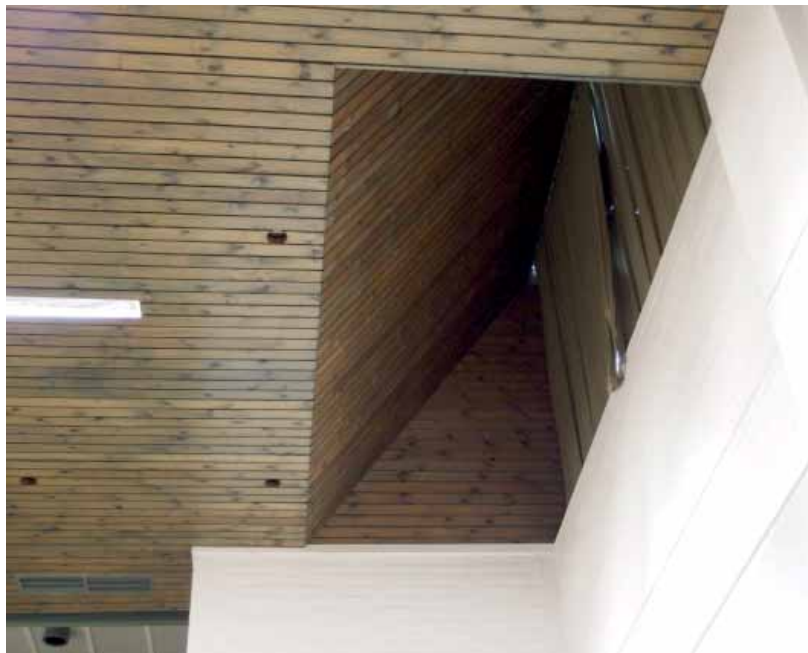
Salin yläikkunan kuilu (ikkunan verhot suljettuina). Salin katot on verhottu höylätyllä, vihertäväksi petsilakatulla paneelilla.
