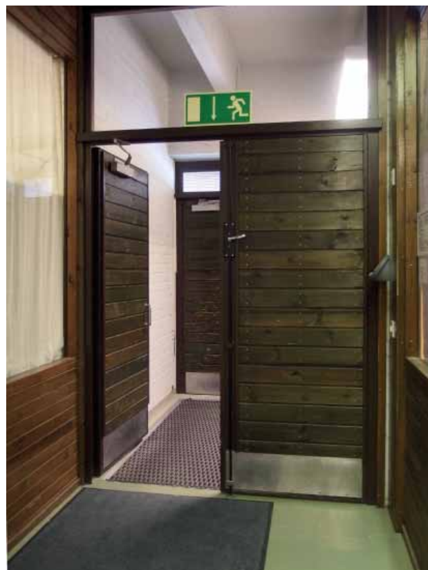
Korjaamon (1987) petsilakattuja sisäovia ja -ikkunoita. Lattioissa on vihreät Finnflex-laatat.
