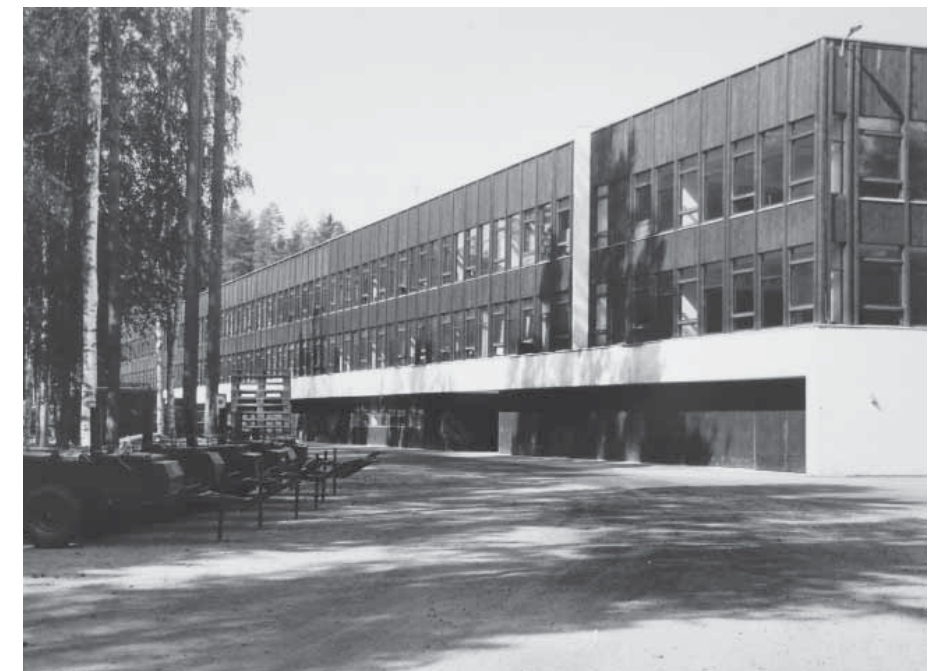
Rakennuksen eteläsivua 1970-luvulla. Julkisivussa näkyvä valkoinen pystyosa on ensimmäisen ja toisen rakennusvaiheen saumakohta.
