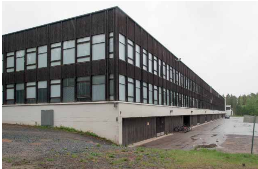
Kasarmirakennuksen lounaiskulma, jossa ikkunanauhat jatkuvat kulman ympäri. Betonisokkeli jatkuu eteläsivulla pohjakerroksen ovia suojaavana palkkina, joka samalla on arkkitehtonisesti tärkeä aihe (vrt. esim. Elokuvaluokan katos).
