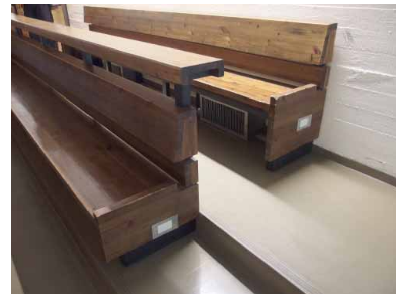
Elokuvaluokassa (1973) toistuvat samat perusmateriaalit kuin muuallakin: karkeat, valkoiseksi maalatut betonipinnat, Finnflex-lattiat. Sisäkatoissa on laadukkaampi höylätty ja petsilakattu paneeli. Yläkuvassa katsomon on massiivisia, petsilakattuja mäntypenkkejä.
