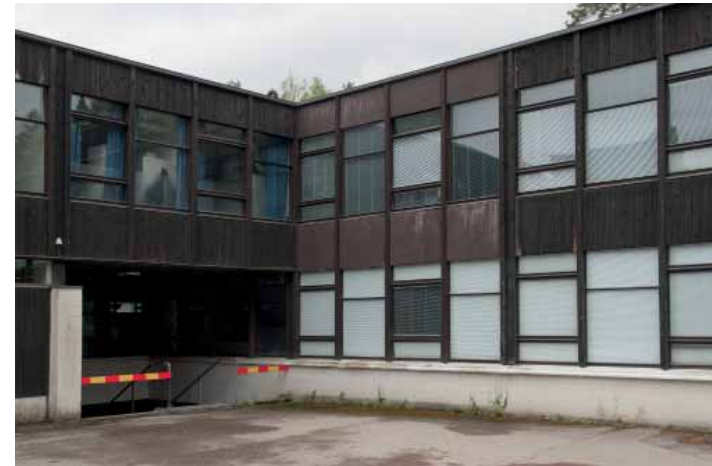
Ikkunanauhat liittyvät sisäkulmassa toisiinsa (Kasarmi 1).
