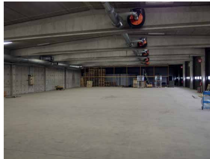
Hallien kattorakenteet ovat aiemmista vastaavista rakennuksista poiketen kokonaan betonia: esijännitetyt betonipalkit kannattavat vesikatteen alusrakenteena olevia ontelolaattoja.
