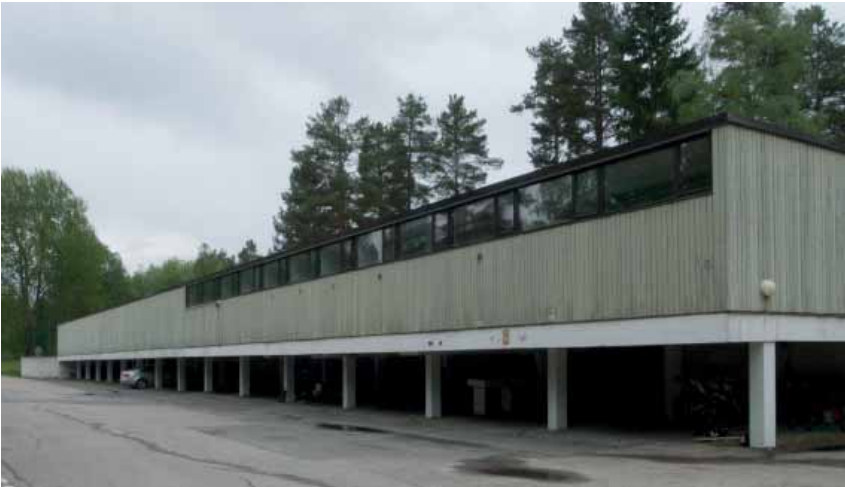
Huoltorakennus etelästä: rakennuksen alakerta toimii autokatoksena. Ylempää kerrosta kannattava valkeaksi maalattu betonirakenne pilareineen toimii vahvana arkkitehtonisena aiheena.
