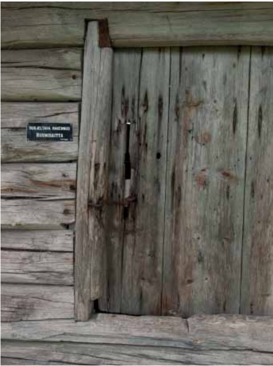
Sisäänpäin aukeava, pihtipielinen ovi.
