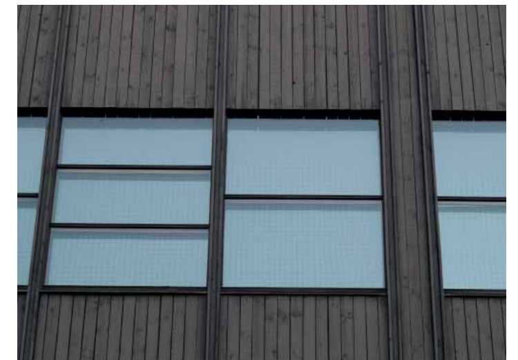
Kuntotalon pohjoissivua, jossa puuverhousta rytmittävät ruodeparit, kuten useissa muissakin varuskunnan 1960-70-lukujen rakennuksissa.
