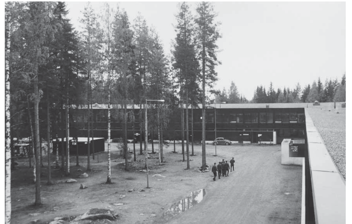
Kasarmi 1 1970-luvulla kuvattuna länsisiiven katolta. Piha-alue oli alkuun asfalttomaton. Kuva: Puolustusvoimat.
