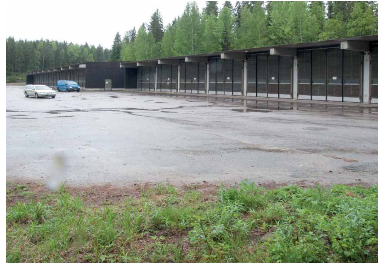
Ponttonivarasto eli ns. ABC-halli sen ja vesikalustovaraston välissä olevan kentän puolelta. Parisataametristä rakennusta rytmittävät keskimmäisen osan ulosveto muiden rintamasta ja osien välissä ovat poukammat, joihin on sijoitettu ilmakeivaimien konehuoneet (kuva alla).
