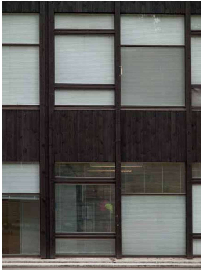
Kasarmien julkisivujen ikkunajakoa ja ruodesysteemiä. Oikeanpuoleisessa kuvassa julkisivua vasta valmistuneena vuonna 1967. Julkisivujen kaikki puuosat ovat painekyllästettyjä. Kuvaushetkellä puuosia ei ehkä vielä ollut käsitelty tummanruskeiksi. (Pioneerirykmentin kokoelmat; osa kuvasta)
