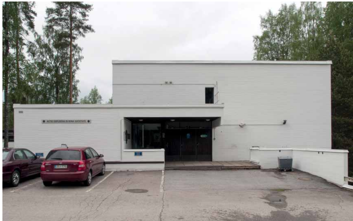
Esikunnan funkishahmoinen eteläpääty, jossa on rakennuksen pääsisäänkäynti.
