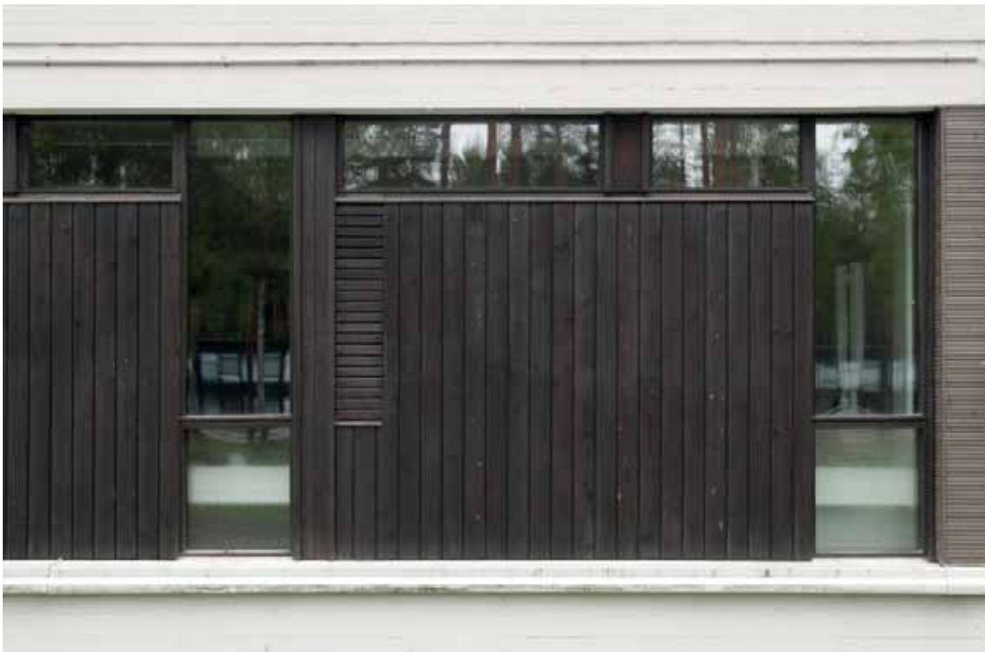
Poliklinikan julkisivujen jäsentely on vapaampaa kuin kasarmien varhaisemmissa rakennuksissa. Ikkunoiden sijoittelu liittyy osittain myös huoneiden käyttötarkoitukseen - näkyvyyttä ulospäin on rajoitettu.
