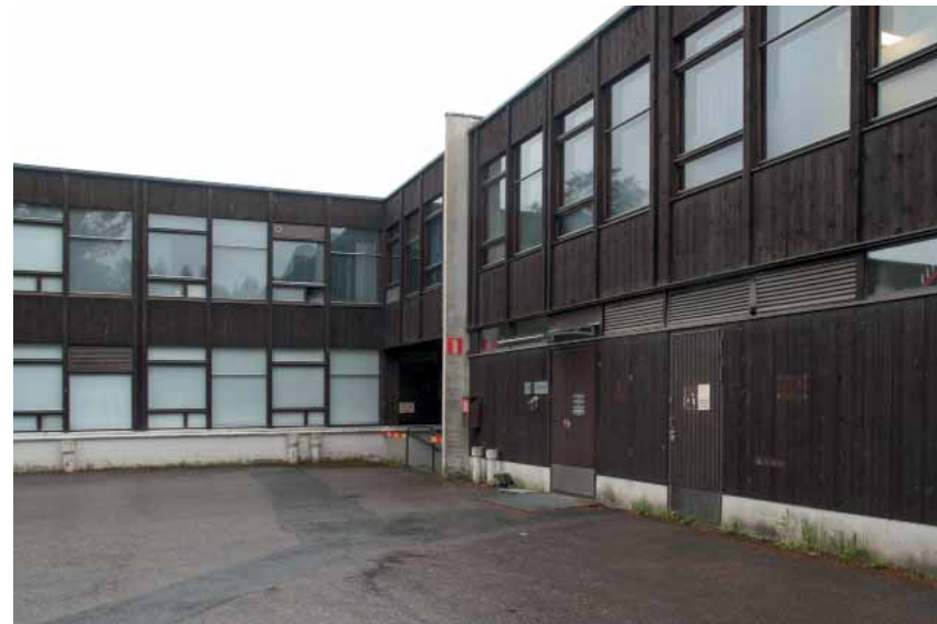
Kasarmi 1:n ja 2:n liittymäkohta sisäpihan kaakkoiskulmassa. Julkisivussa erottuva pystyosa on ensimmäisen rakennusvaiheen pääty, joka on jätetty palomuuriksi osien välille.
