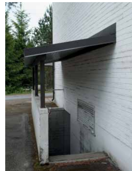
Rakennuksen eteläpäädyssä olevan, IV-konehuoneeseen johtavan portaan suojaksi on myöhemmin lisätty katos.
