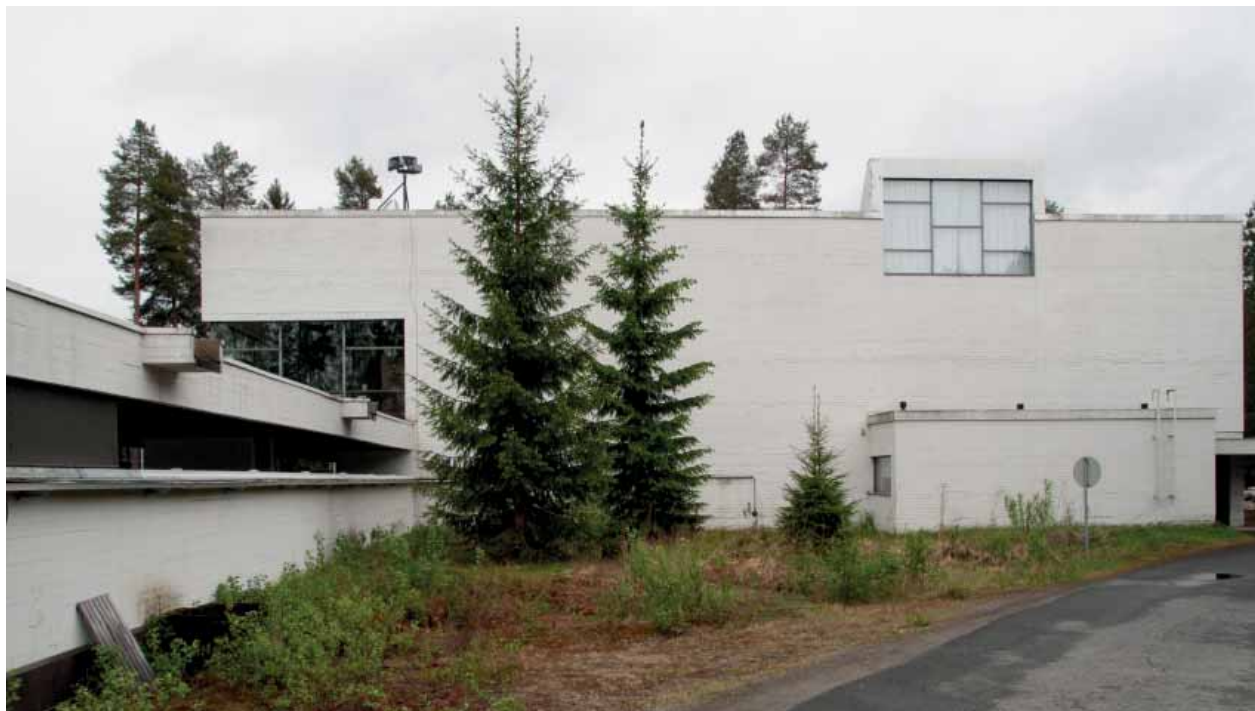
Rakennuksen pohjoissivu. Vasemmalla Elokuvaluokan Ruokalaan yhdistävä katos, jonka suojana on betoninen muuriaihe. Huomaa katoksen vedenheittäjät.
