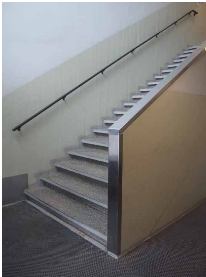
Portaiden materiaalit ovat karun tarkoituksenmukaisia, kuten maalattua betonia, mosaiikkibetonia ja ruostumatonta terästä.
