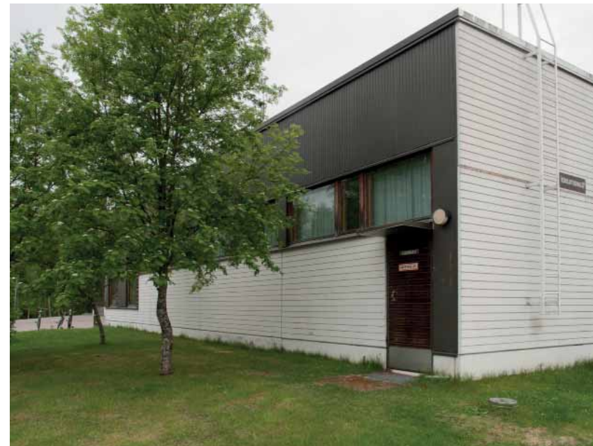
Rakennuksen koilliskulma. Oikealla uritettua betonielementti-seinää.
