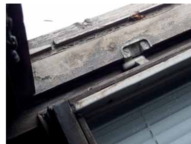
Kasarmeissa on kaksinkertaiset, sisään-päin aukeavat ikkunat.
