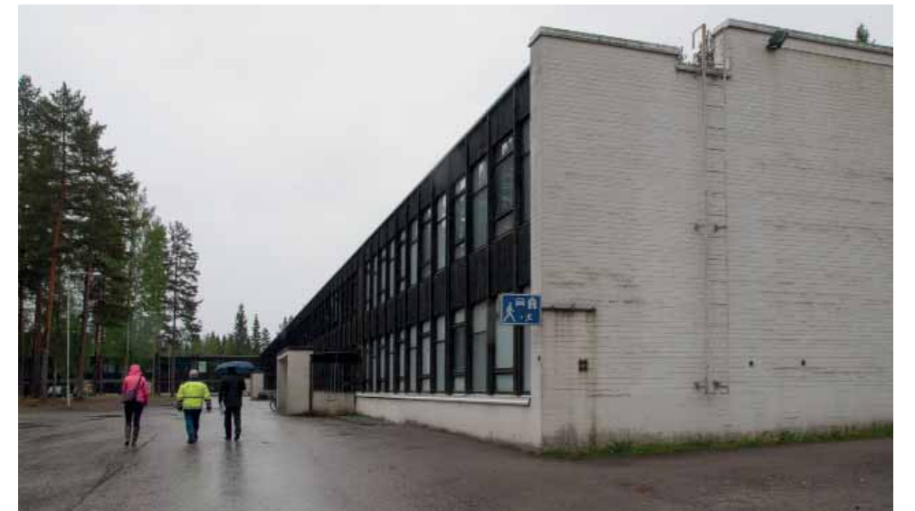
Kasarmi 1:n pohjoispäätyä. Päädyssä näkyvä muuriaihe porrastukseen on tehty vesikaton kallistusten naamioimiseksi. Julkisivuissa rakennus vaikuttaa täysin tasakattoiselta, vaikka tosiasiassa katto on kahteen suuntaan kalteva. Vedenpoisto tapahtuu sisäisesti katossa olevan kurun kohdalta.
