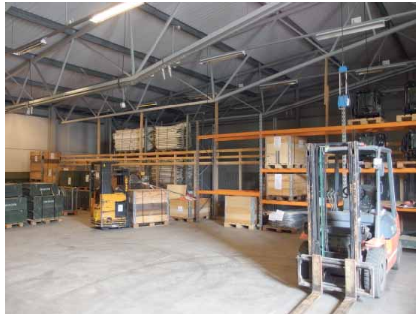
Varastosuojan kaikki kantavat rakenteet ovat terästä
