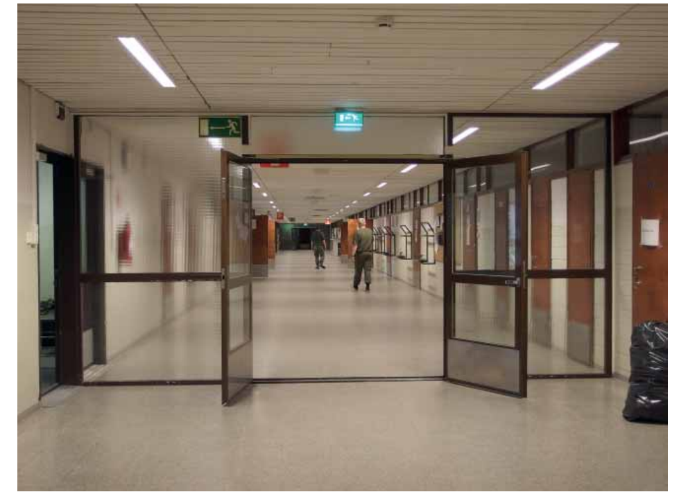
Teräskehysiset rautalankalasiovet on lisätty myöhemmin, kun oli tarpeen jakaa kerrostaso useammaksi palo-osastoksi.
