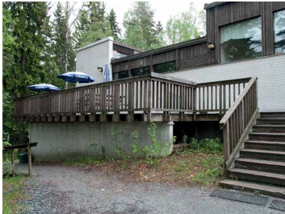
Sotilaskodin pohjoisseinustalle vuonna 1996 tehty terassi.
