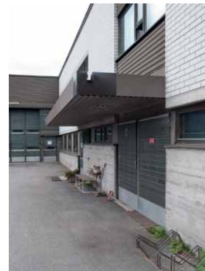
Autohallin pohjoissiiven julkisivua katoksineen.
