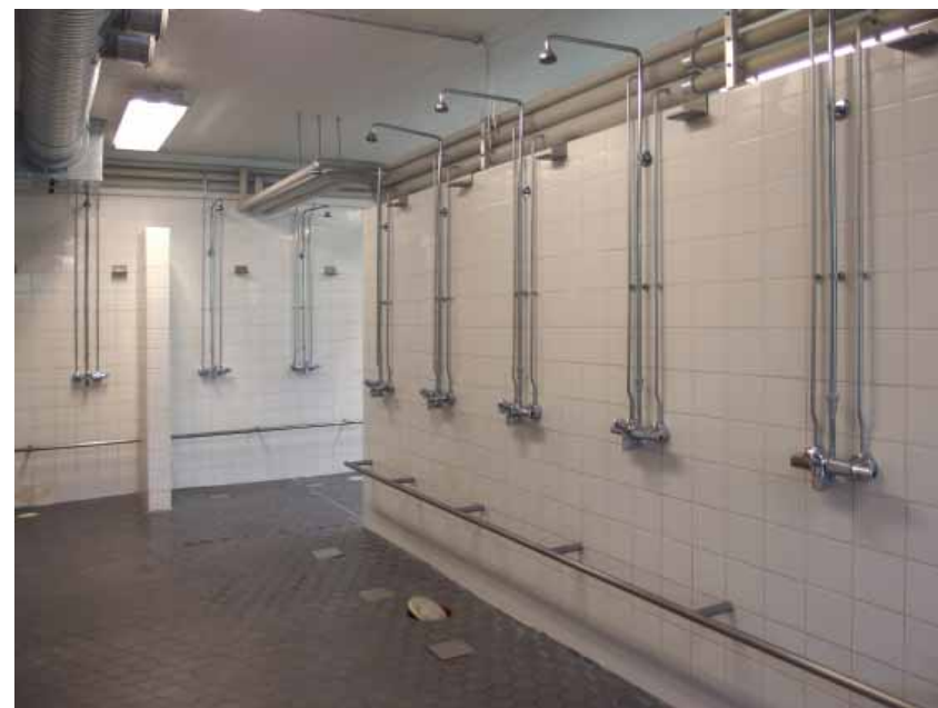
Uusittu saunaosaston pesuhuone.
