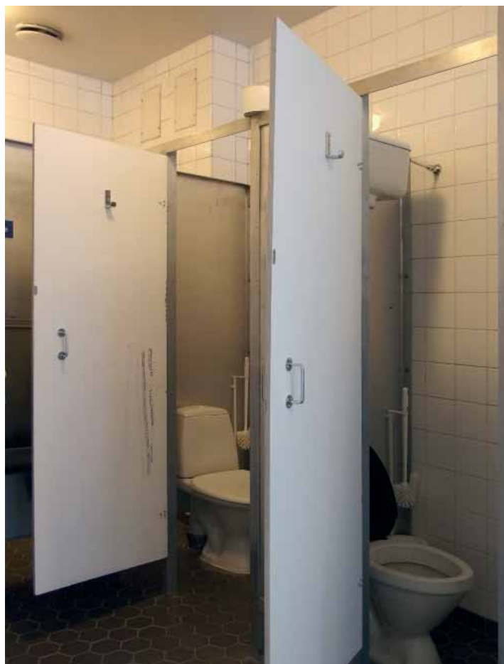
Kasarmien wc-tilat olivat alunperin ovettomia. Ovet lisättiin 1990-luvulla.
