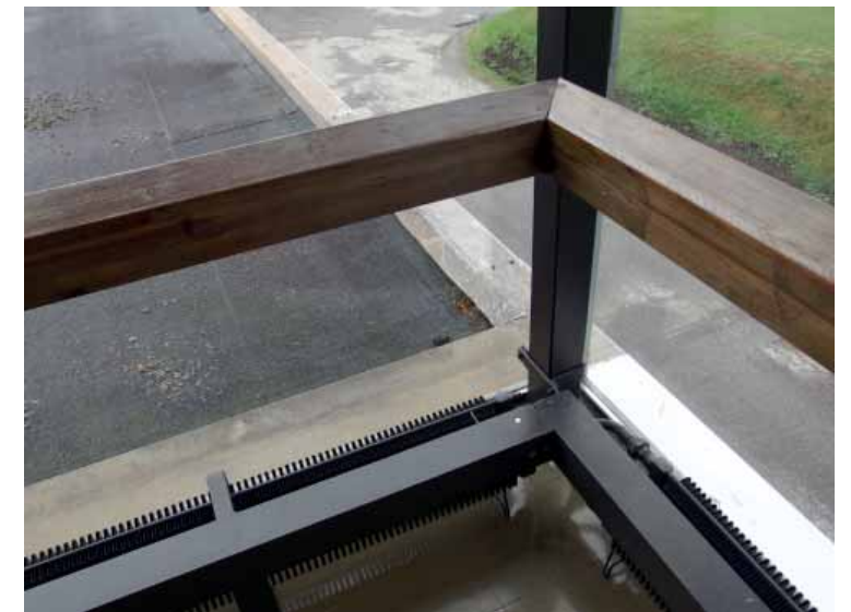
Suurten lasipintojen karmirakenteet ovat muista rakennuksista poiketen terästä. Pyrkimyksenä on ollut rakenteiden visuaalinen keveys.
