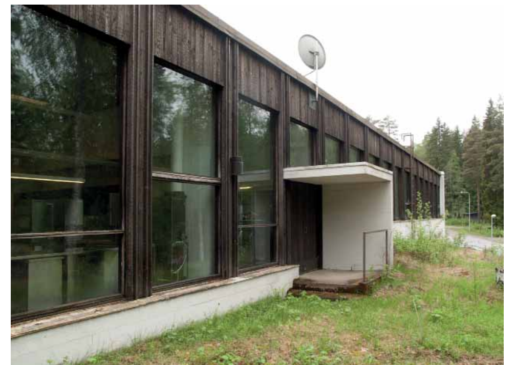
Ruokalan pohjoissivulla oleva betoninen sisäänkäyntikatos.
