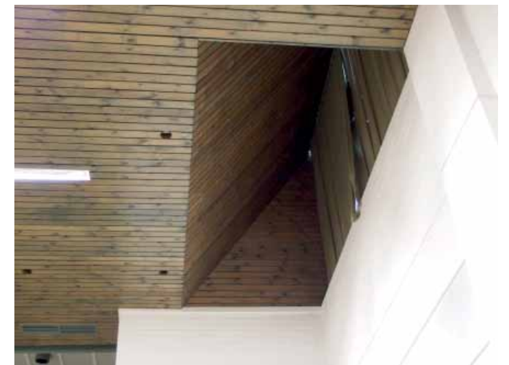
Elokuvaluokassa (1973) toistuvat samat perusmateriaalit kuin muuallakin: karkeat, valkoiseksi maalatut betonipinnat, Finnflex-lattiat. Sisäkatoissa on laadukkaampi höylätty ja petsilakattu paneeli. Yläkuvassa katsomon on massiivisia, petsilakattuja mäntypenkkejä.
