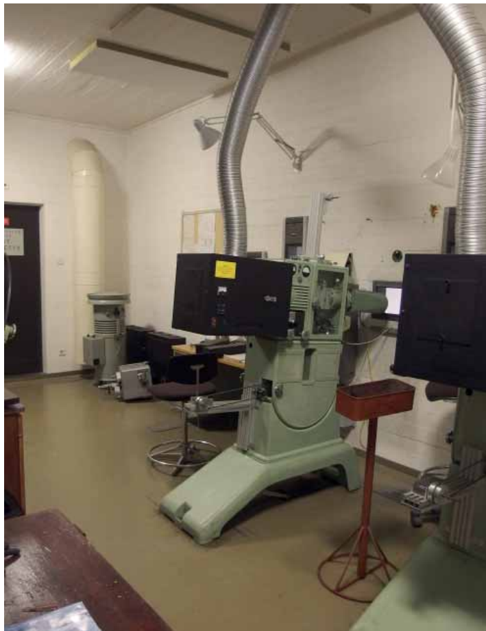
Elokuvakonehuone rakennuksen ylimmässä kerroksessa.
