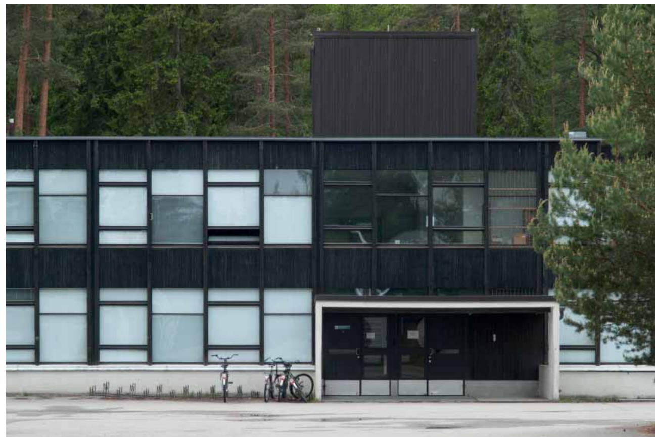
Kasarmi 1:n ulkoasua ovat eniten muuttaneet katoille 1990-luvulla tehdyt ilmanvaih- tokonehuoneet.
