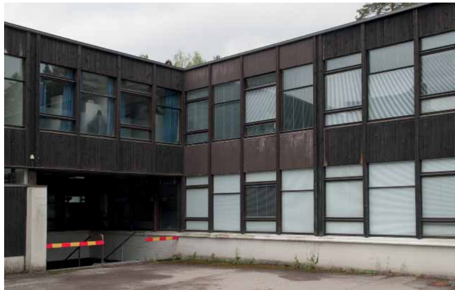
Kasarmi 1:n lounaiskulmaus sisäpihanpuolelta. Rakennuksen ali pohjakerroksen tasolle johtava käytävä vasemmalla.
