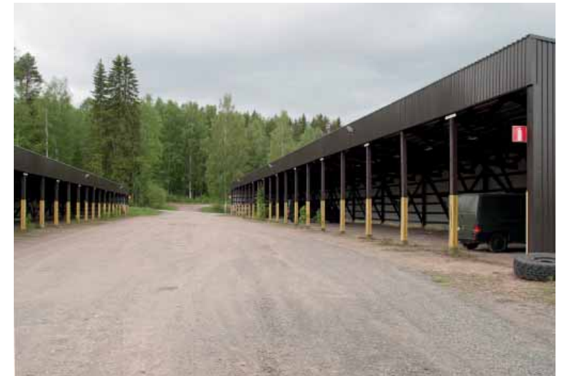
Katokset 303 ja 304 ovat alueen varhaisimpia autosuojia. Kantavat rakenteet ovat puuta. Alunperin katteena ja verhouksena oli sinkitty aaltopelti.
