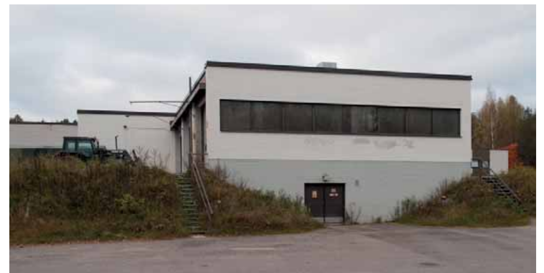
Rakennuksen itäsivu kellarin varastotiloihin johtavine ovineen.
