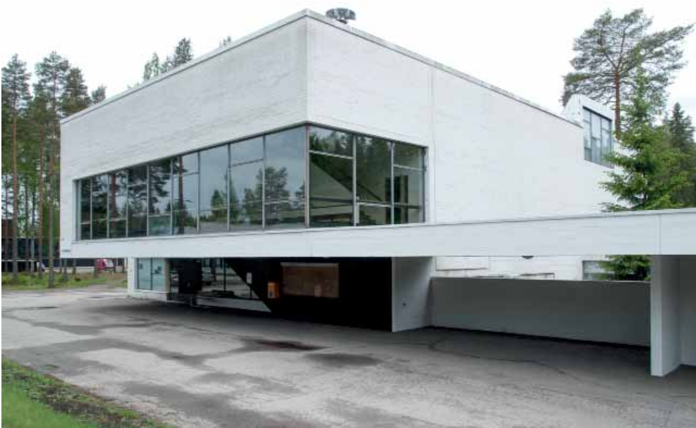
Elokuvaluokan etelä- ja itäisivuja. Kuutiomaista rakennusmassaa keventää ensimmäisen kerroksen voimakas sisäänveto ja toisen kerroksen lämpiön suuret ikkunat. Julkisivun alaosan palkki jatkuu reunapalkkina katokselle, joka yhdistää Elokuvaluokan Ruokalarakennukseen.
