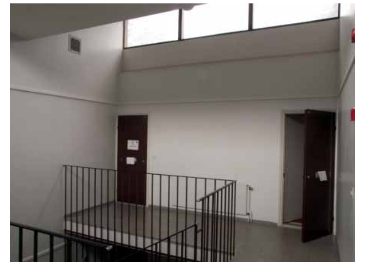
Porrashuoneisiin tulee valoa kattolyh- dyistä, jotka antavat myös omaleimai- suutta talojen ulkonäölle. Yläkuvassa kerrostaloryhmä pian talojen valmistu- misen jälkeen.
