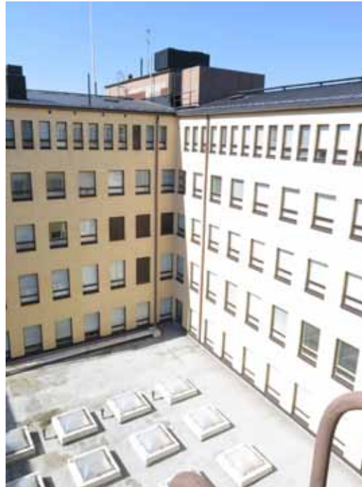
Sisäpihan puolella keltaiseksi maalattu tavanomainen rappaus, katupuolella terastirappaus.
