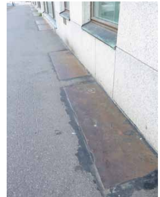
Sisäpihan puolella keltaiseksi maalattu tavanomainen rappaus, katupuolella terastirappaus.
