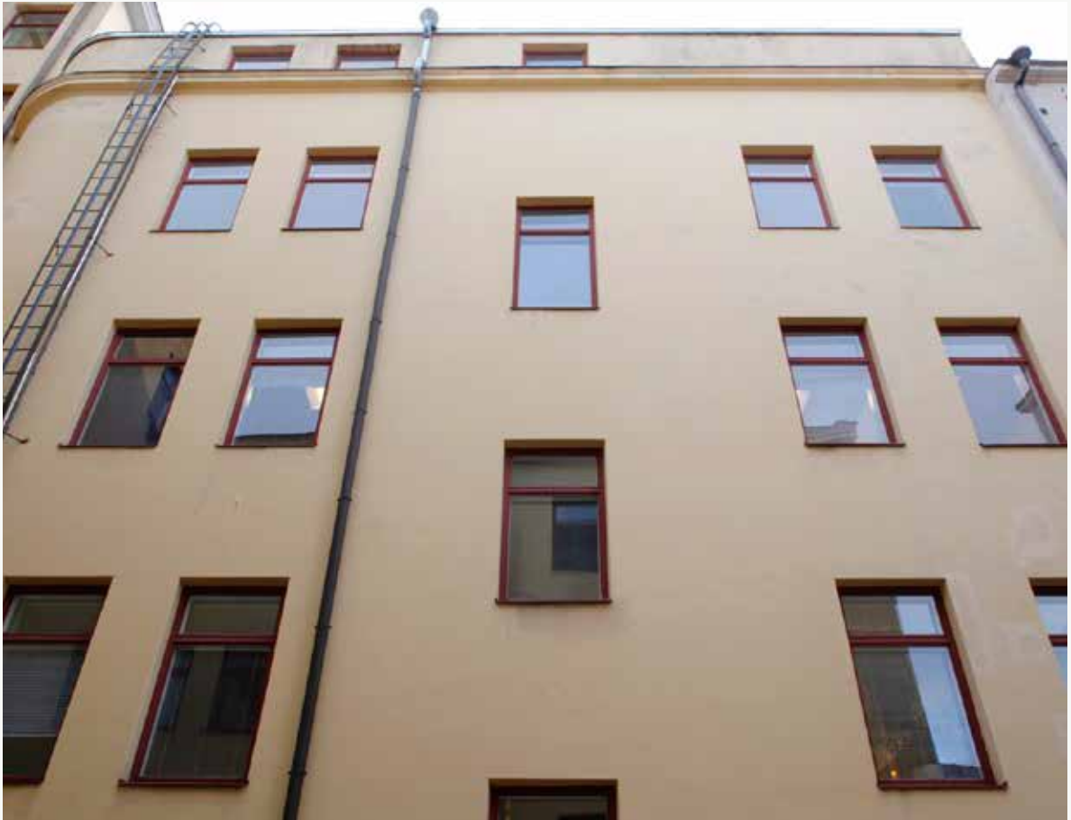
I3. Ratakadun siiven pihapuoleisen vesikaton lapetta korotettiin 1970-luvulla.
