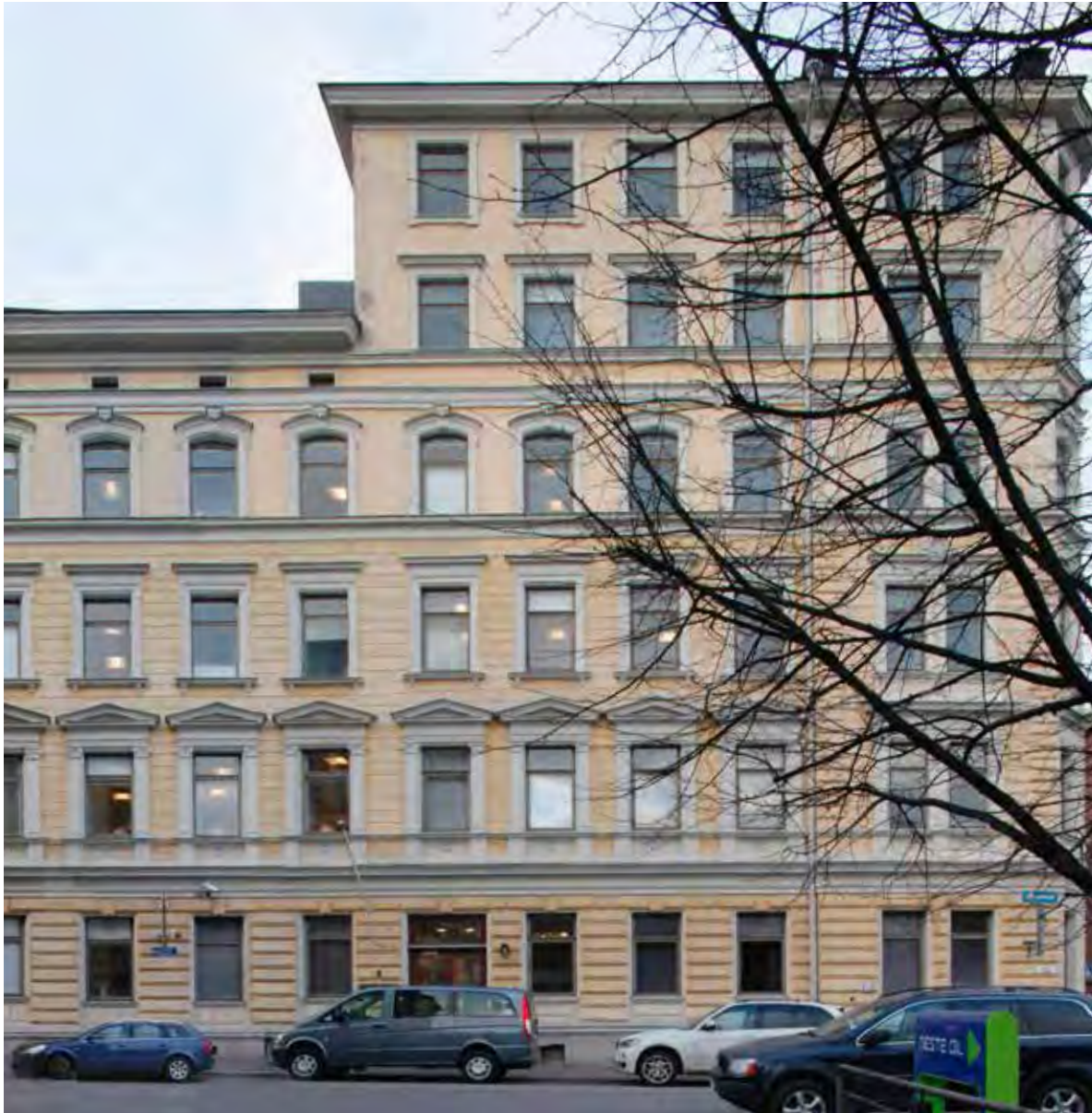
Ratakatu 3. Ratakadun puoleinen julkisivu.
