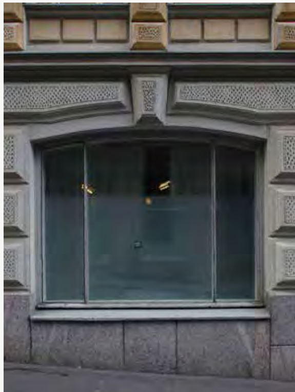
5. Pohjoisnurkan pohjakerroksen ikkunaa suurennettiin vuonna 1926.
