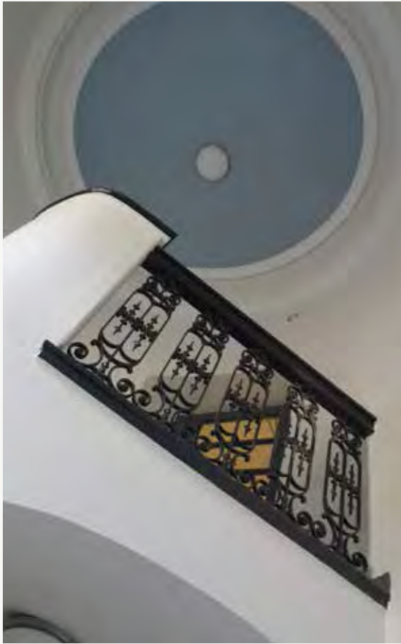
31. Ratakadun siiven porras.
