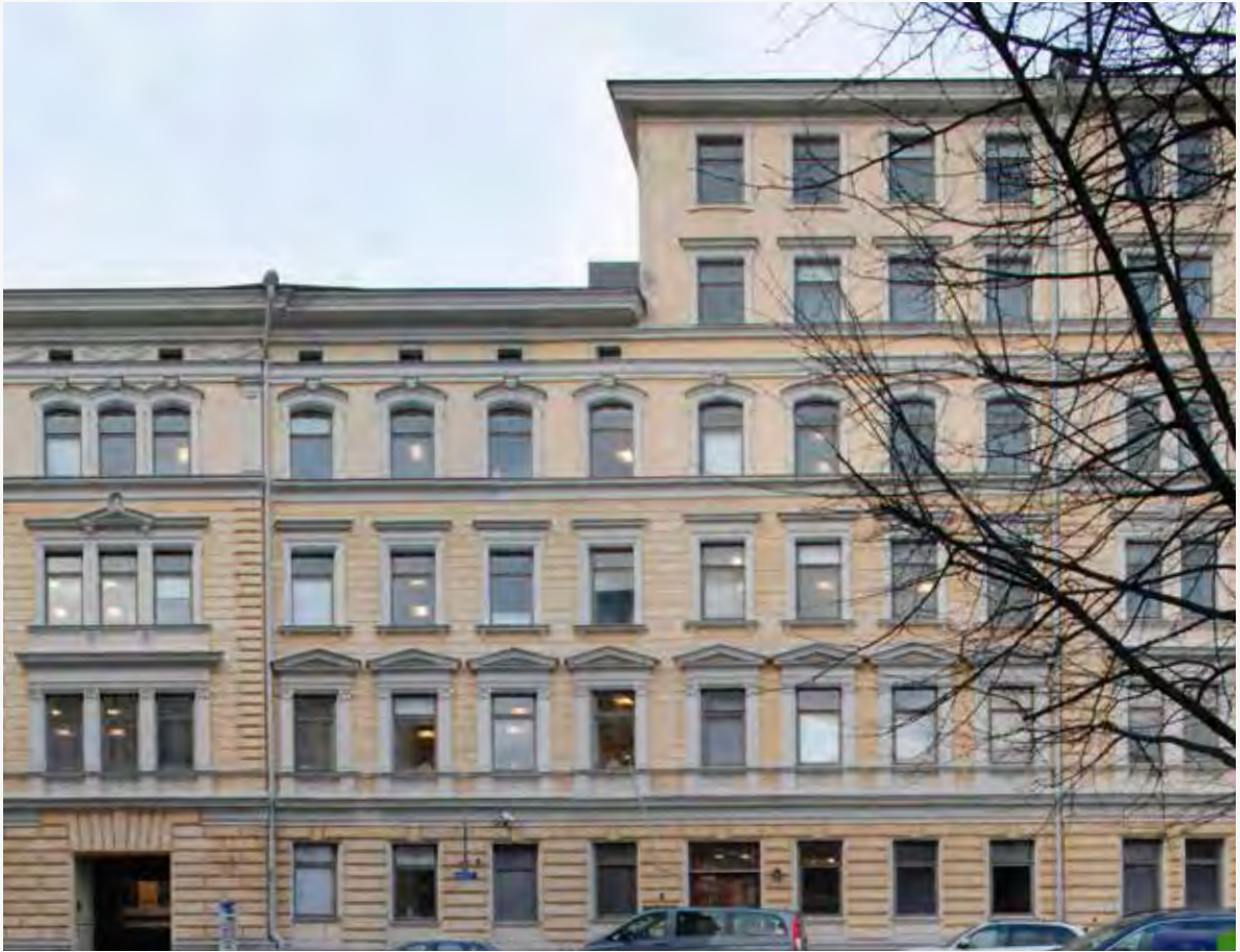
8. Ratakadun siipi rakennettiin kiinni kulmarakennukseen.
