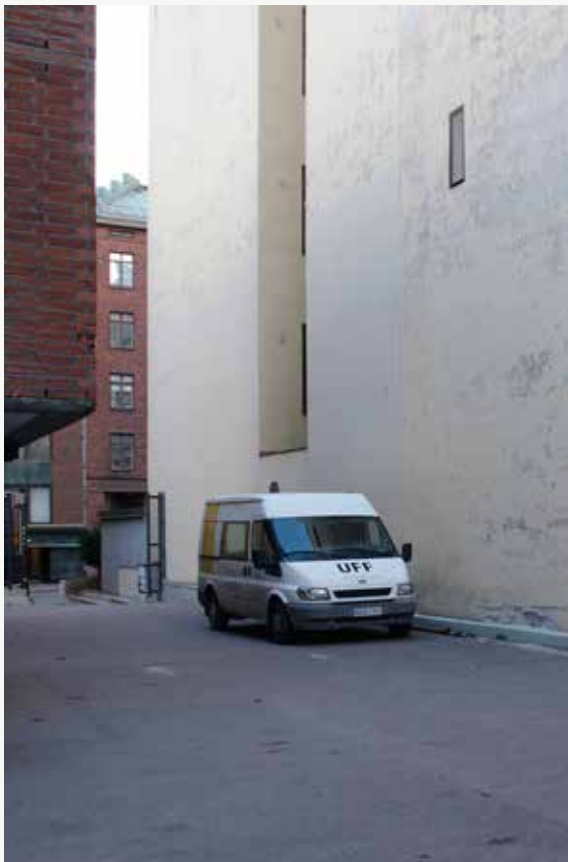
17. Piharakennuksen umpinainen takajulkisivu.
