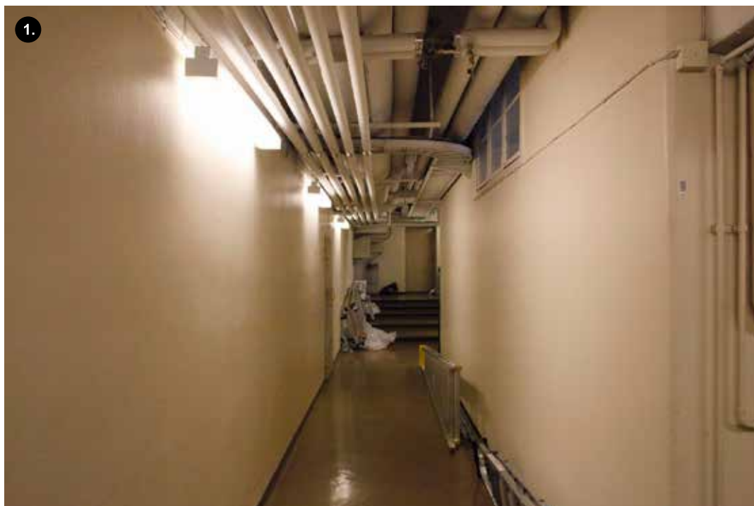
Kellarikerroksen keskellä kulkeva käytävä. Kerroksessa on paljon, osin tontin maastonmuodoista johtuvia tasoeroja ja siten portaita tilojen välillä.
