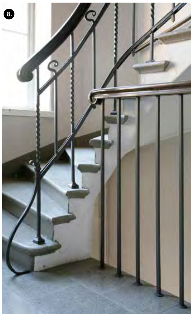
Portaan käsijohde on puinen ja kaide koristeltu takorautaisilla detaljeilla.
