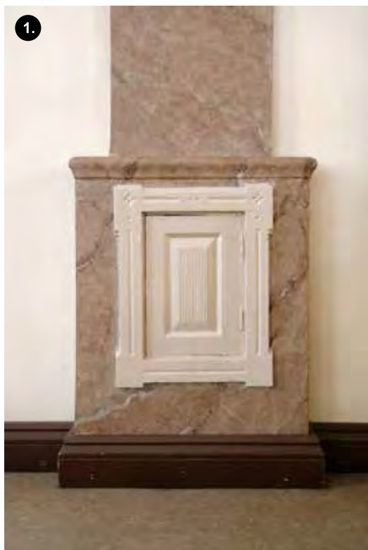
Juhlasalin pilasterin jalustassa sijaitseva komero.
