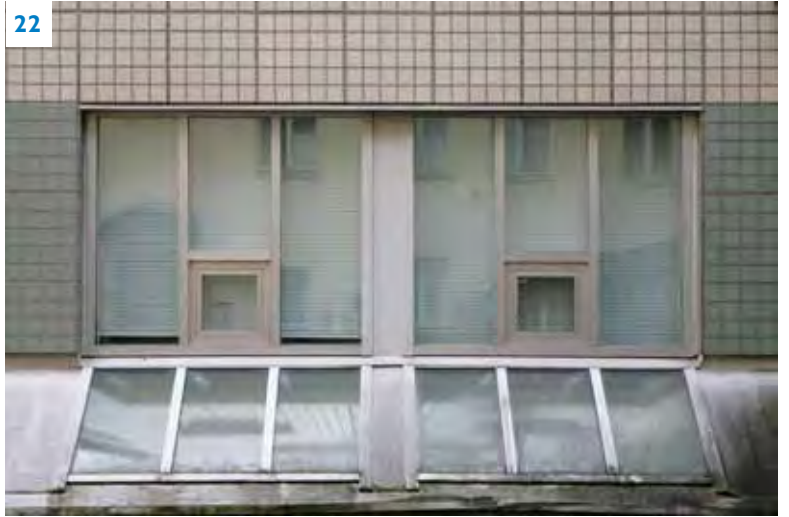
Uuden pihasiiven julkisivuote alumiini-ikkunoineen.
