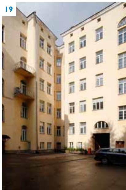
Länsi- ja pohjoissiipien kulman sisäpiha-julkisivuja.
