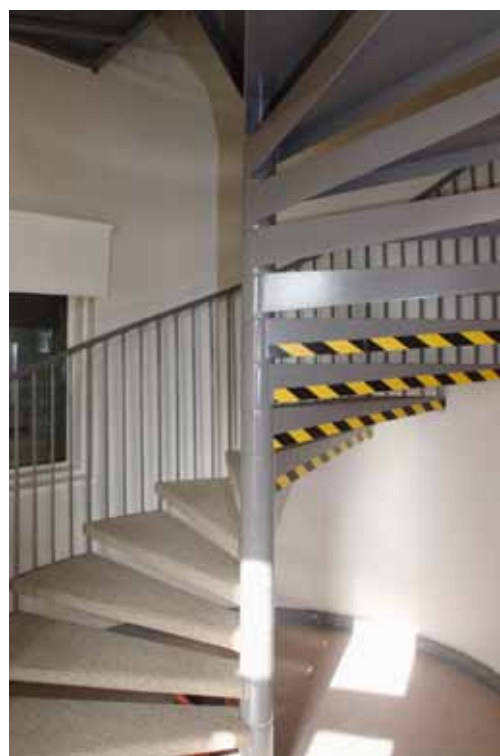
5. kerroksesta ullakolle johtaa 1987-1991 asennettu teräksinen kierrosportas.
