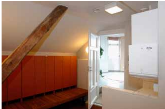
Pukuhuonetiloissa näkyy vanhoja hirsirakenteita.
