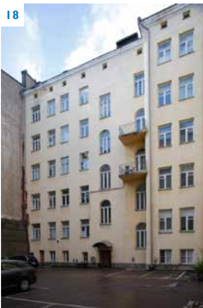
Rakennuksen länsisiiven sisäpihajulkisivu.
