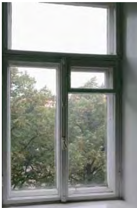
4. kerroksen perinnehuoneen 410 ikkuna.
