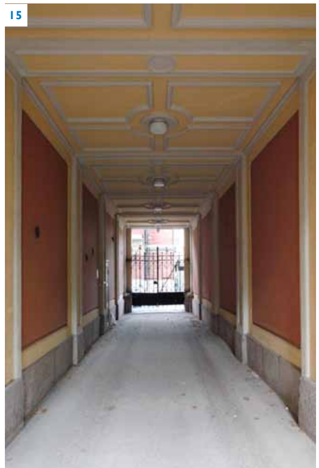
Näkymä sisäpihalta porttikäytävään kohti Punanotkonkatua.
