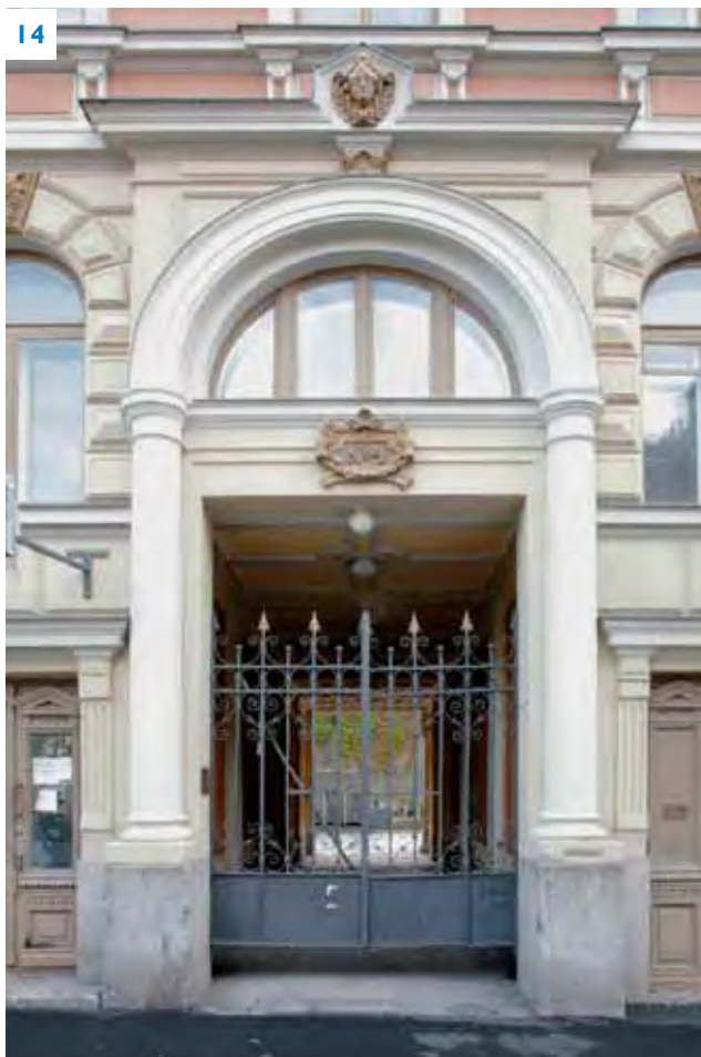
Metalliportti on alkuperäinen. Se on kunnostettu 1987-1991.
