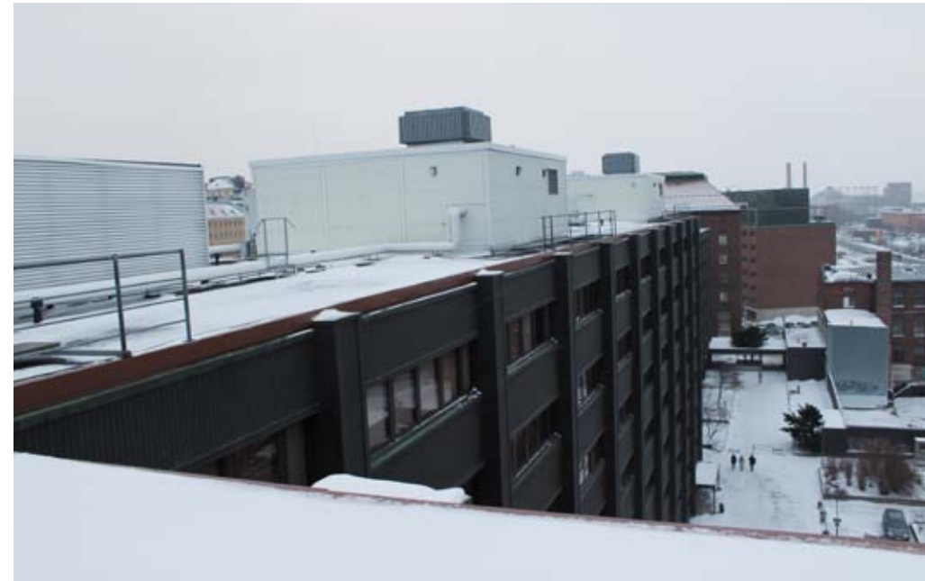
Konehuoneisiin on kulku katolta.
