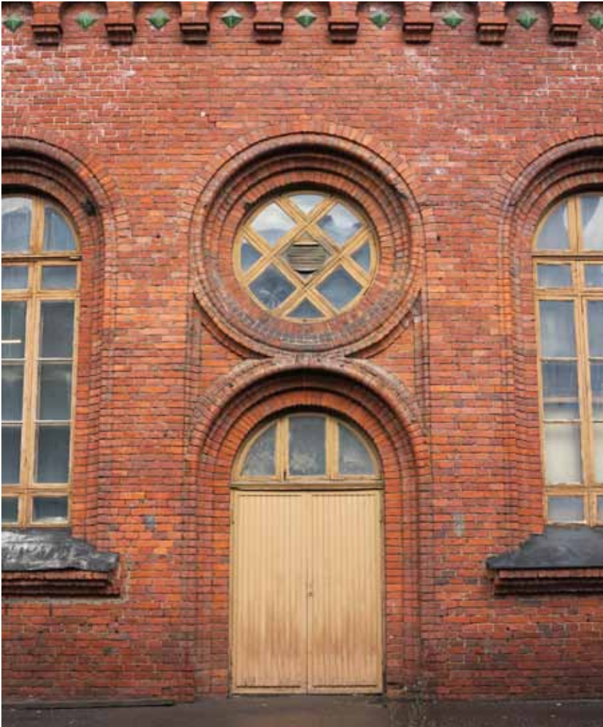
Muototiiltä on käytetty ikkuna- ja oviaukkojen kehysmuurauksissa, karniisilistassa ja julkisivun yksityiskohdissa. Kuva eteläseinustalta.
