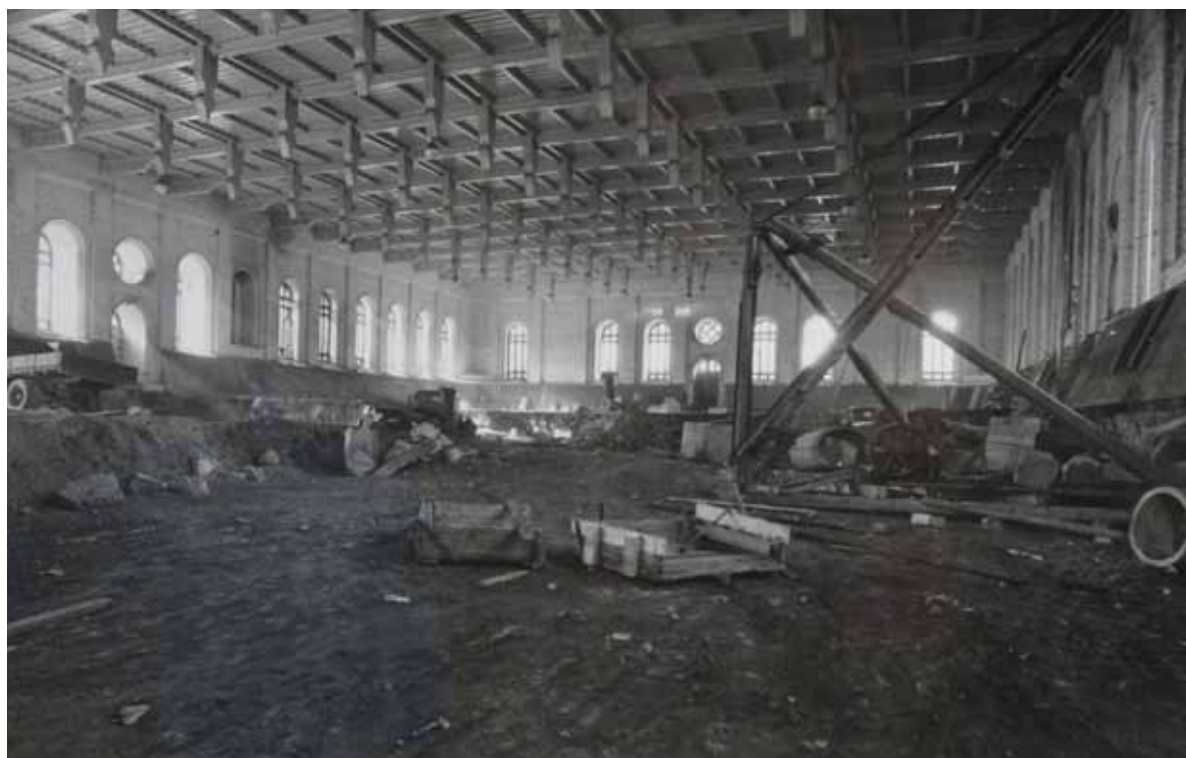
Kaivuutyöt käynnissä 1949. KA> PLM T28107. Viereisen sivun kuva A. Savialoff 1949 MFA.
