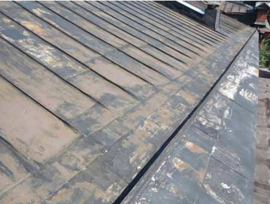
Nykyinen tietävästi 1950-luvun alussa tehty peltikate noudattaa pitkälti alkuperäistä vesijalkakouruineen ja vaakasuuntaisine hakasaumoineen.
