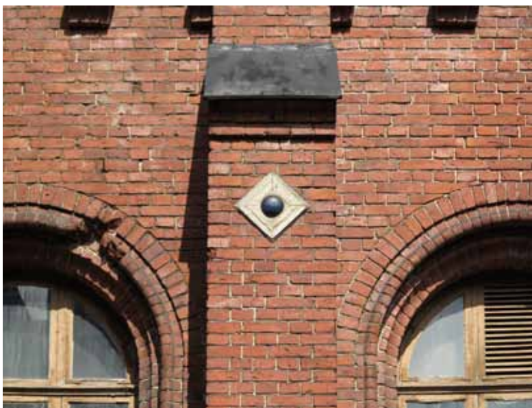
Esimerkki kontreforin yläpään muodonannosta Dalströmin suunnitelmassa ja alla nykytilanne.
