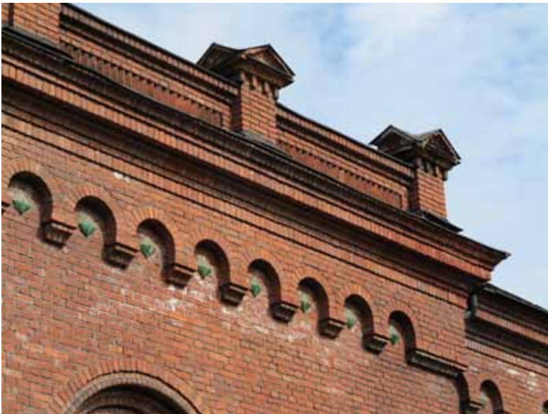
Kaarifriisi ja vihreäksi lasitetut tiilirobit, yllä Dalströmin suunnitelmassa 1874 ja alla nykyasu eteläisellä seinällä.
