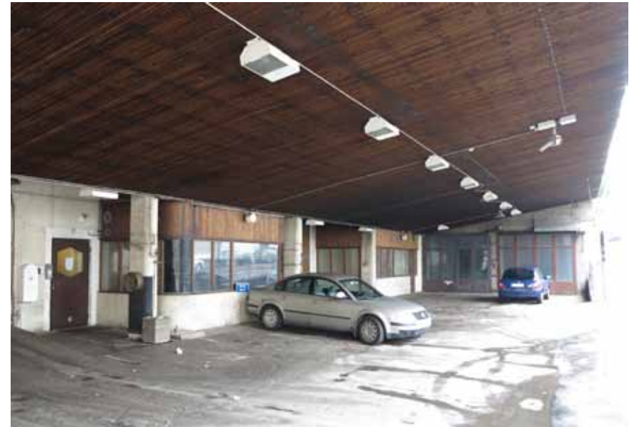
Yleiskuva katoksen alta: kaksi entistä huoltamon palvelukioskia, oikealla autohuoltoon ja autopesuun johtaneet ovet.
