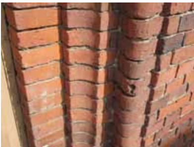
Muototiiltä on käytetty ikkuna- ja oviaukkojen kehysmuurauksissa, karniisilistassa ja julkisivun yksityiskohdissa. Kuva eteläseinustalta.
