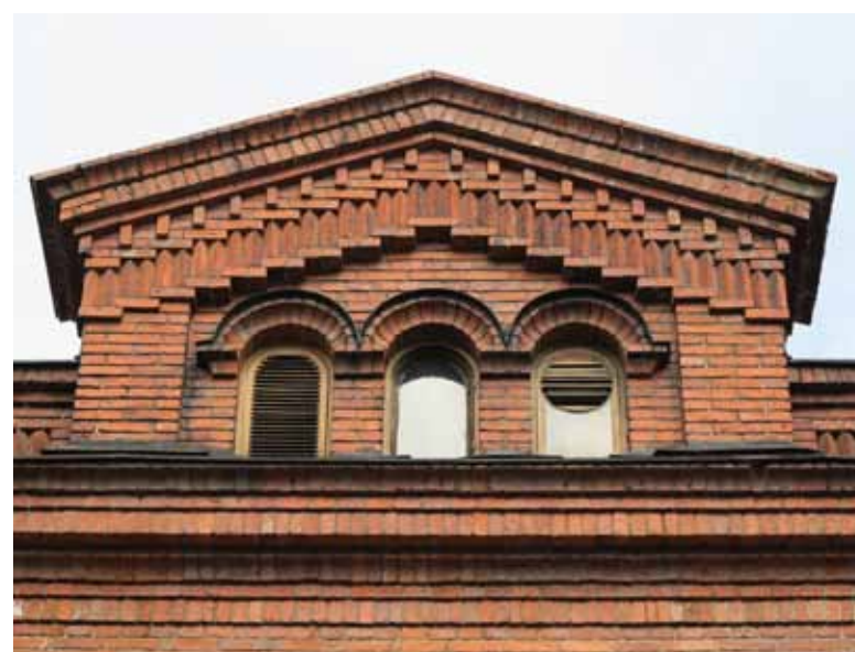
Pitkien sivujen keskirisaliittien ja itäpäädyn eteisosan harjapääte. Yllä Dalströmin suunnitelma, alla eteiläisen julkisivun pääte; ikkunat ovat vaihtuneet tuuletusritilöiksi.
