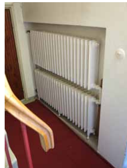
Rakennuksessa on valurautaisia Kesto-radiaattoreita porrashuoneissa, toimistokerroksessa yms. paikoissa, jotka mitoitukseltaan ovat niille soveliaita.
