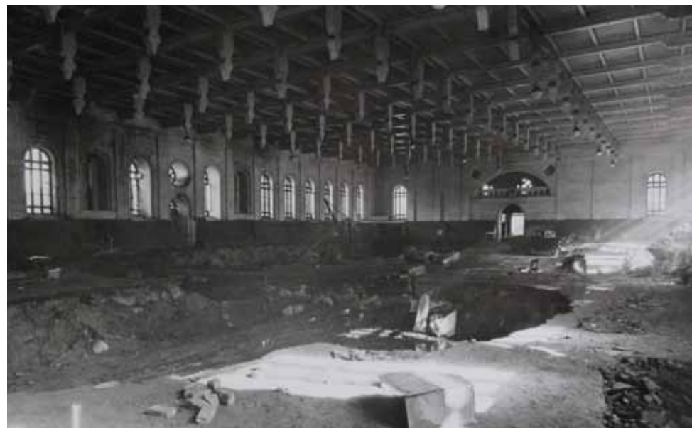
Kuva purkutyövaiheen alusta, 1949, jossa varsinkin vasemmalla olevan kaivannon leikkaus osoittaa tiiviimmän pintakerroksen täyttömaan päällä. KA > PLM T28107
