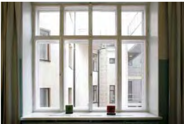
Ikkuna 2. kerroksen aulatilasta pihalle.
