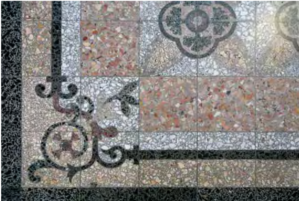
Aulatilän koristeellista mosaiikkibetonia. Mosaiikkibetoni oli paljon käytetty materiaali uusrenessanssitalojen porrashuoneissa ja auloissa.
