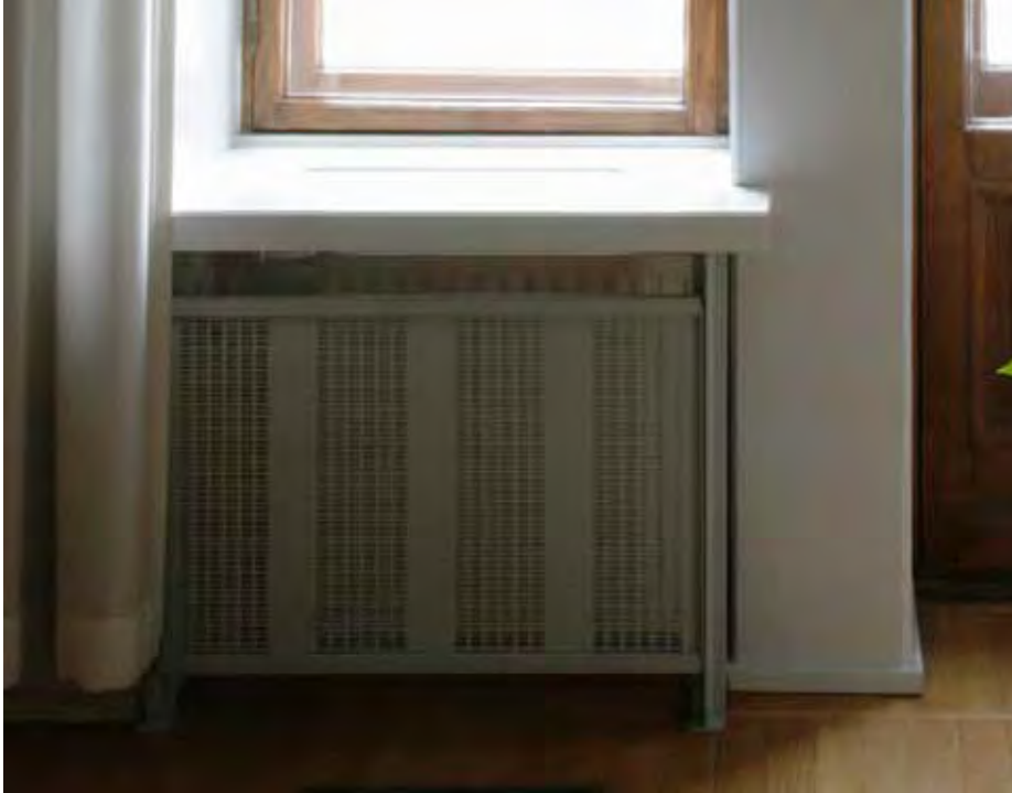
1980-luvulla pattereiden eteen kiinnitettiin levysuojukset.
