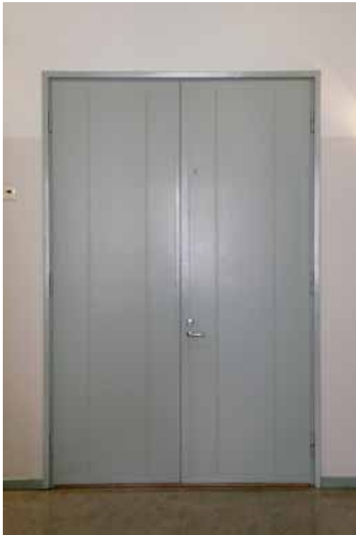
Maalattu, korkea puurakenteinen laakapariovi 1980-luvulta. Ovilevyä kiertää suorakulmainen lista. Keskivyo-ohykettä on jäsennöity kahdella pystylistalla.
