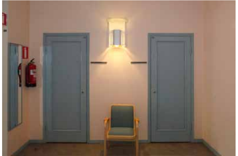
1930-luvun maalattua yksipeilistä kehysovea 1930-luvulta on käytetty sekundääristen tilojen ovityyppinä.
