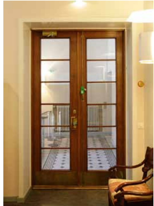
B-portaan porrashuoneessa on 1930-luvulta peräisin oleva tammilasipariovi.
