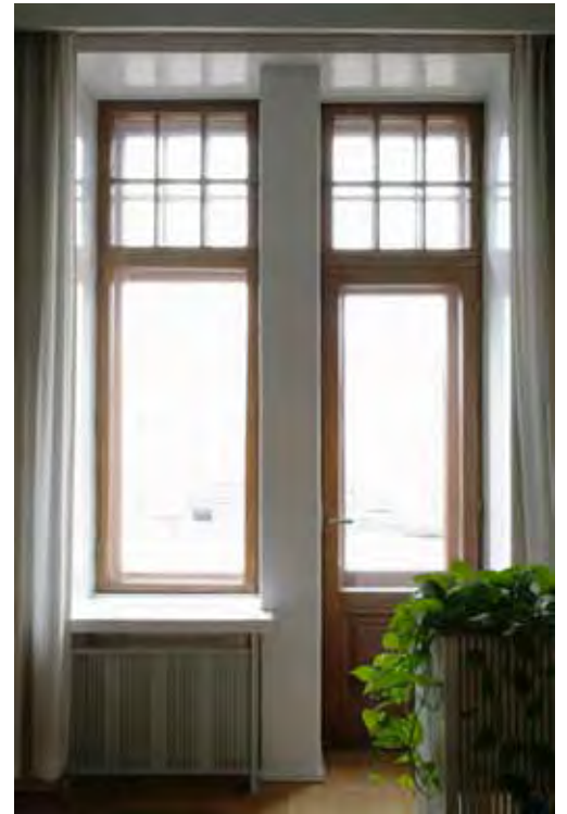
Kadunpuoleinen ikkuna ja parvekkeen ovi.
