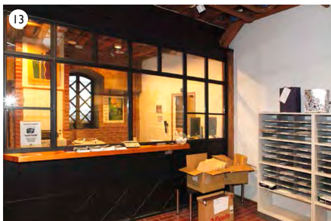
Toimistuhuoneita ja sosiaalitylöjä on muodostettu kevyin väliseinin. Ilmastointiputket on jätetty näkyviin.
