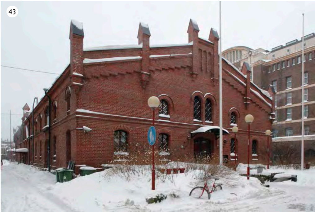
Vuonna 1989 murattu uusi päätyseinä.
