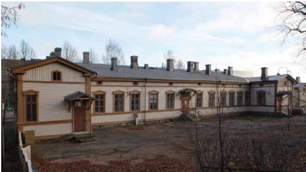
Rakennuksen 8 pihanpuoleinen julkisivu länteen.
