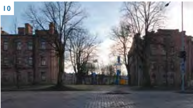
10 Päävartiorakennus 6 näkyy rakennusten 2 (vas.) ja 1 väliin jäävällä akselilla.
