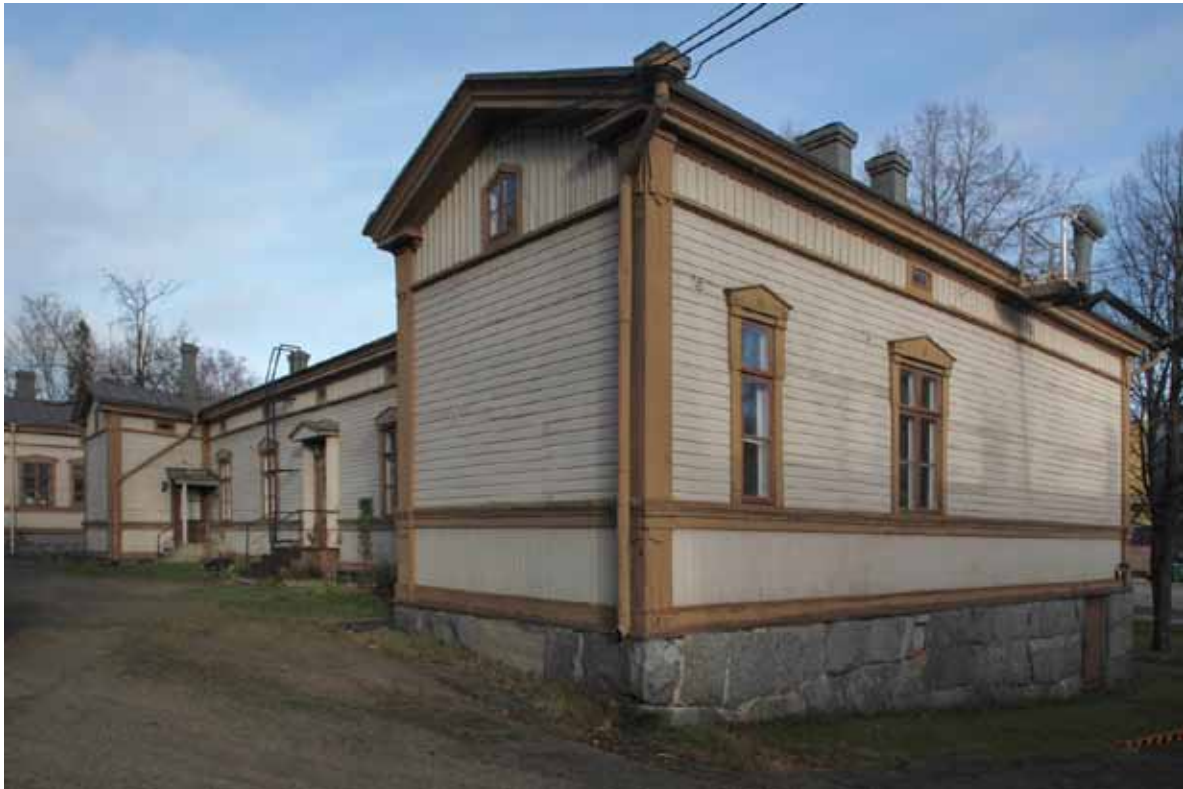
Rakennuksen 4 sisäpuoleinen näkymä. Kuvasta ilmenee rakennuksen sijoittuminen rinteeseen.
