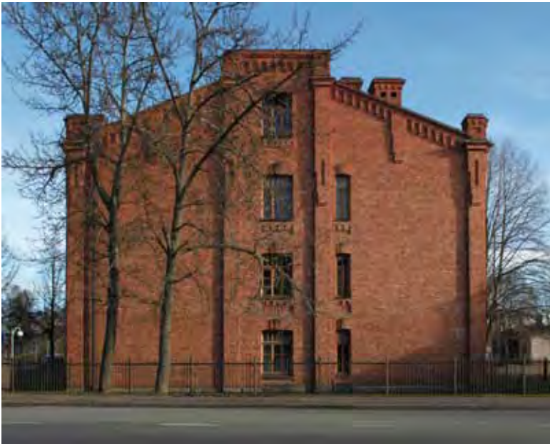
Rakennus 1:n päätyjulkisivussa korostuu keskirisaliitti. Kuva on Vuorikadun puolelta.
