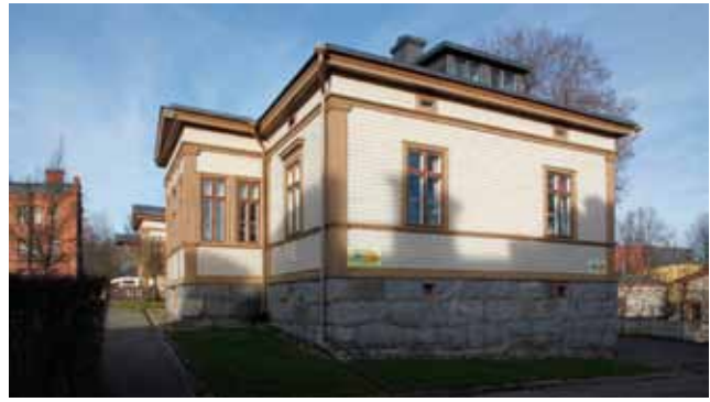
Rakennuksen 7 etelänpuoleinen pääty. Katolla näkyvät ullakkoikkunat. Ullakko otettiin käyttöön 1940-luvulla.
