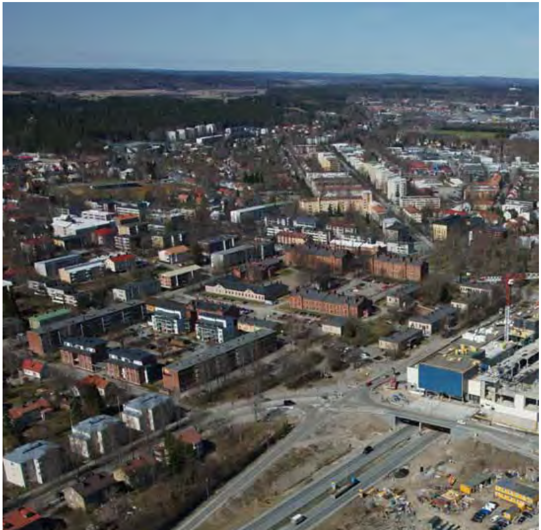
Viistoilmakuva keväältä 2013. Kasarmialueen itäpuolella moottoritien päälle on rakennettu kansi ja kauppakeskukseen rakennustyömaa on kesken. Valokuva Skyfoto Group, Sami Kurikka. HML MS.
