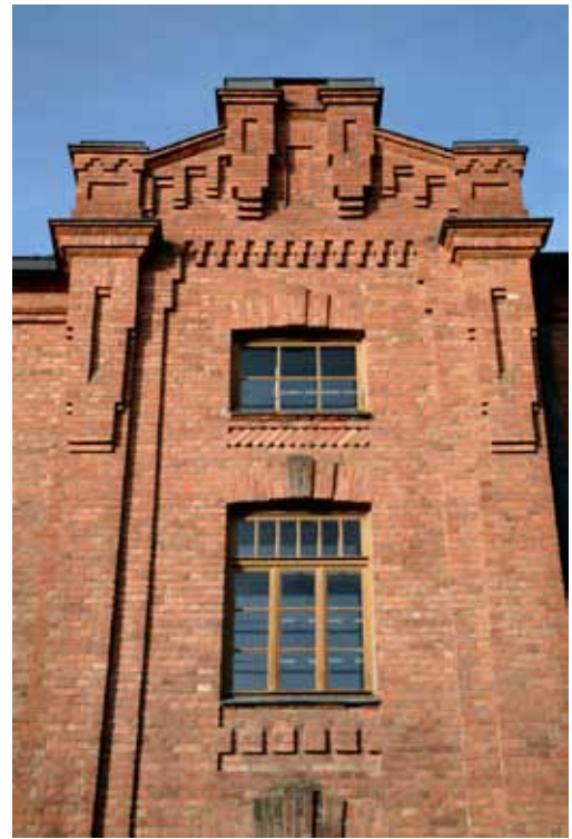
Julkisivudetaljissa näkyy attikan koristelua.
