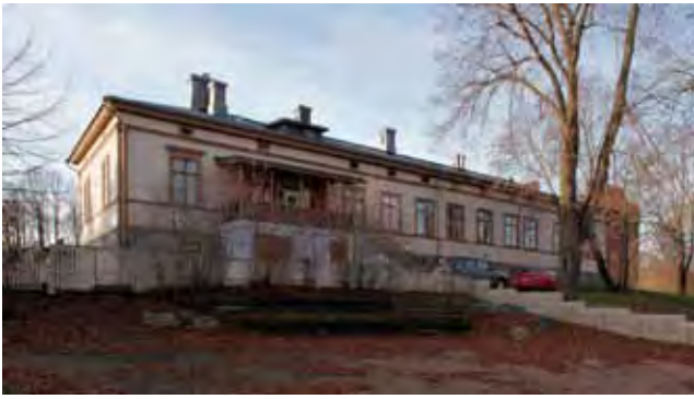
Idänpuoleinen julkisivu. Keittiöporras on myöhäisempi lisäys. Rakennus sijaitsee rinteessä.
