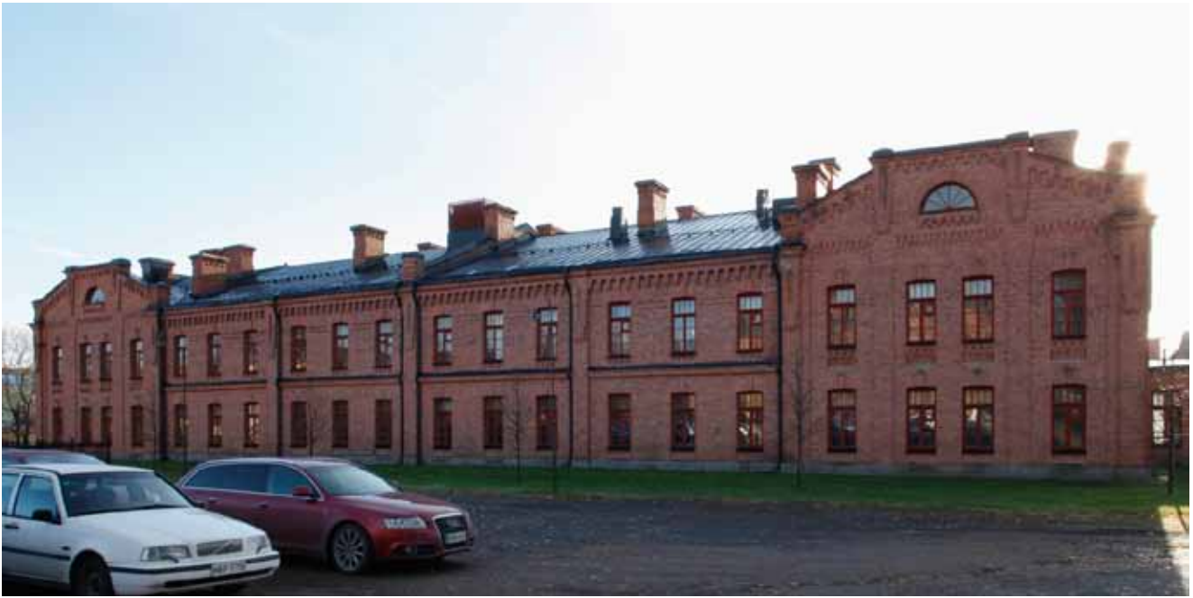
Rakennus 10:n julkisivu pohjoiseen, joka on etelänpuoleista julkisivua koristeellisempi. Attikoihin on sijoitettu pyörökaari-ikkunat.
