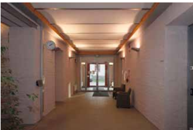
Sisätilat on uudistettu vuonna 2007 toimistotiloiksi. Katossa näkyvät tiiliholvaukset, jotka on tuettu rautakiskoilla.
