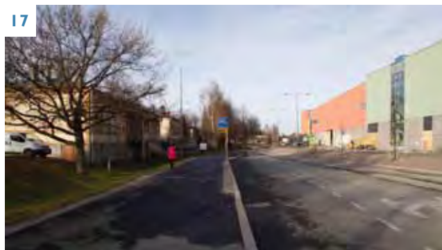
Näkymä Eureninkatua pitkin kohti pohjoista. Vasemmalla puurakennukset 15 ja 8, oikealla kauppakeskuksen rakennustyömaa.
