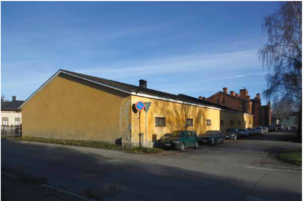
Rakennuksen 20 julkisivu Vuorikadulle on umpinainen. Selkäsuonkadun puoleisessa julkisivussa on kahdeksan luukku.
