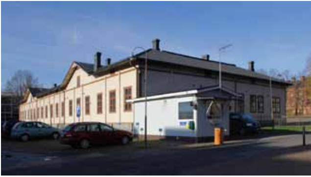
Rakennuksen II kulmassa on 1990-luvulla rakennettu kulunvalvontakoppi, jonka kautta valvotaan sisäänpääsyä aidatulle alueelle.
