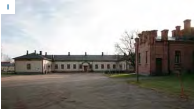
1880-luvun miehistörakennuksen (11) ja 1910-luvun upseerikerhon (5) edustalla on tasainen hiekkakenttä.
