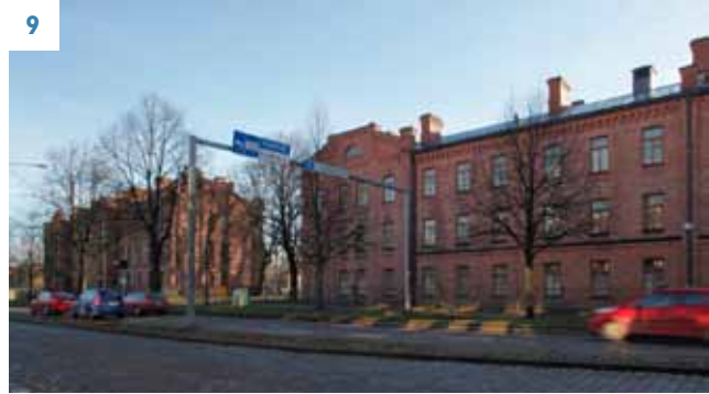
9 Suomen kasarmien rakennusten 2 ja 1 tiilijulkisivut pohjoiseen Turuntielle.
