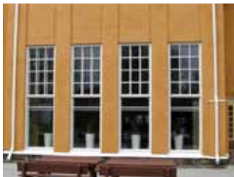
Aulan korkeat ikkunat poikkeavat muista ikkunoista. Ne olivat alun perin alaosaan ylösnostettavia (nk. sash window).
