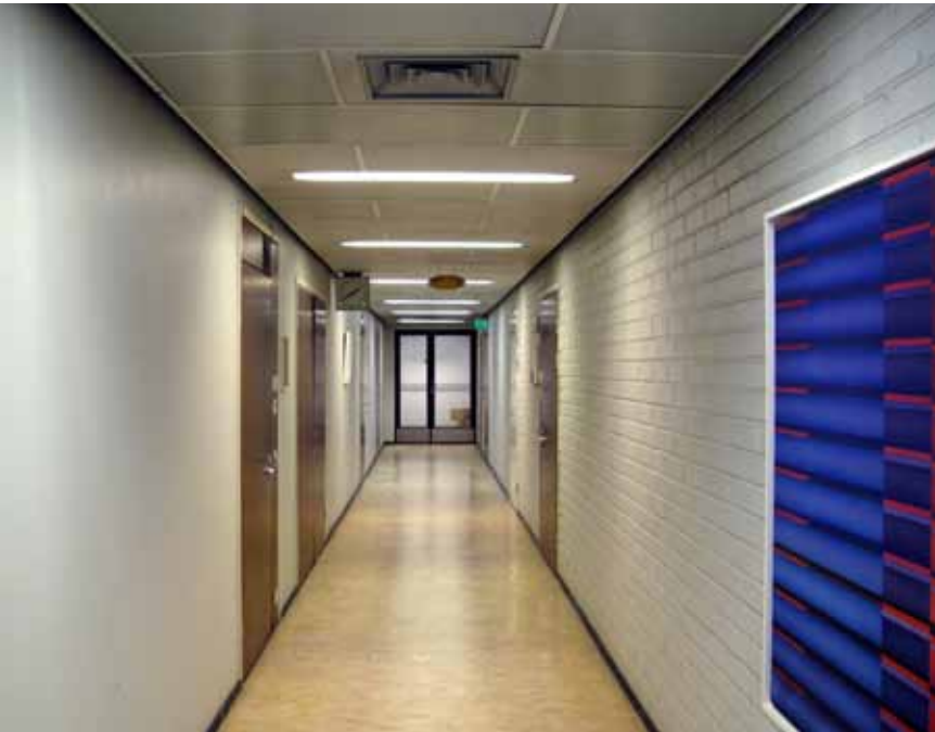
Pohjakerroksen käytävä 013a. Vuoden 1975 peruskorjauksen aikainen puhtaaksimuuraus ja maalattu tiiliseinä erottuu vanhasta rapatusta sydänmuurista.
