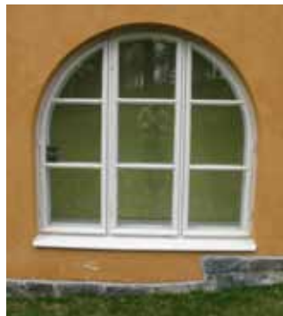
Kaari-ikkunat on sijoitettu sisemmäksi julkisivupinnasta. Niitä on käytetty pohjakerroksessa.
