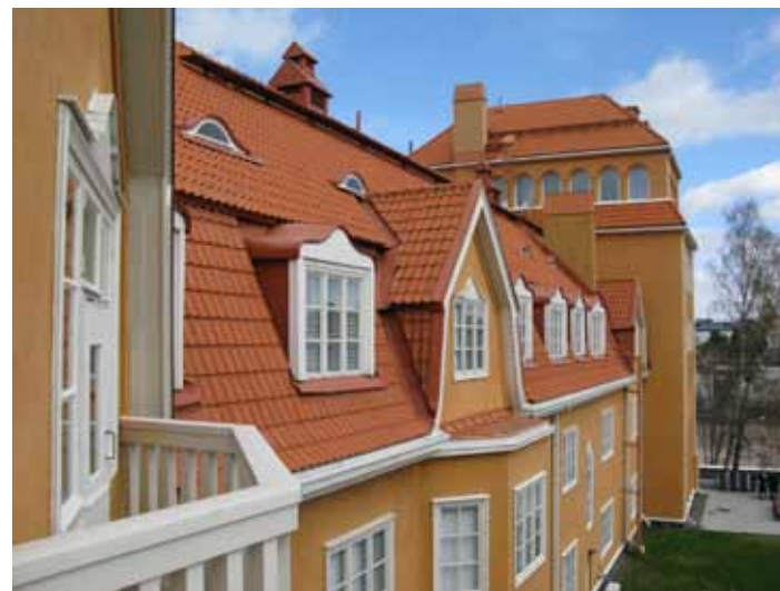
Erimallisilla ikkunoilla on rytmitetty julkisivupintaa ja siihen liittyvää mansardikattoa. Keskiosan erkkerin yläpuolinen parveke on poistettu ja ovi muutettu ikkunaksi.
