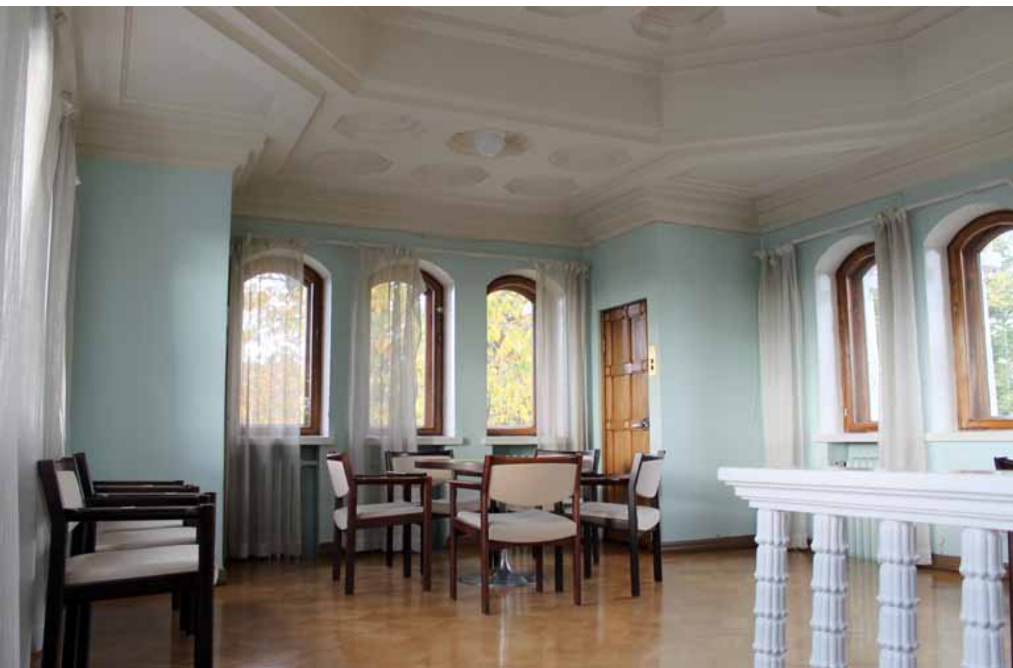
Massiivinen kasettikatto on betonirakenteinen ja se koostuu kahdeksankulmioista, joissa profiloidut listat.
