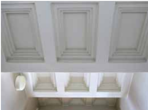
Kaariaukkoja kehystävät klassiset nauhalistat, jotka ovat olleet alusta saakka maalattuna seinäväriin. Portaan porrastuvissa kattopinnoissa on voimakkaasti profiloitunut kasetit.
