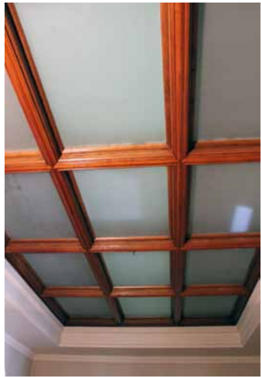
Profiloidut kattolistat kiertävät kattopintaa sekä tilan keskellä olevaa tammista kattoikkunaa.
