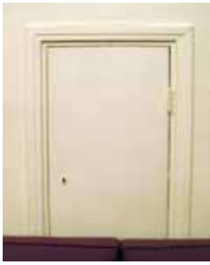
Maalattu luukku (1950-l.) tilassa 110. Ovilistoissa on muiden ovien tapaan pieni pykällys.
