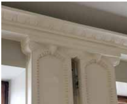
Terassin ovia kehystävissä pilastereiden sivuissa on puulistat oviverhotangon kiinnitystä varten.
