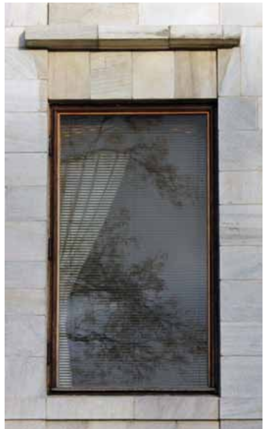
Tammi-ikkunat ovat pääosin yhtenäisiä ilman välijaakoja. Osa ikkunoiden ulkopuitteista avautuu poikkeuksellisesti ulospäin.
