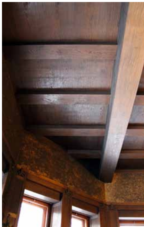
Kattopinta primääri- ja sekundaaripalkkeineen on verhoitu tammiviilulla. Seinäpinnan palkkien välit ovat myös tammea. Tapetin yläreunassa puulista.
