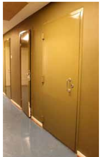
Maalatut laakaovet (1950–60-l.) ovat sileitä puuovia tai teräspaloovia. Ne sijoittuvat pääosin pohjakerrokseen.
