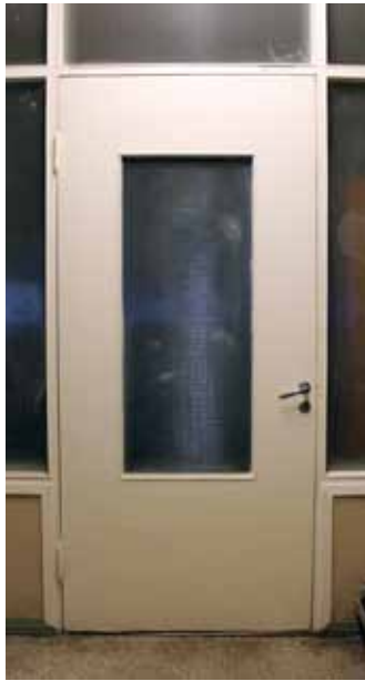
Maalattu luukku (1950-l.) tilassa 110. Ovilistoissa on muiden ovien tapaan pieni pykällys.
