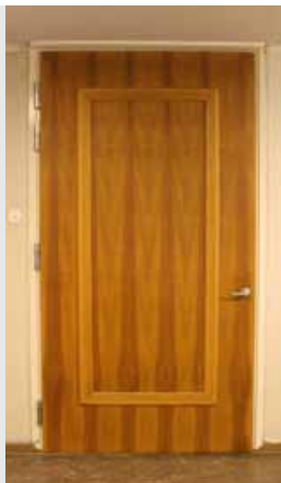
Maalatut laakaovet (1950–60-l.) ovat sileitä puuovia tai teräspaloovia. Ne sijoittuvat pääosin pohjakerrokseen.
