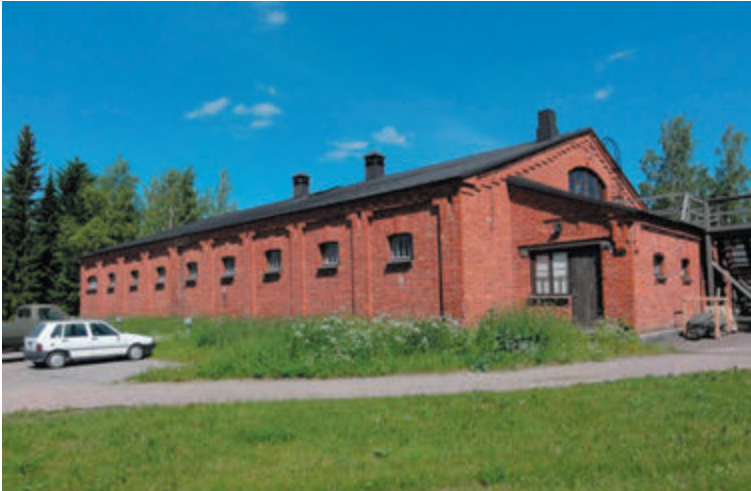
Rakennus 41, varasto, entinen talli.
