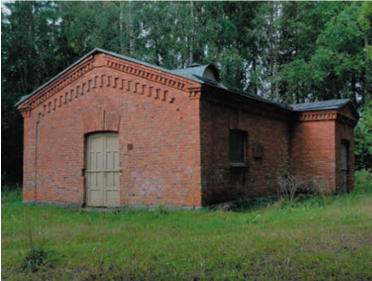
Rakennus 57, entinen tsasouna.
