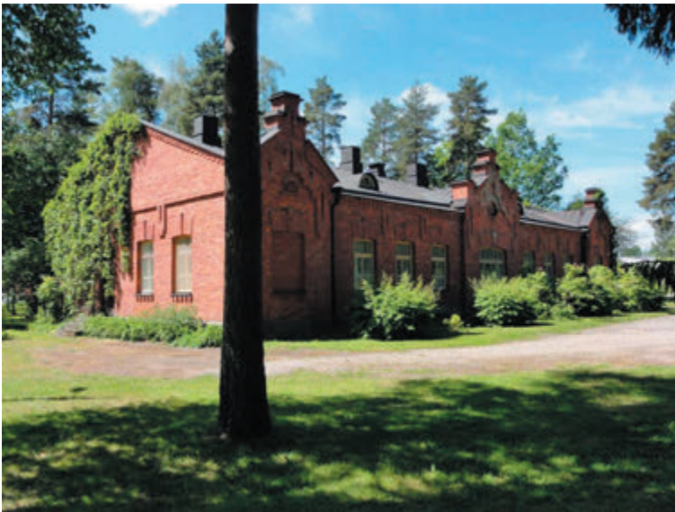
Rakennus 8, entinen rykmentin komentajan asuinrakennus.
