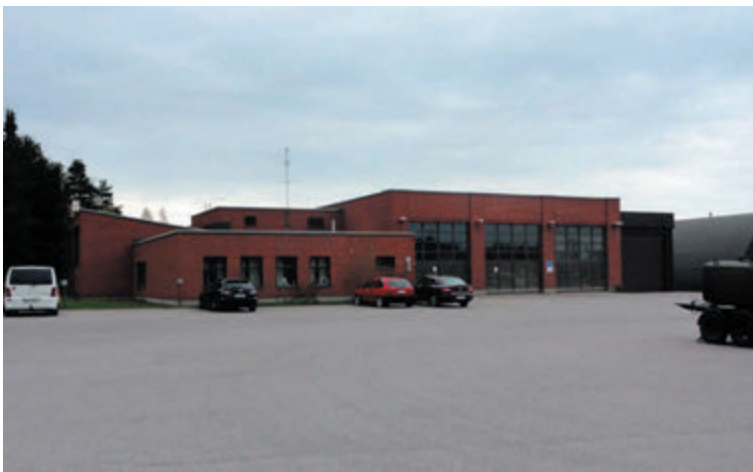
Rakennus 100, autohuoltola, oikealla rakennus 51.
