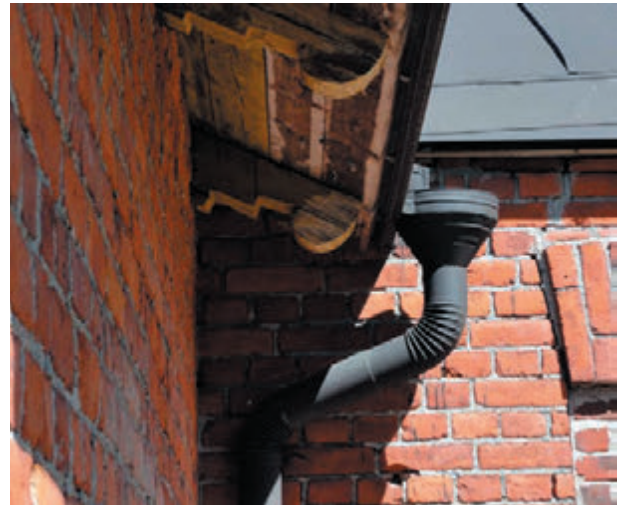
Rakennus 31, oikealla räystääskonsolit.
