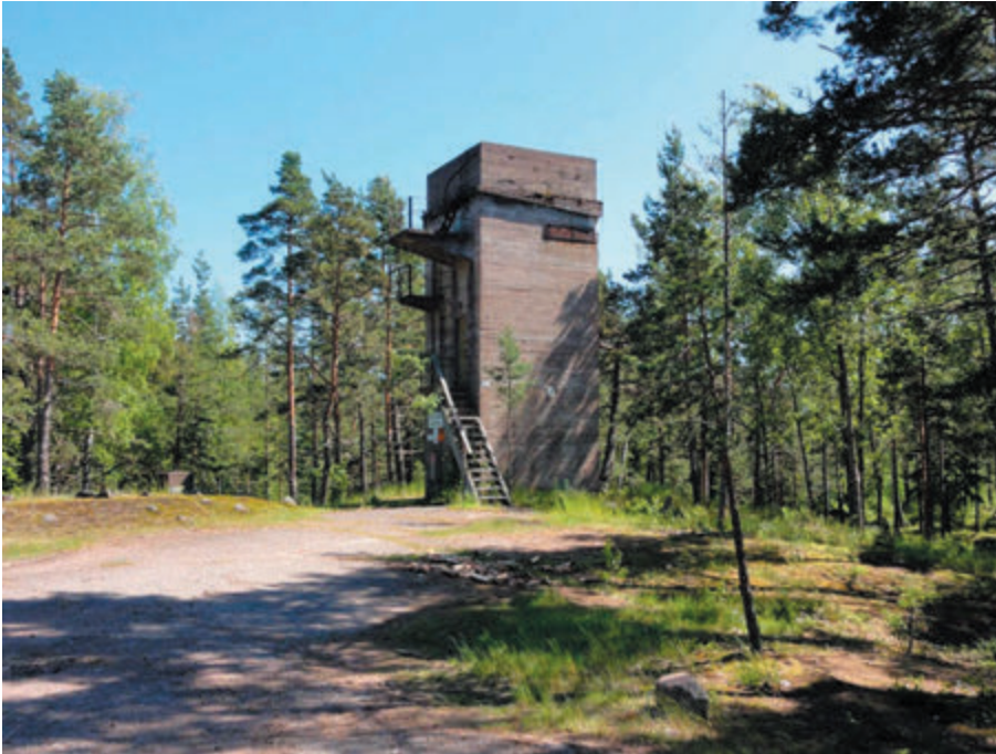
1930-luvun alussa rakennettu ns. Rikaman saapas, betoninen nelikulmainen tulenjohtotorni.
