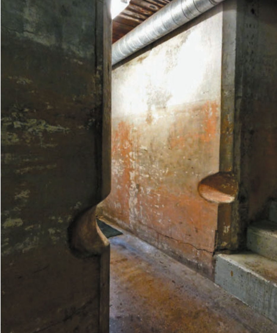
Ylhäällä järeän patterin tykki, alhaalla näkymä patterin sisätiloista.
