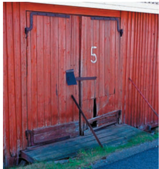
Rakennuksen 30 ovi saranoineen.
