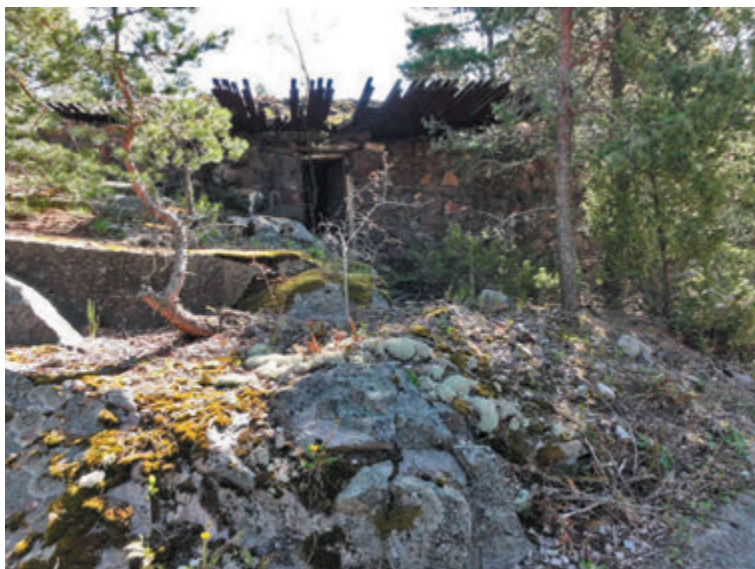
Rakennus 7, entinen sota-ajan leipomo.
