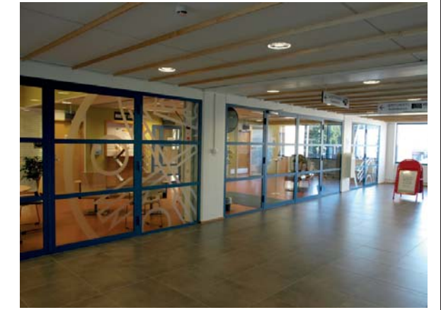
Verotoimiston asiakasaulan ikkunaseinä kerrostasolle yhteisessä aulatilassa.
