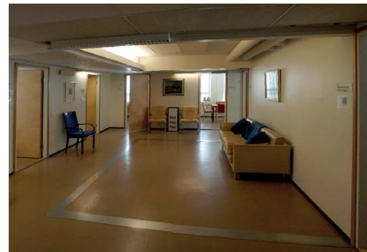
Aula käytävän päässä. Huoneiden lakatut vaneriovet vastaavat asultaan alkuperäisiä ovia (ullakolla on varastoituna purettuja alkuperäisiä ovilehtiä).
