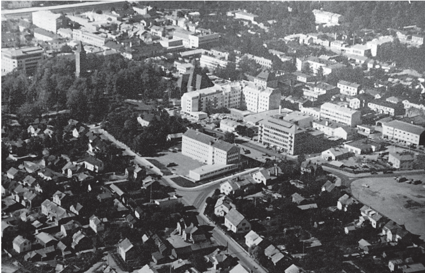
Lappeenrannan keskustaa vuonna 1956, Postitalon juuri valmistuttua. Sairaalan ja Postitalon korttelin etelä- ja itäpuolella on vielä tiivistä pientaloasutusta. (EKM)
