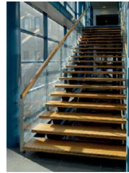
Sisäpihalle tehdyn laajennusosan porrashuone.
