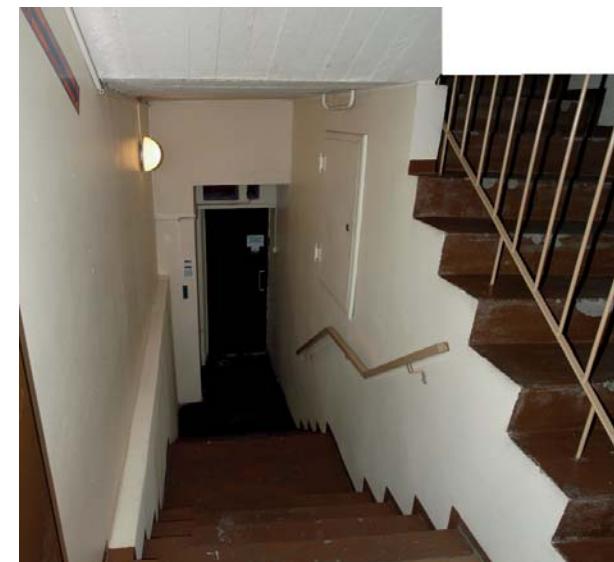
1980-luvulla rakennettu yhteys Lappeenrannan virastotalolle.
