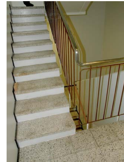
IV-konehuone. Porrassyöksy kapenee IV-konehuoneeseen mentäessä.
