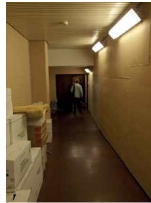
Käytävää alkuperäisasussa, levymuotilla puhdasvalettua seinään ja maalattua betonilattiaa.
