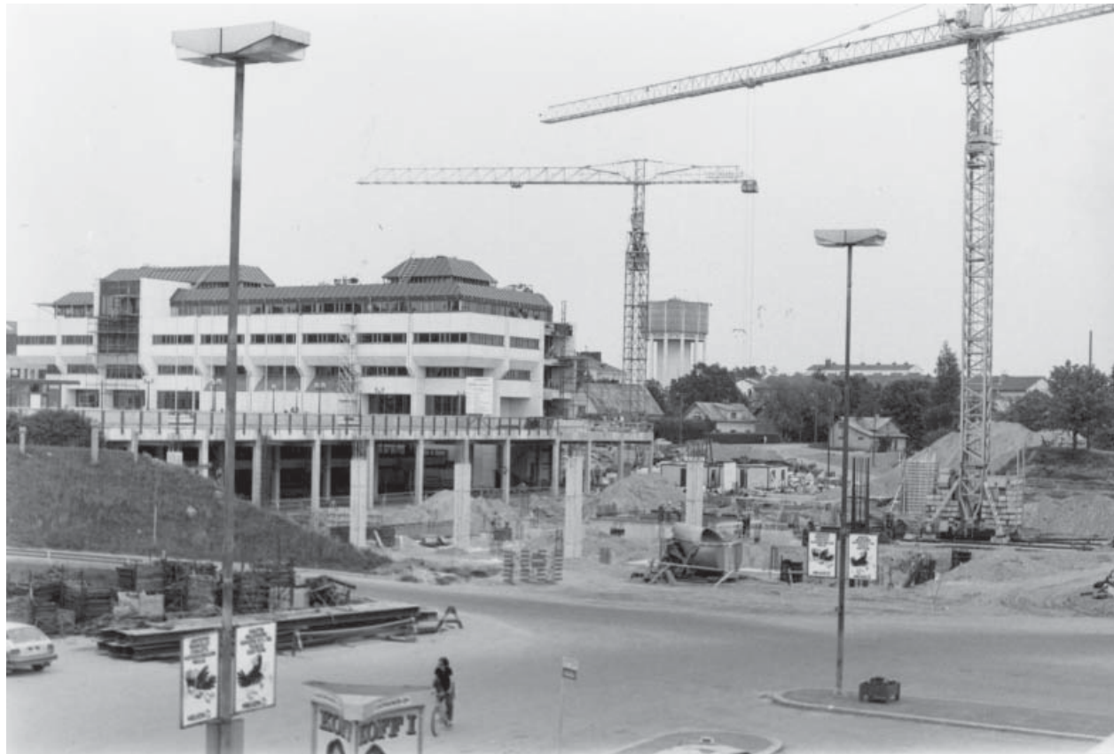
Kaupungintalo ja sitä ympäröivät betonikannet rakenteilla vuonna 1982 (EKM, valok. H. Tuhkanen)
