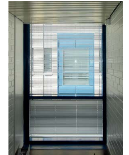
C osan ja AB osassa olleen ruokalan yhdistänyt, kujan ylittävä, käytävä oli tässä.
