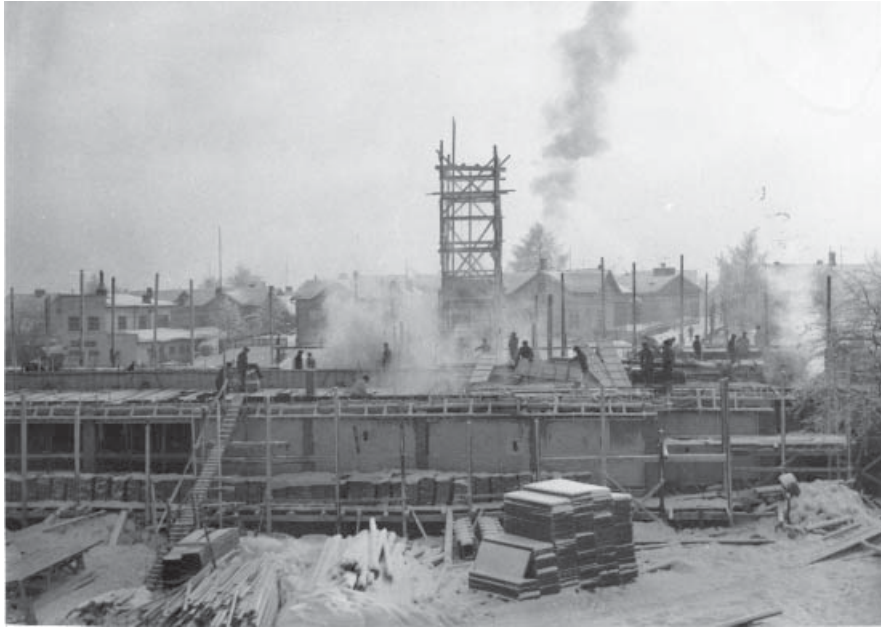
Postitalon työmaa ilmeisesti alkuvuodesta 1955, taustalla Peltolan kaupunginosan rakennuksia. (LKA)
