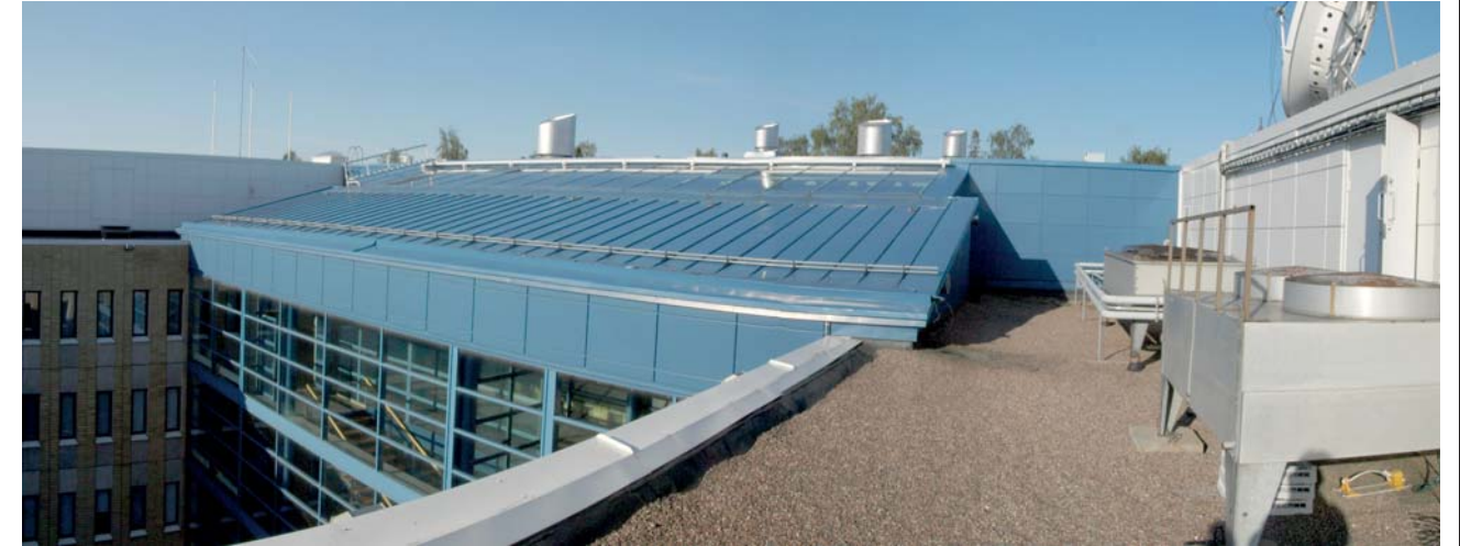
Sisäpihalle rakennettu laajennusosa, porrashuone ja kerrostasojen yhteisaulat. Katolla alkuperäiset konehuoneet (valkea muovipinnoitettu teräspeltikasetointi) ja uudet konehuoneet (sininen peltikasetointi).
