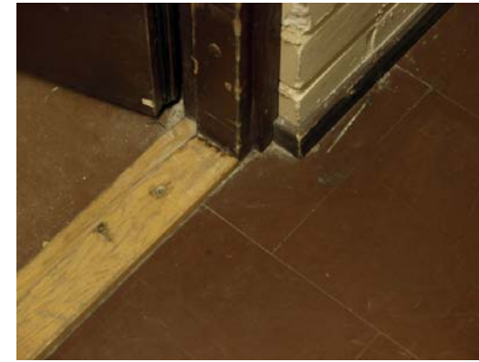
Alkuperäinen ovi ja irtokynnys. Alkuperäiset lattiapinnoitteet, kvartsiyvyylimuovilaatta ja samaan väriin maalattu betonilattia.
