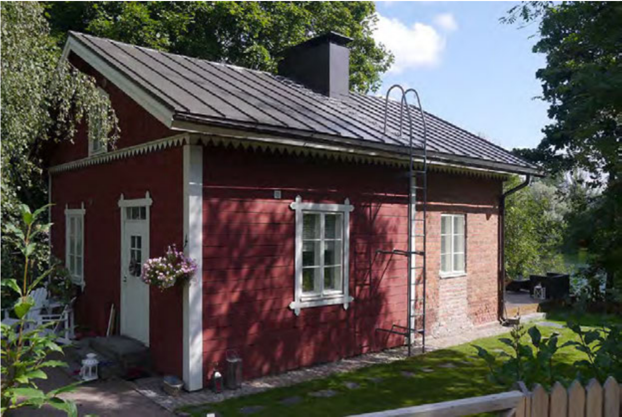
↑ Sauna- ja pesutuparakennus. Pesutuvan entinen sisäänkäynti on muutettu ikkunaksi ja alaosa muurattu umpeen. amoy 2012
