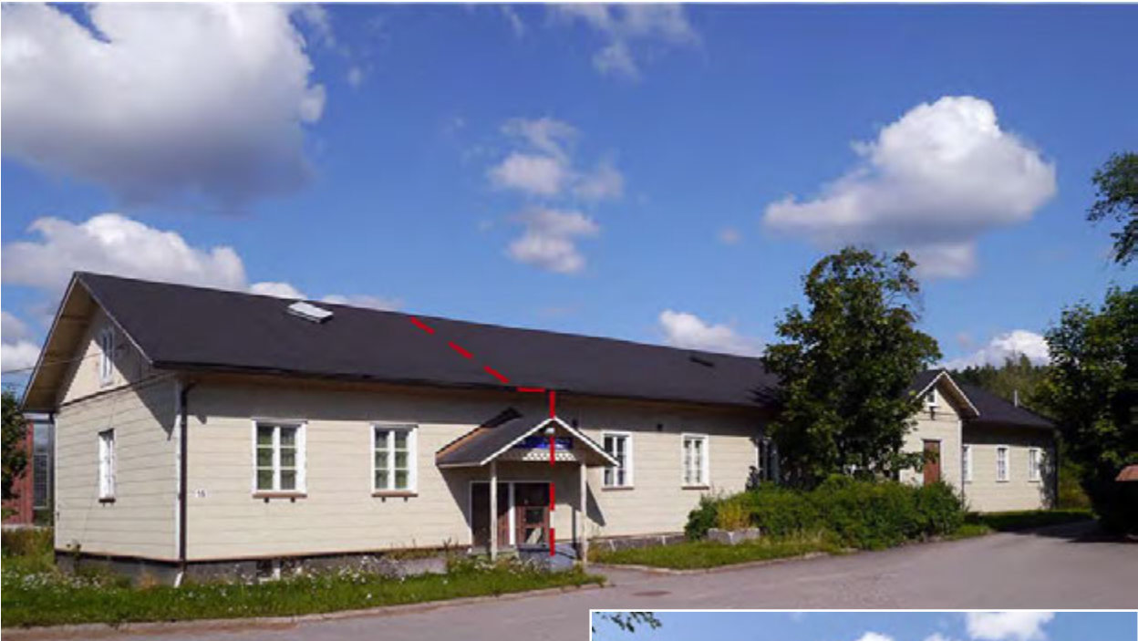
↑ Vuoden 1894 asuinkasarmi. Laajennusosan ja alkuperäisen rungon jatkoskohta on esitetty punaisella katkoviivalla. amoy 2012
