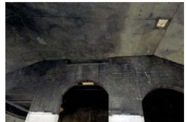
↑ 7. veturipilttuun katto vuonna 2012. amoy 2012 Veturipilttuiden katot on levytetty, niissä näkyy edelleen savutorvien aukot. Tämän veturipilttuun katossa on myös kolo jossa vesisäiliö ollut.
