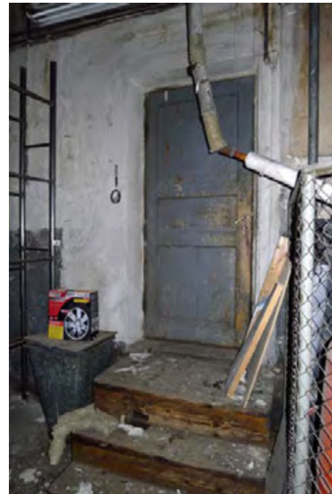
↑ Toimistosiiven korjaushuonetilaan B johtava vanha puuovi. amoy 2012
