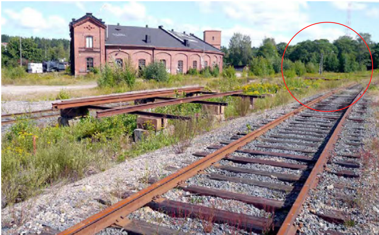
↑ Näkymä entisen puunantoalueen suuntaan. amoy 2012 Punaisen ympyrän keskellä on vesiviskuri. Etualalla näkyy ratakiskojen säilytystä, ratakiskojen säilytysalustoina on kiskojen välissä graniittilohkareita.
