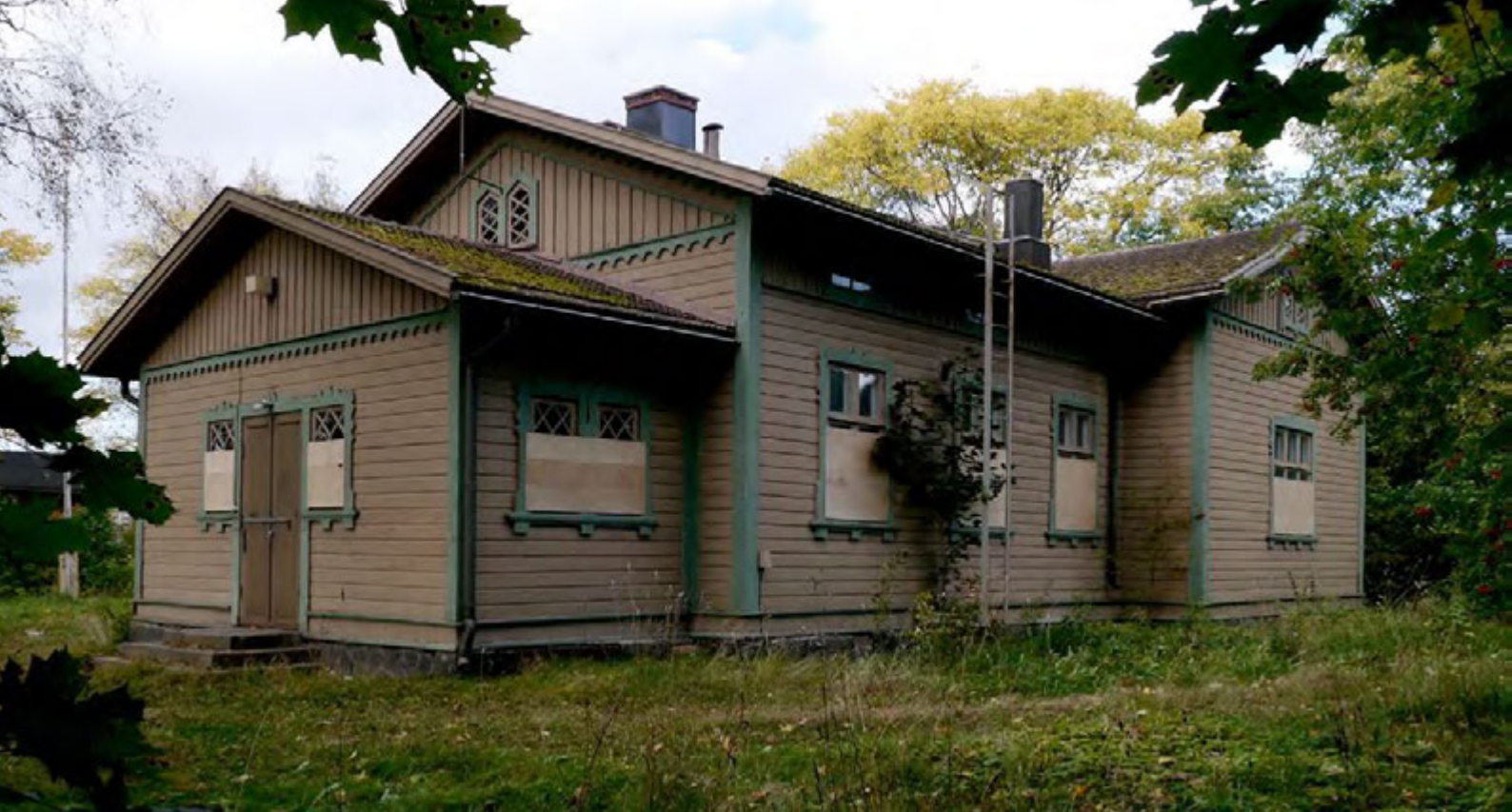
↑ Koulurakennuksen radanpuoleinen julkisivu. amoy 2012 → Seinän yläosan detaljointia. amoy 2012
