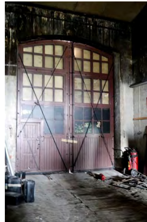
↓ Veturiportti sisäpuolelta. amoy 2012. Veturiportissa on sisäpuolella vinotuet.
