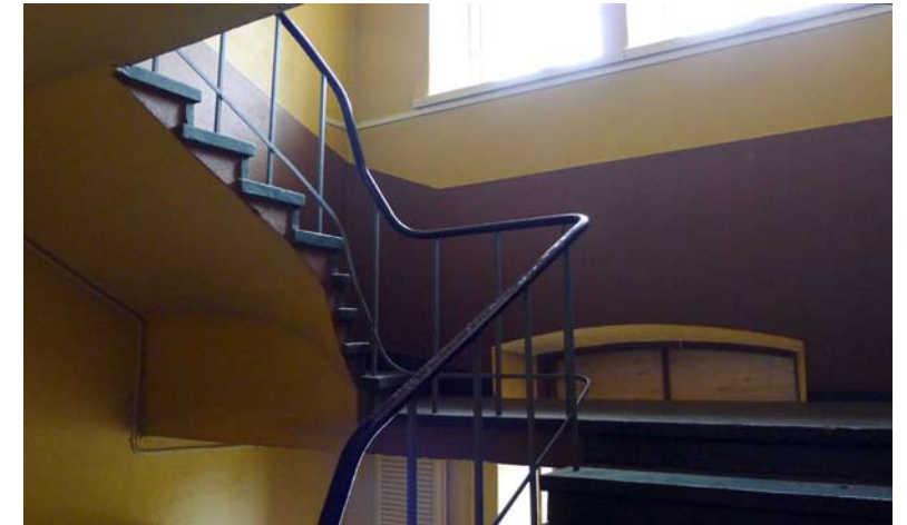
↑ Portaan välitasanne. amoy 2012 Välitasanne on ensimmäisen oviaukon yläikkunan päällä. Julkisivun sommittelu on ollut sisätiloja tärkeämpää.
