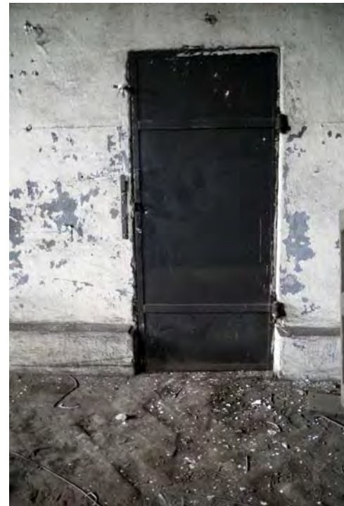
↑ Vanhassa ulkoseinässä, veturipilttuiden n:o 5 ja 6 välissä oleva vanha teräsovi. amoy 2012
