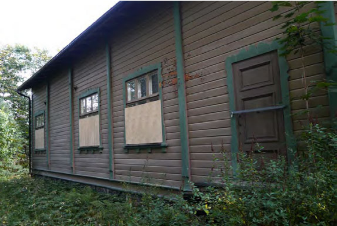
↑ Muutoksia koillisjulkisivulla. Vasemmalta laskien toinen ikkuna poistettiin 1930-luvun muutoksessa. Vuoden 1959 uusi sisäänkäynti on toteutettu vanhan arkkitehtuurin mukaisesti. amoy 2012
