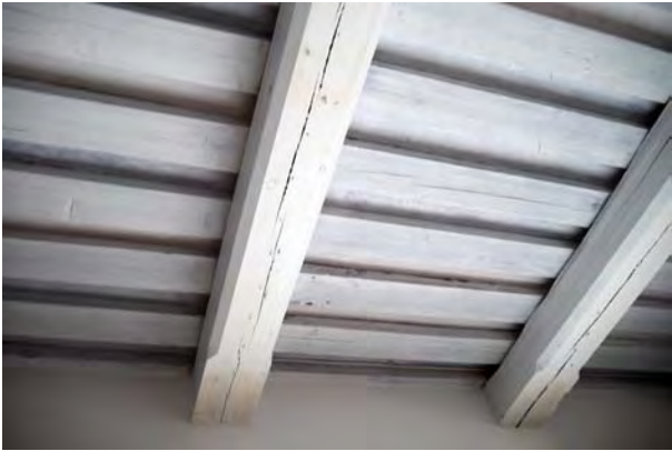
↓ Vuoden 2007 remontissa uudelleen paljastetut pesutuvan vanhat kattopalkit ja laipiolauditus. amoy 2012
