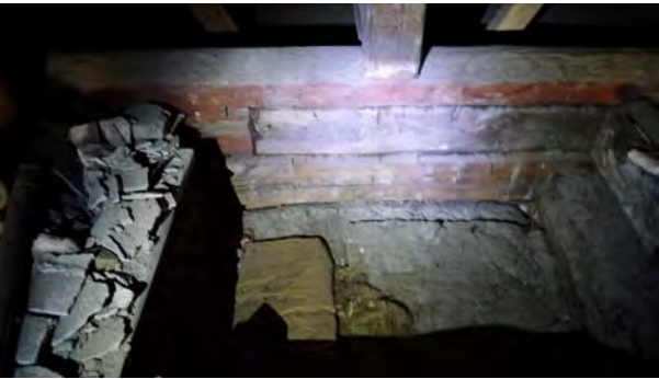
↓ Puretun hormin paikka rakennuksen ullakolla. amoy 2012
