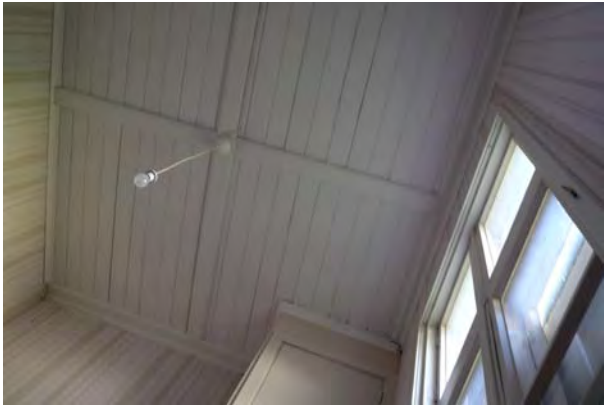
↑ Opettajan asunnon alkuperäisen keittiön kattopanelointia. Keittiö on myöhemmissä muutoksissa jaettu väliseinällä. amoy 2012
