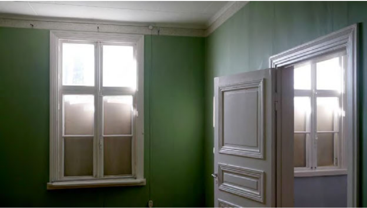
↓ Pienempi luokkahuone on jaettu väliseinällä 1950-luvulla. Seinässä oleva ovi vuorilautoineen on kuitenkin vanhempi ja edustaa 1900-luvun alkuvuosi- kymmeniä. amoy 2012
