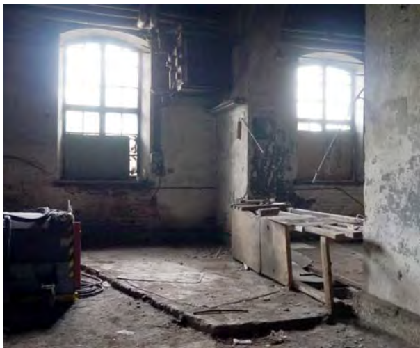
↓ Veturipilttuun n:o 7 lattiassa oleva viisto betonikorotus. amoy 2012
