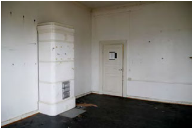
↓ Korjaushuone B:n yläpuolella olevan toimistohuone. amoy 2012 Uuni on todennäköisesti alkuperäinen, mutta luukut on vaihdettu. Taustalla näkyy alkuperäinen peiliovi. Lattia on peitetty mustalla muovimatolla.
