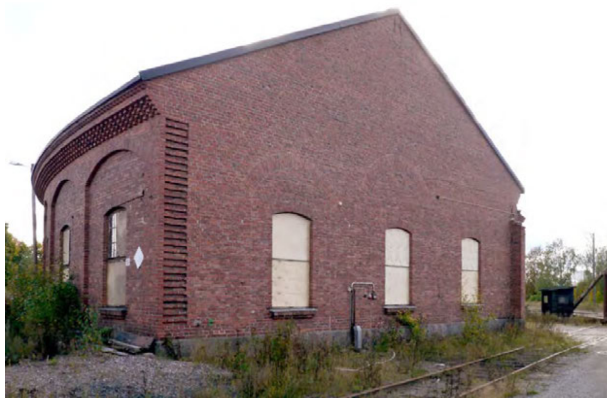
↑ Veturitallin pääty. amoy 2012 Päädyssä näkyy veturitallin jatkettavuus, päätyyn on muurattu valmiiksi sisätilojen holvikaaret ja nurkkiin on jätetty tartuntapinta.
