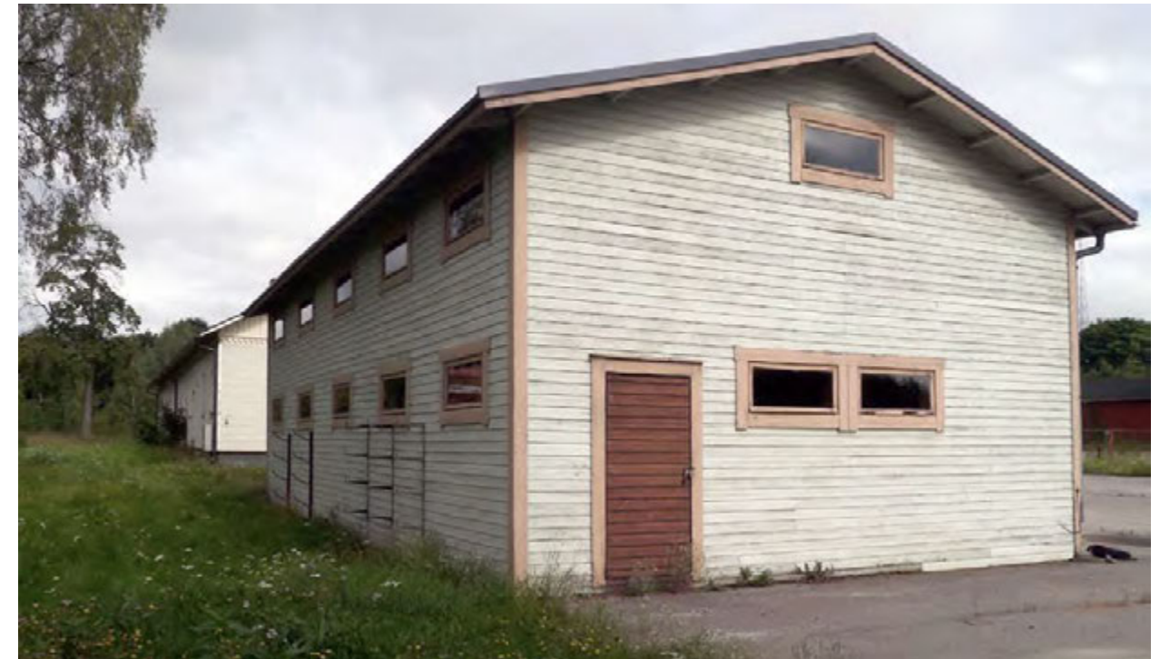
↑ 1970-luvun alun autotalli- ja varastorakennus Vesijärven radan puolelta. Taempana vuoden 1894 entinen asuinkasarmi. amoy 2012
