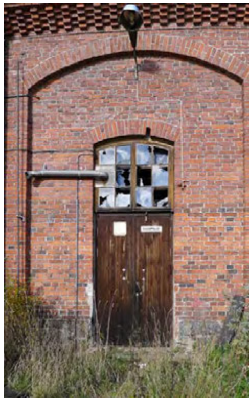
↓ Veturitallin eteläjulkisivun käyntiovi. amoy 2012
