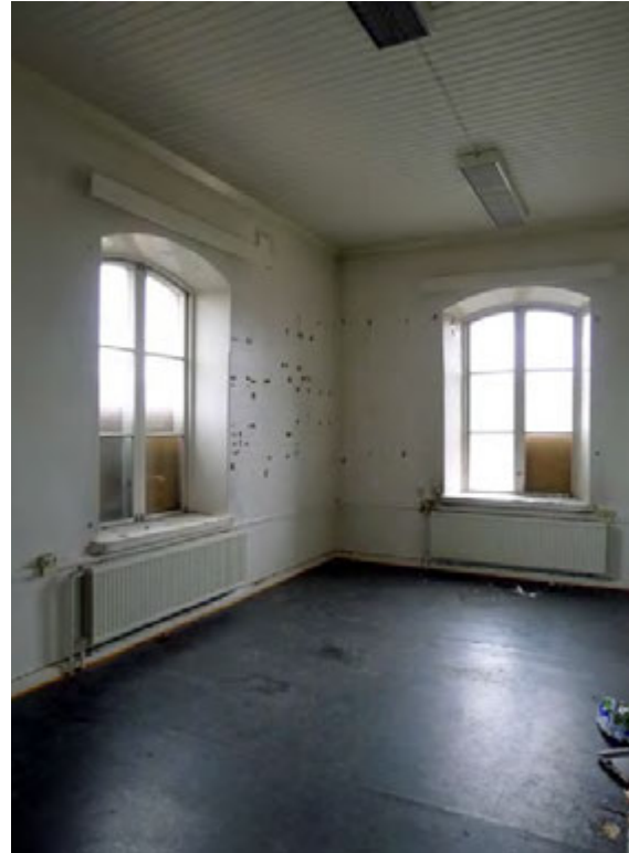
↓ Korjaushuone B:n yläpuolella oleva toimistohuone. amoy 2012 Molemmissa toimistohuoneissa on kaksi holvikaarellista, kuusi-ruutuista ikkunaa.
