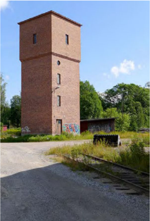
466 ja 467. Kaksi uudemmanmallista erillistä vesitornia: suurempi kokonaan tiilistä tehty ja pienempi, jossa vesisäiliön ympärillä oleva yläosa on puusta.
