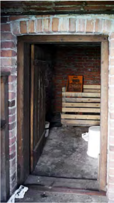
↓ Näkymä eteisen läpi kellariin. amoy 2012
