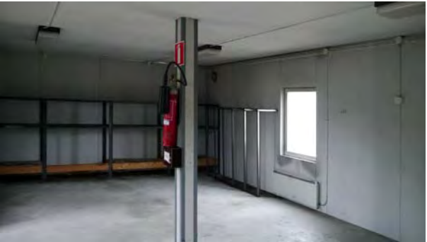
↑ Sisäkuva kaakkoispään rankorakenteisesta osasta. Levytetty pilari keskellä kannattaa kurkihirttä. amoy 2012
