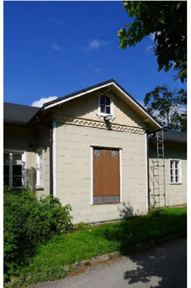
↑ Vanha sisäänkäyntikuisti oli käytössä vielä 1970-luvun muutosten jälkeen, mutta on myöhemmin muutettu huonetilaksi, jolloin porras on purettu. amoy 2012
