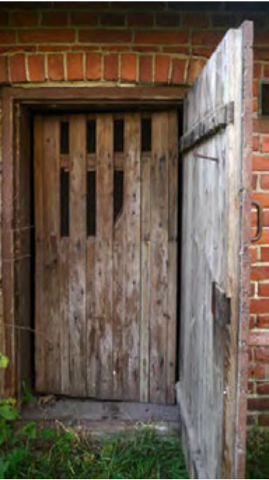
↓ Maakellarin ulko-ovi on tuplaovi, jonka sisemmässä ovilevyssä on teräsverkolla suojatut tuuletusreiät. amoy 2012
