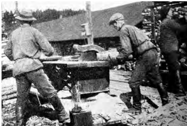
↑ Halkojen sahaus suoraan vaunuista mittoihin. Valtionrautatiet 1912-1937, s.731.
