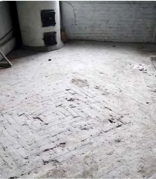
↓ Veturitallien lattiat ovat tiiltä ja ne on ladattu taidokkaasti. amoy 2012
