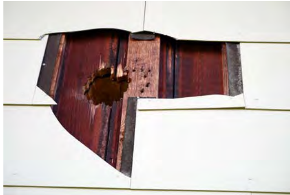
↑ Vanhan pystyrimalaudoituksen rimoitus on poistettu, mutta muuten vanha hirsirunko ja julkisivulaudoitus on tallella 1970-luvun kuitusementtilevyverhouksen alla. amoy 2012
