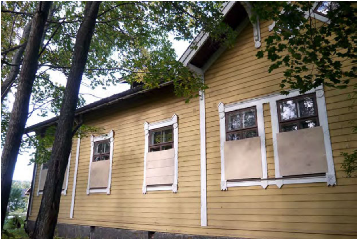
↑ Asuinkasarmin lounaisjulkisivu amoy 2012
