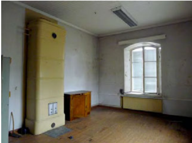
↓ Korjaushuone B:n yläpuolella olevan toimistohuone. amoy 2012 Uuni on todennäköisesti alkuperäinen, mutta luukut on vaihdettu. Taustalla näkyy alkuperäinen peiliovi. Lattia on peitetty mustalla muovimatolla.
