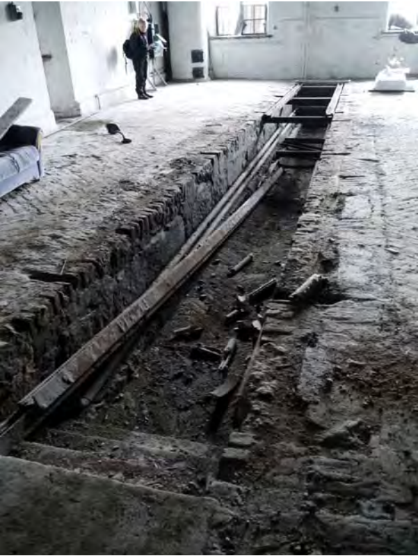
↑ Veturipilttuun n:o 2 huoltokanaali. amoy 2012 Kiskot on purettu kaikista veturipilttuista yhtä lukuunottamatta. Huoltokanaalin reunat ovat luonnonkiveä ja porrasaskelmat betonia.
