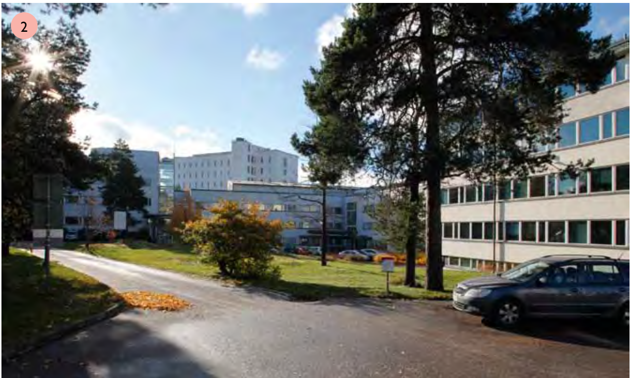
Näkymä pääsisäänkäynniltä kohti etelää. Taustalla rakennukset I ja F. Pihan puusto on alkuperäistä.
