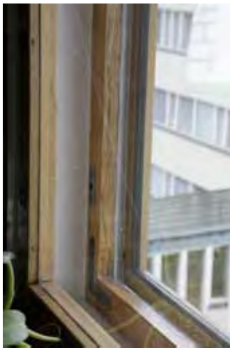
Vanhojen puuikkunoiden ulkopuolelle lisättiin alumiinipuite vuonna 2002.
