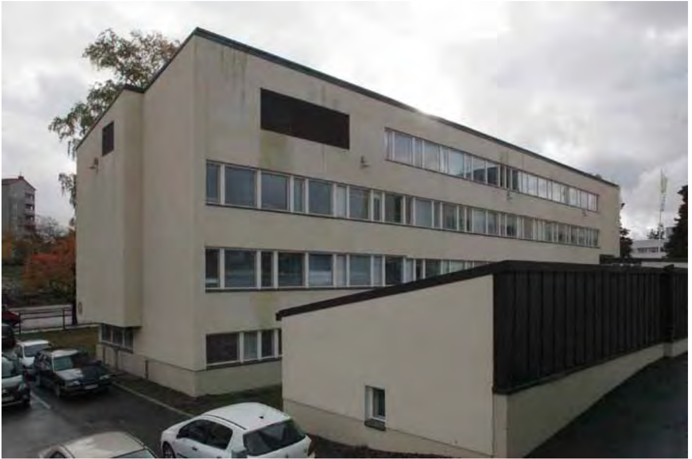
C-rakennusta laajennettiin peruskorjauksen yhteydessä 2005–2007 kuvan edustalla olevalla kerroksen korkuisella tilalla. Samalla rappaus uusittiin ja maalattiin luonnonvalkoiseksi. 1956–1958 rakennettu C-rakennuksen vanhempi osuus yhtyy siihen ja näkyy taaempana.
