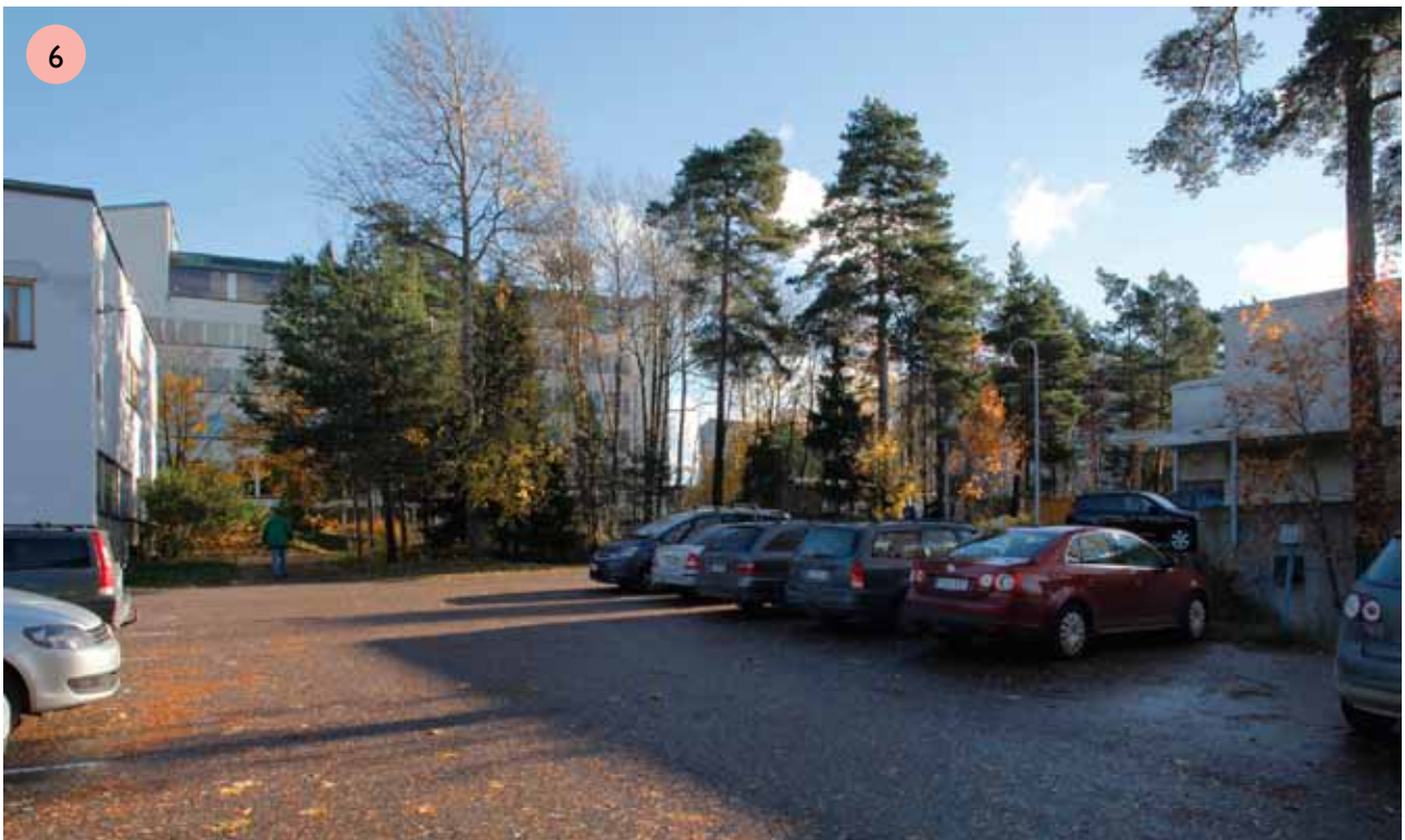
Näkymä rakennuksen G länsipuolen parkkipaikalta kohti rakennuksen A itäjulkisivua..
