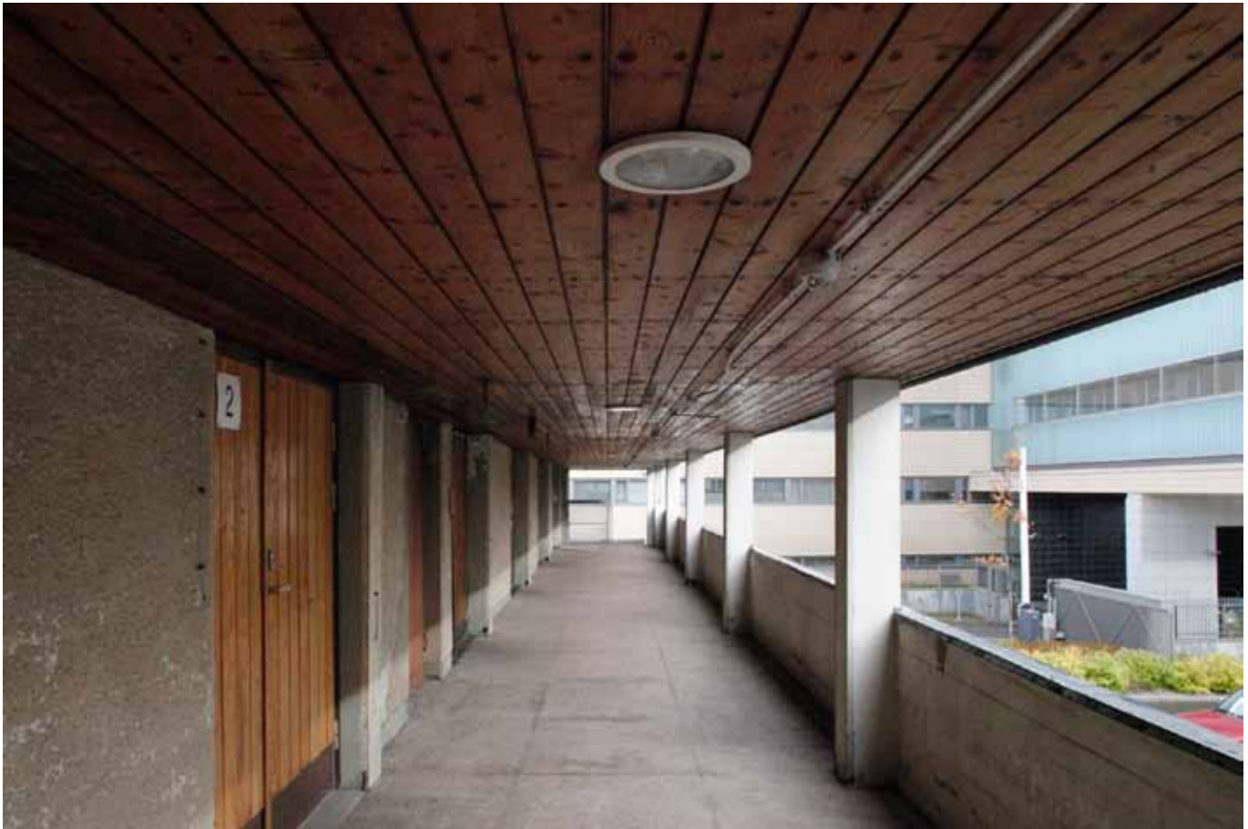
D-rakennuksen itäisivun ulkokäytävänäkymä.
