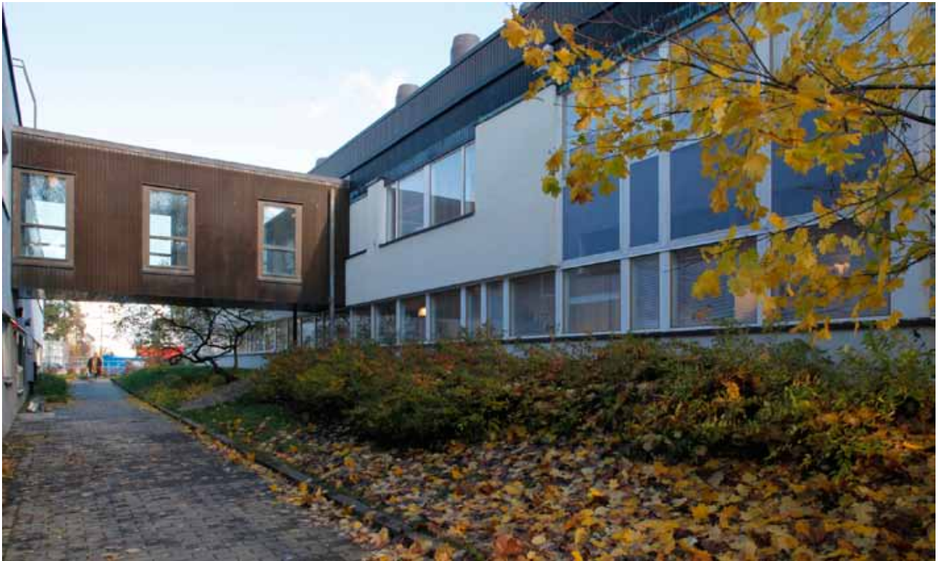
B-rakennuksen länsisivulta on yhdyssilta viereiseen G-rakennukseen.
