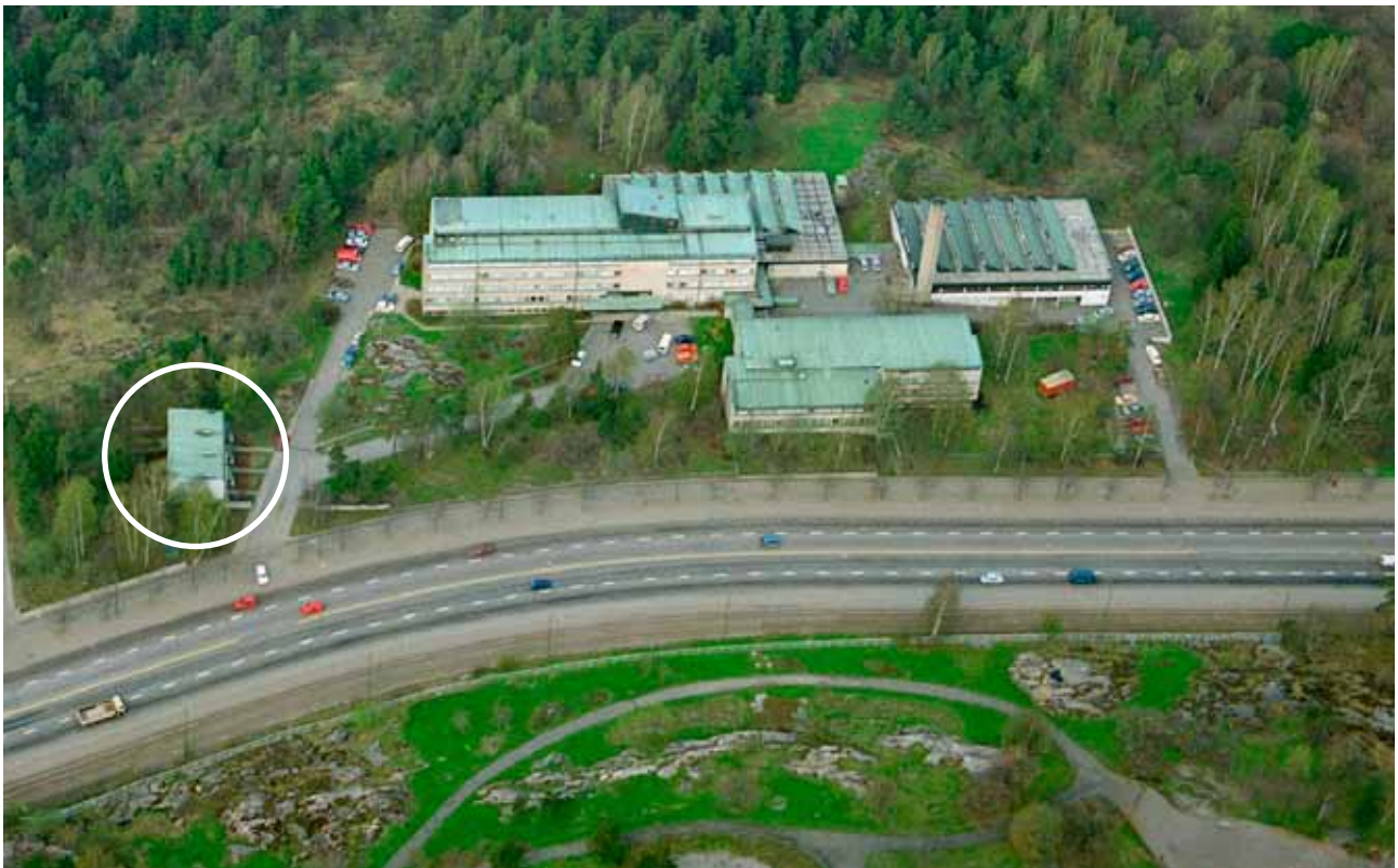
Ilmakuva vuodelta 1986, jossa on nähtävissä tontin kaakkoiskulmassa, lähellä Mannerheimintietä sijainnut kolmen asunnon asuinrakennus E. Rakennus purettiin 1996 I-rakennuksen alta. Lähde: Helsingin kaupungin kiinteistövirasto.
