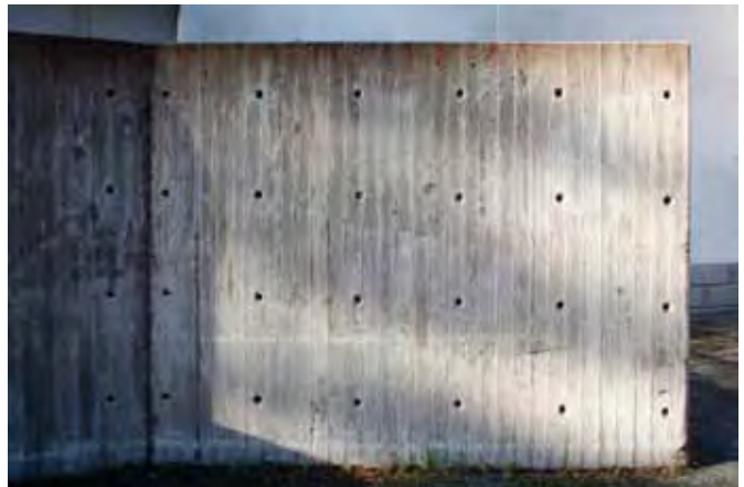
Rakennuksen itäjulkisivun ulkoportaan seinämä on puhasvalubetonia, jonka muottilaudoituskuvio on jätetty näkyviin.
