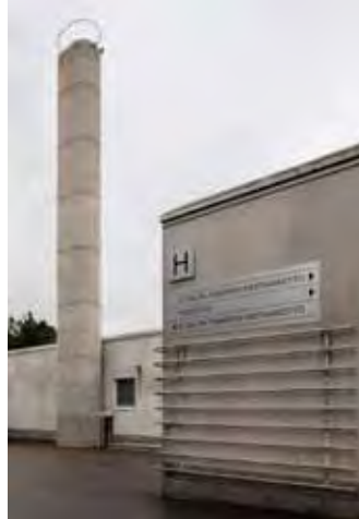
Rakennuksella H on betoninen elementtipiippu. Lastauslaiturin seinää on suojattu vaakateräsputkillä.
