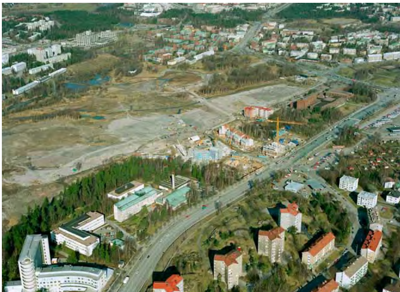
Ilmakuva vuodelta 1989 kun G- ja F-rakennukset ovat juuri valmistuneet. "Köyhien stokka" on purettu ja Pikku-Huopalahden kaupunginosan rakentaminen on alkanut. Lähde: HEL KK.
