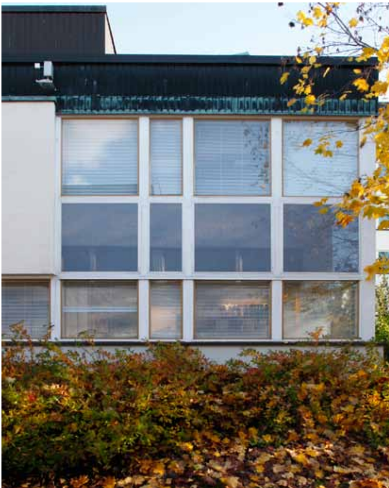
Rakennuksen lounaiskulma on lasitettu. Ikkunapinnan yläpuolella näkyy julkisivun kuparipellitystä. Julkisivumaalaus on luonnonvalkoinen.
