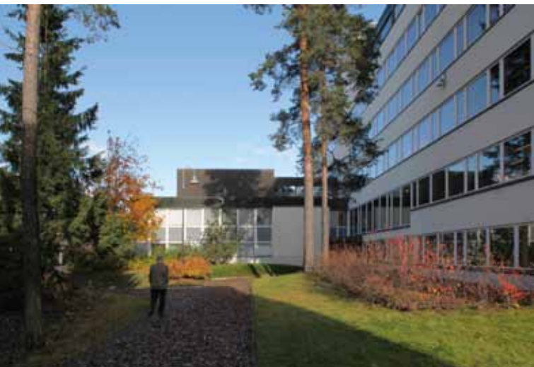
A- ja B-rakennuksen yhtymäkohta.
