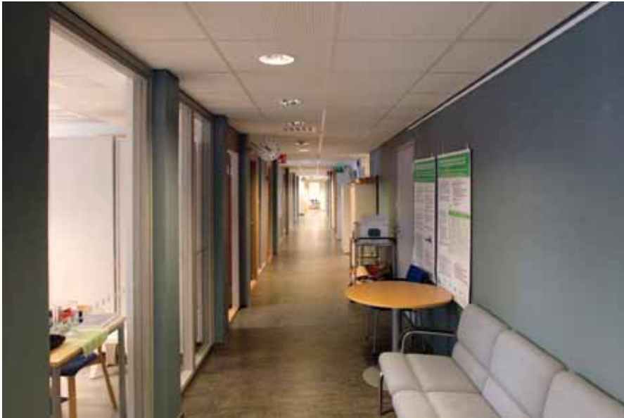
Peruskorjauksen yhteydessä 2005–2007 C-rakennuksen laboratoriotilat muutettiin toimistokäyttöön.
