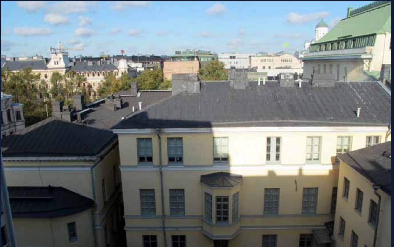
Sisäpihanäkymä pohjoiseen. Vasemmalta: A-, B- ja C-osat.
