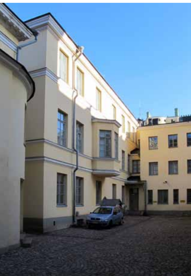
Alun perin kaksikerroksista pihasiipeä on korotettu 1920-luvulla. Ulkorakennuksen itäsiipeä on korotettu kahteen kertaan, ensin pihasiiven rakentamisen yhteydessä ja toisen kerran 1920-luvulla.
