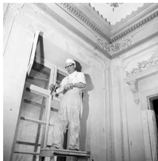
Ruokasalin pihanpuoleisen kulman maalauskoristelua viimeistellään 1960-luvun peruskorjauksen aikana. Raimo Ahonen / Lehtikuva
