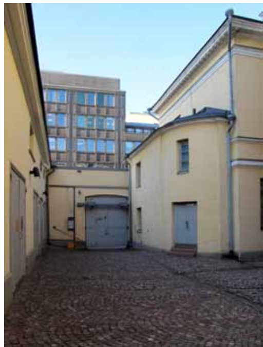
Fabianinkadun siiven eteläpäädyn kaksikerroksinen laajennus on rakennettu kahdessa vaiheessa vuosina 1826–56. Päärakennuksen konsolikattolista päättyy rakennuksen kulmaan.
