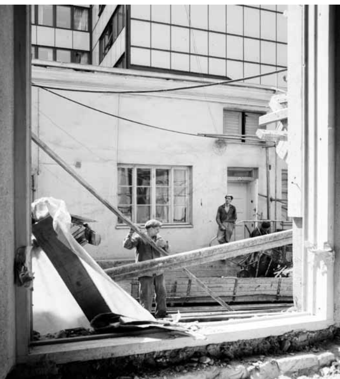
Peruskorjauksen aikana kesäkuussa 1965 pihasiiven ikkuna-aukon läpi otettu kuva ulkorakennuksesta. Ulkorakennuksen ikkunat muutettiin autotallinoviksi ja oikeanpuoleisen työmiehen takana näkyvä ovi muurattiin umpeen. Raimo Ahonen / Lehtikuva
