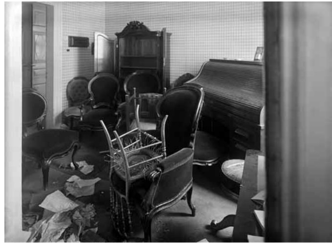
Nykyisen keittiötilan 225 kohdalla olleista huoneista läntisin vuonna 1918 Smolnan valtauksen jälkeen. Huone oli ollut aiemmin kenraalikuvernöörin palvelusväen käytössä. Takaseinällä oven vieressä näkyy palvelijankutsulaite. HKM
